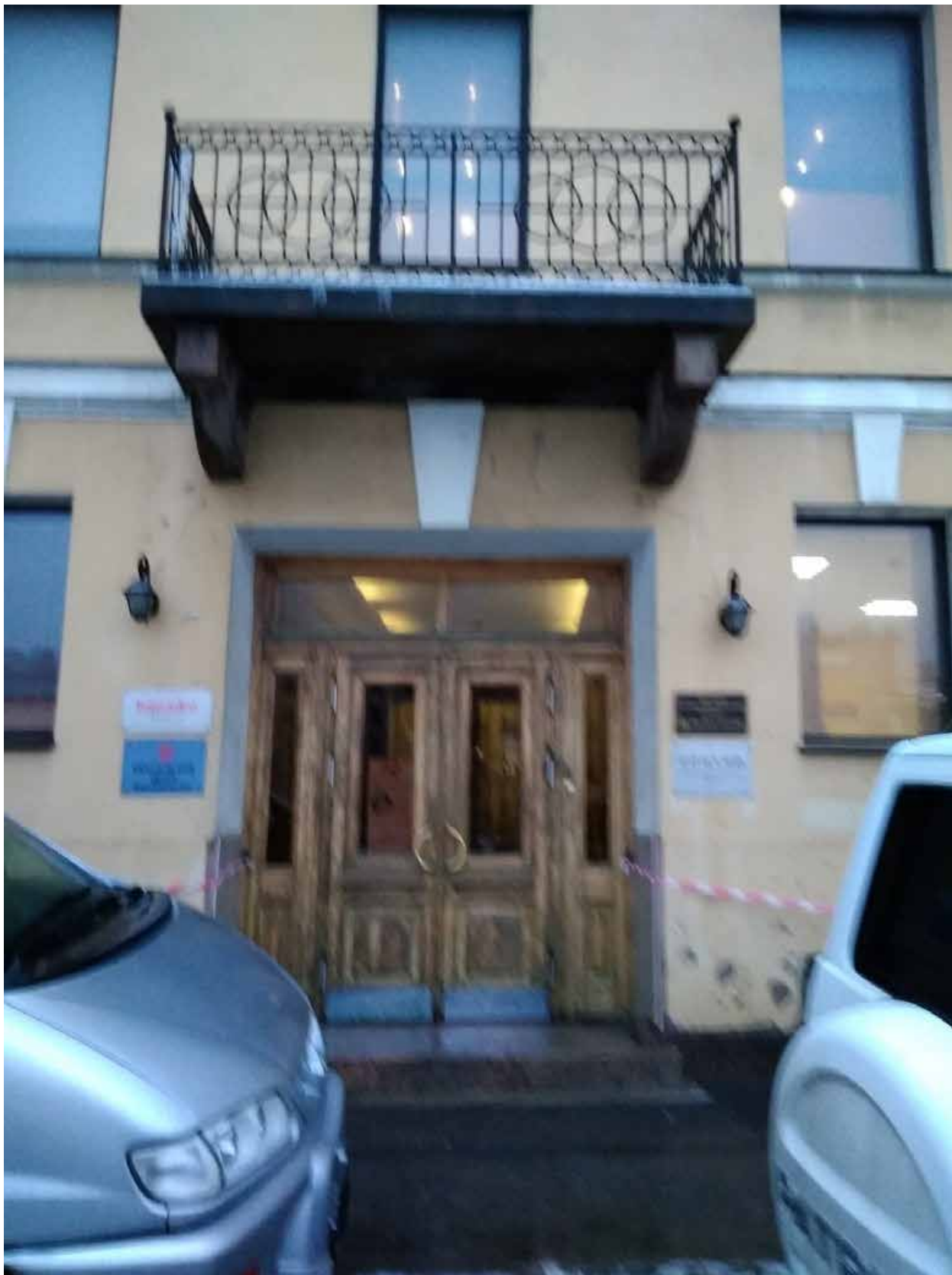
Фото 03. ВОКН «Здание (многоквартирный дом)», расположенный по адресу: Санкт-Петербург, набережная реки Фонтанки, дом 132, литера З. Вид на лицевой (северный) фасад с четной стороны наб. р. Фонтанки.
