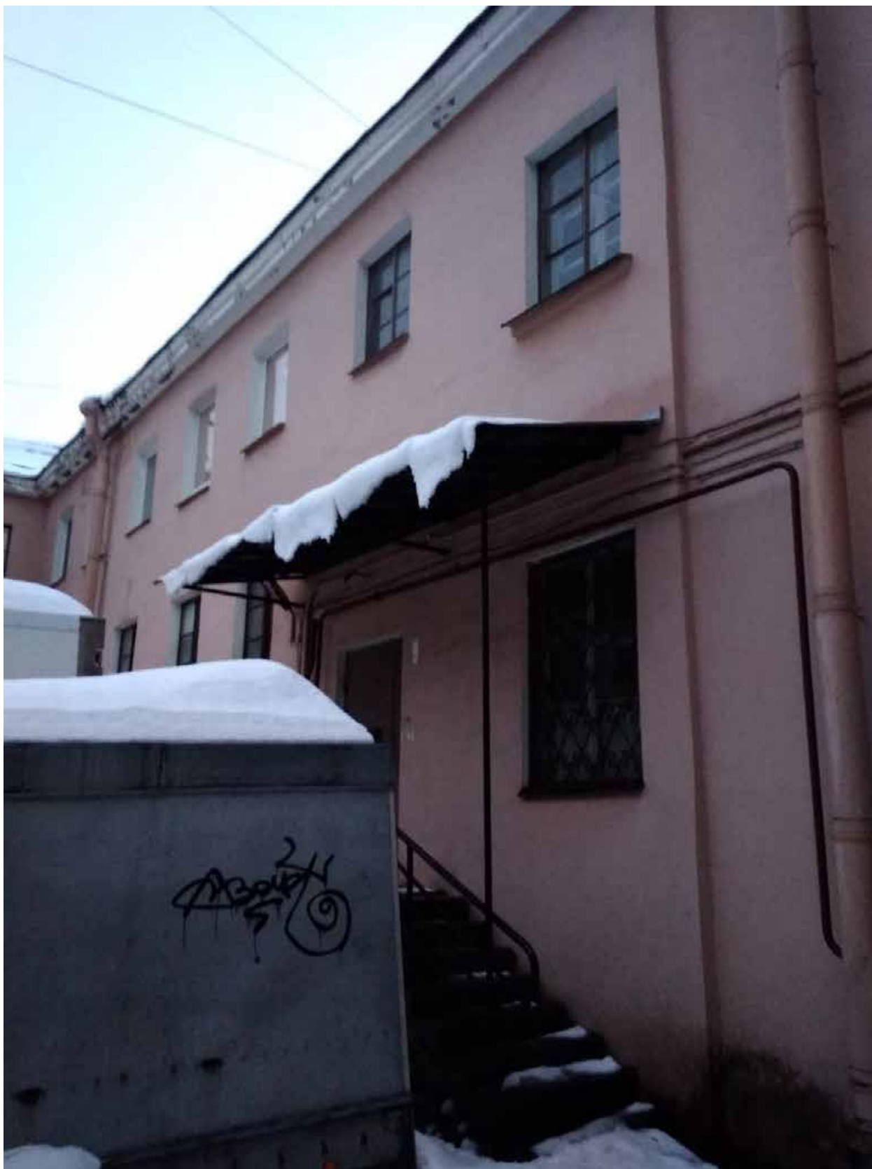
Фото 13. ВОКН «Особняк П.А. Поповой (с флигелями)», расположенный по адресу: г. Санкт-Петербург, наб. реки Фонтанки, д. 130, лит. А. Вид со двора на входную группу флигеля, расположенного в западной границе участка.
