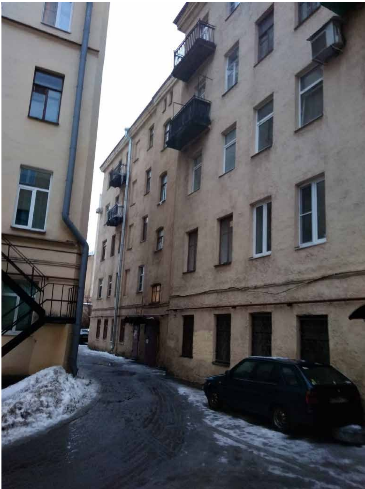
Фото 11. ВОКН «Дом Н. Шпейфера (доходный дом страхового общества "Саламандра")», расположенный по адресу Измайловский пр., 7; Троицкая пл. б/№. Вид со двора проход между восточным и южным фасадами.
