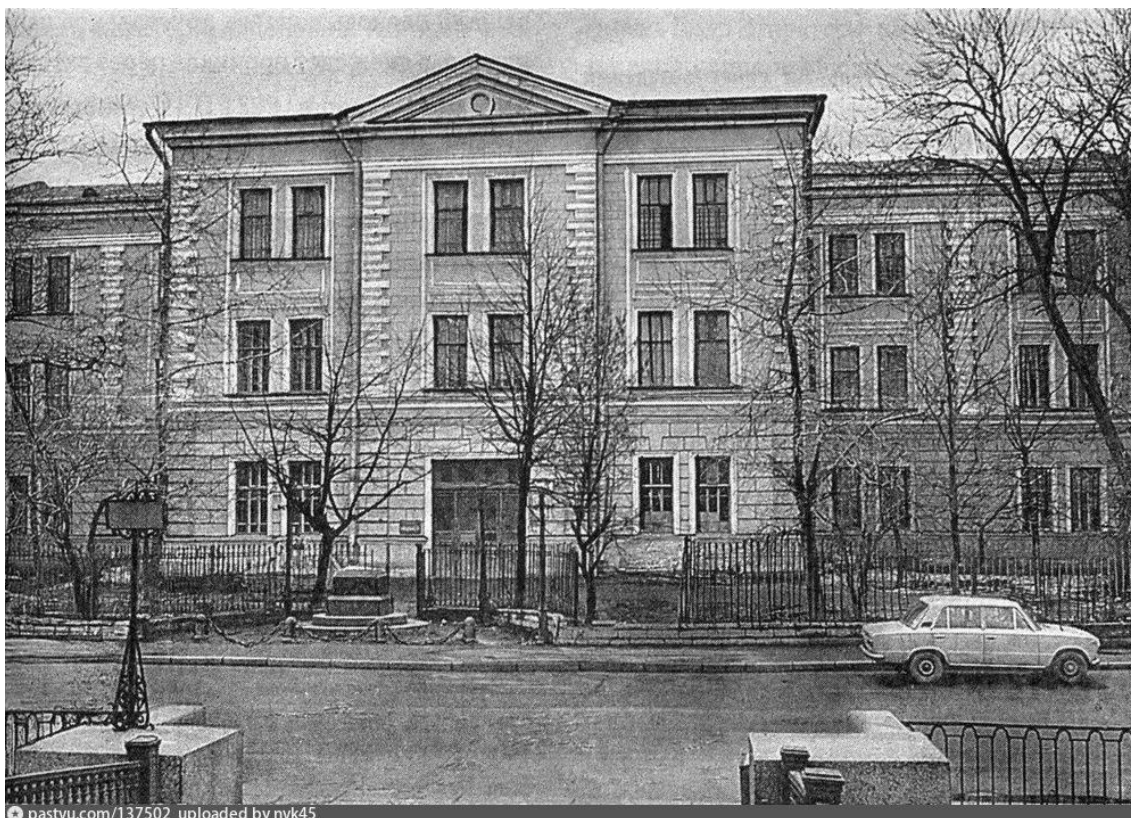
42. Здание б. Александровской больницы в память 19 февраля 1861 года (Фонтанка, 132). 1981—1985 гг. [Электронный доступ]: https://pastvu.com/p/13750 . (Дата обращения 10.10.2021).
