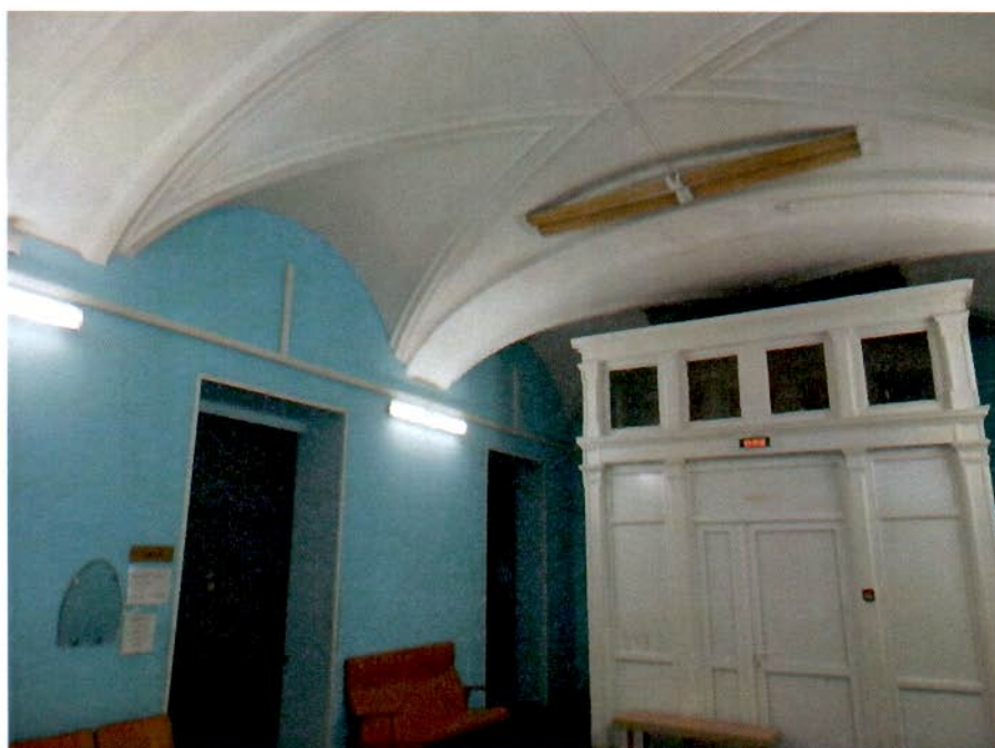
2. Фрагмент вестибюля и тамбур парадного входа в здание.
