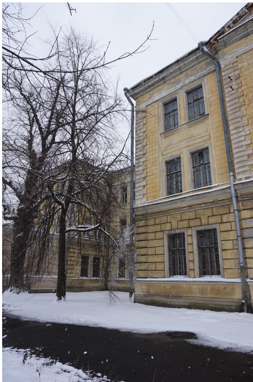
Фото 07. ВОКН «Александровская больница для рабочего населения в память 19-го февраля 1861 г. Комплекс с территорией, садом, оградами и постаментом от не сохранившегося бюста имп. Александра II» расположенный по адресу: Санкт-Петербург, Троицкий пр., 1-3; Фонтанки р. наб., 132. Вид на (северный) фасад главного корпуса с четной стороны наб. р. Фонтанки.
