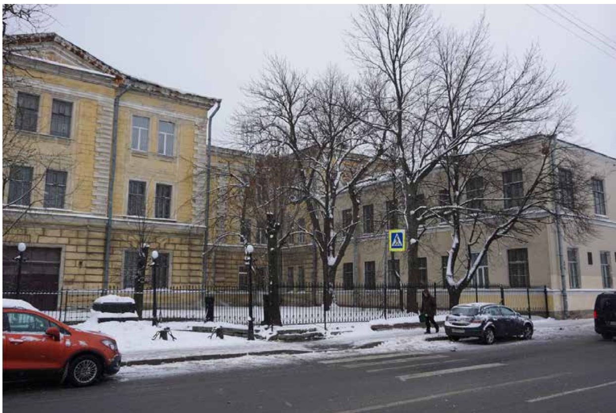
Фото 10. ВОКН «Александровская больница для рабочего населения в память 19-го февраля 1861 г. Комплекс с территорией, садом, оградами и постаментом от не сохранившегося бюста имп. Александра II» расположенный по адресу: Санкт-Петербург, Троицкий пр., 1-3; Фонтанки р. наб., 132. Вид на (северный) фасад главного корпуса с четной стороны наб. р. Фонтанки.
