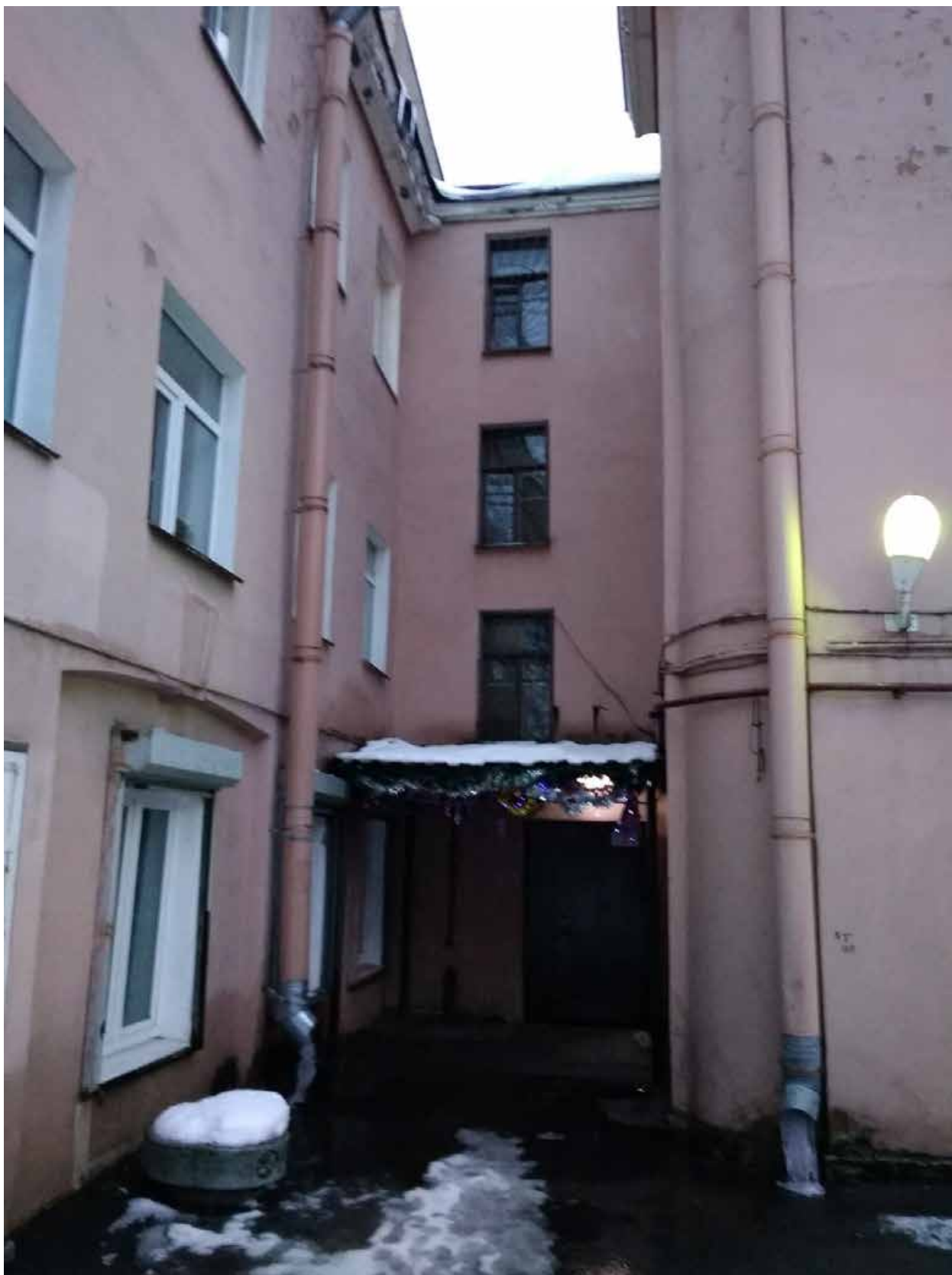
Фото 19. ВОКН «Особняк П.А. Поповой (с флигелями)», расположенный по адресу: г. Санкт-Петербург, наб. реки Фонтанки, д. 130, лит. А. Вид со двора на входную группу между восточным и южным флигелями.
