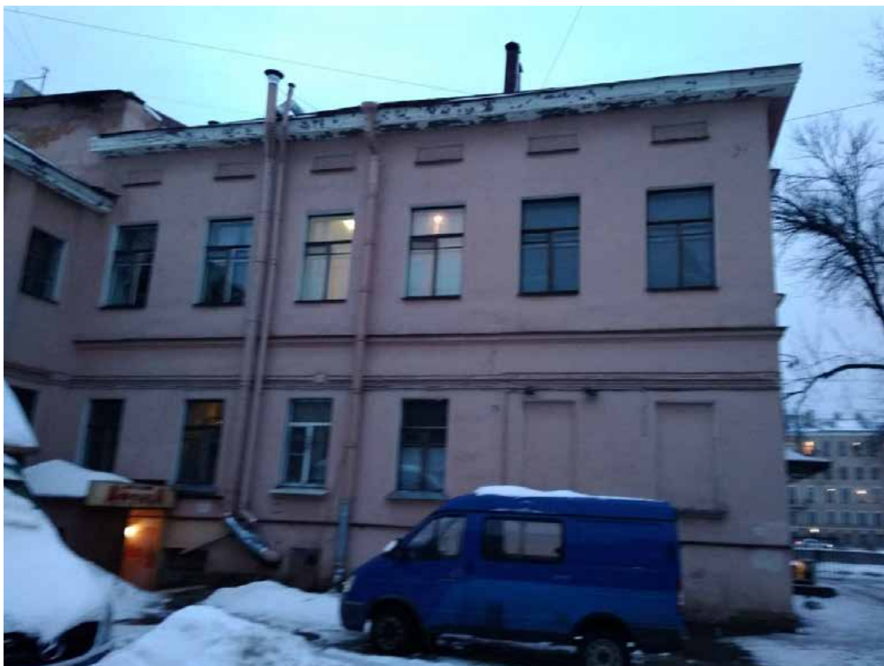
Фото 09. ВОКН «Особняк П.А. Поповой (с флигелями)», расположенный по адресу: г. Санкт-Петербург, наб. реки Фонтанки, д. 130, лит. А. Вид со двора на юго-восточный фасад лицевого корпуса
