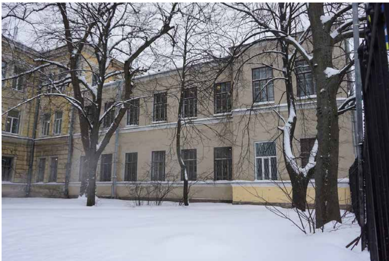
Фото 11. ВОКН «Александровская больница для рабочего населения в память 19-го февраля 1861 г. Комплекс с территорией, садом, оградами и постаментом от не сохранившегося бюста имп. Александра II» расположенный по адресу: Санкт-Петербург, Троицкий пр., 1-3; Фонтанки р. наб., 132. Вид на фасад (северо-восточный) флигеля, примыкающего справа к главному корпусу с четной стороны наб. р. Фонтанки.
