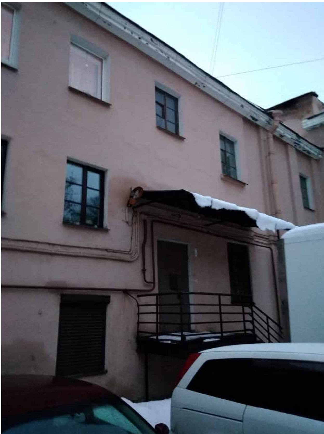
Фото 14. ВОКН «Особняк П.А. Поповой (с флигелями)», расположенный по адресу: г. Санкт-Петербург, наб. реки Фонтанки, д. 130, лит. А. Вид со двора на входную группу флигеля, расположенного в западной границе участка.
