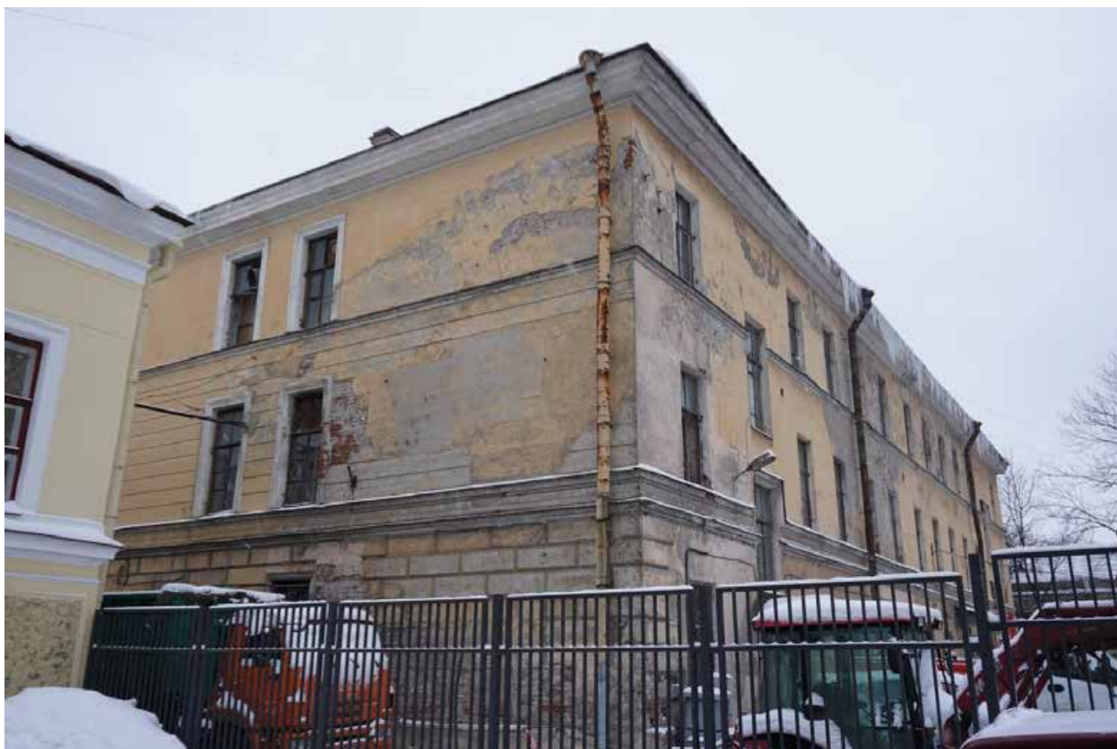
Фото 36. ВОКН «Александровская больница для рабочего населения в память 19-го февраля 1861 г. Комплекс с территорией, садом, оградами и постаментом от не сохранившегося бюста имп. Александра II» расположенный по адресу Санкт-Петербург, Троицкий пр., 1-3; Фонтанки р. наб., 132. Вид на северный фасад флигеля (Фонтанки р. наб., 132Г) с нечетной стороны Троицкого пр.
