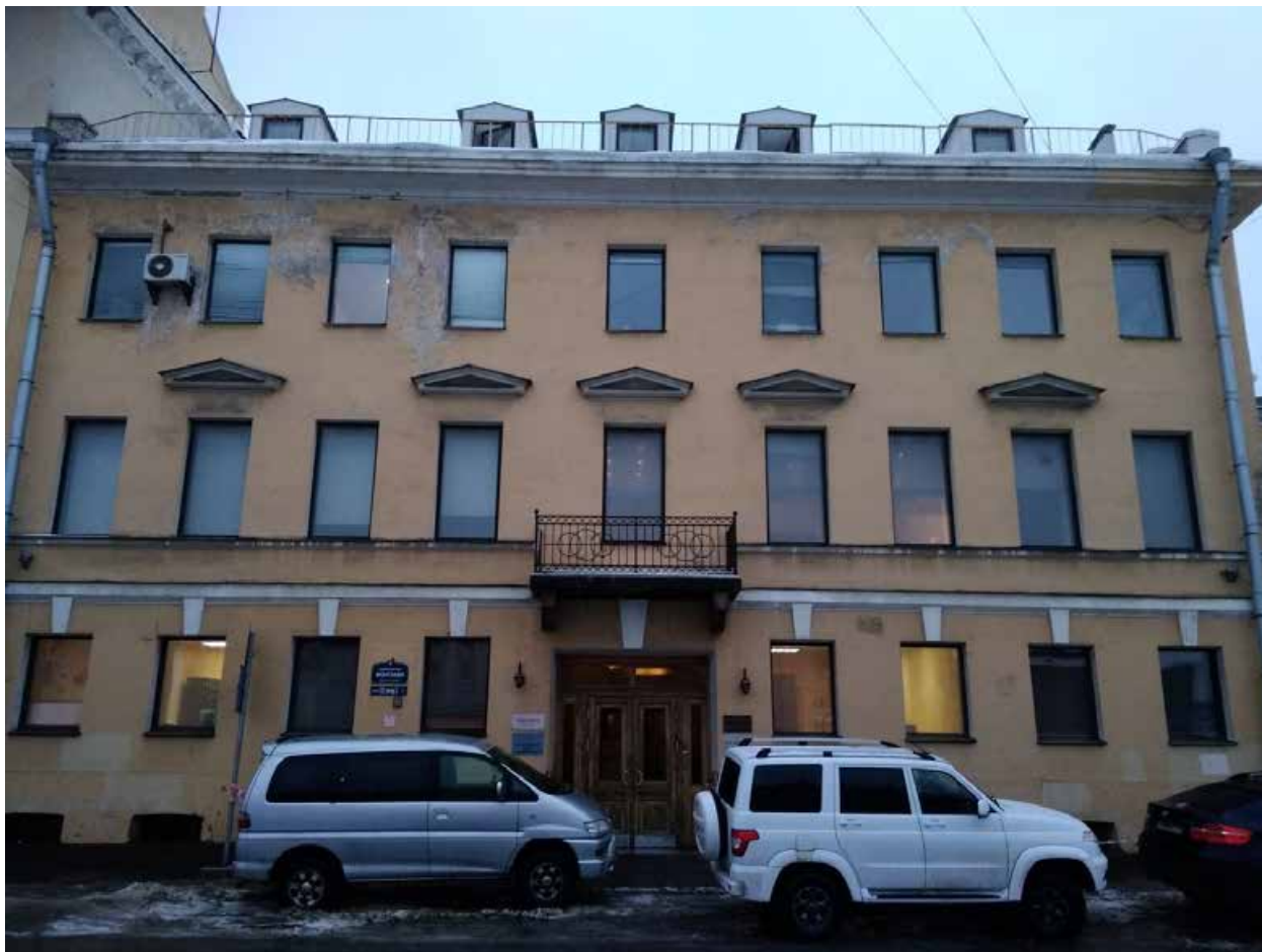
Фото 01. ВОКН «Здание (многоквартирный дом)», расположенный по адресу: Санкт-Петербург, набережная реки Фонтанки, дом 132, литера З. Вид на лицевой (северный) фасад с четной стороны наб. р. Фонтанки.
