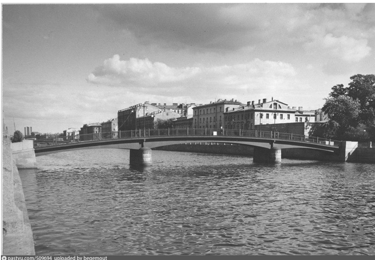
11. Красноармейский мост 1970-1980. Датировка условная. [Электронный доступ]: https://pastvu.com/p/509694
