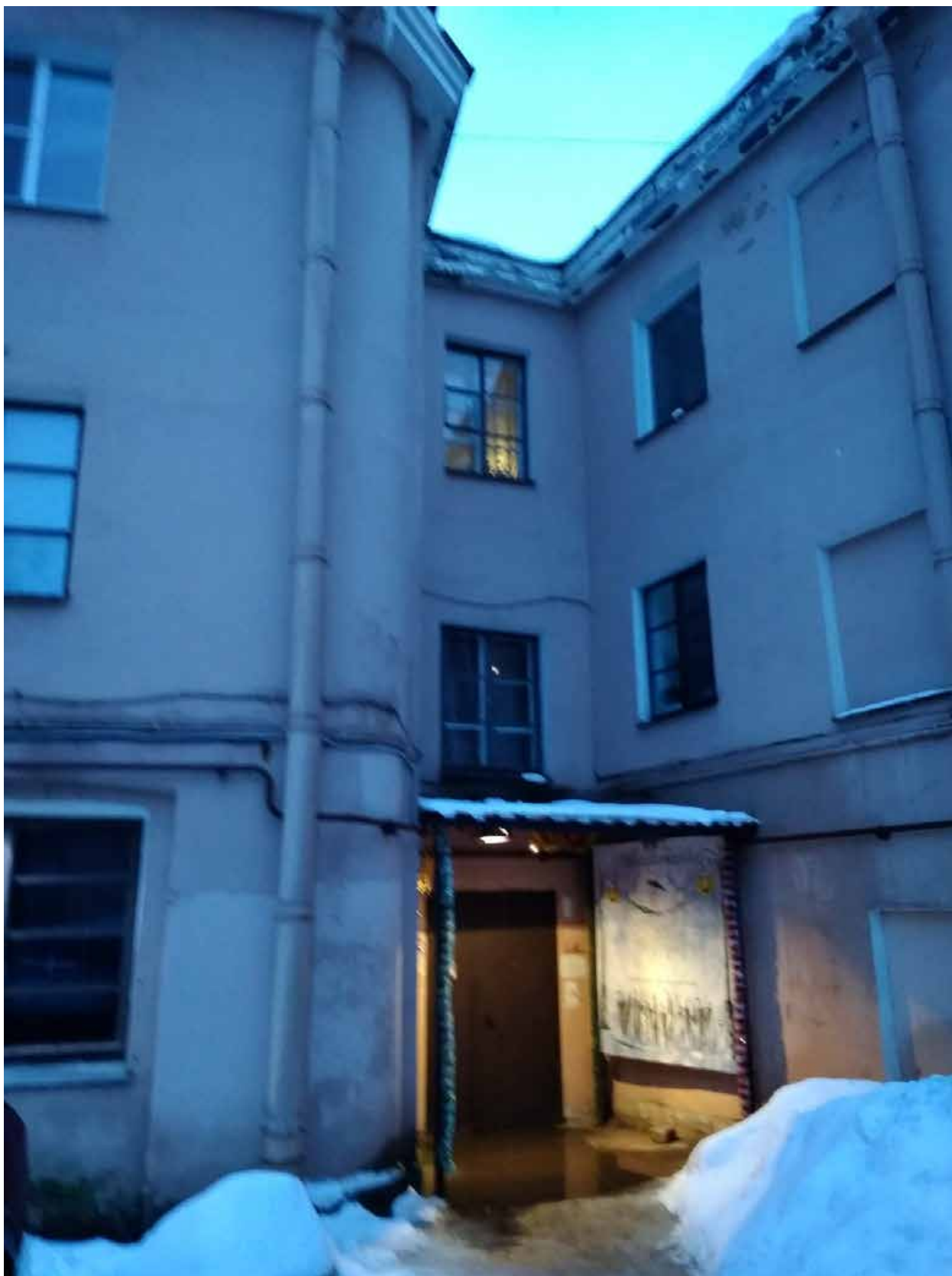
Фото 16. ВОКН «Особняк П.А. Поповой (с флигелями)», расположенный по адресу: г. Санкт-Петербург, наб. реки Фонтанки, д. 130, лит. А. Вид со двора на входную группу между южным и западным флигелями.
