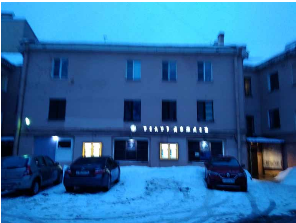
Фото 15. ВОКН «Особняк П.А. Поповой (с флигелями)», расположенный по адресу: г. Санкт-Петербург, наб. реки Фонтанки, д. 130, лит. А. Вид со двора на лицевой фасад флигеля, расположенного в южной границе участка.
