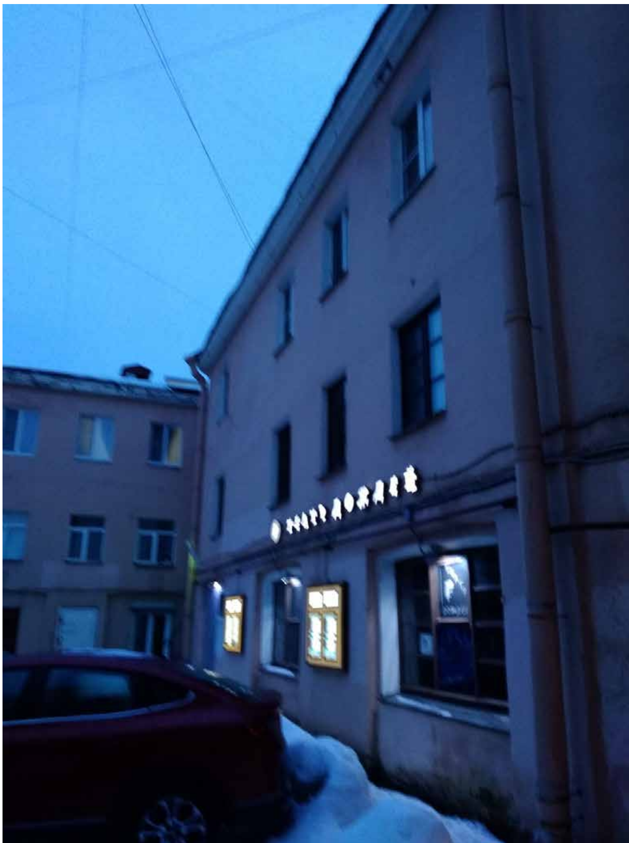
Фото 17. ВОКН «Особняк П.А. Поповой (с флигелями)», расположенный по адресу: г. Санкт-Петербург, наб. реки Фонтанки, д. 130, лит. А. Вид со двора на лицевой фасад флигеля, расположенного в южной границе участка.
