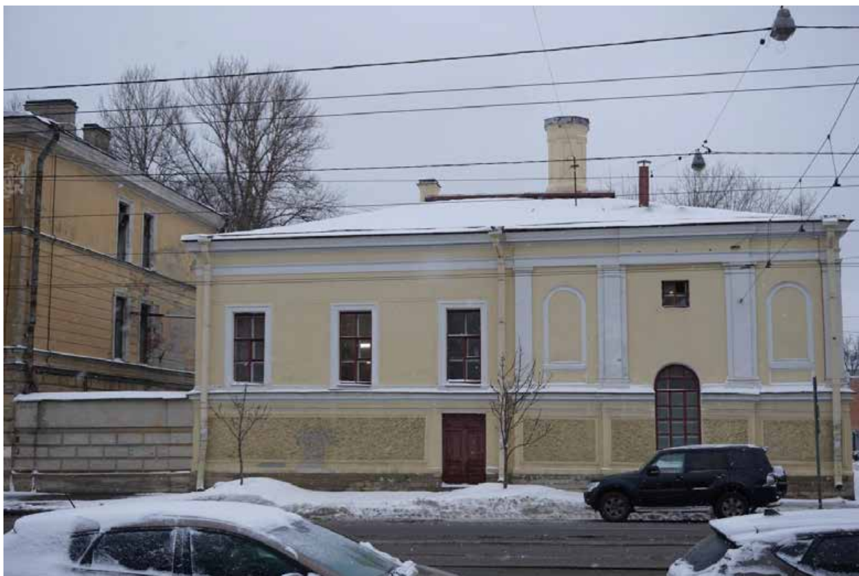
Фото 30. ВОКН «Александровская больница для рабочего населения в память 19-го февраля 1861 г. Комплекс с территорией, садом, оградами и постаментом от не сохранившегося бюста имп. Александра II» расположенный по адресу Санкт-Петербург, Троицкий пр., 1-3; Фонтанки р. наб., 132. Вид на лицевой (южный) «Часовни у Троицкого собора» (Фонтанки р. наб., 132Д) с нечетной стороны Троицкого пр.
