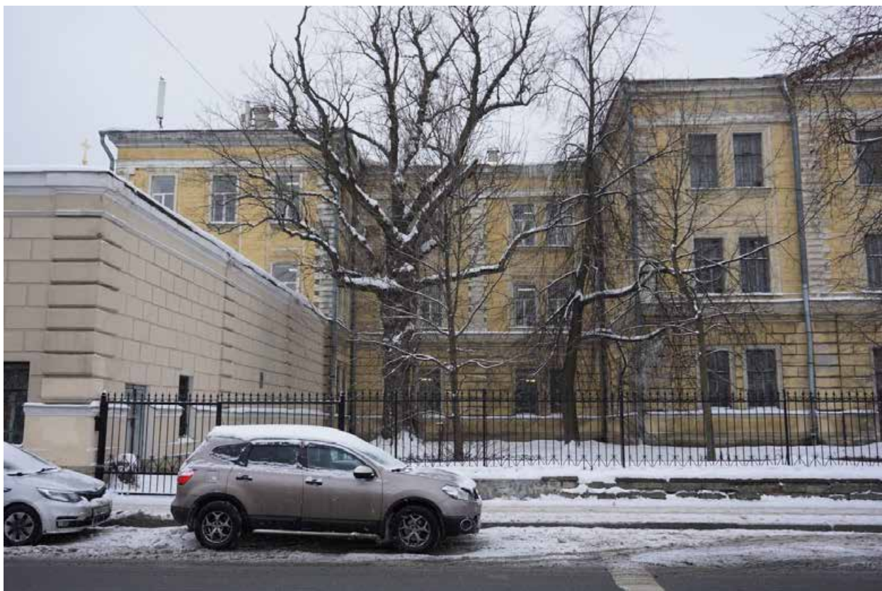
Фото 05. ВОКН «Александровская больница для рабочего населения в память 19-го февраля 1861 г. Комплекс с территорией, садом, оградами и постаментом от не сохранившегося бюста имп. Александра II» расположенный по адресу: Санкт-Петербург, Троицкий пр., 1-3; Фонтанки р. наб., 132. Вид на главный (северный) фасад с четной стороны наб. р. Фонтанки.
