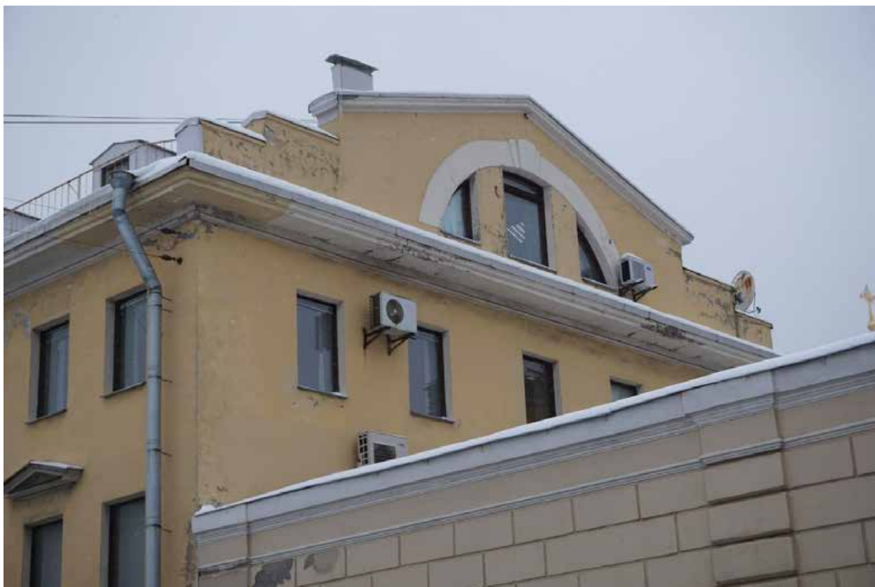
Фото 03. ВОКН «Здание (многоквартирный дом)», расположенный по адресу: Санкт-Петербург, набережная реки Фонтанки, дом 132, литера 3. Вид на фрагмент западного фасада.
