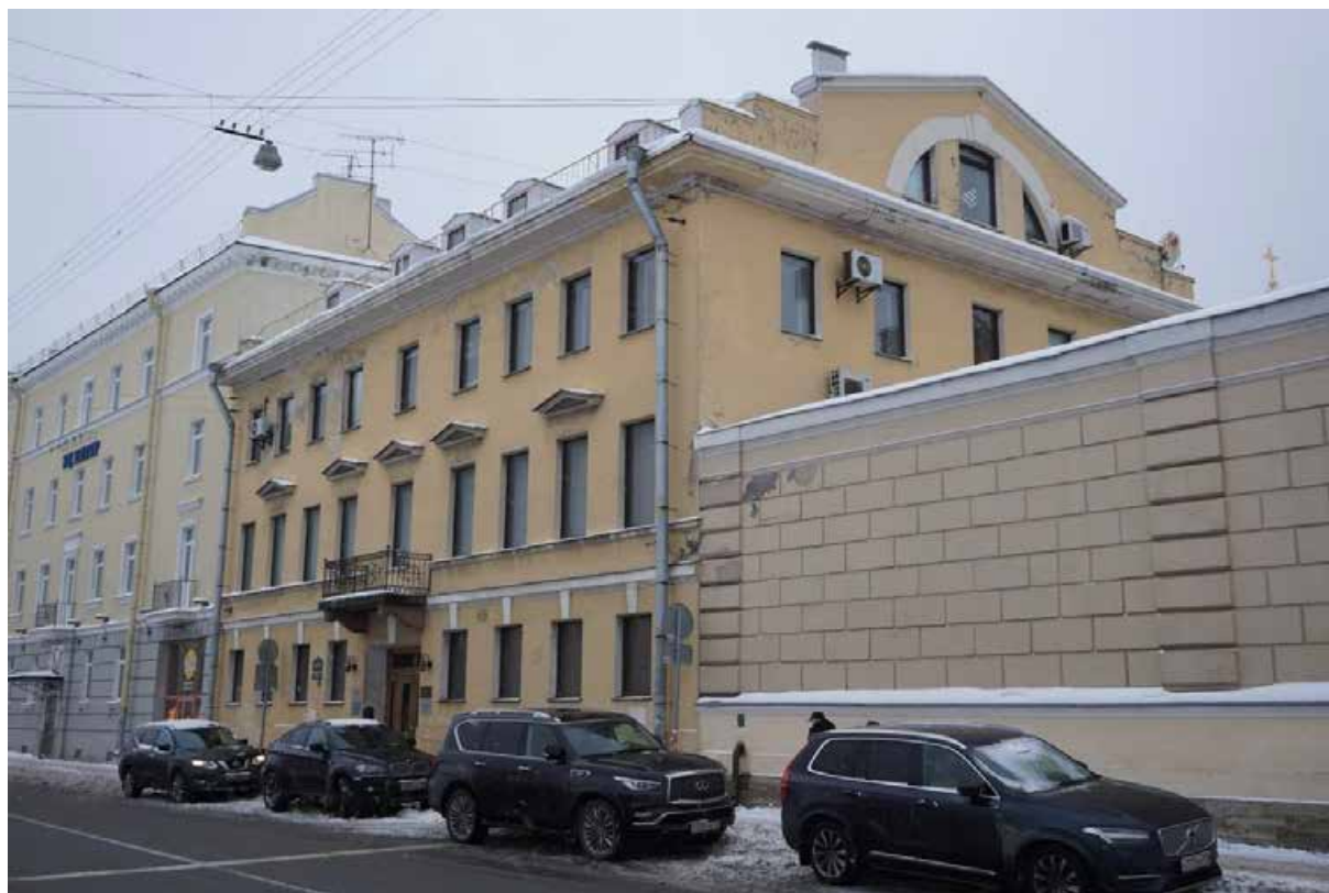
Фото 01. ВОКН «Здание (многоквартирный дом)», расположенный по адресу: Санкт-Петербург, набережная реки Фонтанки, дом 132, литера 3. Вид на лицевой (северный) и западный фасады с четной стороны наб. р. Фонтанки.
