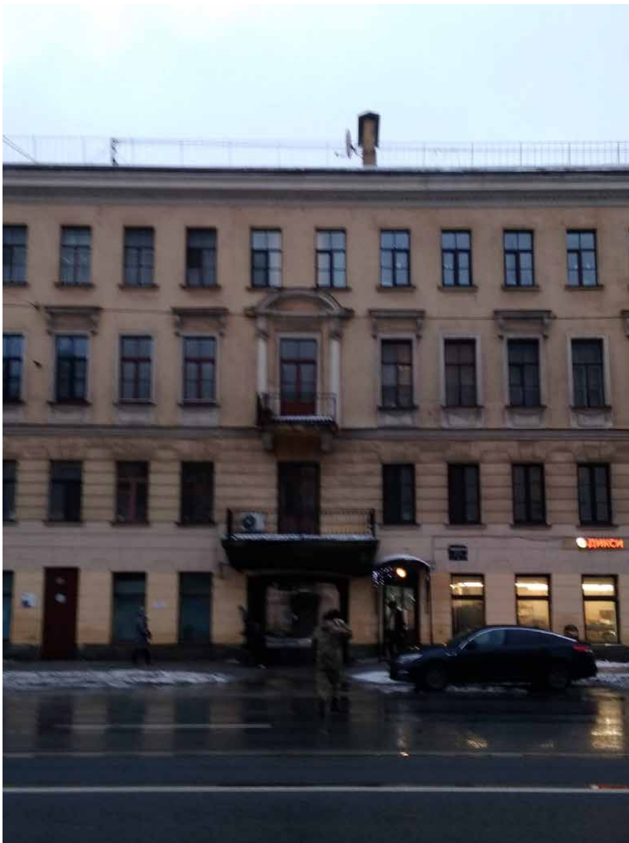
Фото 05. ВОКН «Дом Н. Шпейфера (доходный дом страхового общества "Саламандра")», расположенный по адресу Измайловский пр., 7; Троицкая пл. б/№. Вид на лицевой фасад (восточный) по Измайловскому проспекту.
