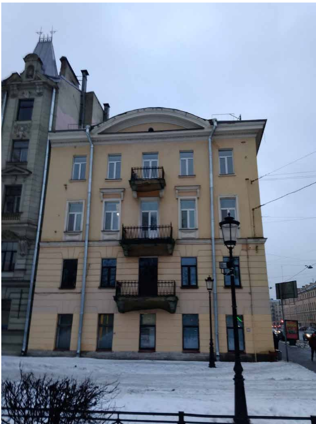
Фото 01. ВОКН «Дом Н. Шпейфера (доходный дом страхового общества "Саламандра")», расположенный по адресу Измайловский пр., 7; Троицкая пл. б/№. Вид на лицевой фасад (южный) по Троицкому проспекту.
