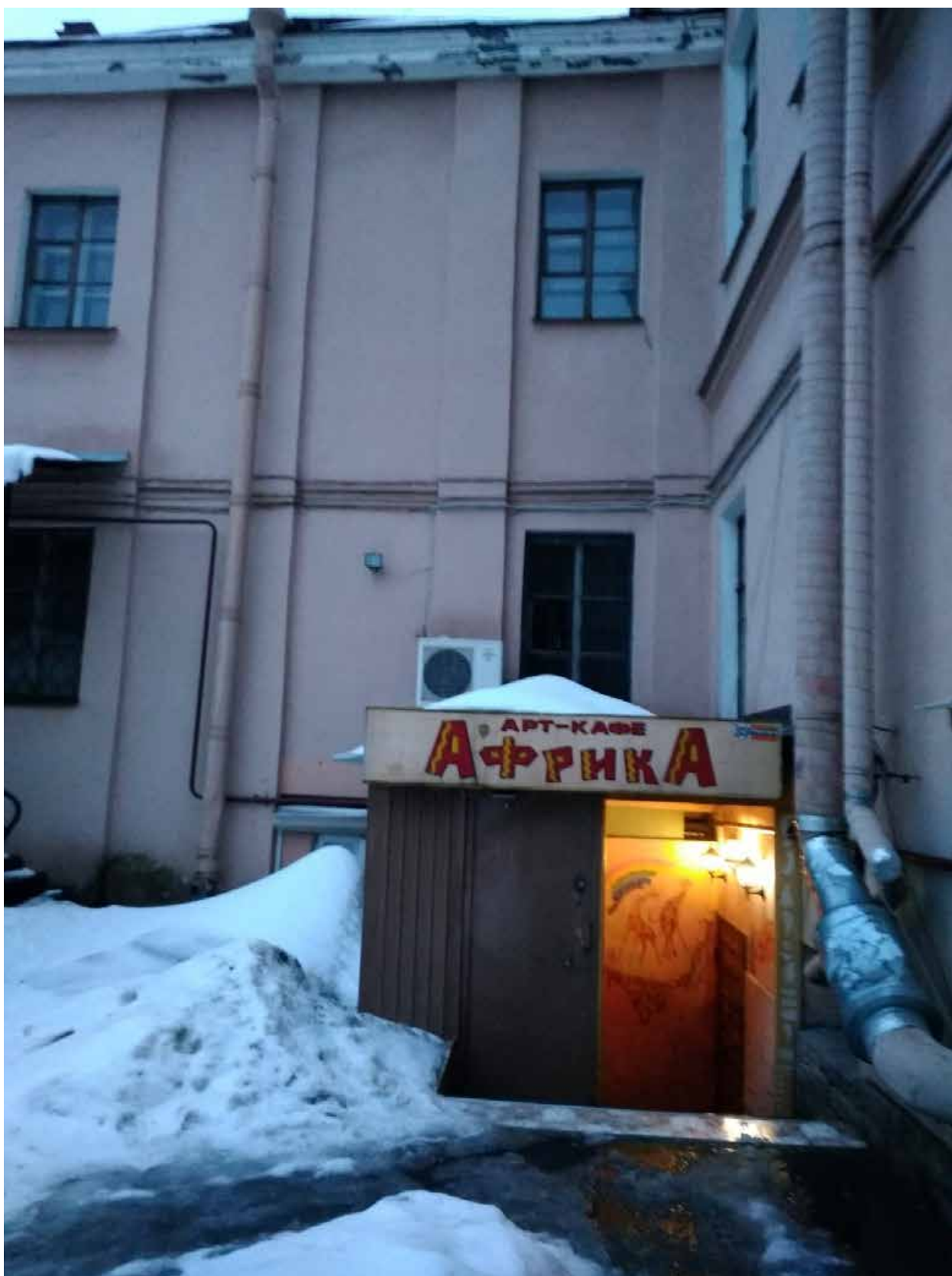
Фото 11. ВОКН «Особняк П.А. Поповой (с флигелями)», расположенный по адресу: г. Санкт-Петербург, наб. реки Фонтанки, д. 130, лит. А. Вид со двора на пристройку к флигелю, расположенному в западной границе участка.
