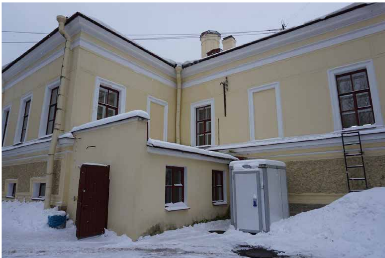
Фото 35. ВОКН «Александровская больница для рабочего населения в память 19-го февраля 1861 г. Комплекс с территорией, садом, оградами и постаментом от не сохранившегося бюста имп. Александра II» расположенный по адресу Санкт-Петербург, Троицкий пр., 1-3; Фонтанки р. наб., 132. Вид на северный фасад и входную группу «Часовни у Троицкого собора» (Фонтанки р. наб., 132Д) с нечетной стороны Троицкого пр.
