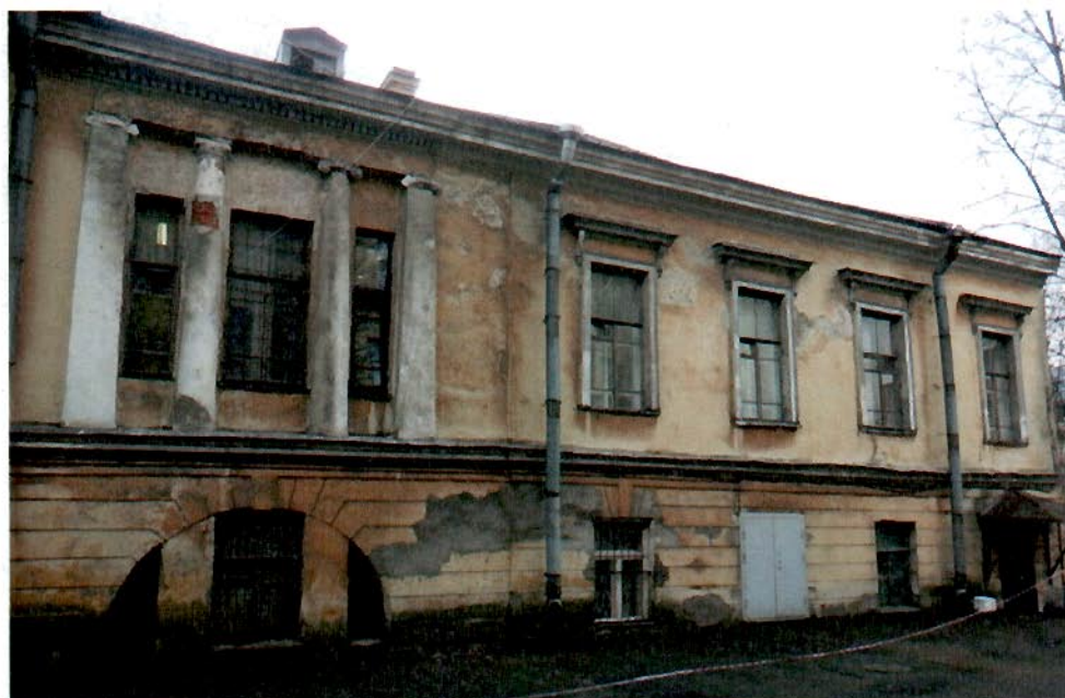
10. Фрагмент северного дворового фасада здания.
