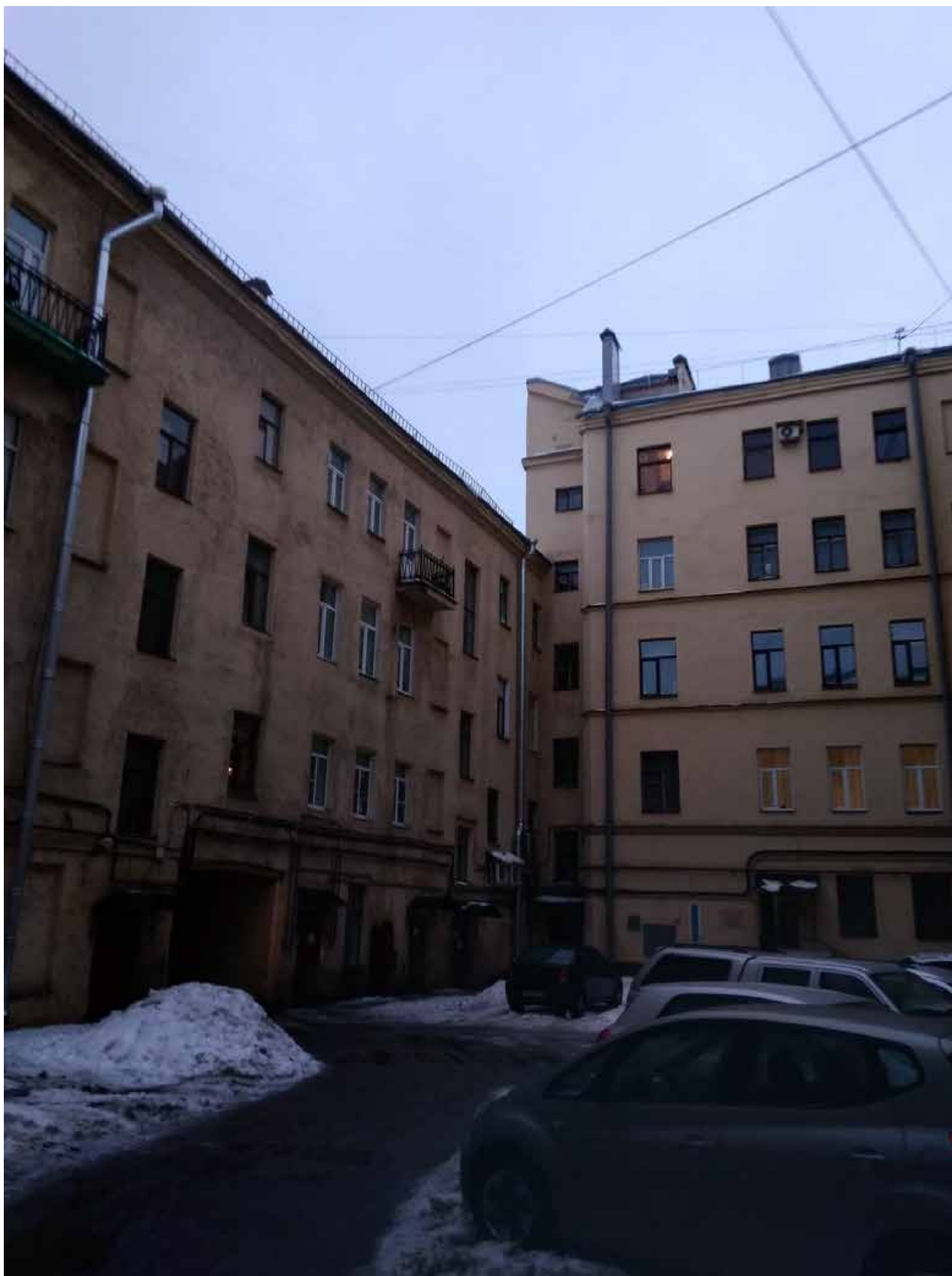
Фото 06. ВОКН «Дом Н. Шпейфера (доходный дом страхового общества "Саламандра")», расположенный по адресу Измайловский пр., 7; Троицкая пл. б/№. Вид со двора на северный и западный фасады.
