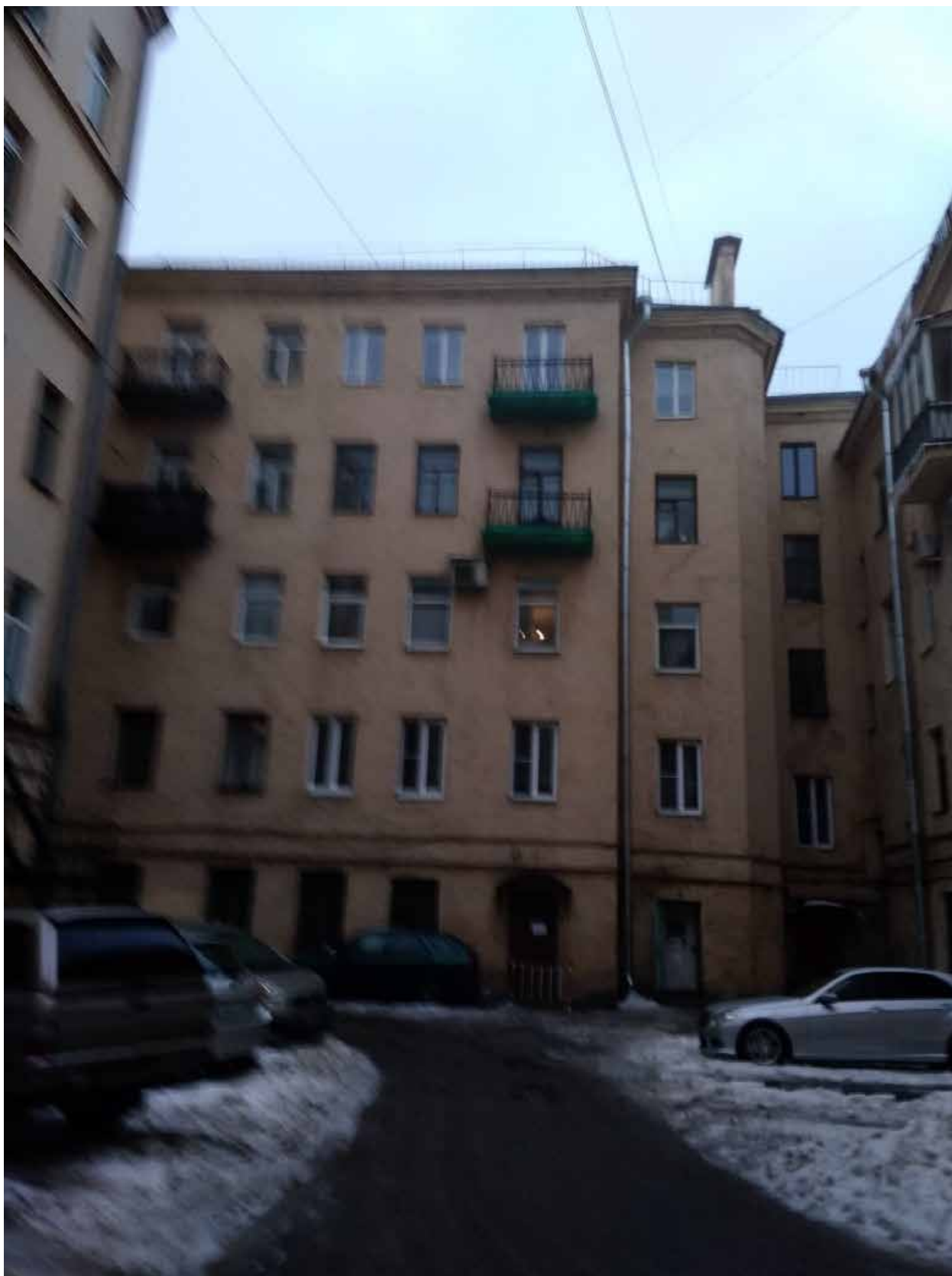
Фото 07. ВОКН «Дом Н. Шпейфера (доходный дом страхового общества "Саламандра")», расположенный по адресу Измайловский пр., 7; Троицкая пл. б/№. Вид со двора на северный фасад.
