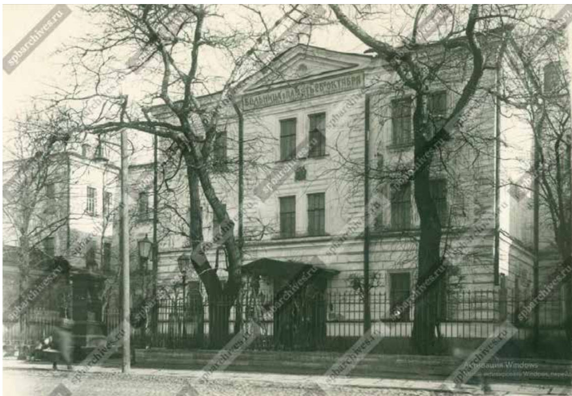
19. Внешний вид здания больницы. 1934 г. ЦГАКФФД СПб Шифр: Гр 58629.
