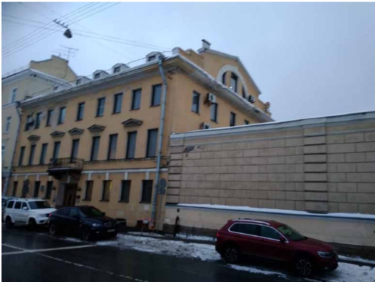
Фото 04. ВОКН «Здание (многоквартирный дом)», расположенный по адресу: Санкт-Петербург, набережная реки Фонтанки, дом 132, литера З. Вид на лицевой (северный) и западный фасады с четной стороны наб. р. Фонтанки.
