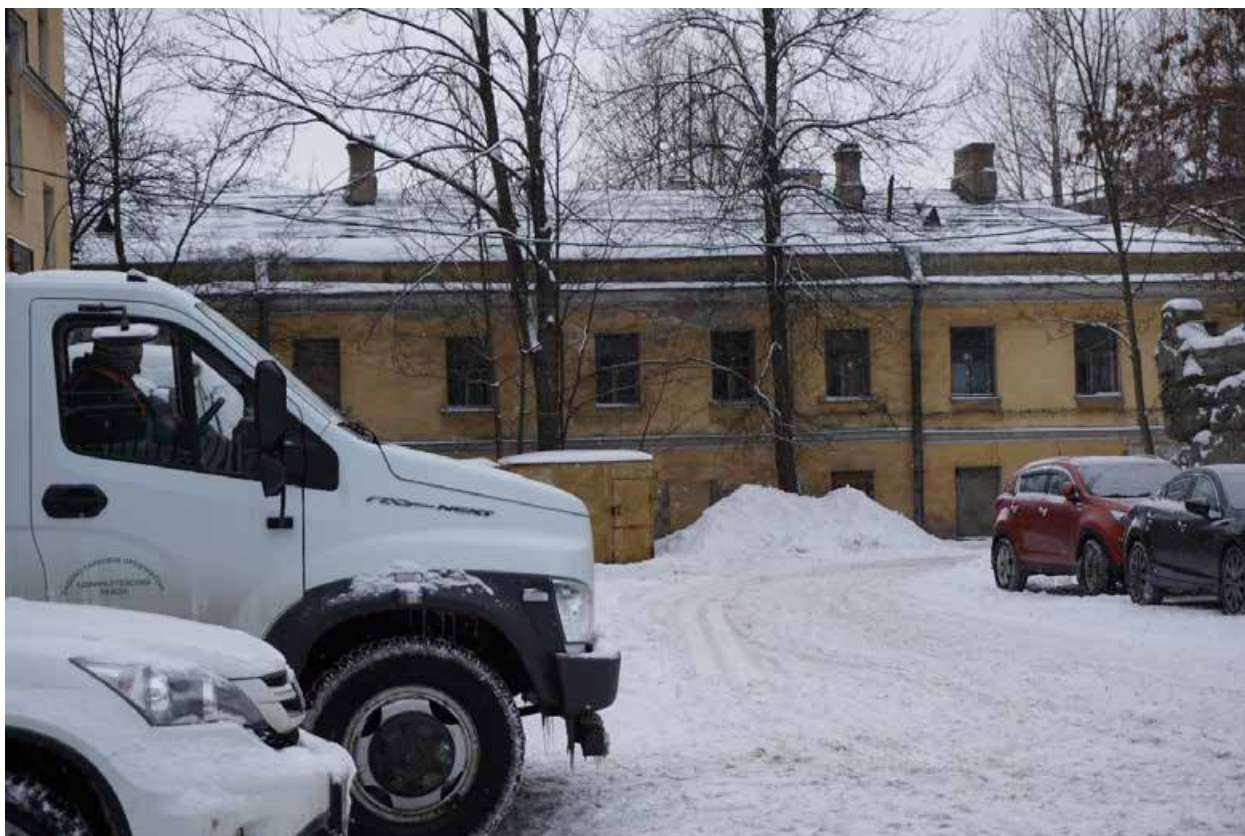
Фото 37. ВОКН «Александровская больница для рабочего населения в память 19-го февраля 1861 г. Комплекс с территорией, садом, оградами и постаментом от не сохранившегося бюста имп. Александра II» расположенный по адресу Санкт-Петербург, Троицкий пр., 1-3; Фонтанки р. наб., 132. Вид на северный фасад и внутренний двор флигеля (Фонтанки р. наб., 132Г) с нечетной стороны Троицкого пр.
