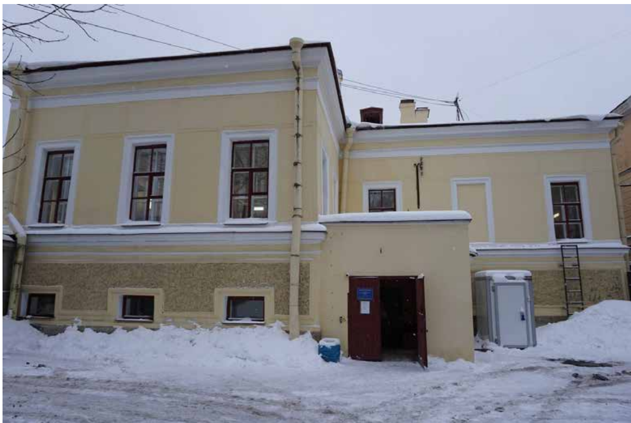
Фото 34. ВОКН «Александровская больница для рабочего населения в память 19-го февраля 1861 г. Комплекс с территорией, садом, оградами и постаментом от не сохранившегося бюста имп. Александра II» расположенный по адресу Санкт-Петербург, Троицкий пр., 1-3; Фонтанки р. наб., 132. Вид на северный фасад и входную «Часовни у Троицкого собора» (Фонтанки р. наб., 132Д) с нечетной стороны Троицкого пр.
