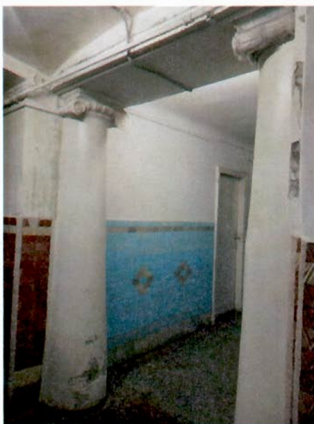
11. Фрагмент интерьера 1-го этажа здания.
