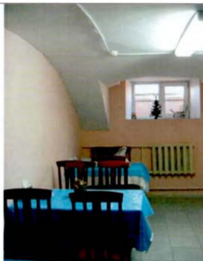
16. Подвал. Общий вид. Казачий квартирный флигель.
