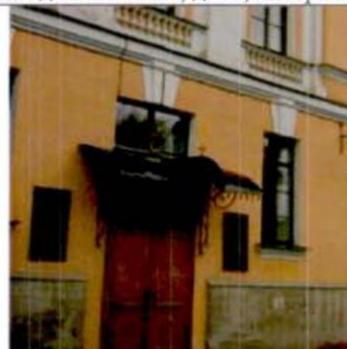
2. Дверной проем южного фасада.
