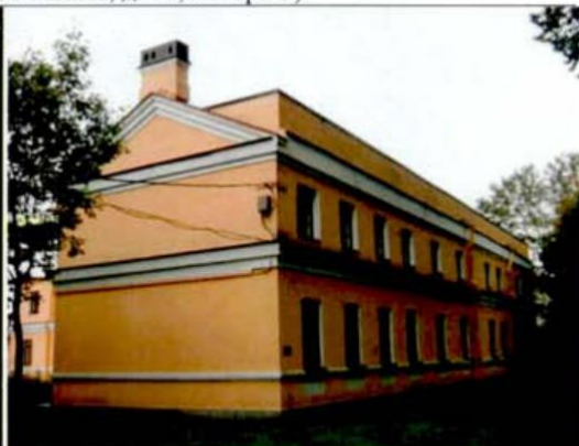
2. Восточный торцевой, северный фасады.
