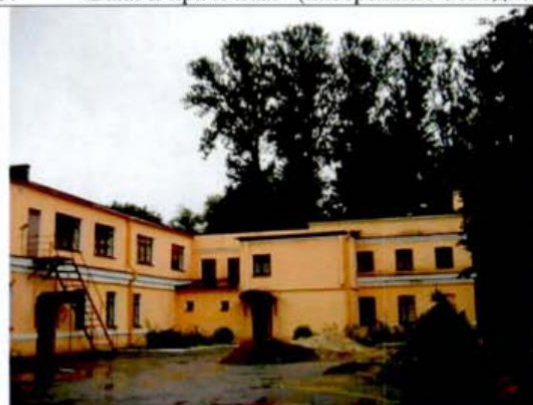
1. Южный, восточный фасады.
