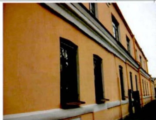
3. Фрагмент западного фасада.
