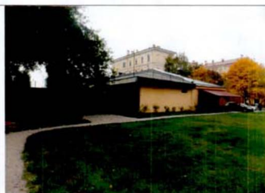
5. Северо-восточный участок территории. Вид на северный фасад Служебного корпуса.
