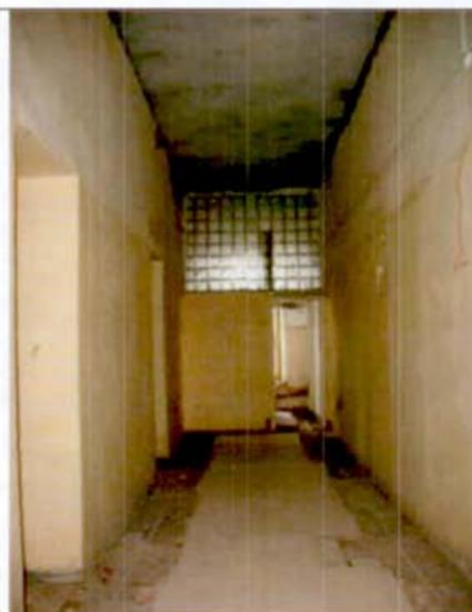
10. Коридор. Общий вид. Академический квартирный флигель.
