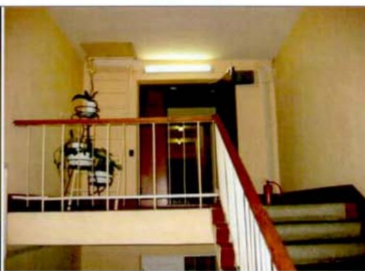
10. Лестница. Общий вид
