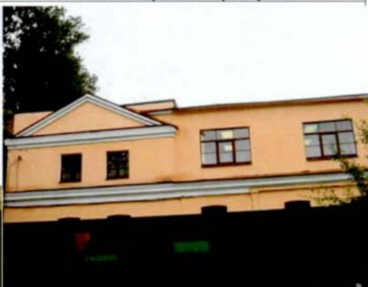
4. Фрагмент западного фасада.
