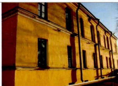
13. Западный фасад. Казачий квартирный флигель.
