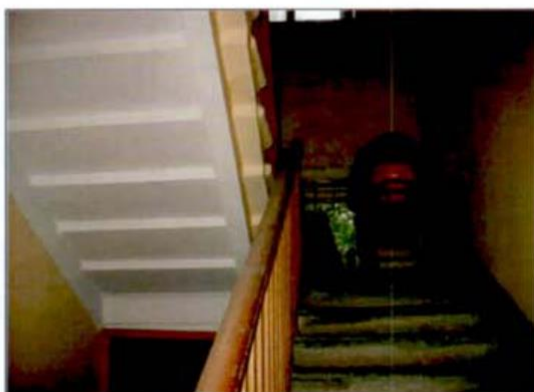
9. Лестница. Общий вид
