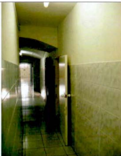
15. Подвал. Общий вид. Казачий квартирный флигель.
