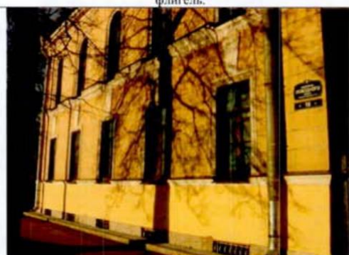
14. Южный фасад. Казачий квартирный флигель.
