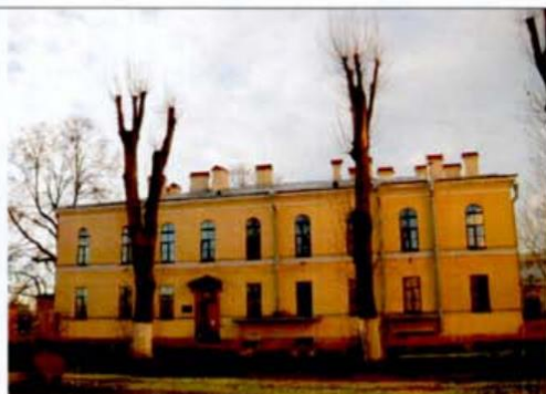
11. Восточный фасад. Казачий квартирный флигель.
