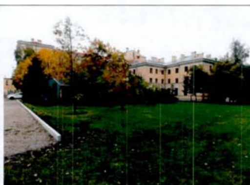
6. Северный участок территории. Вид на северный фасад здания Больницы.
