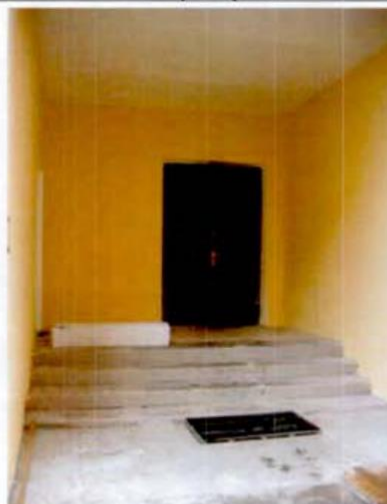
6. Дверной проем южного фасада.
