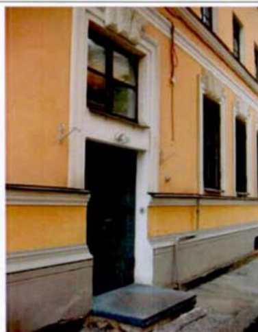
7. Дверной проем южного фасада.
