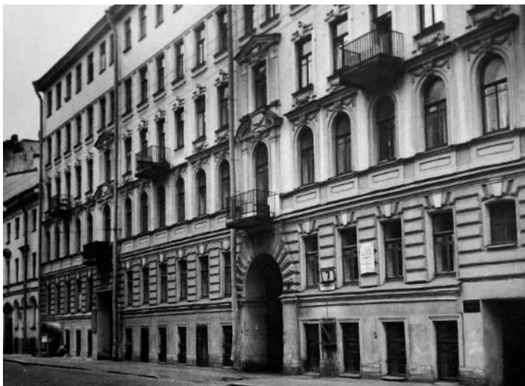
Илл. 16. Фото 1995 год. Объект культурного наследия федерального значения «Дом, где жили: в 1882-1910 гг. - композитор Балакирев М.А., в 1893-1895 гг. - революционер Кржижановский Г.М.», расположенный по адресу: Санкт-Петербург, Коломенская улица, д. 7, лит.А (Коломенская ул., 7). Размещено на Retro View of Mankind's Habitat [Электронный ресурс]. Режим доступа: https://pastvu.com/ .
