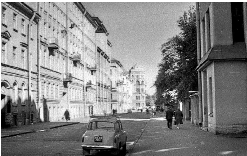
Илл. 15. Фото 1972-1978 гг. объекта культурного наследия федерального значения «Дом, где жили: в 1882-1910 гг. - композитор Балакирев М.А., в 1893-1895 гг. - революционер Кржижановский Г.М.», расположенного по адресу: Санкт-Петербург, Коломенская улица, д. 7, лит.А (Коломенская ул., 7). Размещено на Retro View of Mankind's Habitat [Электронный ресурс]. Режим доступа: https://pastvu.com/ .
