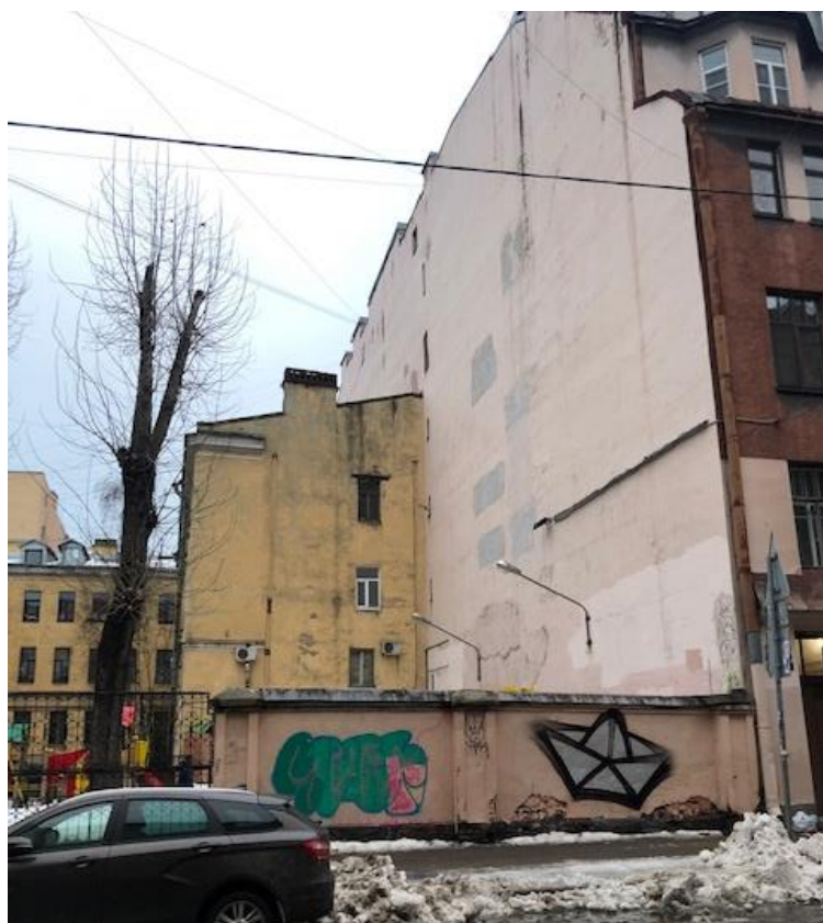
Фото 4. Участок производства работ
