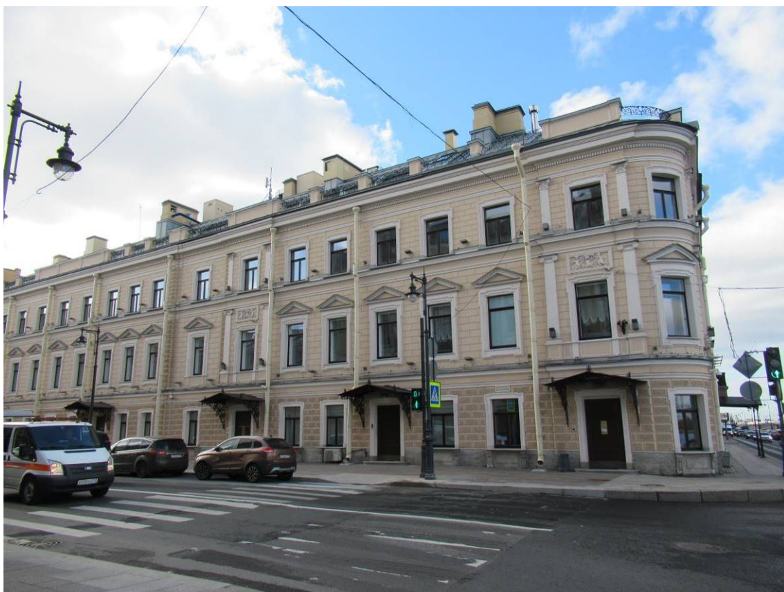
Илл. 02. Объект культурного наследия федерального значения «Дом Кушелева-Безбородко Г.А. (Елисеева А.Г.) с дворовыми флигелями». Вид на здание с перекрестка Гагаринской ул. и наб. Кутузова. Съемка 15.09.2021 г. Трушковский В. Э.
