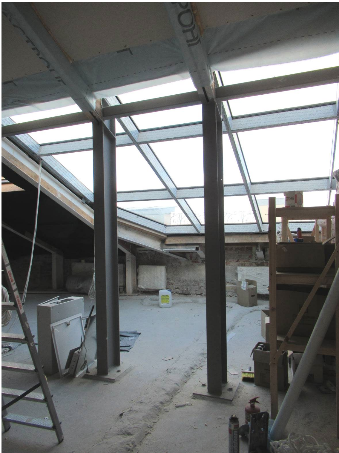
Илл. 18. Квартира № 5. 4-й этаж. Пом. 6/9,4; 7/44,9. Съемка 15.09.2021 г. Трушковский В. Э.
