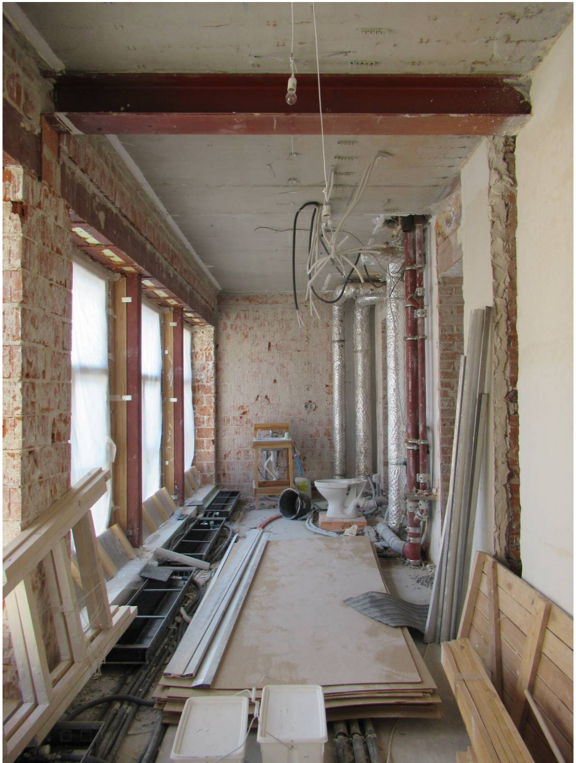
Илл. 06. Квартира № 3. 3-й этаж. Пом. 1/26,5; 2/7,2. Съемка 15.09.2021 г. Трушковский В. Э.
