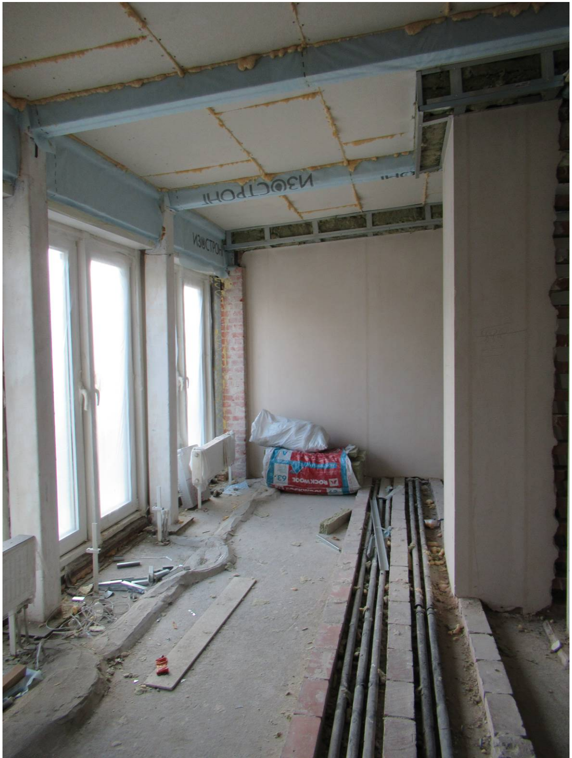
Илл. 13. Квартира № 5. 4-й этаж. Пом. 2/14,4. Съемка 15.09.2021 г. Трушковский В. Э.
