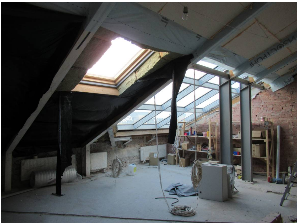
Илл. 16. Квартира № 5. 4-й этаж. Пом. 6/9,4; 7/44,9. Съемка 15.09.2021 г. Трушковский В. Э.
