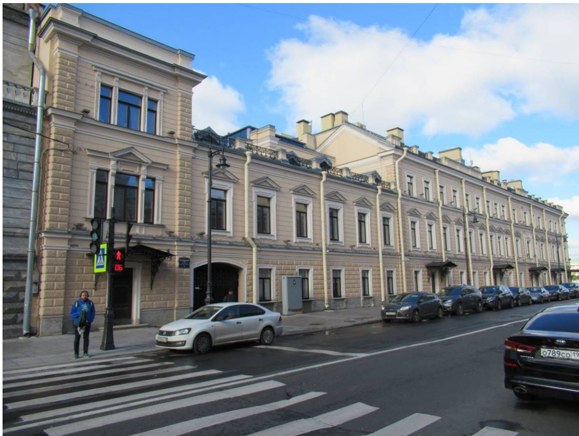
Илл. 01. Объект культурного наследия федерального значения «Дом Кушелева-Безбородко Г.А. (Елисеева А.Г.) с дворовыми флигелями». Вид на здание с Гагаринской ул. с южной стороны. Съемка 15.09.2021 г. Трушковский В. Э.
