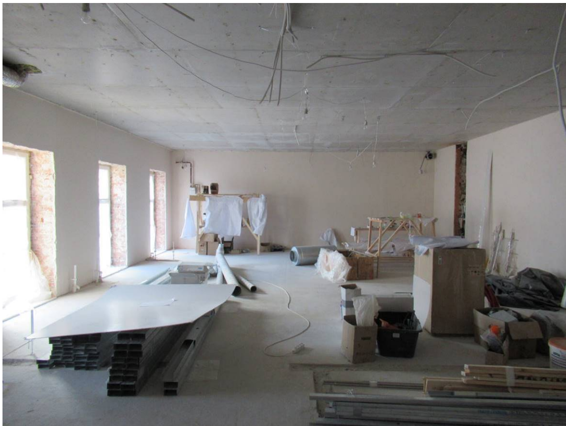
Илл. 07. Квартира № 3. 3-й этаж. Пом. 3/15,6; 4/64,2; 5/11,8. Съемка 15.09.2021 г. Трушковский В. Э.
