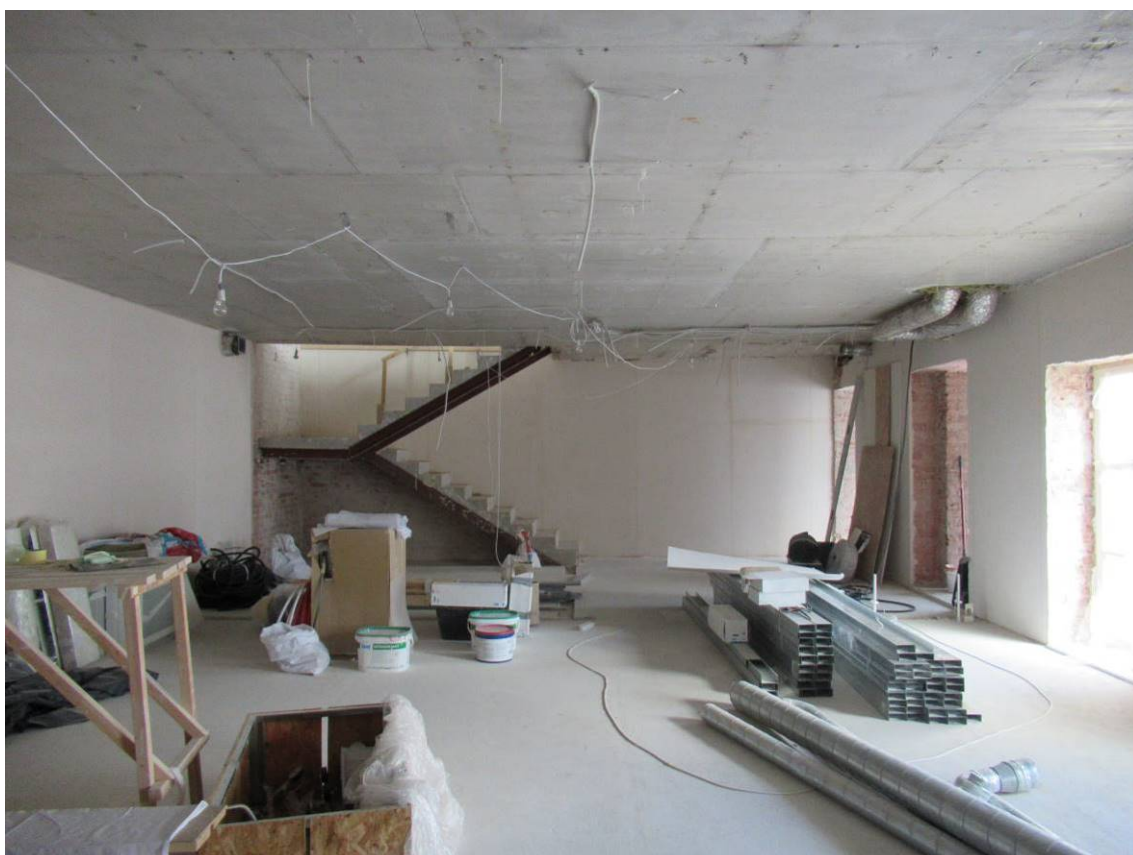
Илл. 08. Квартира № 3. 3-й этаж. Пом. 3/15,6; 4/64,2; 5/11,8. Съемка 15.09.2021 г. Трушковский В. Э.
