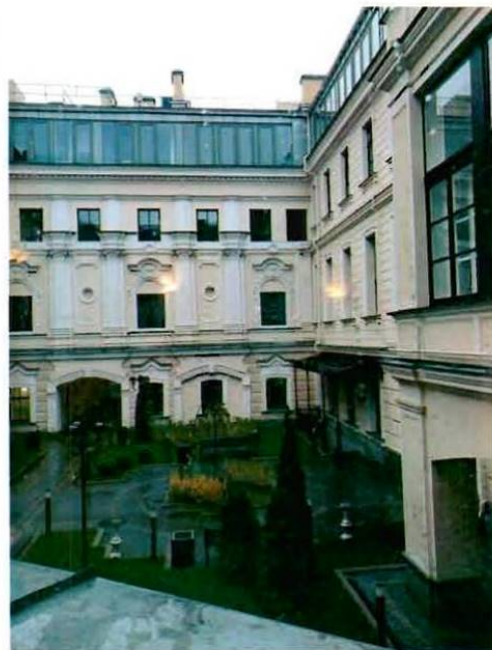
7. Фрагмент дворового фасада объекта культурного наследия.
