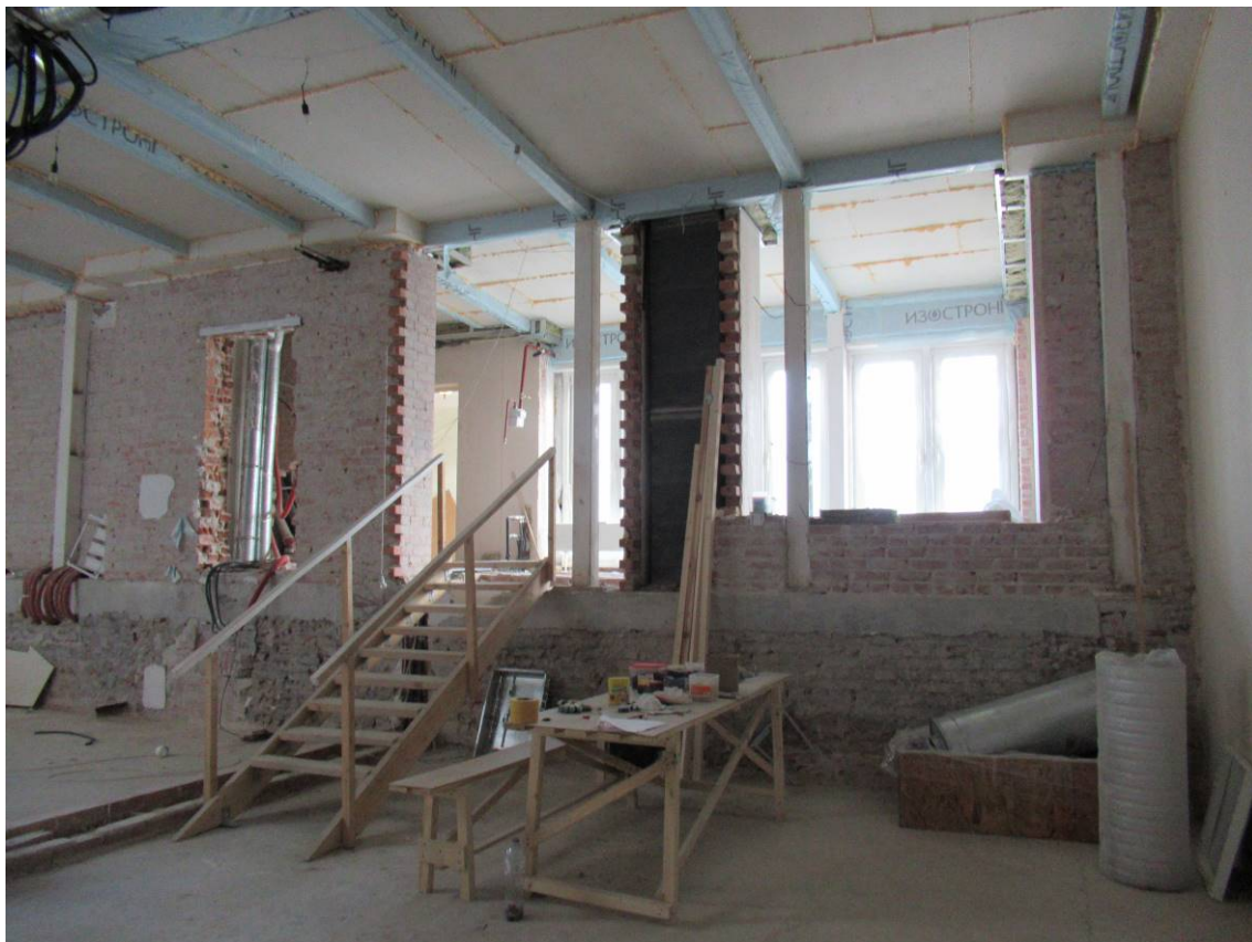
Илл. 14. Квартира № 5. 4-й этаж. Пом. 3/41,4; 4/24,5; 5/25,2; 8/6,8; 9/4,4. Съемка 15.09.2021 г. Трушковский В. Э.
