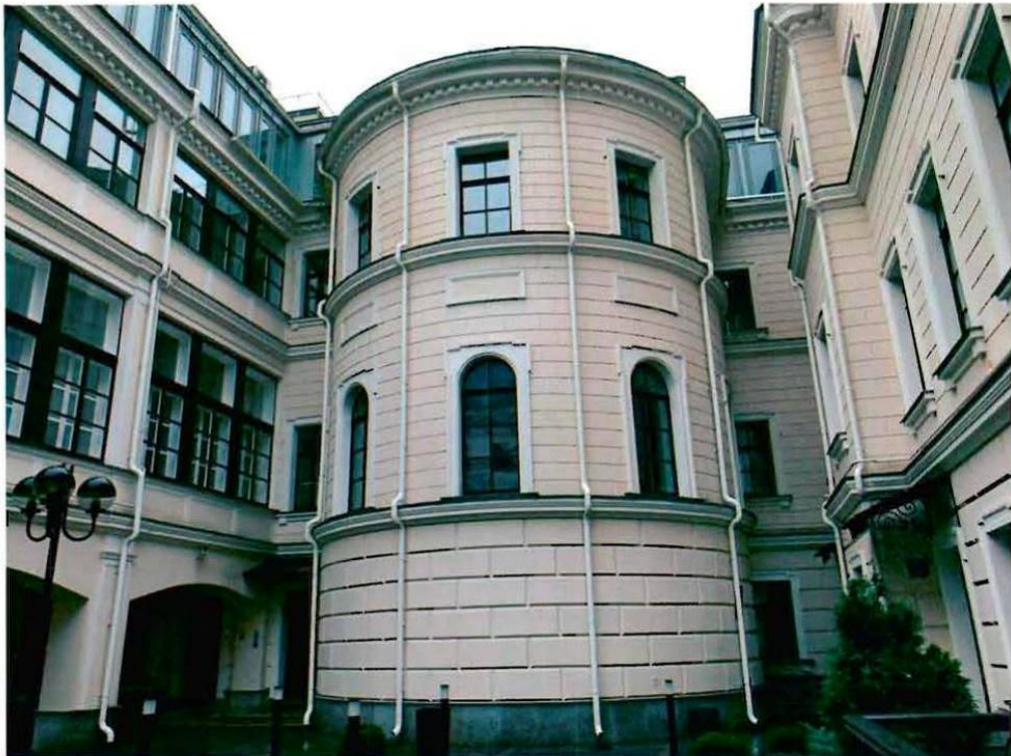
5. Фрагмент дворового фасада объекта культурного наследия. Северный фасад северного двора.
