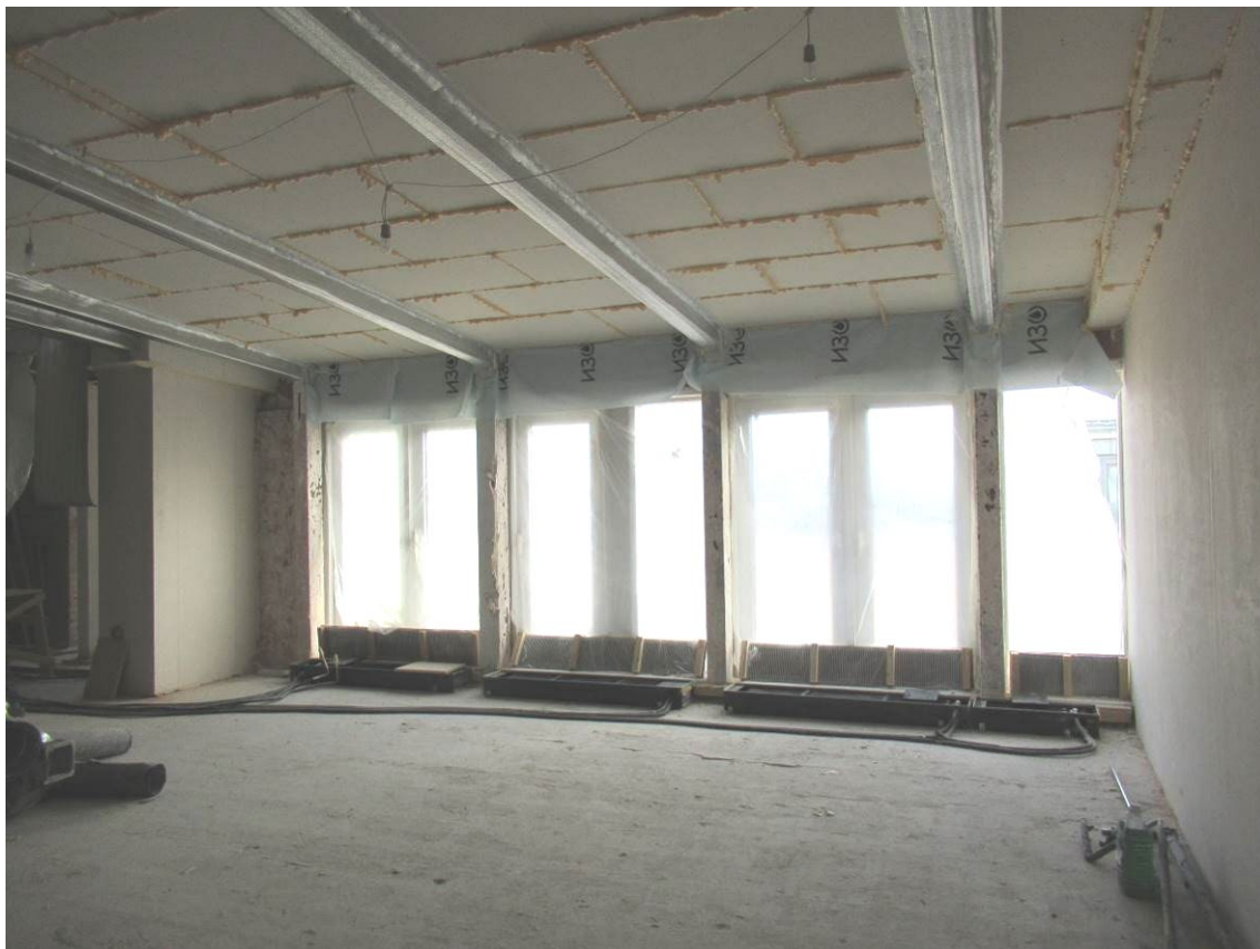
Илл. 09. Квартира № 3. 4-й этаж. Пом. 11/12,7; 10/37,6; 9/29,7; 7/12,5. Съемка 15.09.2021 г. Трушковский В. Э.
