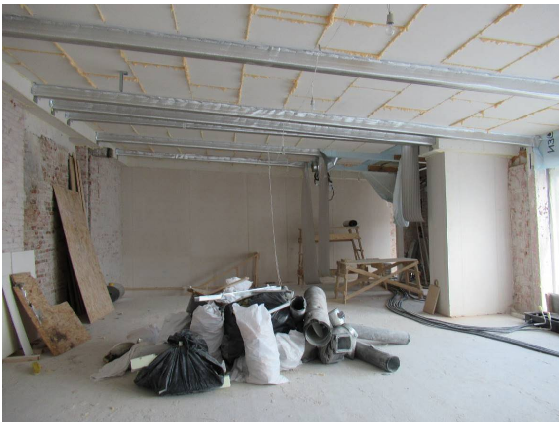
Илл. 10. Квартира № 3. 4-й этаж. Пом. 11/12,7; 10/37,6; 9/29,7; 7/12,5. Съемка 15.09.2021 г. Трушковский В. Э.
