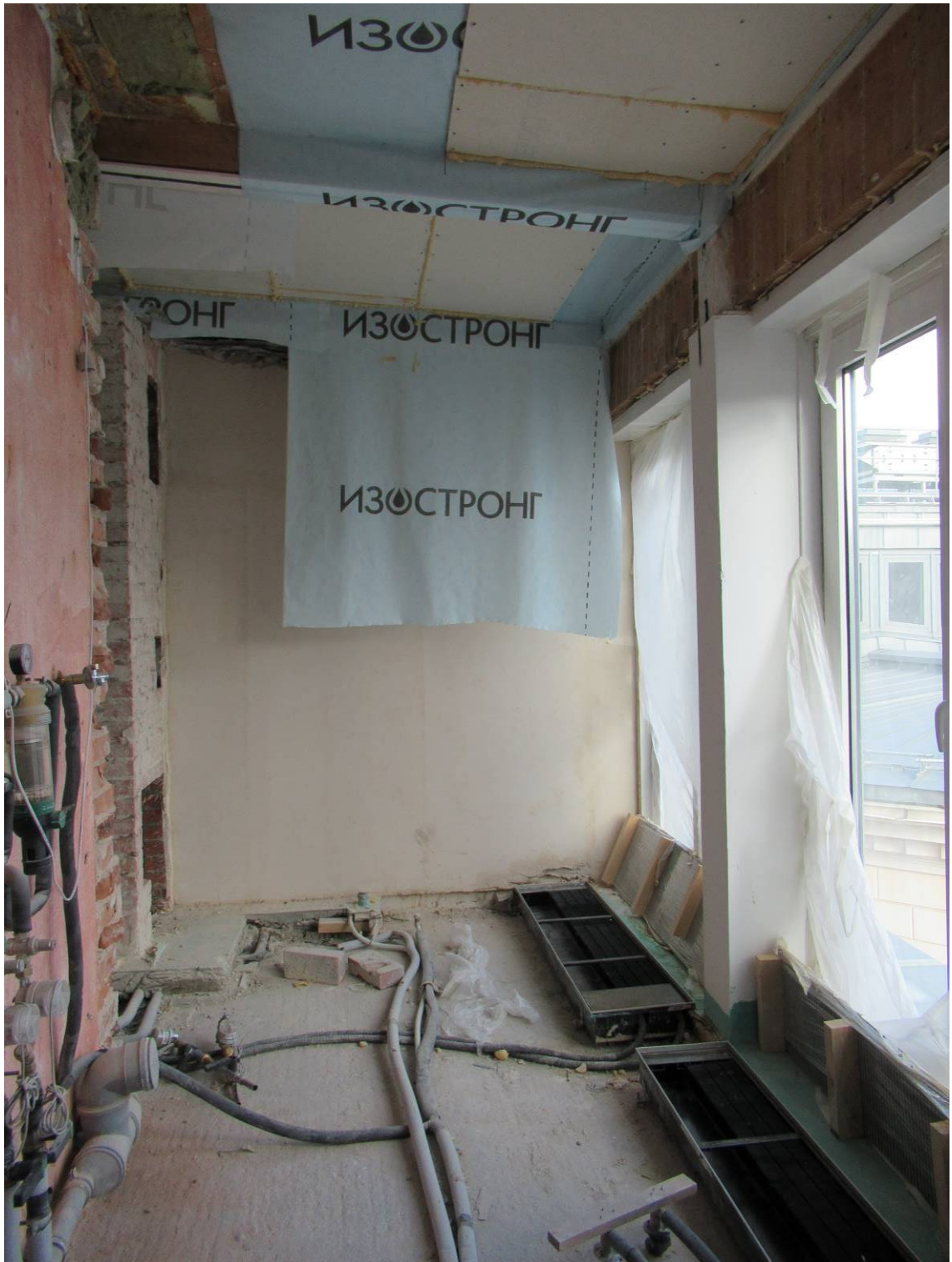
Илл. 11. Квартира № 3. 4-й этаж. Пом. 8/10,1; 9/29,7. Съемка 15.09.2021 г. Трушковский В. Э.
