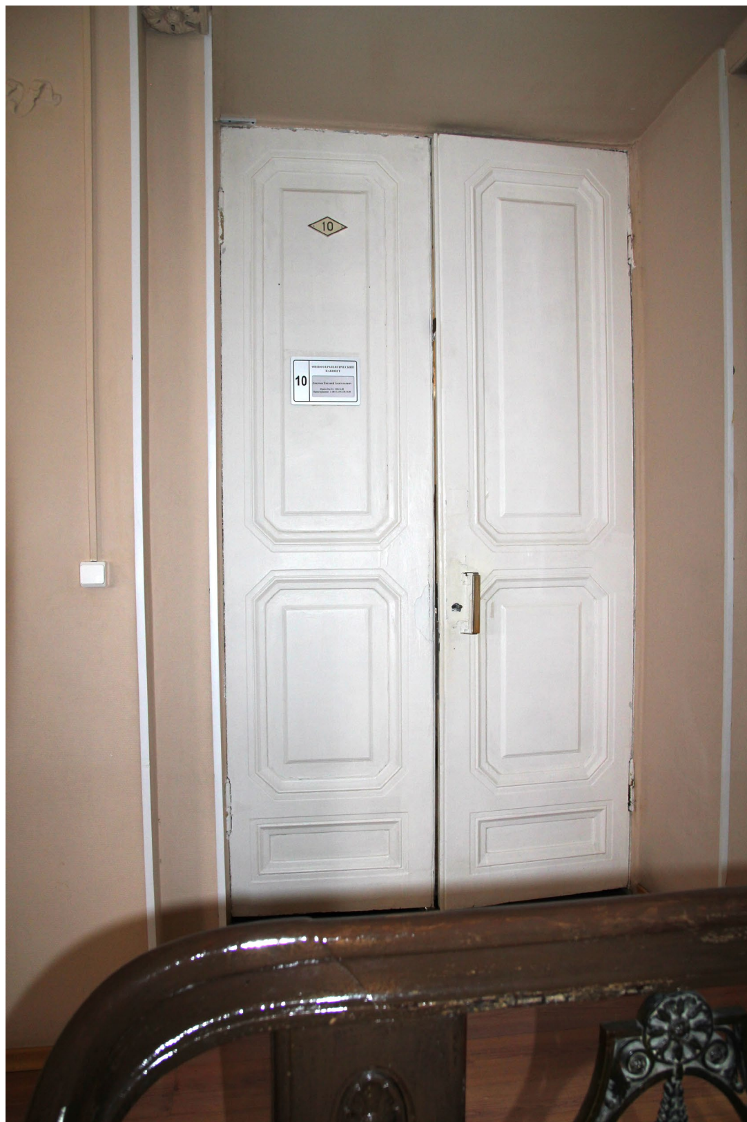
Фото 51. Помещение №68. Дверное заполнение ДВ-6б в помещение №77
