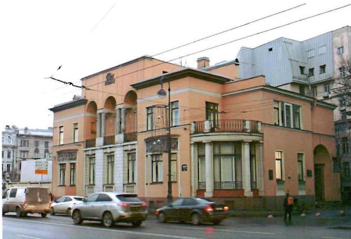
Фото №1. Вид на лицевые (северный и восточный) фасады со стороны Каменноостровского проспекта.
