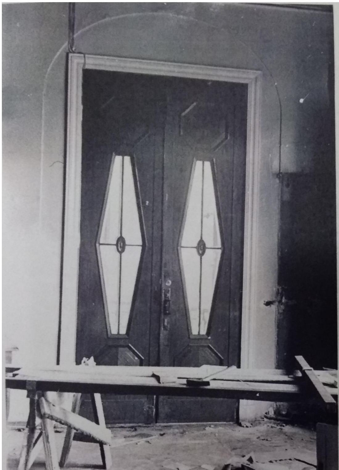
67. Особняк М.К. Покотиловой. Гостиная во время ремонта. Входные двери. Фото. 1970 г. /Возможно, двери в северной стене помещения №43 ?/ Опубл.: КГИОП. п. 865. Н-7772. Историко-культурная экспертиза объекта недвижимого имущества, расположенного по адресу: Санкт-Петербург, Петроградский район, наб. р. Карповки, 31 лит. А, и прилегающего участка, по адресу: Каменно-островский пр., 48; Карповский пер., 2. / ООО "Архитектурная мастерская Т. А. Славиной". СПб., 2006. Ил. 66.
