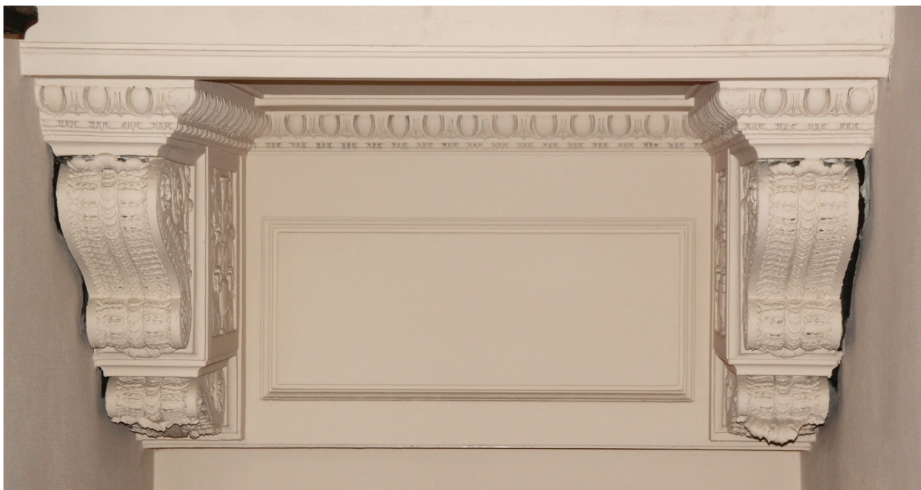
Фото 45. Общий вид кронштейнов
