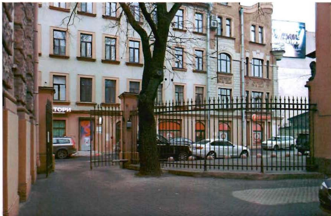
Фото №17. Вид со стороны двора.
