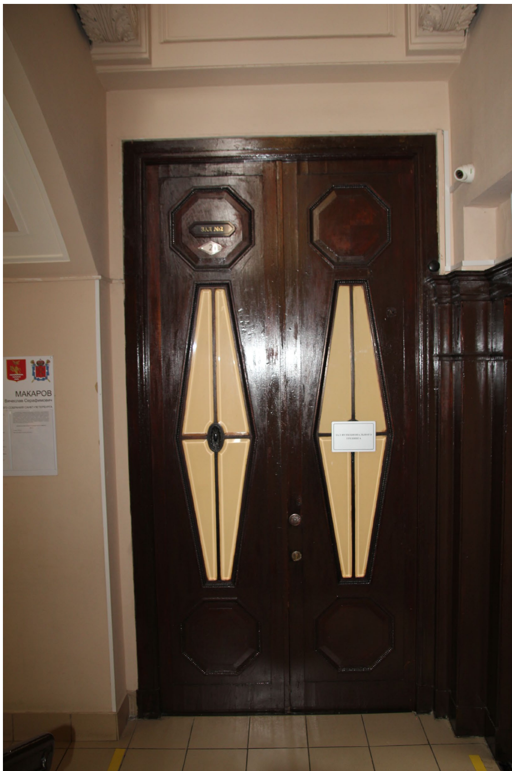
Фото 29. Помещение №43. Общий вид дверного заполнения ДВ-2в
