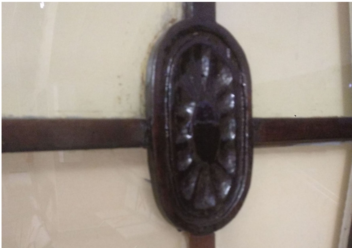
Фото 27 Фрагмент дверного заполнения ДВ-2б. Поздняя декоративная розетка
