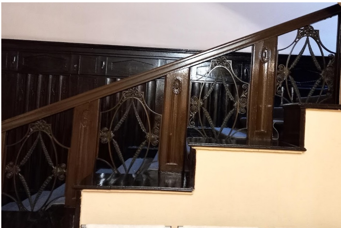
Фото 36. Помещение №43. Фрагмент ограждения лестницы
