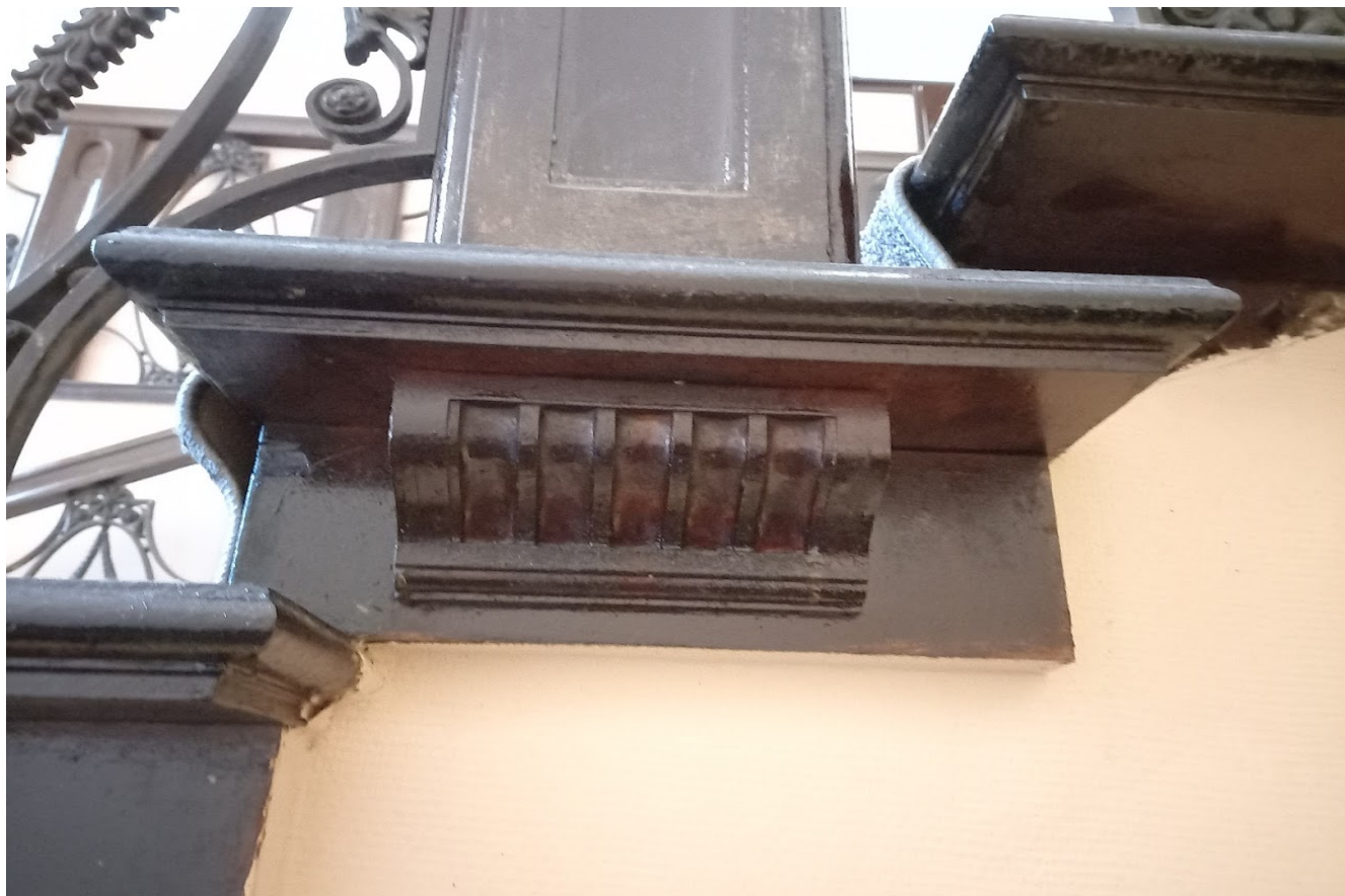
Фото 42. Фрагмент лестничной клетки. Кронштейн ступени. Фронтальный вид
