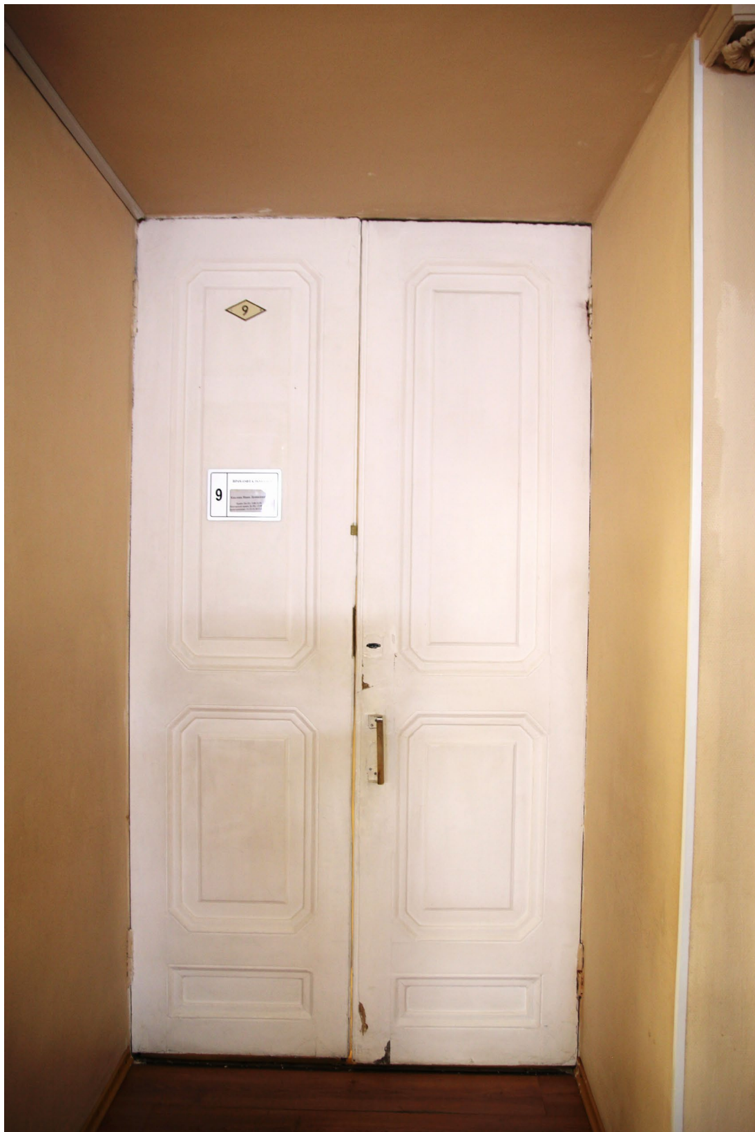
Фото 50. Помещение №68. Дверное заполнение ДВ-6 в помещение №76
