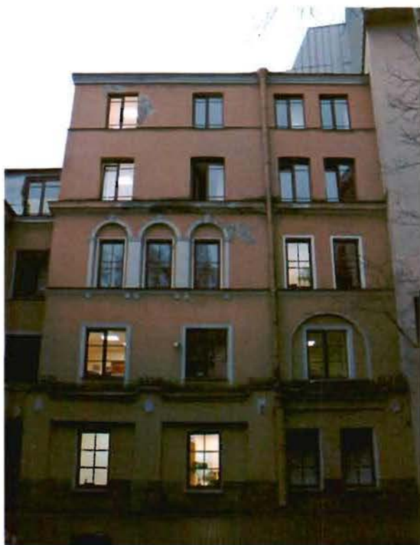
Фото №15. Вид на северный фасад со стороны двора.
