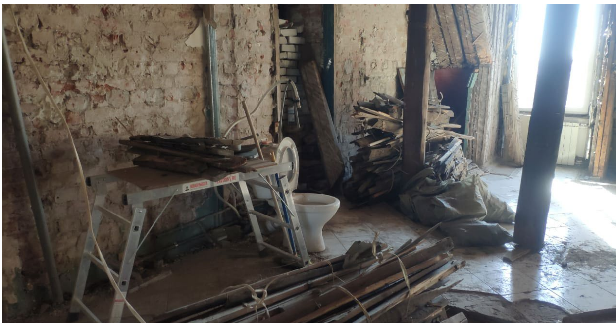
Фото № 7. Интерьер квартиры № 26. Помещения 1,6,7,8,9,10. Перегородки и ценные элементы архитектурно-художественной отделки отсутствуют. Проводятся противоаварийные работы.
