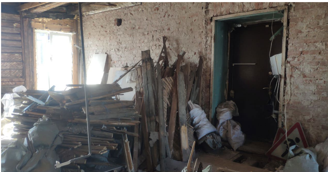
Фото № 5. Интерьер квартиры № 26. Помещения 1,6,7,8,9,10. Перегородки и ценные элементы архитектурно-художественной отделки отсутствуют. Проводятся противоаварийные работы.
