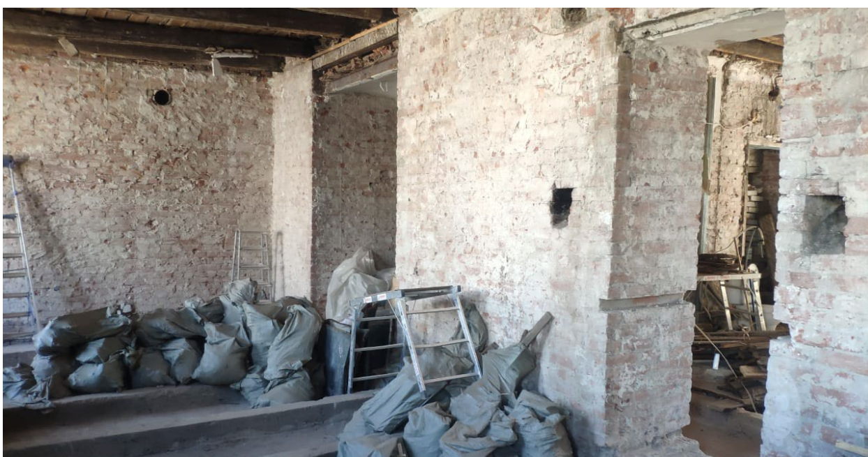
Фото № 6. Интерьер квартиры № 26. Помещения 3,4,5. Перегородки и ценные элементы архитектурно-художественной отделки отсутствуют. Проводятся противоаварийные работы.
