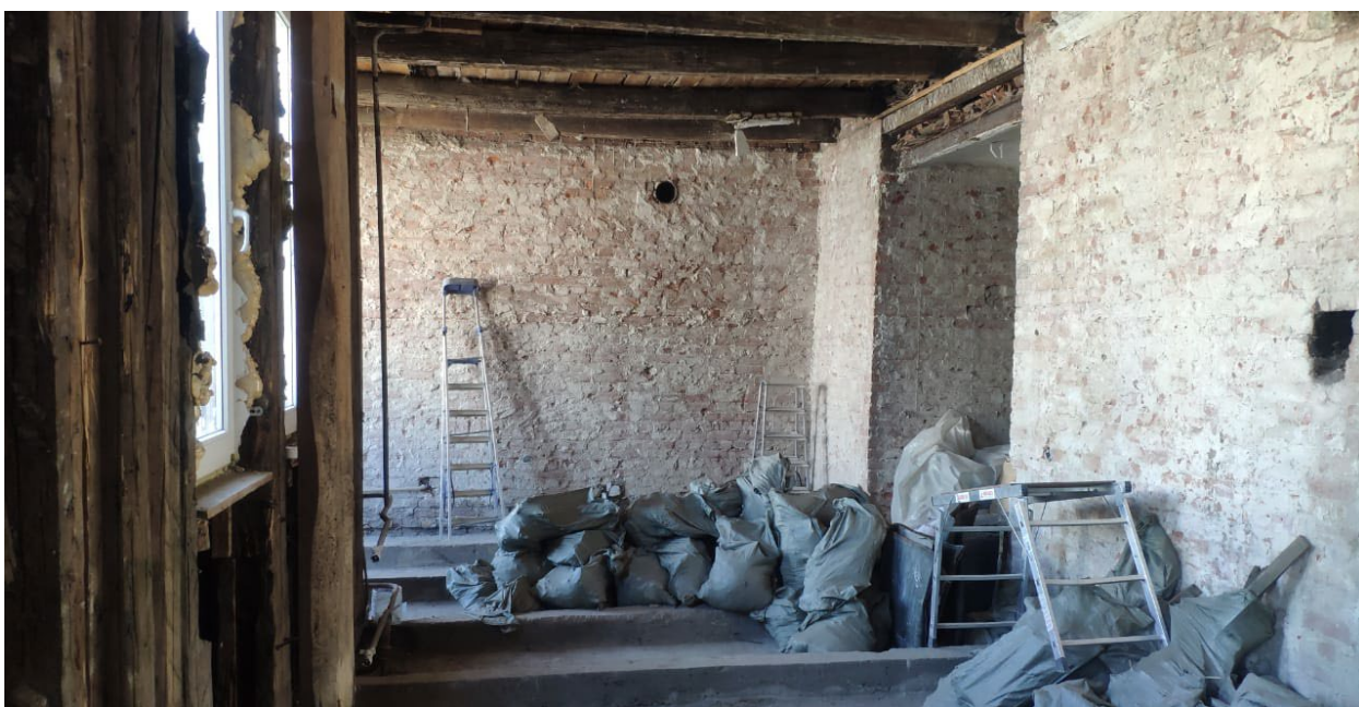
Фото № 8. Интерьер квартиры № 26. Помещения 3,4. Перегородки и ценные элементы архитектурно-художественной отделки отсутствуют. Проводятся противоаварийные работы.
