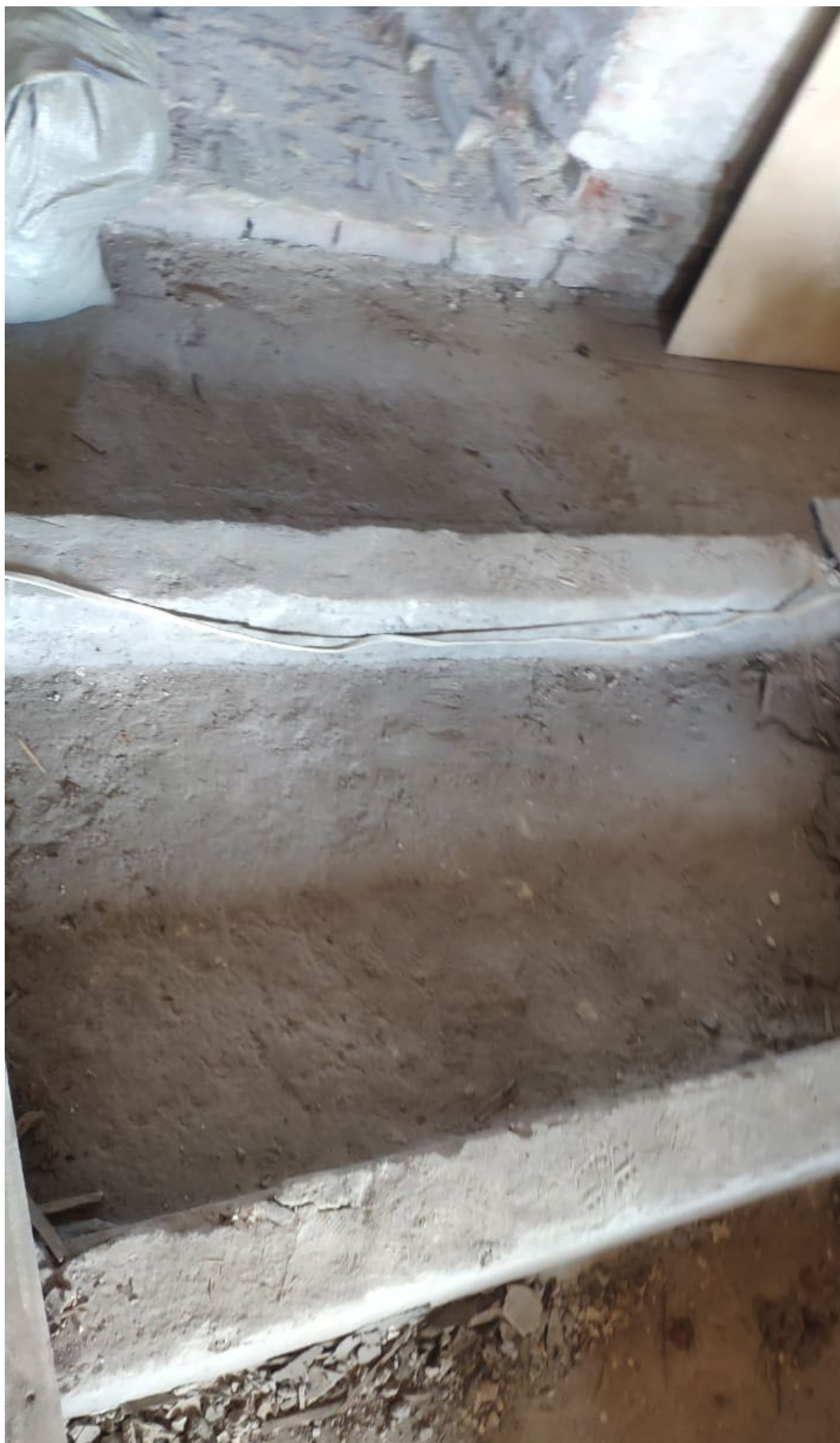
Фото № 9. Интерьер квартиры № 26. Помещение 4. Покрытие пола снято. Проводятся противоаварийные работы.
