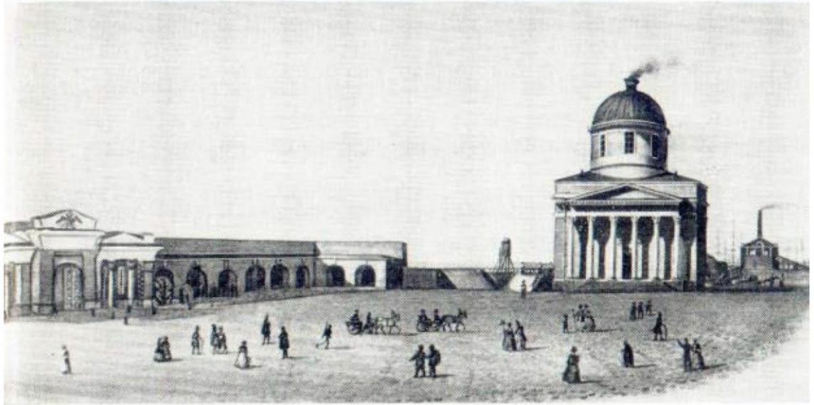
11. Кронштадт. Водоподъемная башня и Петербургские ворота. Нач. XIX в.
