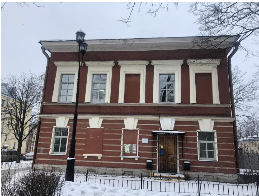
3. Объект культурного наследия федерального значения «Дом пастора», расположенный по адресу: г. Санкт-Петербург, г. Кронштадт, Ленинградская ул., д. 1, литера А, входящий в состав объекта культурного наследия федерального значения «Храм лютеранский святой Елизаветы», расположенный по адресу: г. Санкт-Петербург, г. Кронштадт, Ленинградская ул., д. 1, литеры А, Н. Юго-восточный торцевой фасад. Общий вид.
