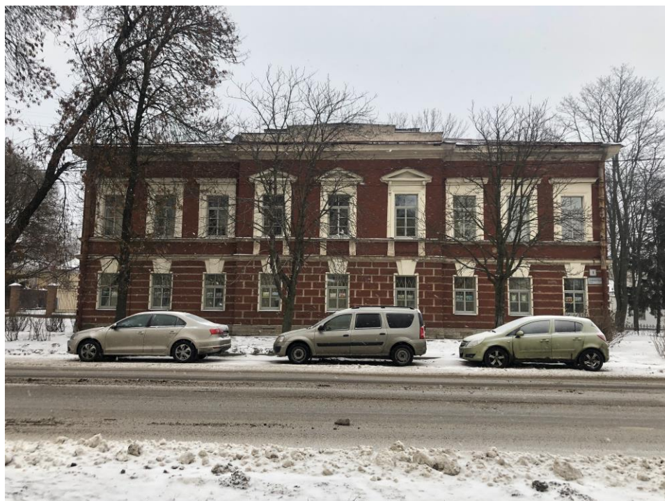
1. Объект культурного наследия федерального значения «Дом пастора», расположенный по адресу: г. Санкт-Петербург, г. Кронштадт, Ленинградская ул., д. 1, литера А, входящий в состав объекта культурного наследия федерального значения «Храм лютеранский святой Елизаветы», расположенный по адресу: г. Санкт-Петербург, г. Кронштадт, Ленинградская ул., д. 1, литеры А, Н. Юго-западный лицевой фасад. Общий вид со стороны Ленинградской улицы.
