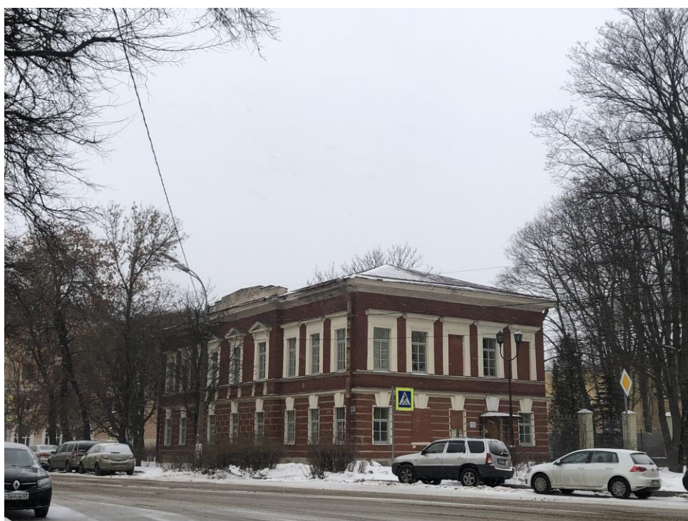
2. Объект культурного наследия федерального значения «Дом пастора», расположенный по адресу: г. Санкт-Петербург, г. Кронштадт, Ленинградская ул., д. 1, литера А, входящий в состав объекта культурного наследия федерального значения «Храм лютеранский святой Елизаветы», расположенный по адресу: г. Санкт-Петербург, г. Кронштадт, Ленинградская ул., д. 1, литеры А, Н. Общий вид со стороны Ленинградской улицы.
