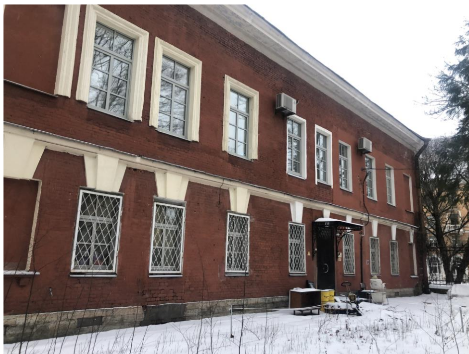
7. Объект культурного наследия федерального значения «Дом пастора», расположенный по адресу: г. Санкт-Петербург, г. Кронштадт, Ленинградская ул., д. 1, литера А, входящий в состав объекта культурного наследия федерального значения «Храм лютеранский святой Елизаветы», расположенный по адресу: г. Санкт-Петербург, г. Кронштадт, Ленинградская ул., д. 1, литеры А, Н. Вид на северо-восточный фасад.
