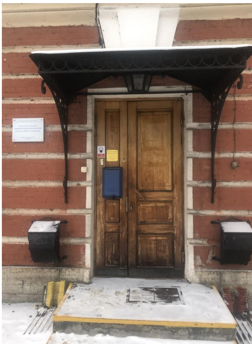
5. Объект культурного наследия федерального значения «Дом пастора», расположенный по адресу: г. Санкт-Петербург, г. Кронштадт, Ленинградская ул., д. 1, литера А, входящий в состав объекта культурного наследия федерального значения «Храм лютеранский святой Елизаветы», расположенный по адресу: г. Санкт-Петербург, г. Кронштадт, Ленинградская ул., д. 1, литеры А, Н. Фрагмент юго-восточного торцевого фасада. Оформление дверного проема.
