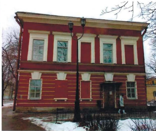
2. Северо-восточный торцевой фасад.
