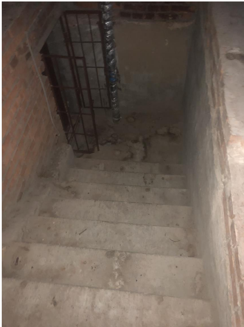
19. Объект культурного наследия федерального значения «Дом пастора», расположенный по адресу: г. Санкт-Петербург, г. Кронштадт, Ленинградская ул., д. 1, литера А, входящий в состав объекта культурного наследия федерального значения «Храм лютеранский святой Елизаветы», расположенный по адресу: г. Санкт-Петербург, г. Кронштадт, Ленинградская ул., д. 1, литеры А, Н. Чердачное помещение. Фрагмент лестницы.
