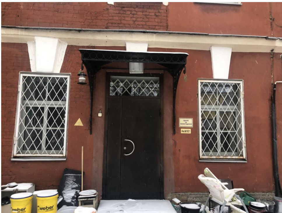
9. Объект культурного наследия федерального значения «Дом пастора», расположенный по адресу: г. Санкт-Петербург, г. Кронштадт, Ленинградская ул., д. 1, литера А, входящий в состав объекта культурного наследия федерального значения «Храм лютеранский святой Елизаветы», расположенный по адресу: г. Санкт-Петербург, г. Кронштадт, Ленинградская ул., д. 1, литеры А, Н. Фрагмент северо-восточного фасада. Оформление дверного проема.
