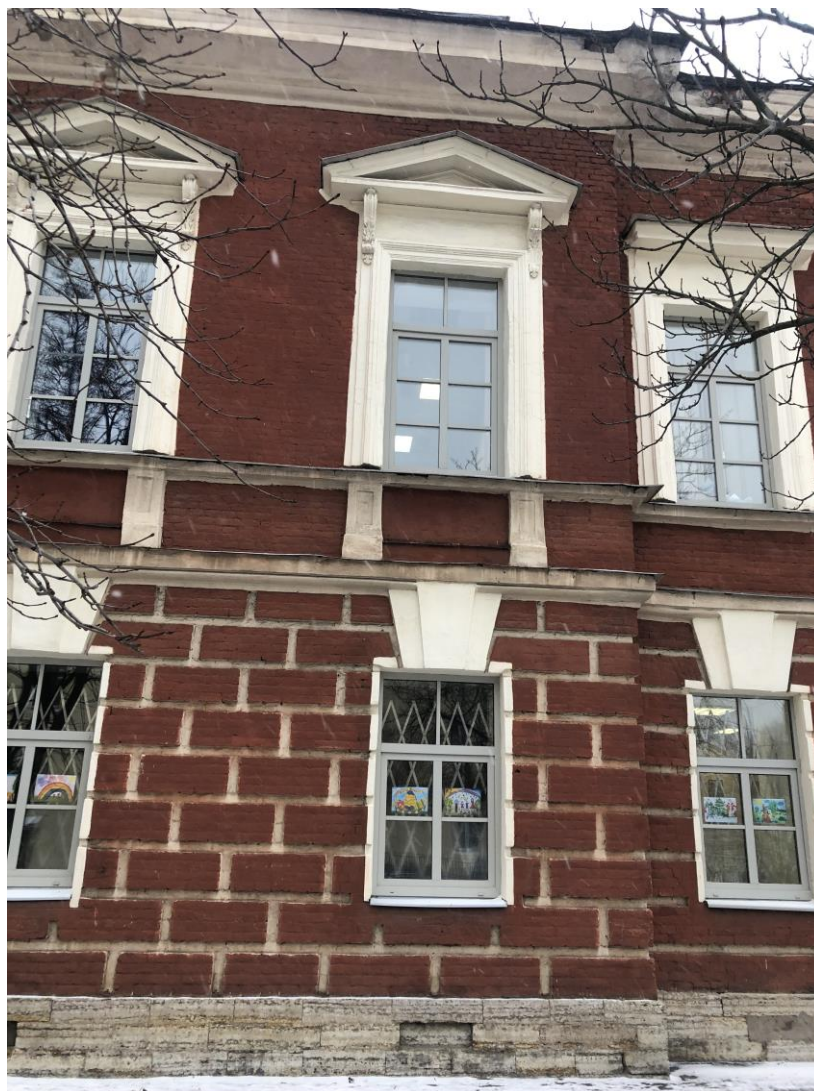
15. Объект культурного наследия федерального значения «Дом пастора», расположенный по адресу: г. Санкт-Петербург, г. Кронштадт, Ленинградская ул., д. 1, литера А, входящий в состав объекта культурного наследия федерального значения «Храм лютеранский святой Елизаветы», расположенный по адресу: г. Санкт-Петербург, г. Кронштадт, Ленинградская ул., д. 1, литеры А, Н. Фрагмент юго-западного лицевого фасада. Оформление оконных проемов.
