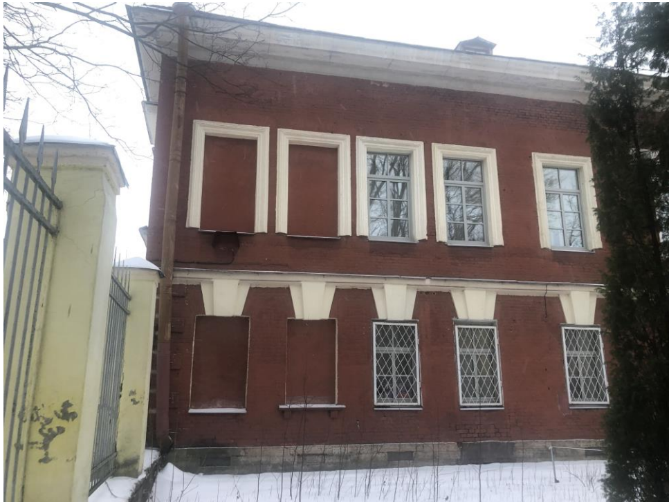
8. Объект культурного наследия федерального значения «Дом пастора», расположенный по адресу: г. Санкт-Петербург, г. Кронштадт, Ленинградская ул., д. 1, литера А, входящий в состав объекта культурного наследия федерального значения «Храм лютеранский святой Елизаветы», расположенный по адресу: г. Санкт-Петербург, г. Кронштадт, Ленинградская ул., д. 1, литеры А, Н. Фрагмент северо-восточного фасада. Оформление оконных проемов.
