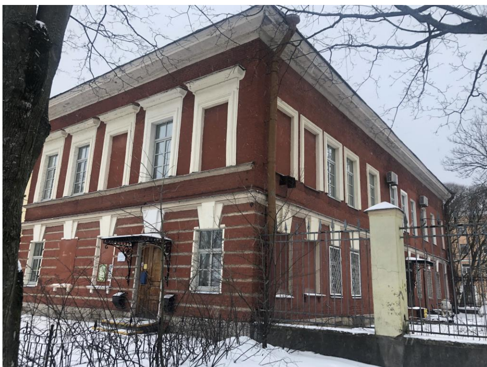
4. Объект культурного наследия федерального значения «Дом пастора», расположенный по адресу: г. Санкт-Петербург, г. Кронштадт, Ленинградская ул., д. 1, литера А, входящий в состав объекта культурного наследия федерального значения «Храм лютеранский святой Елизаветы», расположенный по адресу: г. Санкт-Петербург, г. Кронштадт, Ленинградская ул., д. 1, литеры А, Н. Общий вид на юго-восточный торцевой и северо-восточный фасады.
