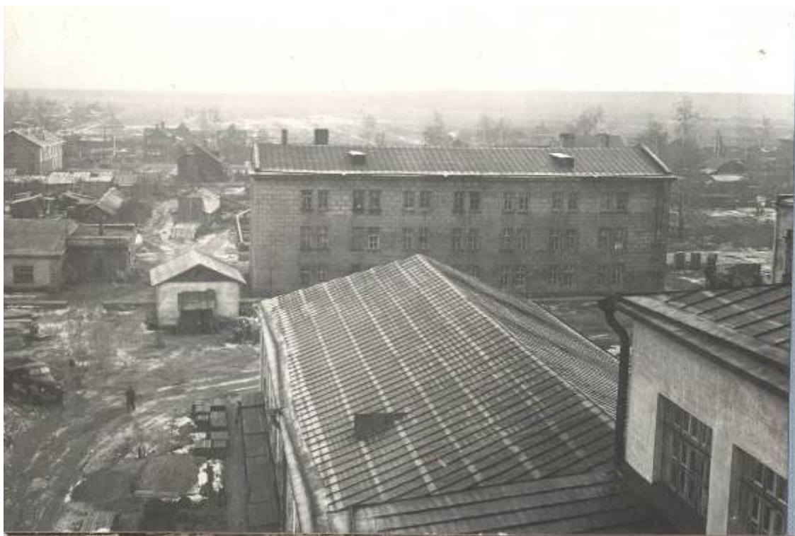
46. Вид лабораторного корпуса. Фото 1957 г. По материалам музея ОАО ВНИИГ им. Б.Е. Веденеева.
