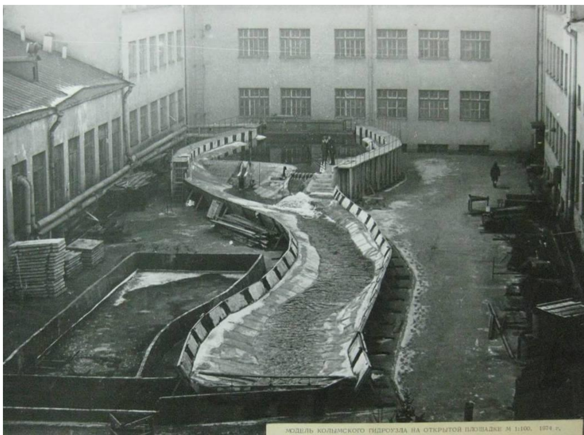
57. Модель Колымского гидроузла на открытой площадке. М 1:100. 1974 г. По материалам музея ОАО ВНИИГ им. Б.Е. Веденеева.
