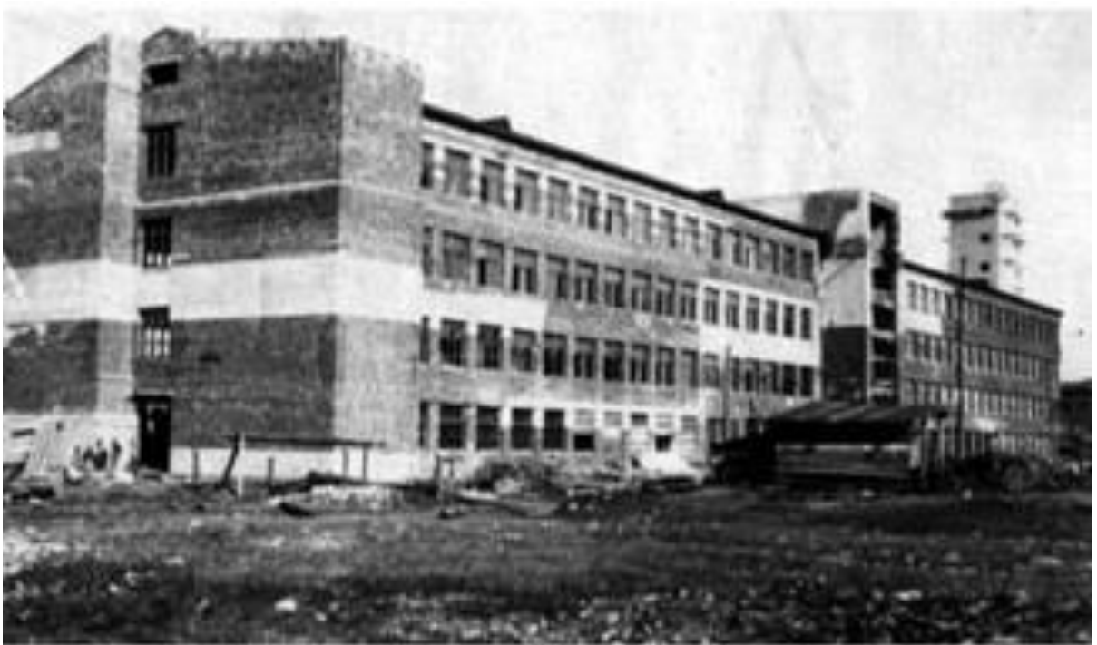
66. Учебный корпус в процессе строительства. 1934 г. По материалам музея ОАО ВНИИГ им. Б.Е. Веденеева.
