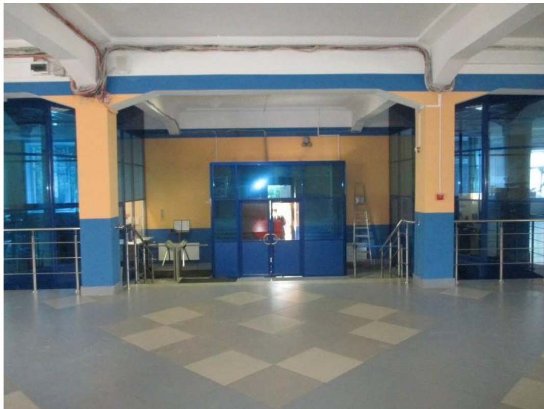
5. Гидротехнический институт им. Б.Е.Веденеева (лицевой корпус с примыкающими дворовыми флигелями). Общий вид на входную группу первого этажа. Штиглиц М.С. 10.02.2021 г.
