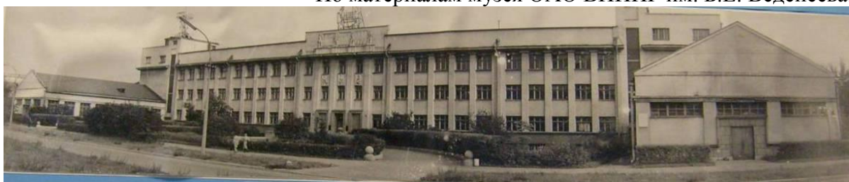
34. ВНИИГ им. Веденева. Лицевой корпус. Фото 1971 г. По материалам музея ОАО ВНИИГ им. Б.Е. Веденева.
