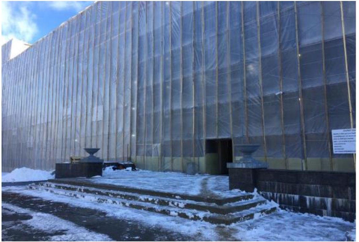
1. Гидротехнический институт им. Б.Е.Веденева (лицевой корпус с примыкающими дворовыми флигелями). Главный фасад в процессе реставрации. Штиглиц М.С. 10.02.2021 г.
