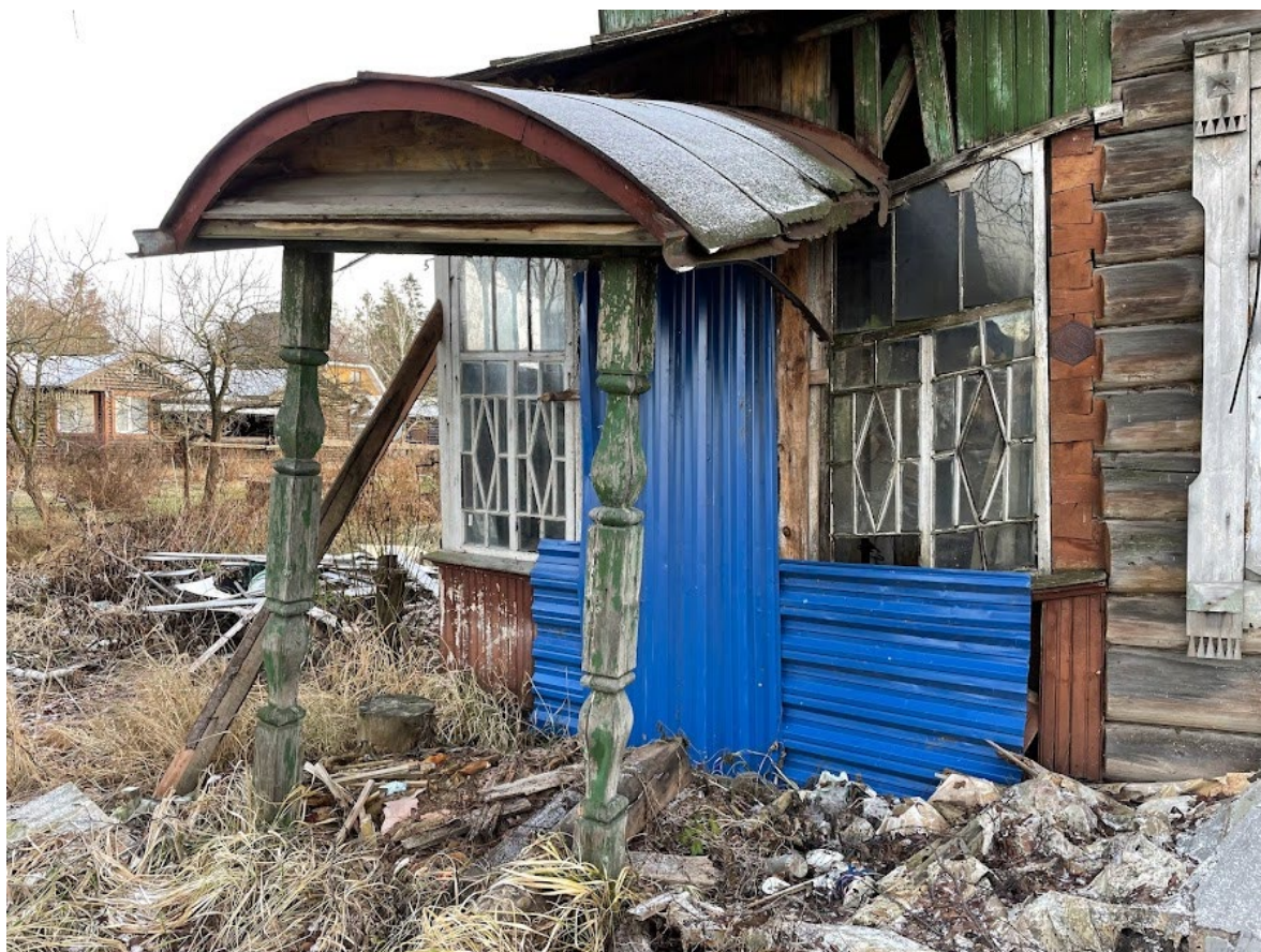
7. Навес над входом на веранду на лицевом фасаде
