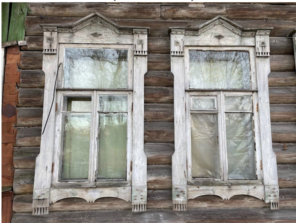
6. Оформление оконных проемов на лицевом фасаде
