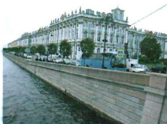
16. Вид стенки набережной с Дворцового моста
