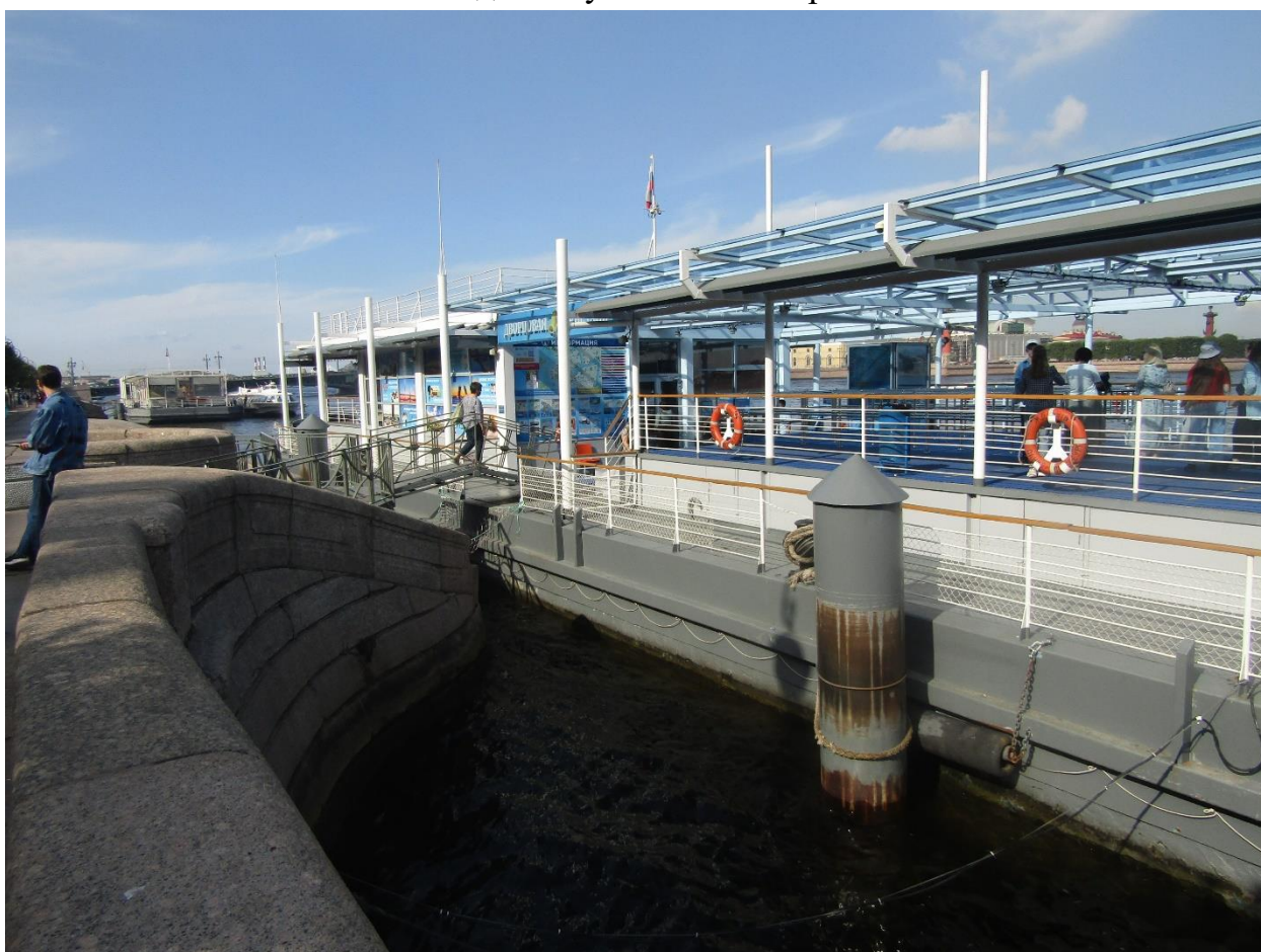
Фото 15. Вид на северо-восточный швартовно-отбойный бал.
