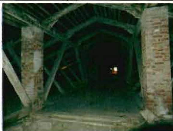
Фото 12. Конструкции крыши. Общий вид. 29.12.2015.
