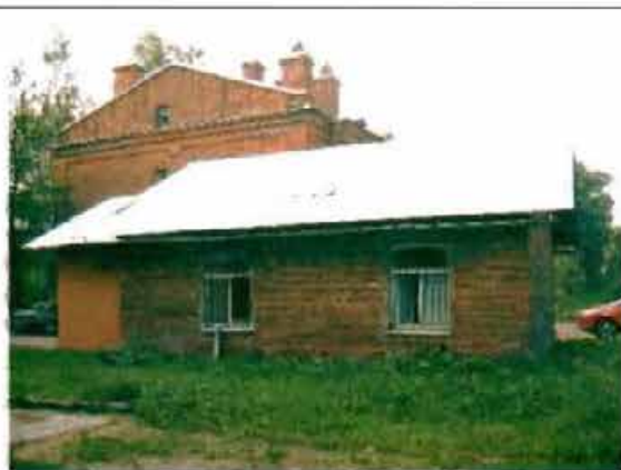
Фото 156. Западный фасад. Общий вид.
