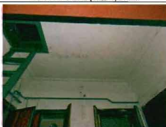
Фото 102. Отделка потолка тамбура. Общий вид.
