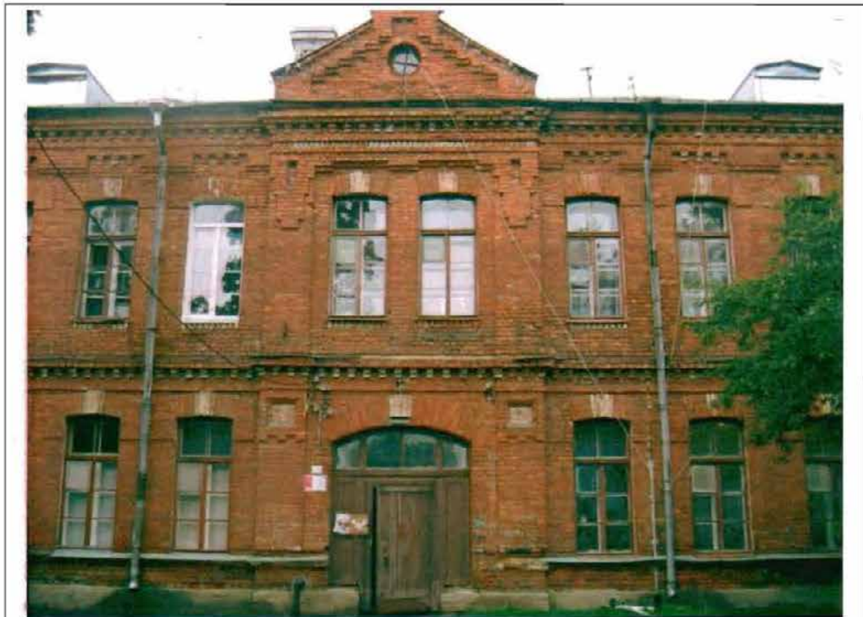
Фото 104. Восточный фасад. Центральная часть. Общий вид.
