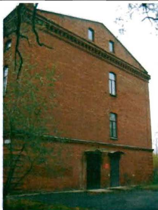
Фото 16. Южный фасад. Общий вид.
