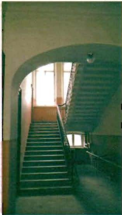
Фото 174. Парадная лестница в центральной части здания. Общий вид.
