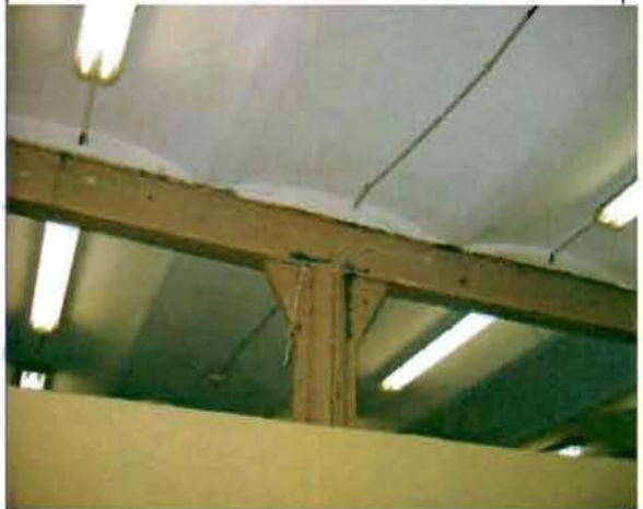
Фото 23. Интерьер. Металлические клепанные колонны и балки. Фрагмент.
