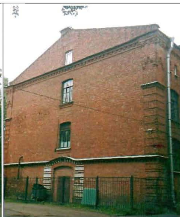
Фото 50. Южный фасад. Общий вид.
