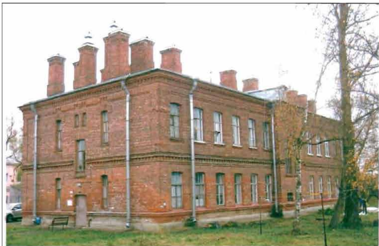
Фото 129. Западный, северный фасады. Общий вид.
