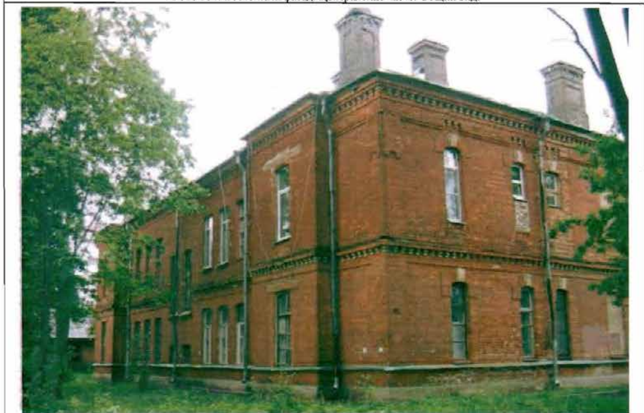
Фото 105. Западный, южный фасады. Общий вид.
