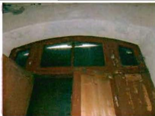
Фото 126. Дверное заполнение центральной части лестницы. Фрагмент.
