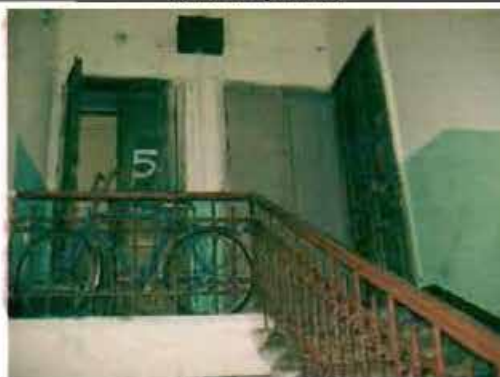
Фото 183. Парадная лестница в центральной части здания. Фрагмент.
