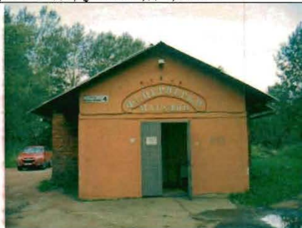
Фото 153. Восточный фасад. Общий вид.
