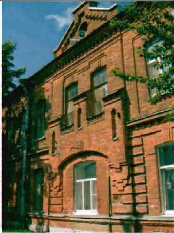
Фото 137. Восточный фасад. Фрагмент.
