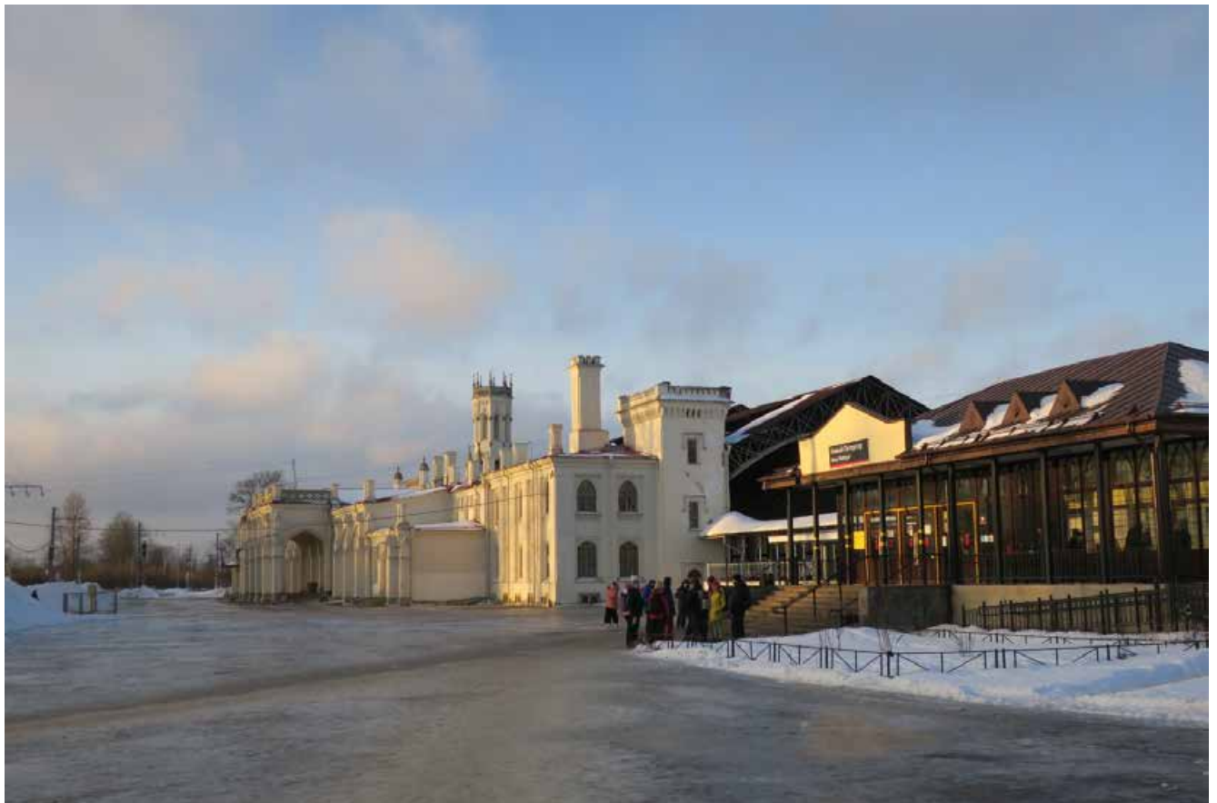
10. Вид от зоны производства работ в сторону объекта культурного наследия федерального значения «Вокзал железнодорожной станции "Новый Петергоф"», расположенного по адресу: Санкт-Петербург, г. Петергоф, Привокзальная площадь, дом 7, литера А, Б.
