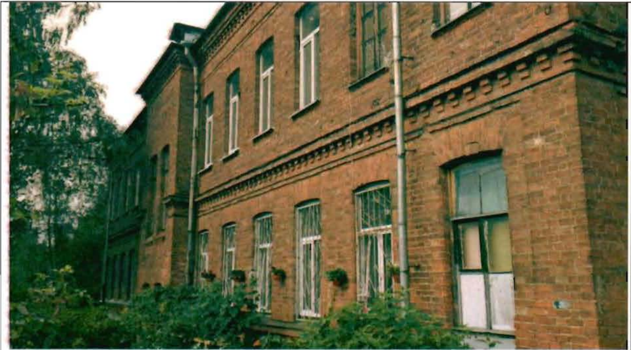
Фото 171. Восточный фасад. Общий вид.
