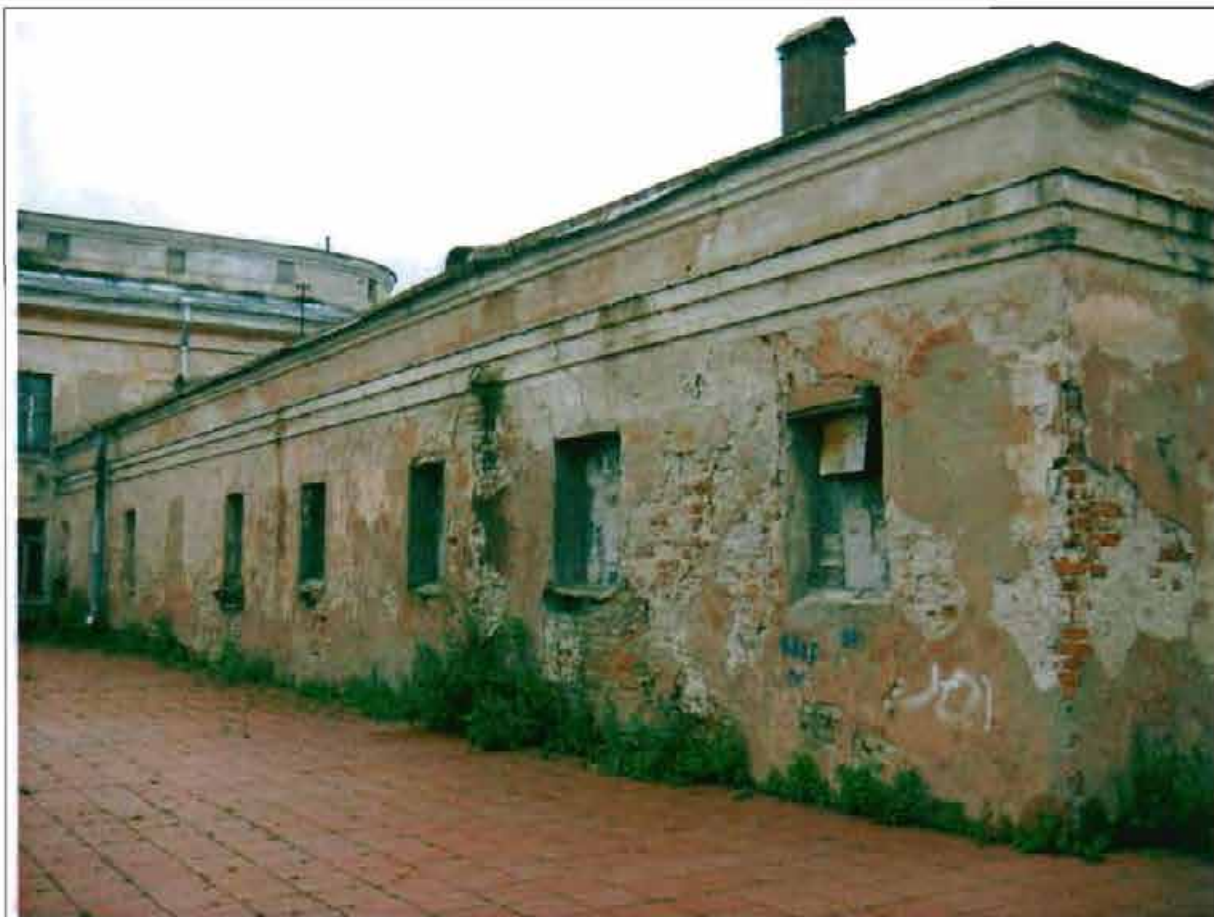
Фото 25. Восточный фасад. Общий вид.
