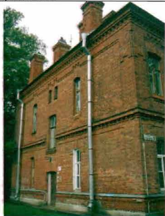
Фото 148. Северный фасад. Общий вид.
