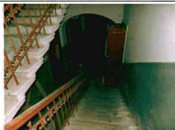
Фото 123. Парадная лестница в центральной части здания. Фрагмент.
