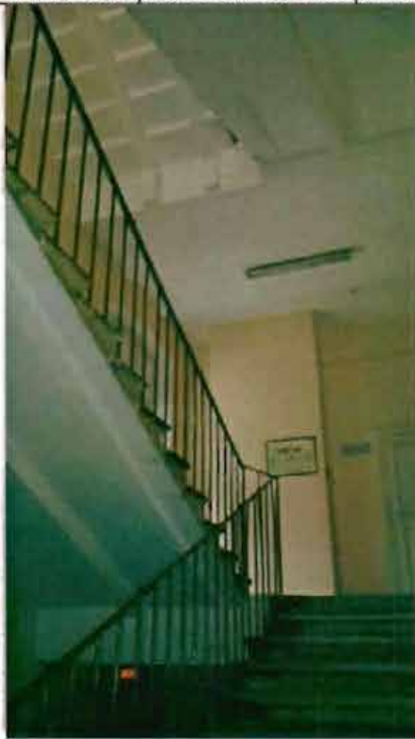
Фото 60. Интерьер. Лестница в южной части здания. Фрагмент.
