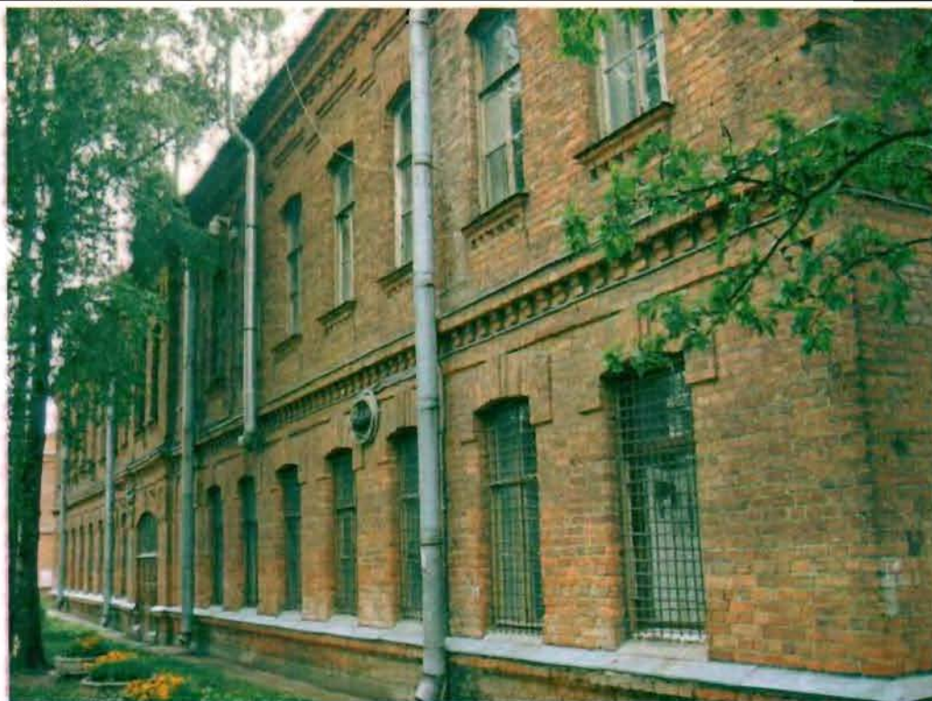
Фото 163. Восточный фасад. Общий вид.
