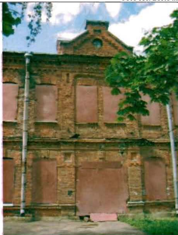
Фото 117. Восточный фасад. Фрагмент центральной части фасада.
