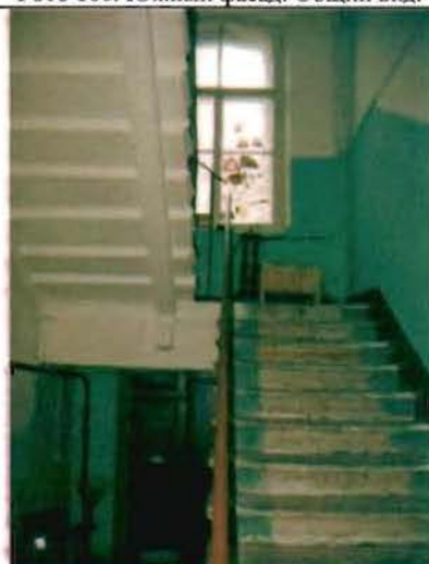
Фото 168. Лестница в южной части здания. Общий вид.
