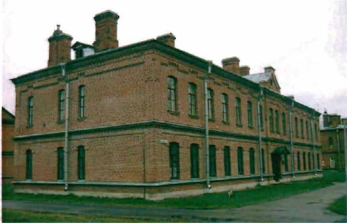
Фото 132. Западный, северный фасады. Общий вид.
