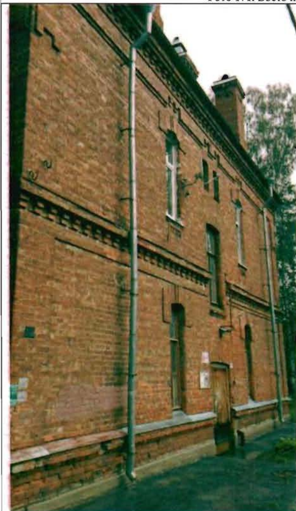
Фото 172. Южный фасад. Общий вид.
