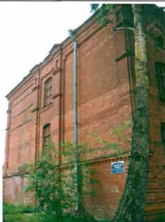
Фото 6. Северный фасад. Общий вид.
