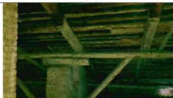
Фото 38. Конструкции крыши. Фрагмент.
