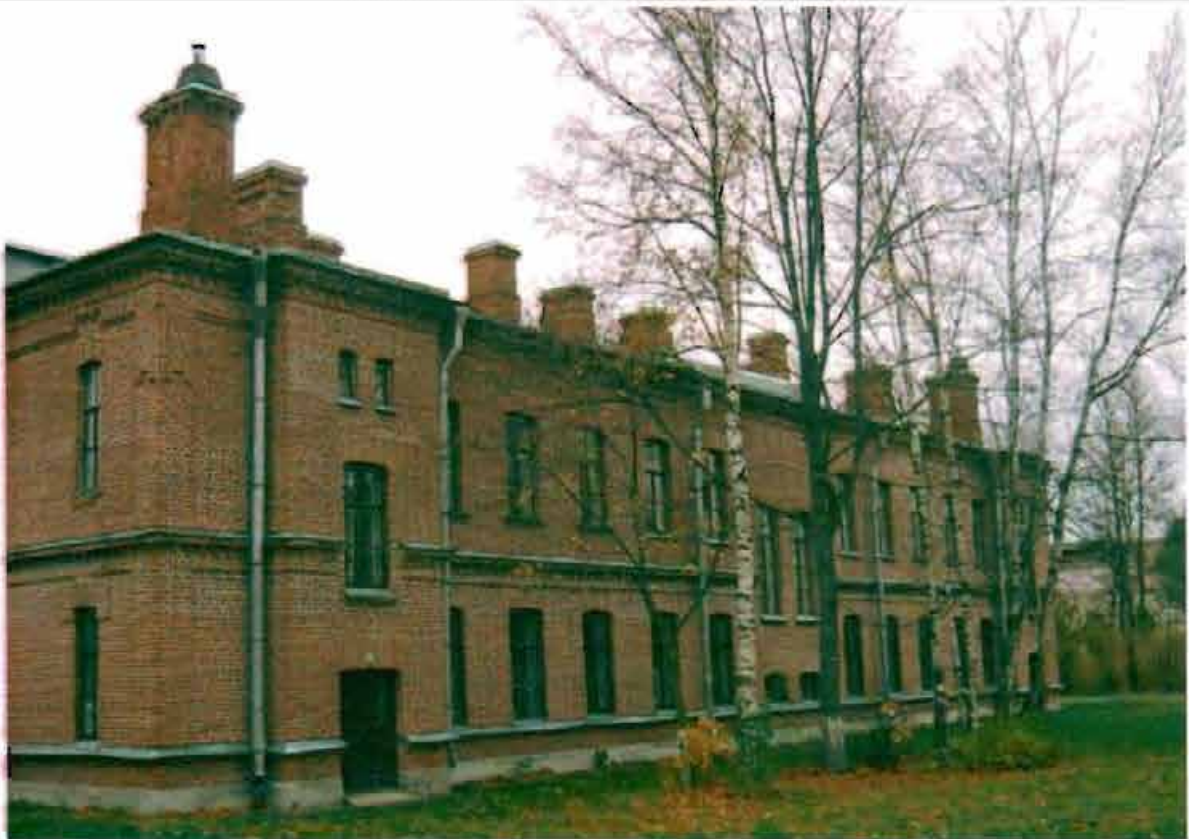
Фото 133. Восточный фасад. Общий вид.
