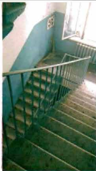
Фото 144. Лестница № 2 в южной части здания. Общий вид.
