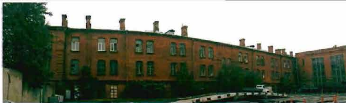
Фото 29. Западный фасад. Общий вид.
