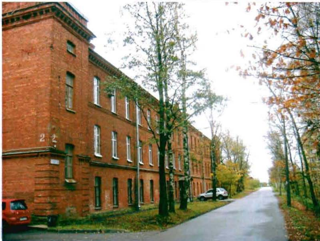
Фото 13. Западный фасад. Общий вид.
