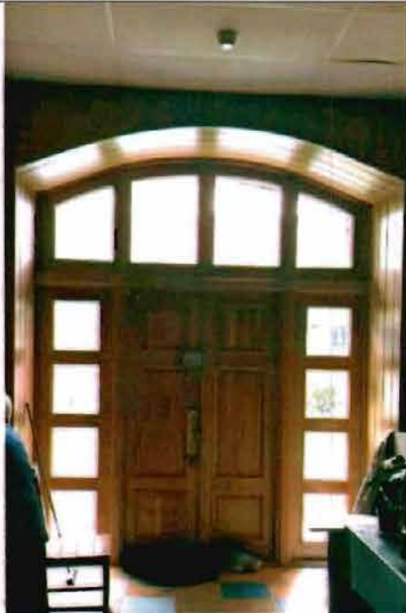
Фото 92. Помещение в уровне 1-го этажа.
