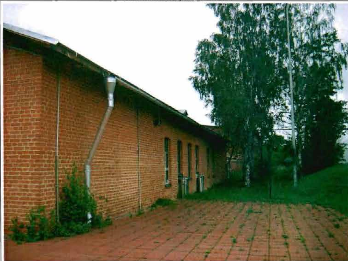
Фото 19. Восточный фасад. Общий вид.
