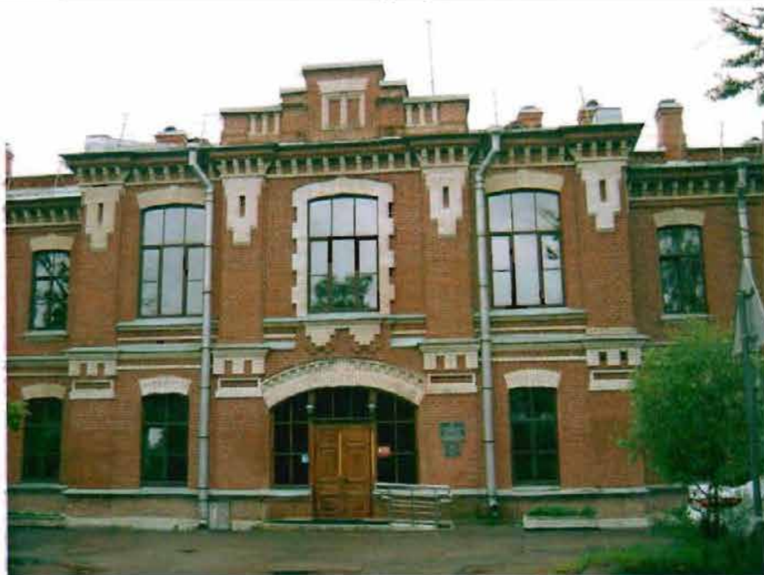
Фото 65. Северный фасад. Фрагмент центральной части фасада.
