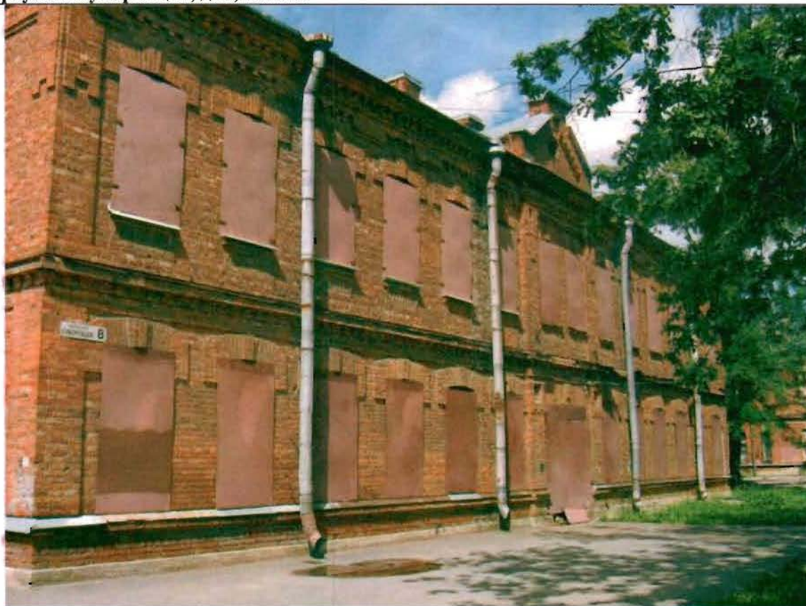
Фото 116. Восточный фасад. Общий вид.
