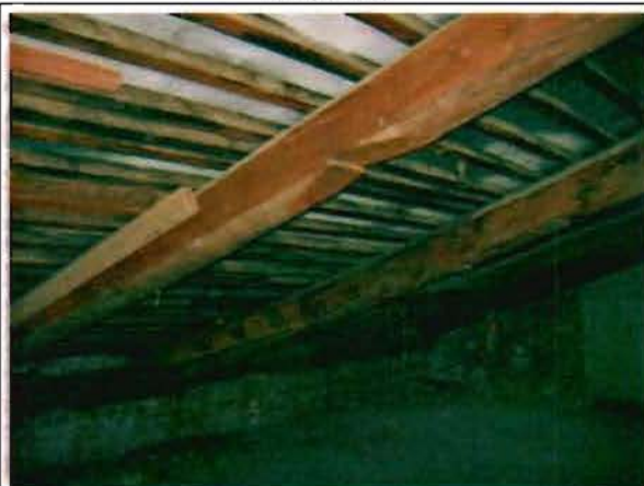
Фото 151. Конструкции крыши. Фрагмент.
