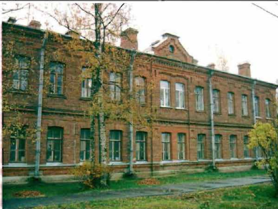
Фото 157. Западный фасад. Общий вид.
