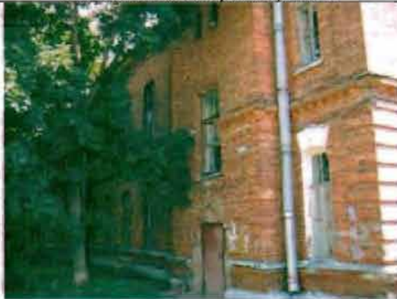
Фото 139. Западный фасад. Фрагмент.
