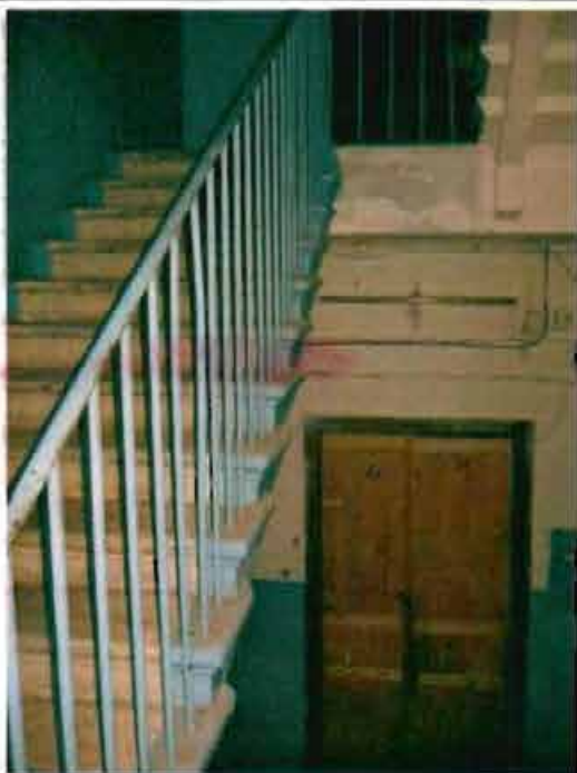
Фото 143. Лестница № 1 в северной части здания. Общий вид.
