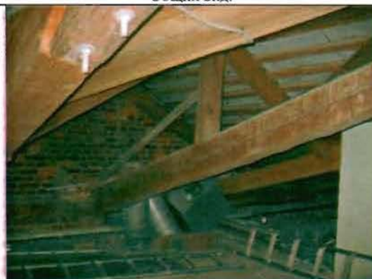
Фото 77. Конструкции крыши. Общий вид.
