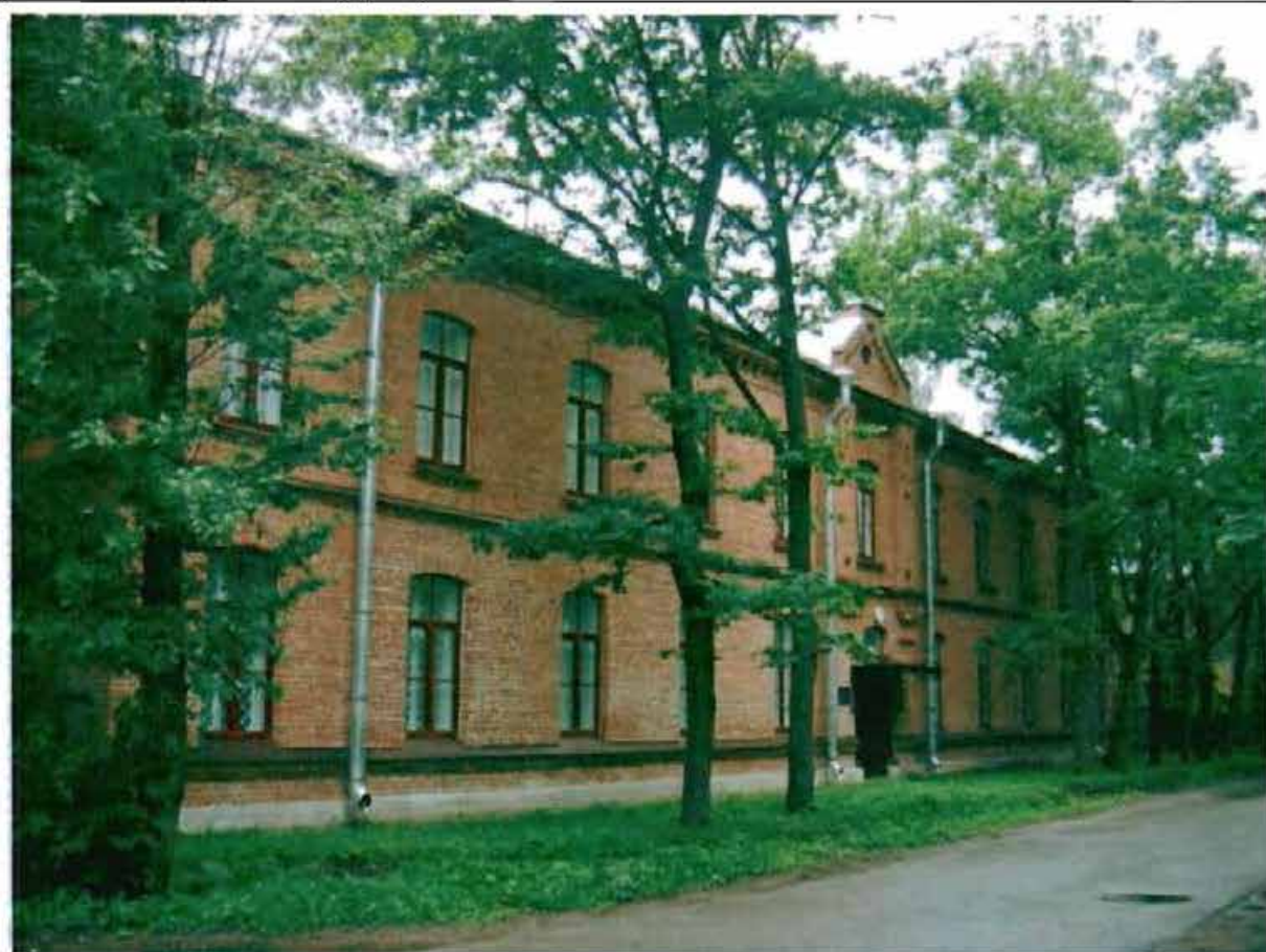
Фото 39. Восточный фасад. Общий вид.
