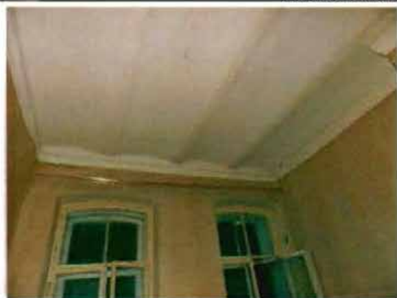
Фото 120. Помещение 1-го этажа. Общий вид.
