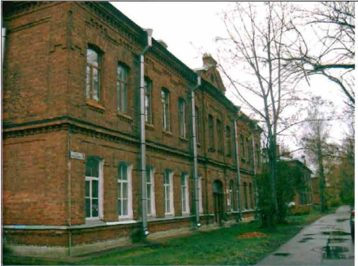
Фото 146. Западный фасад. Общий вид.
