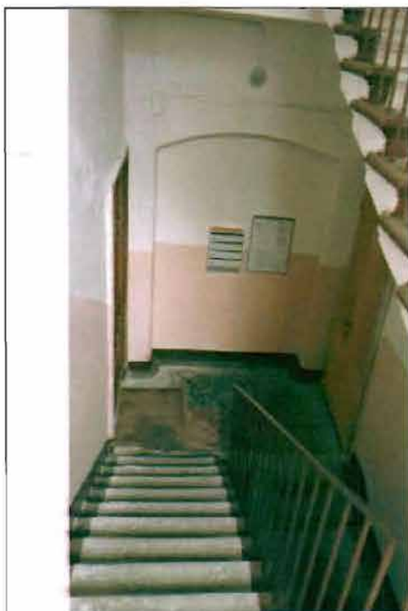
Фото 130. Лестница № 1 в южной части здания. Общий вид.
