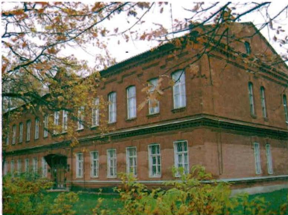
Фото 89. Западный, южный фасады. Общий вид.
