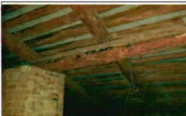
Фото 62. Конструкции крыши. Общий вид.
