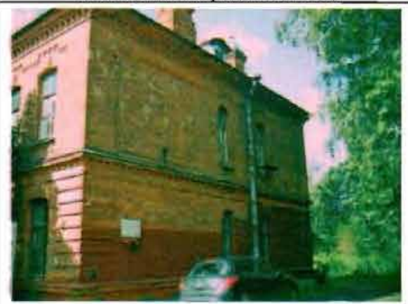
Фото 140. Северный фасад. Общий вид.
