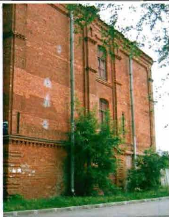
Фото 5. Южный фасад. Общий вид.
