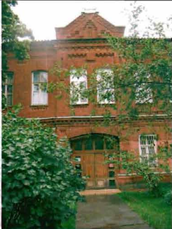
Фото 90. Восточный фасад. Центральная часть. Общий вид.
