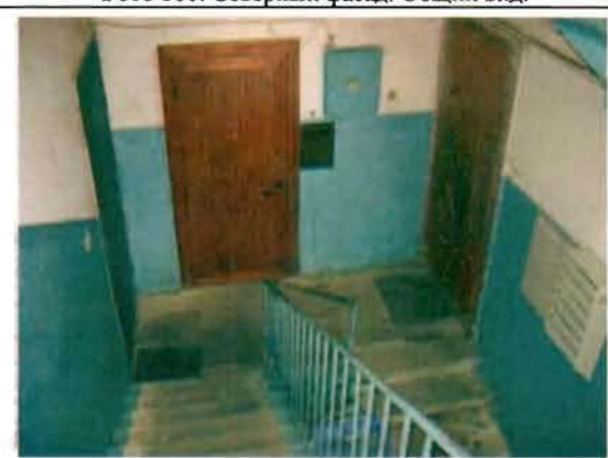
Фото 162. Лестница № 2 в северной части здания. Фрагмент.
