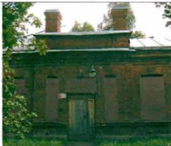
Фото 99. Западный фасад. Центральный часть. Общий вид.
