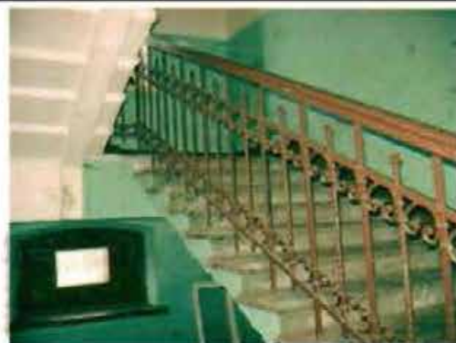
Фото 182. Парадная лестница в центральной части здания. Фрагмент.
