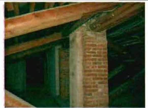
Фото 142. Конструкции крыши. Фрагмент.
