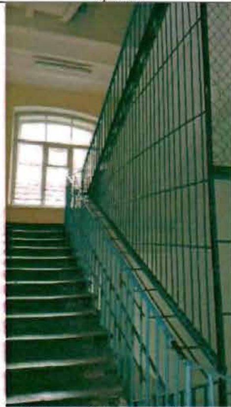
Фото 61. Интерьер. Лестница в южной части здания. Фрагмент.
