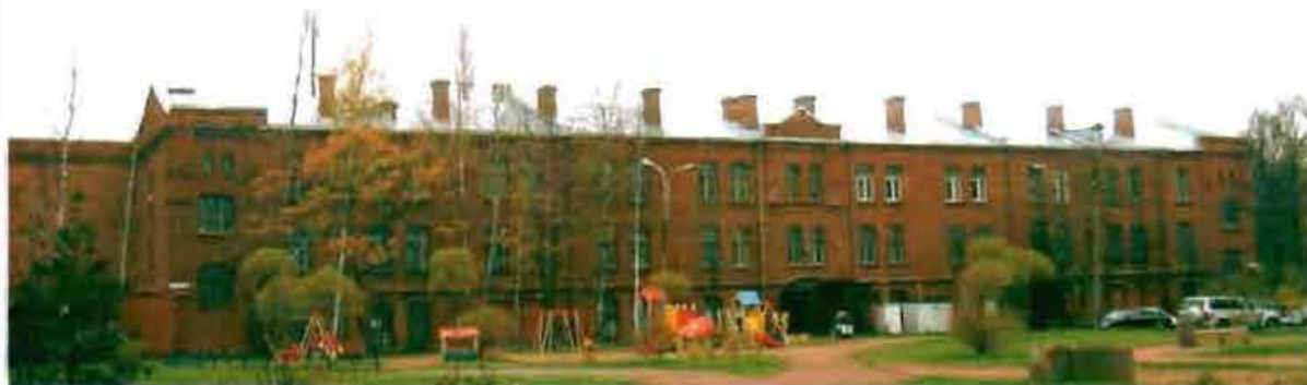
Фото 28. Восточный фасад. Общий вид.
