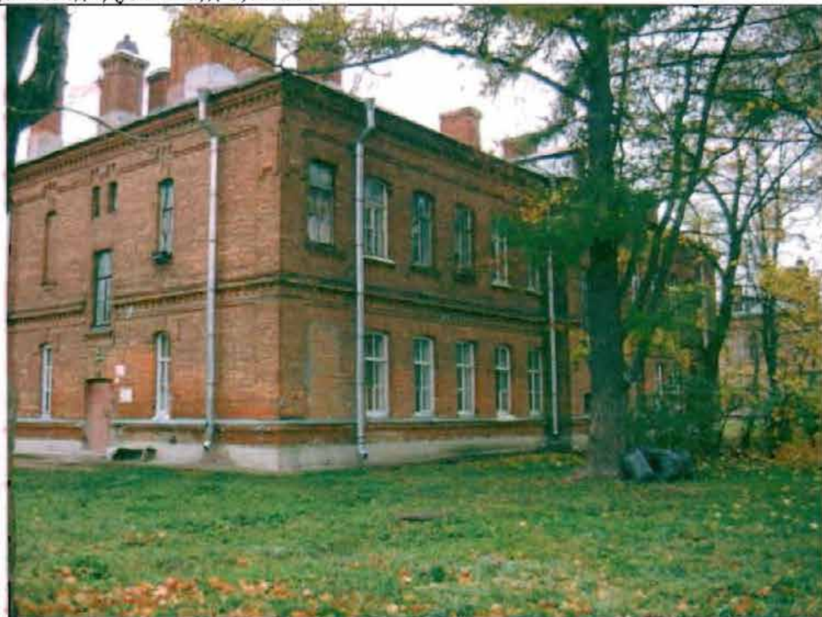
Фото 145. Восточный фасад. Общий вид.
