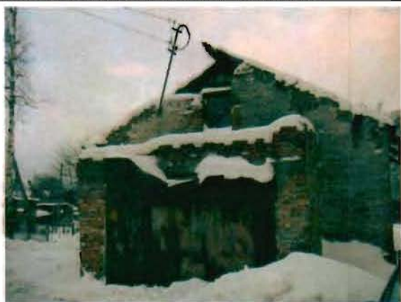
Фото 184. Восточный фасад. Общий вид. 14.01.2015.
