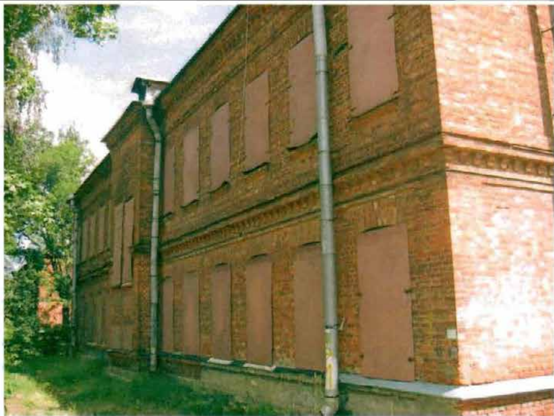
Фото 119. Западный фасад. Общий вид.
