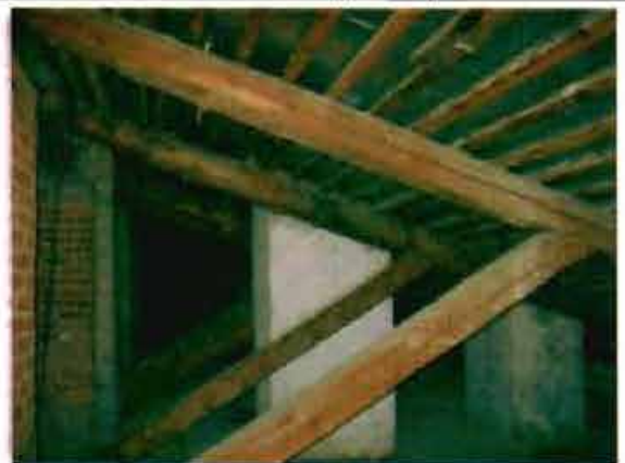
Фото 141. Конструкции крыши. Фрагмент.
