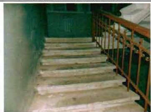
Фото 122. Парадная лестница в центральной части здания. Фрагмент.
