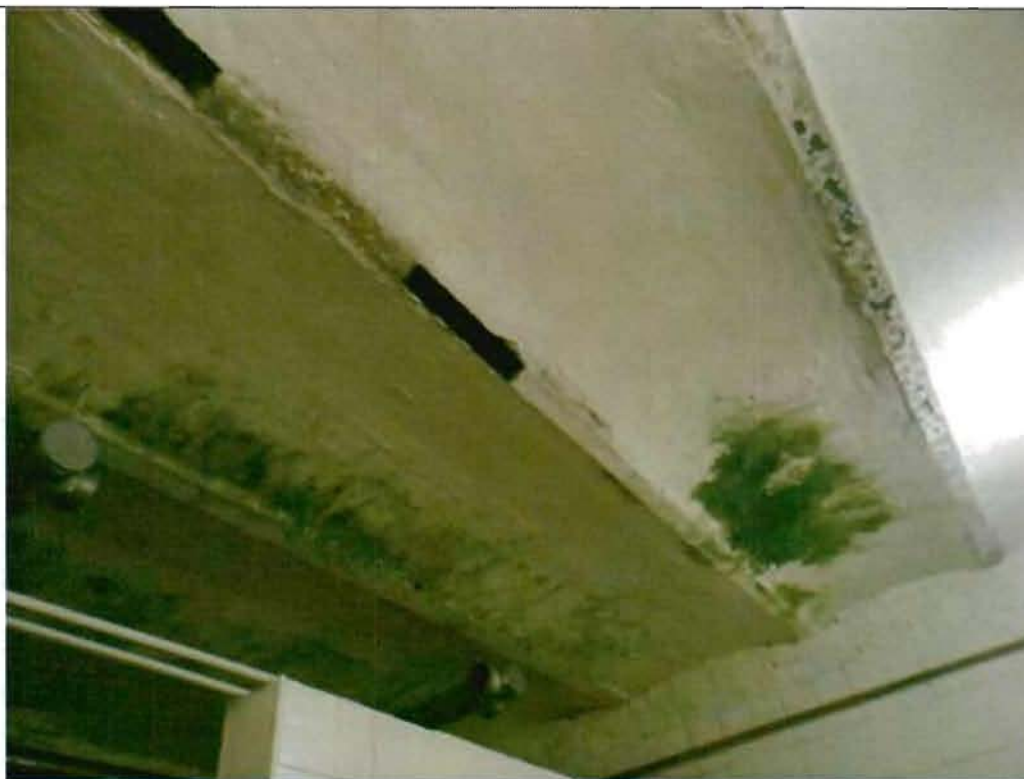
Своды по металлическим балкам. Съёмка 27.11.2012, Воронина Н.В.
