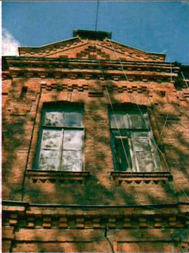
Фото 177. Восточный фасад. Центральная часть. Фрагмент.
