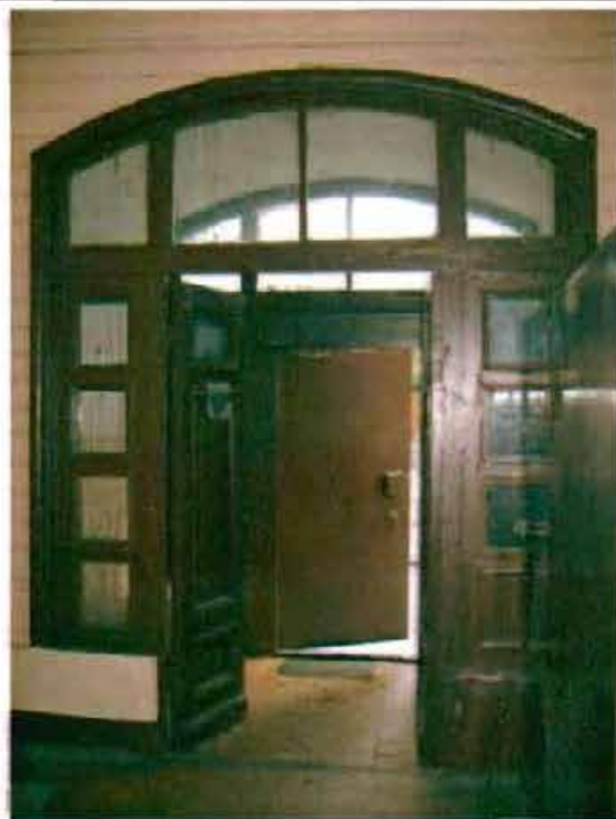
Фото 107. Дверной проем тамбура. Общий вид.
