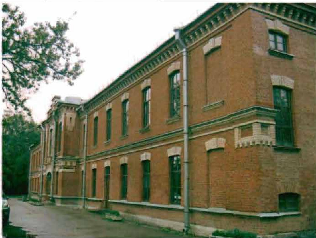
Фото 64. Северный фасад. Общий вид.
