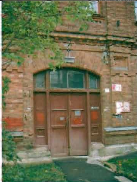
Фото 147. Дверной проем западного фасада. Общий вид.
