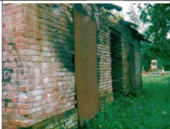
Фото 95. Северный фасад. Общий вид.
