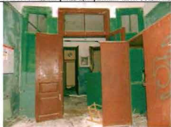
Фото 101. Дверной проем тамбура. Общий вид.
