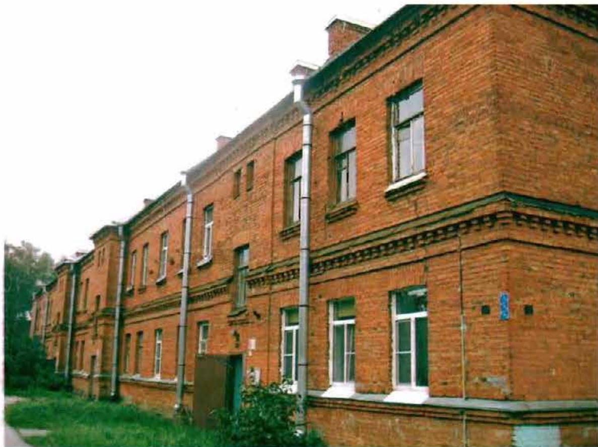
Фото 83. Северный фасад. Общий вид.
