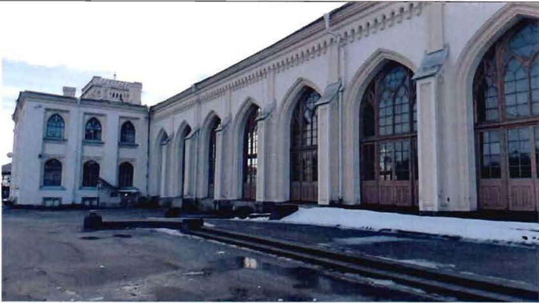
3. Фрагмент северного фасада
