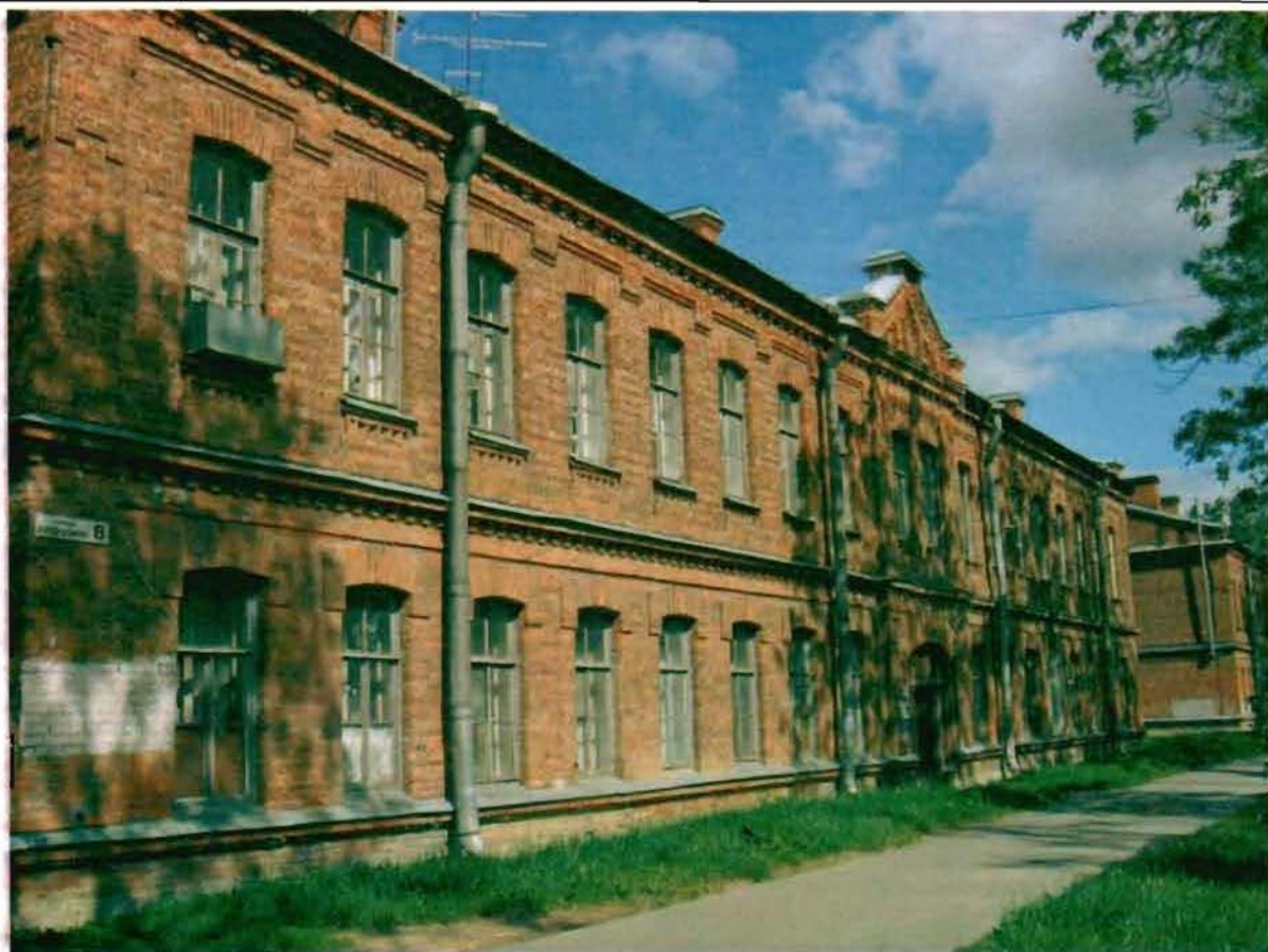
Фото 176. Восточный фасад. Общий вид.
