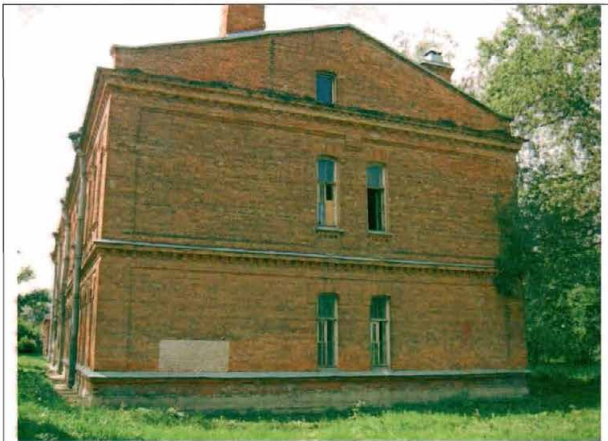
Фото 180. Северный фасад. Общий вид.
