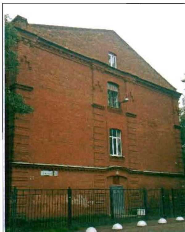
Фото 49. Северный фасад. Общий вид.
