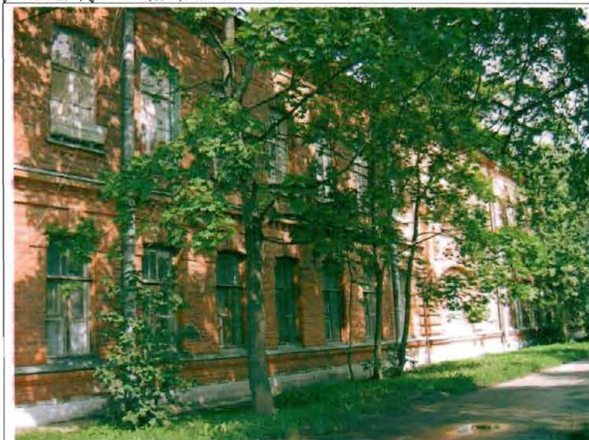
Фото 136. Восточный фасад. Общий вид.
