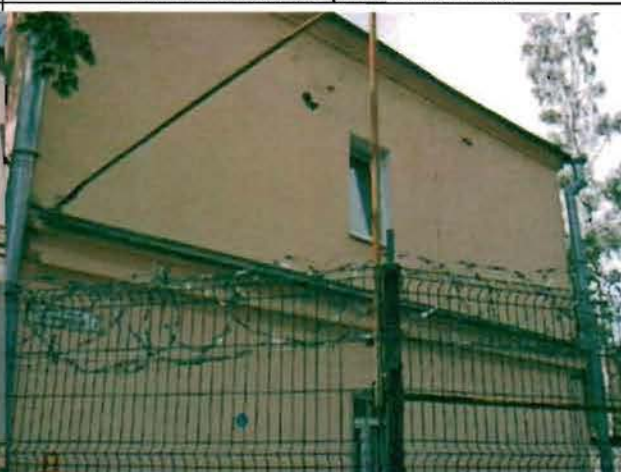
Фото 113. Северный фасад. Общий вид.
