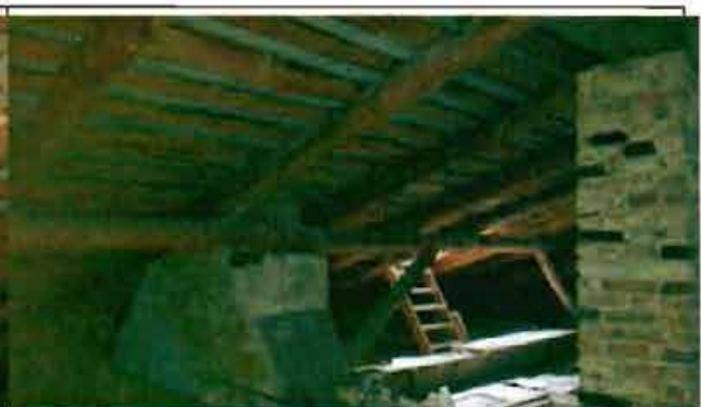
Фото 63. Конструкции крыши. Общий вид.
