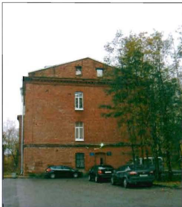
Фото 15. Северный фасад. Общий вид.
