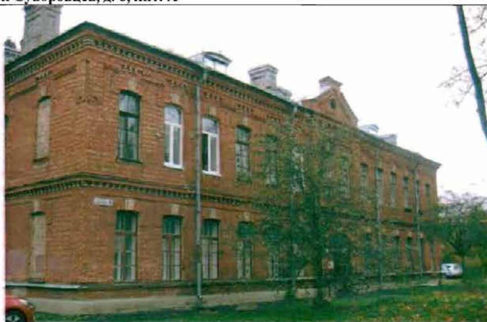
Фото 103. Восточный фасад. Общий вид.
