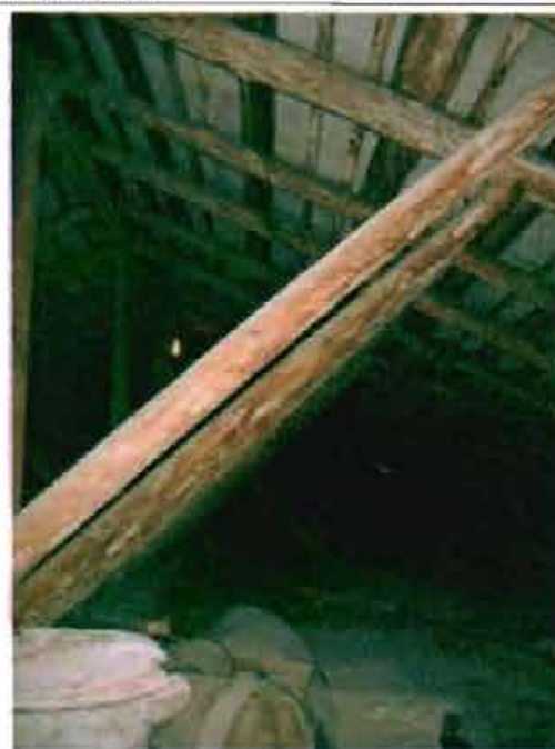
Фото 27. Конструкции крыши. Фрагмент.
