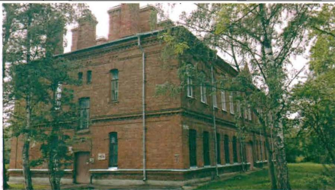
Фото 170. Северный, западный фасады. Общий вид.
