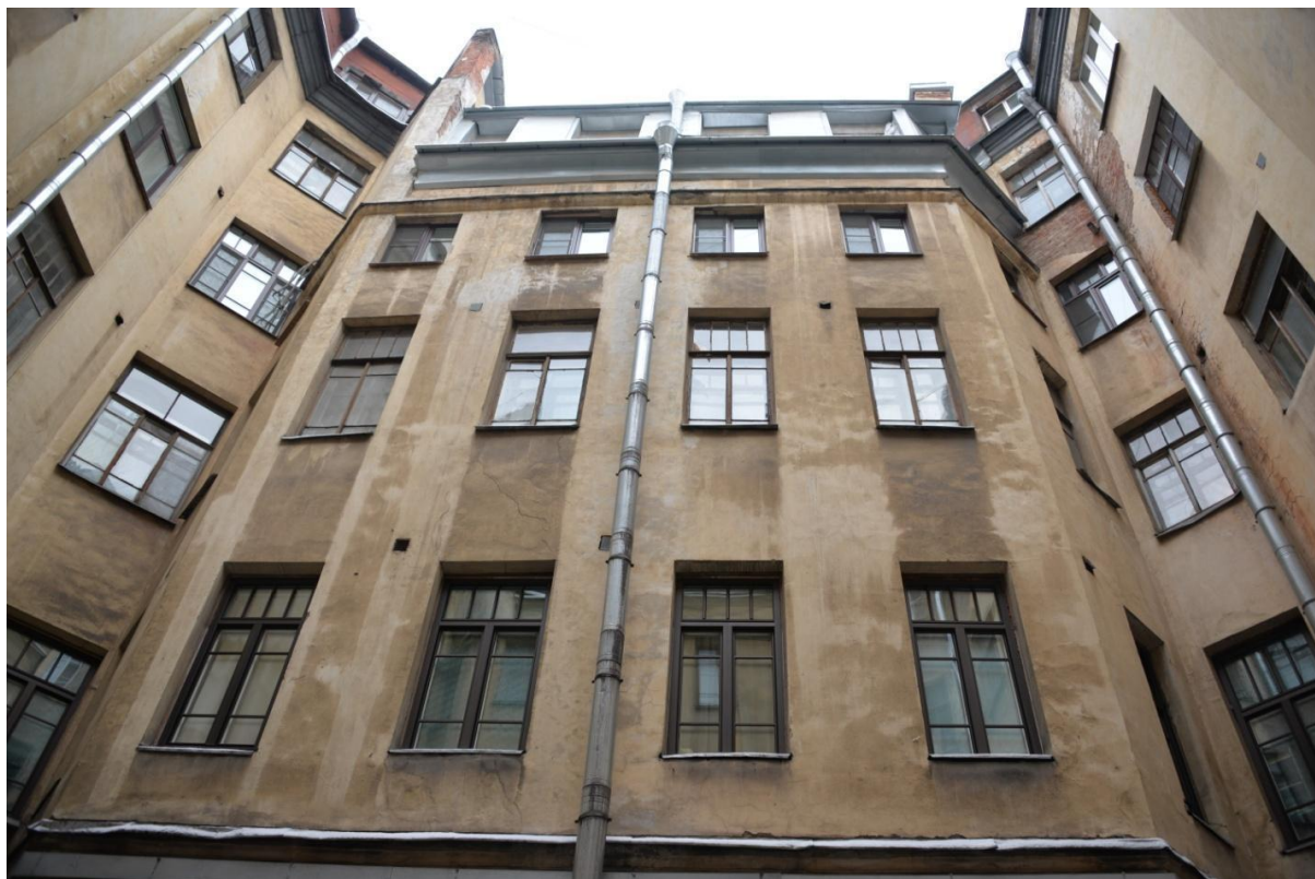
3. Фрагмент дворового фасада
