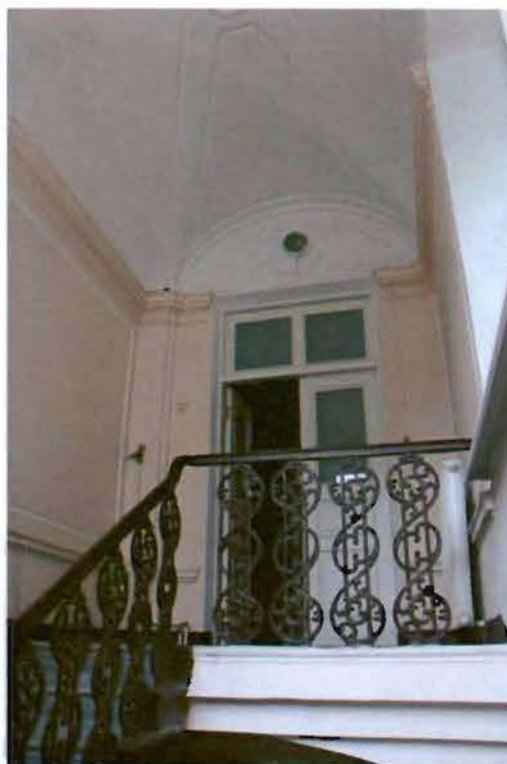
Фото №13. Лестница в цокольный этаж.
