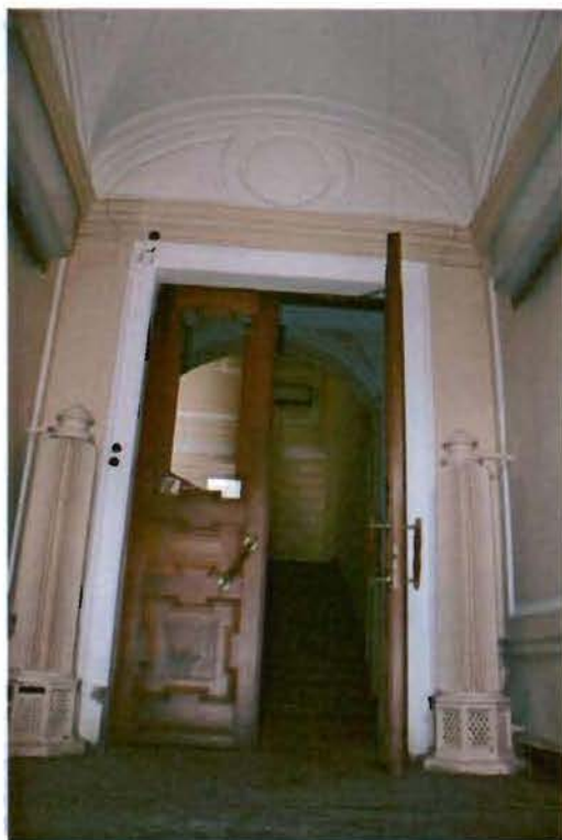
Фото №12. Вестибюль парадного входа.
