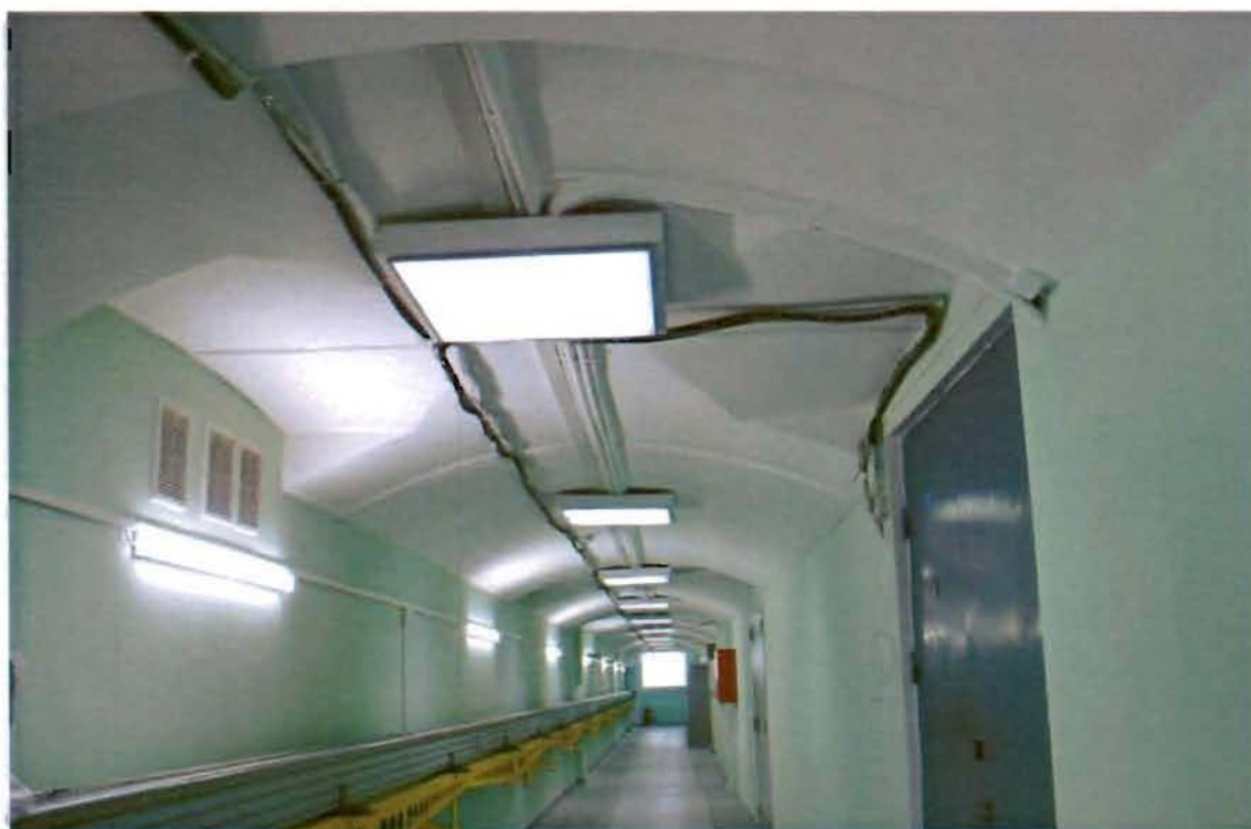
Фото №14. Цокольный этаж.
