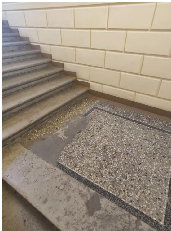
Фото 17. Интерьер объекта культурного наследия федерального значения «Дом, где в 1893-1907 гг. работал химик Менделеев Д.И.», площадка лестничной клетки
