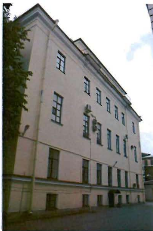
Фото №3. Вид на западный фасад.
