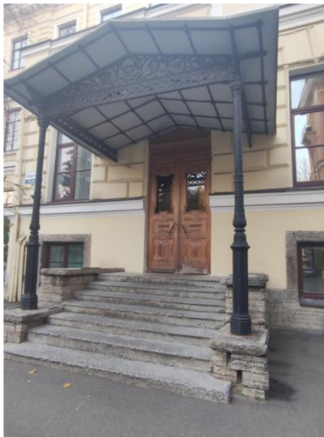
Фото 5. Фрагмент фасада объекта культурного наследия федерального значения «Дом, где в 1893-1907 гг. работал химик Менделеев Д.И.», входное дверное заполнение
