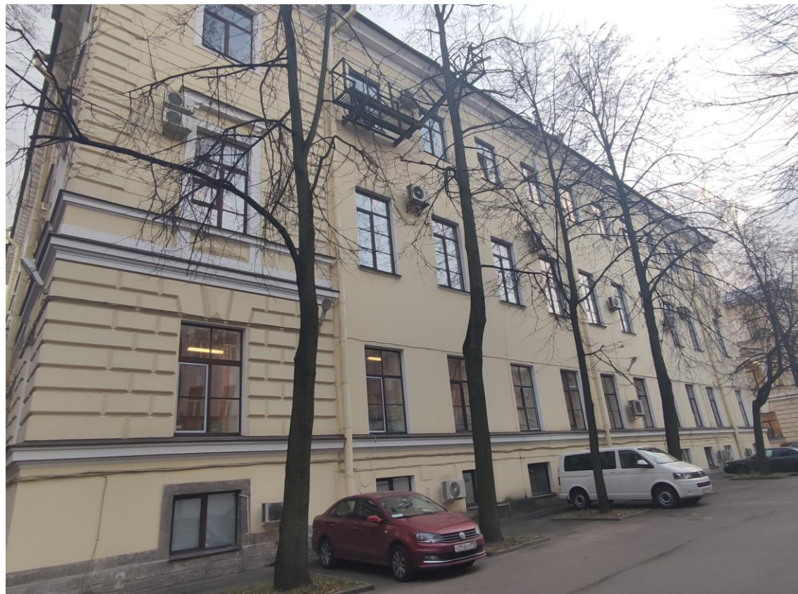
Фото 4. Фрагмент фасада объекта культурного наследия федерального значения «Дом, где в 1893-1907 гг. работал химик Менделеев Д.И.»
