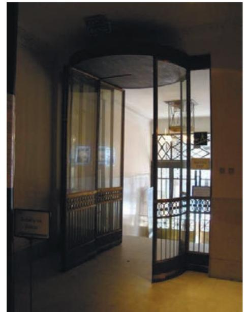
расположенная в верхнем уровне вестибюля дверь - «вертушка» из четырех соединенных крестом остекленных створок со сквозными медными решетками геометрического рисунка в нижней части; стенки конструкции выполнены в виде двух выгнутых створок, соединенных с торцами проема узкими, аналогичными створками; перекрытие конструкции выполнено в виде круглого металлического профилированного барабана с подшипниковым стержнем в центре);
