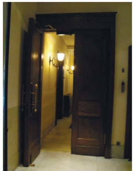
историческое заполнение дверного проема ведущего в помещение ЗН(67): местоположение, тип (двухстворчатая, мелкая расстекловка с переплетом геометрического рисунка с витражным заполнением (фацетированное стекло с узором «мороз», свинцово - паечная протяжка);
