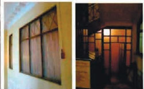
дверь, ведущая в коридор, выходящий во двор - представляет собой часть остекленной перегородки, однопольная с фацетной мелкой расстекловкой геометрического рисунка, в металлической раме:
