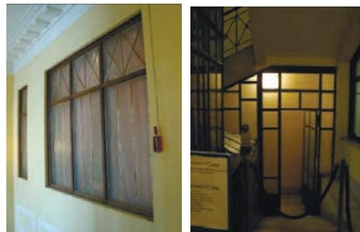
дверь, ведущая в коридор, выходящий во двор - представляет собой часть остекленной перегородки, однопольная с фацетной мелкой расстекловкой геометрического рисунка, в металлической раме;
