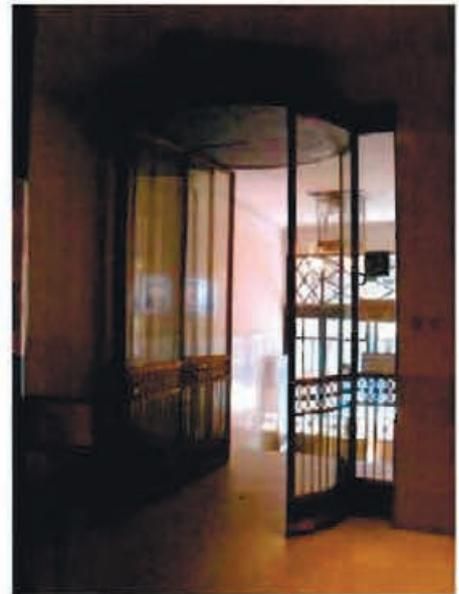
расположенная в верхнем уровне вестибюля дверь - «вертушка» из четырех соединенных крестом остекленных створок со сквозными медными решетками геометрического рисунка в нижней части:
