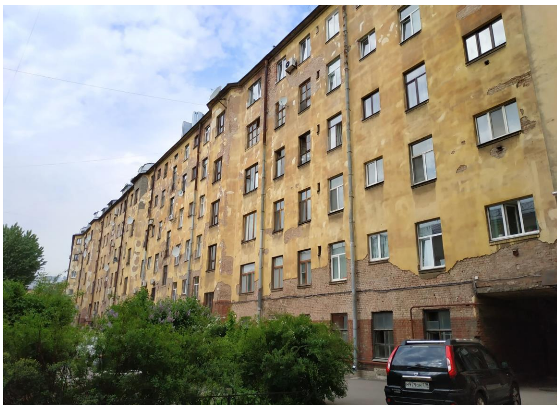
Фото 9. Юго-западный дворовый фасад
