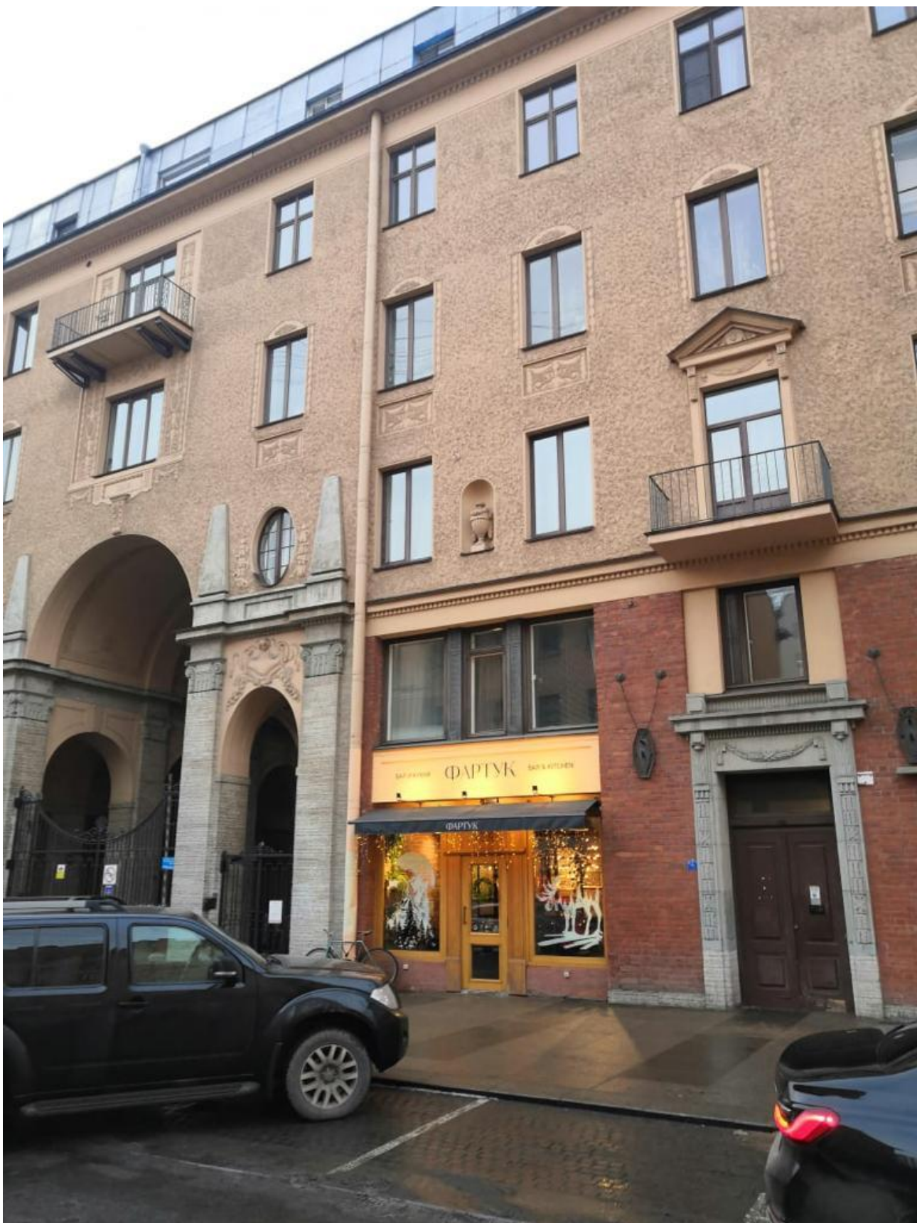
Фото 1. Фрагмент лицевого фасада по ул. Рубинштейна
