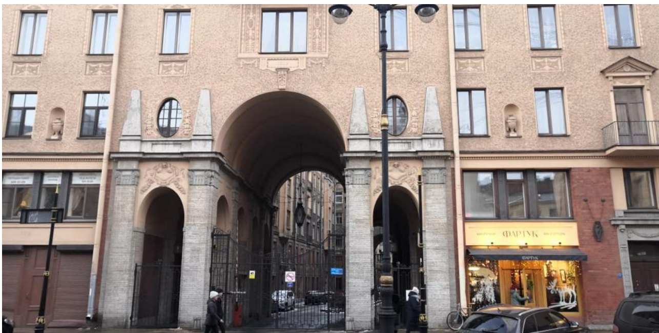
Фото 3. Фрагмент лицевого фасада по ул. Рубинштейна
