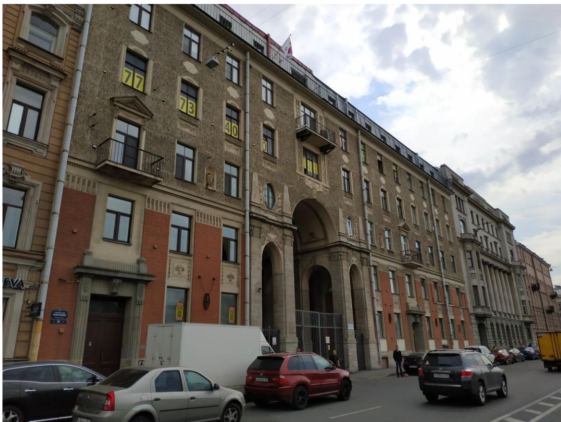
Фото 4. Лицевой фасад по наб. реки Фонтанки
