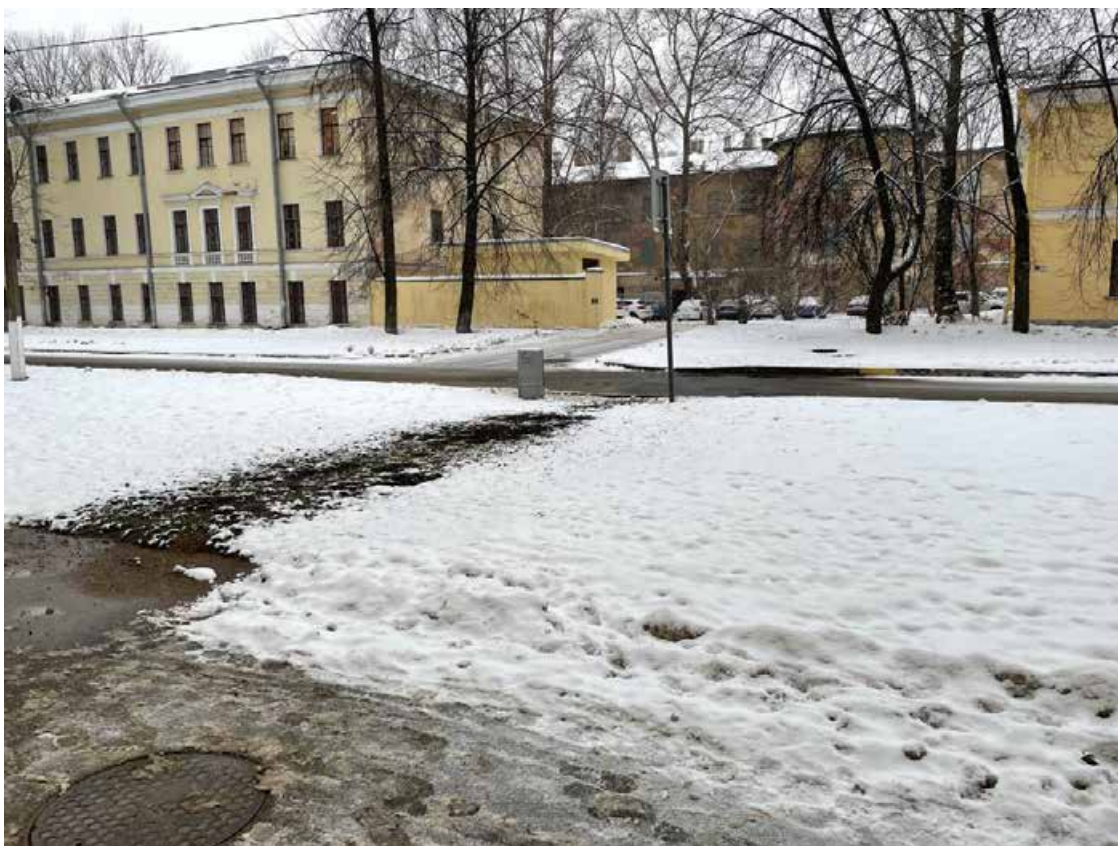
Фото 31. Участок производства работ.
