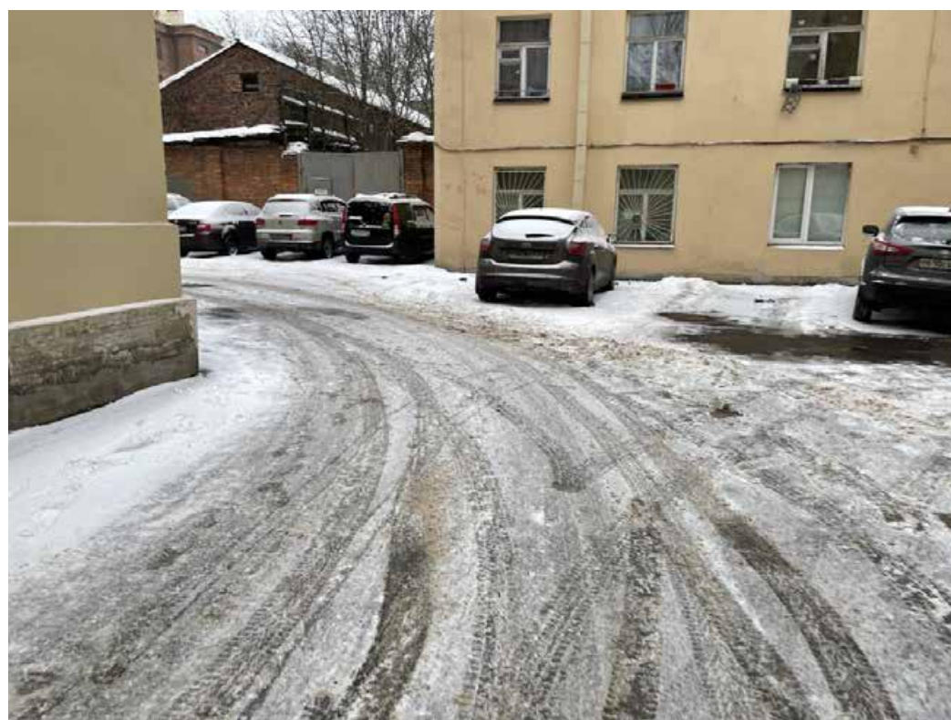
Фото 38. Участок производства работ.
