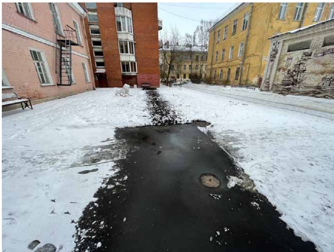
Фото 4. Участок производства работ
