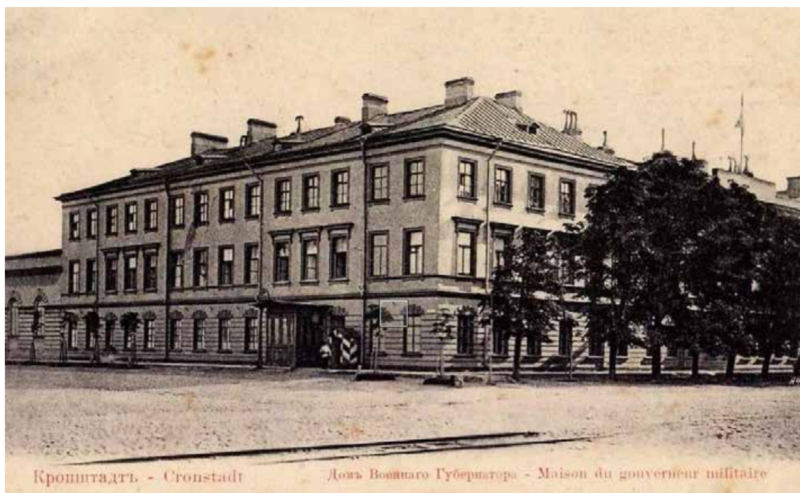
Илл. 18. Дом военного губернатора. Фото 1895-1902 гг. Располагался на месте существующего объекта культурного наследия федерального значения «Дом губернский 9-й», расположенный по адресу: Санкт-Петербург, город Кронштадт, Петровская улица, дом 16/2, литера А. Retro View of Mankind's Habitat [Электронный ресурс]. Режим доступа: https://pastvu.com/ .
