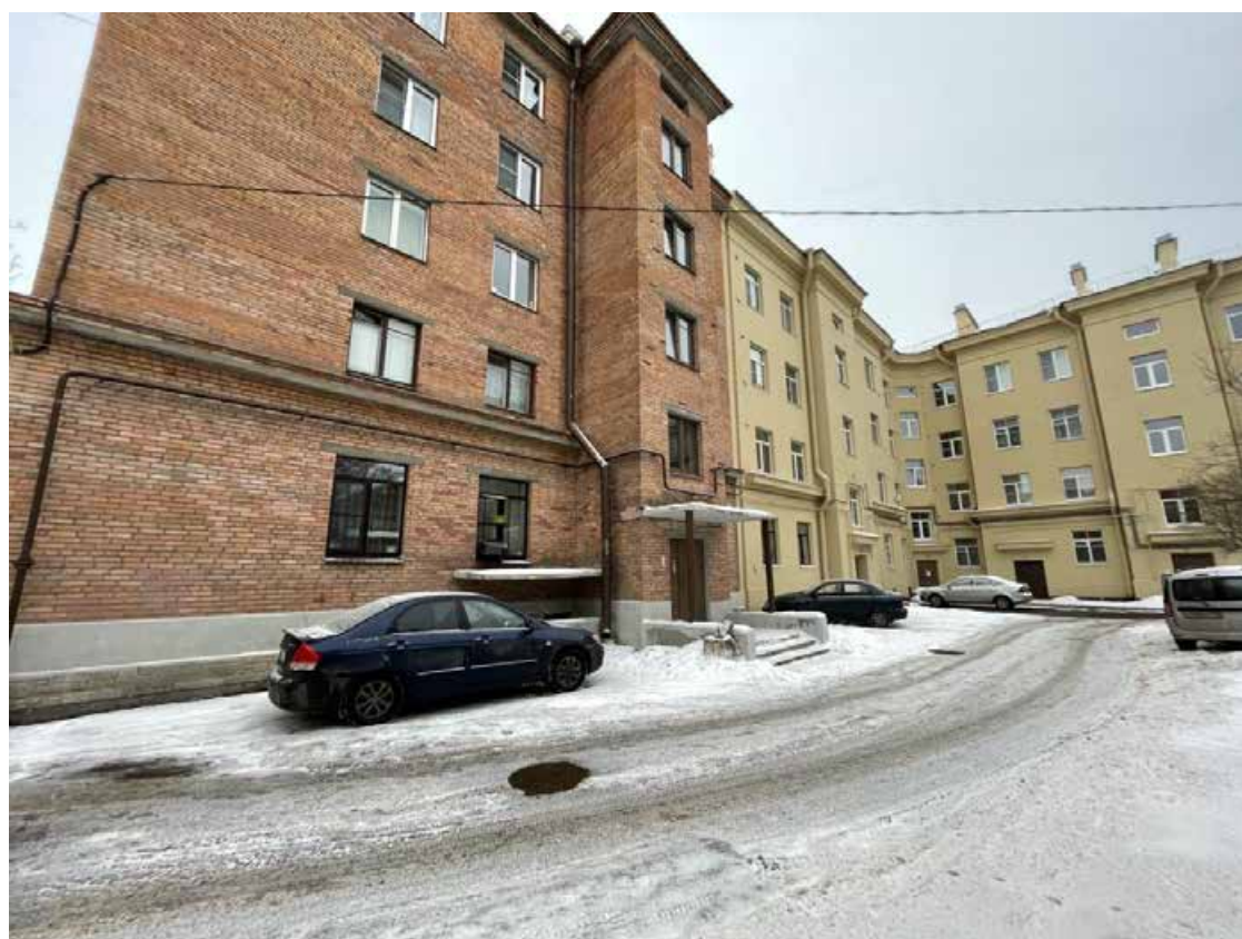
Фото 30. Участок производства работ.
