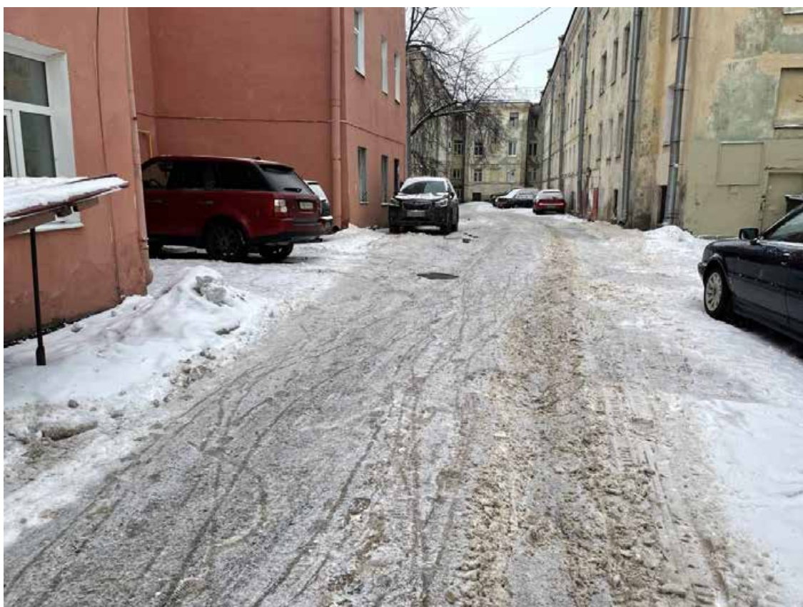
Фото 27. Участок производства работ.
