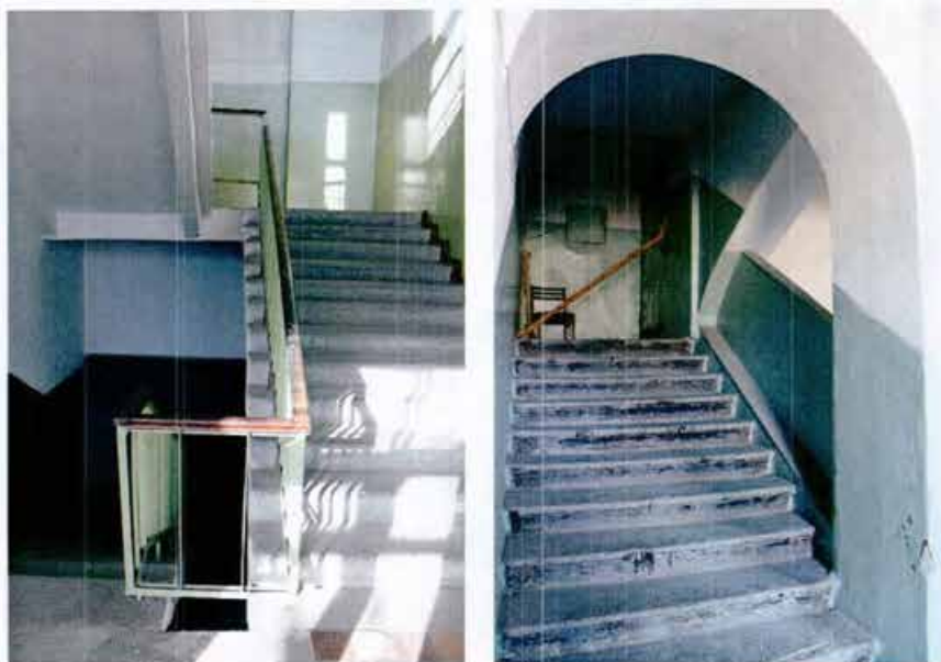
Фото №8, 9. Лестничные марши.
