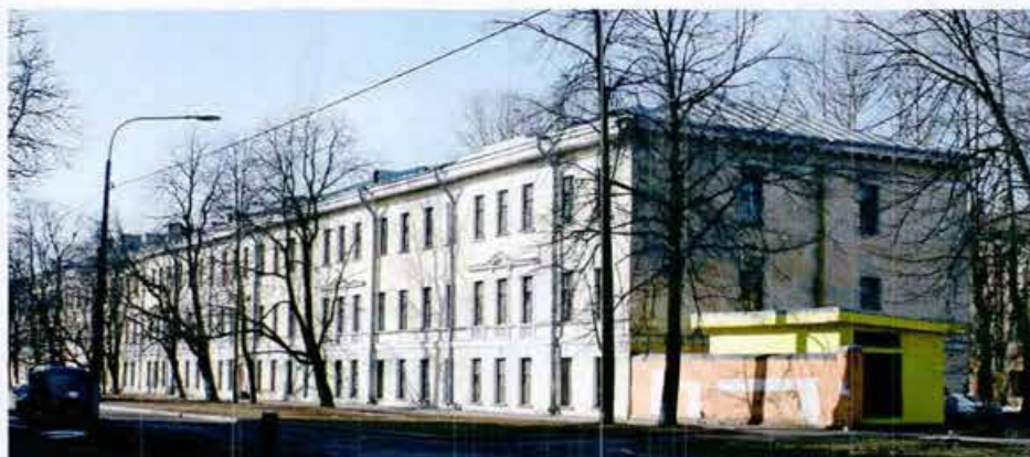
Фото №1. Вид на лицевой и торцевой фасады со стороны Коммунистической ул.
