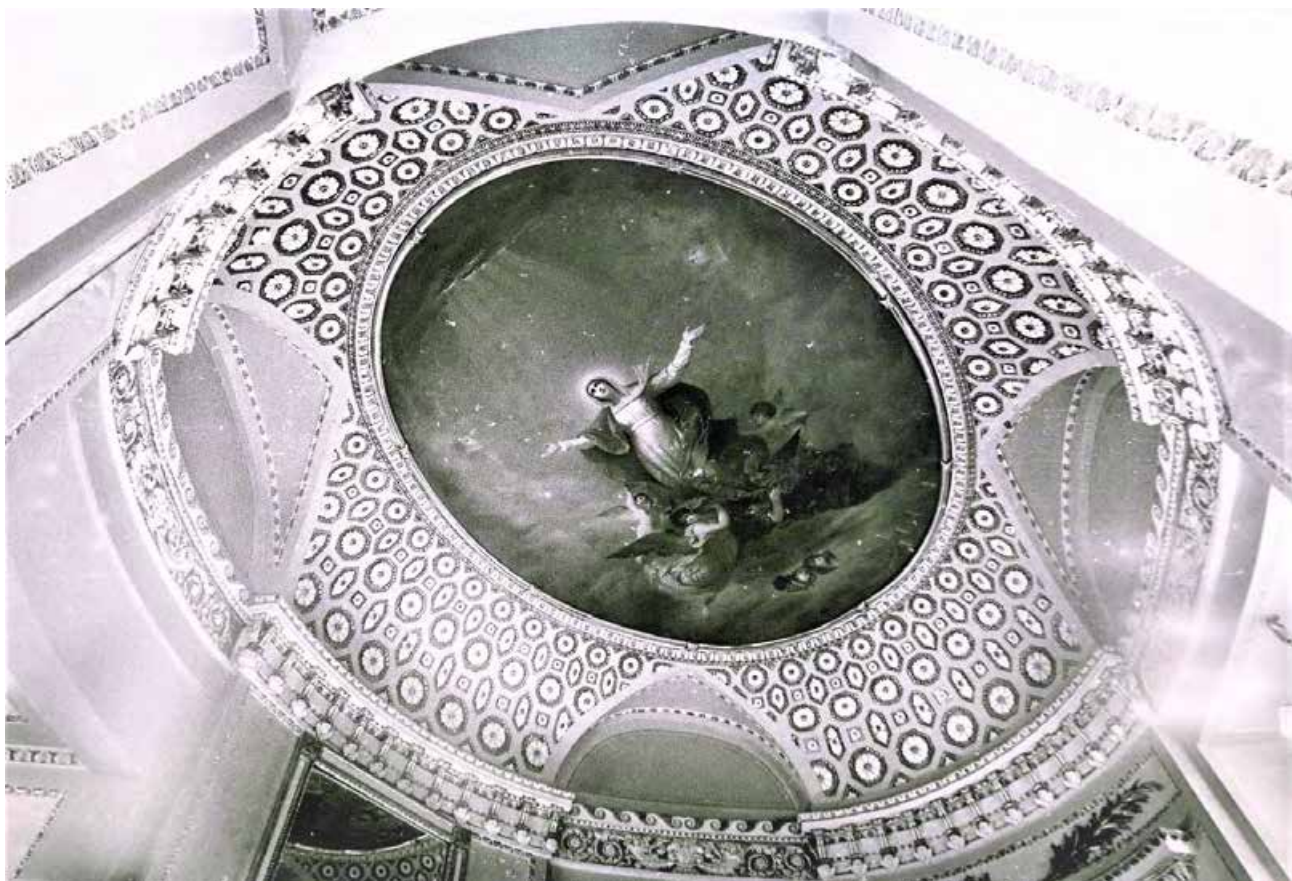
53. Притвор церкви. Вид на потолок
