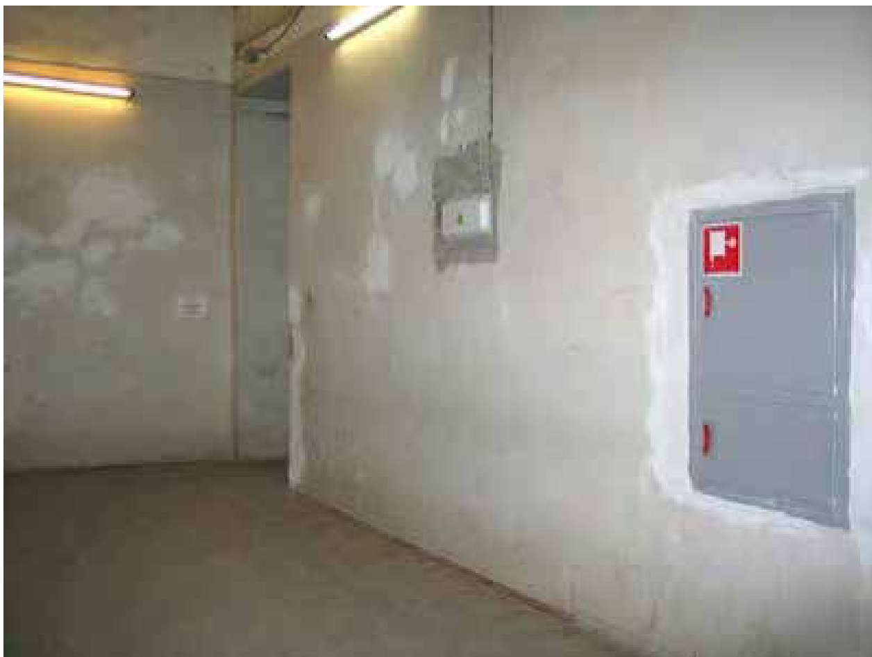
37. Коридор на месте алтарной части церкви
