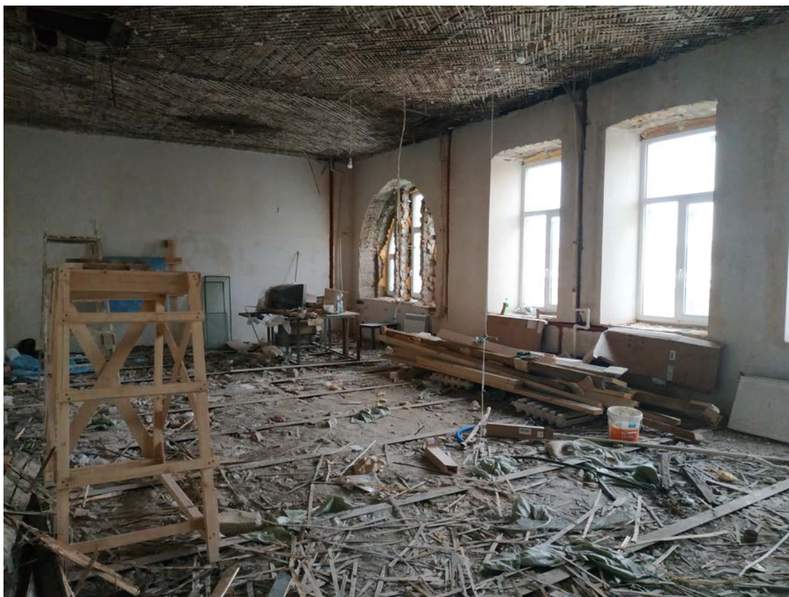
Фото 10. Квартира № 32. Вид на оконные проемы.
