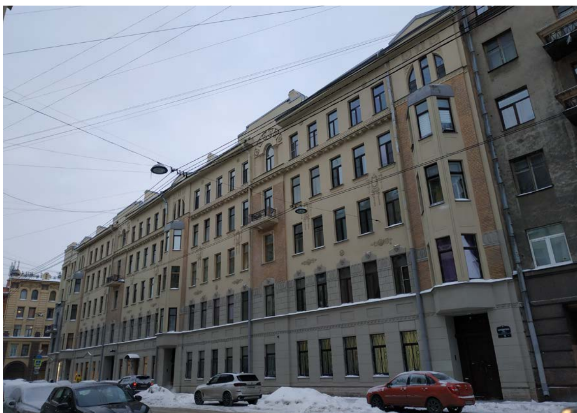
Фото 2. Дом Гудовича В.В. Вид на северо-восточный фасад со стороны Бородинской ул.
