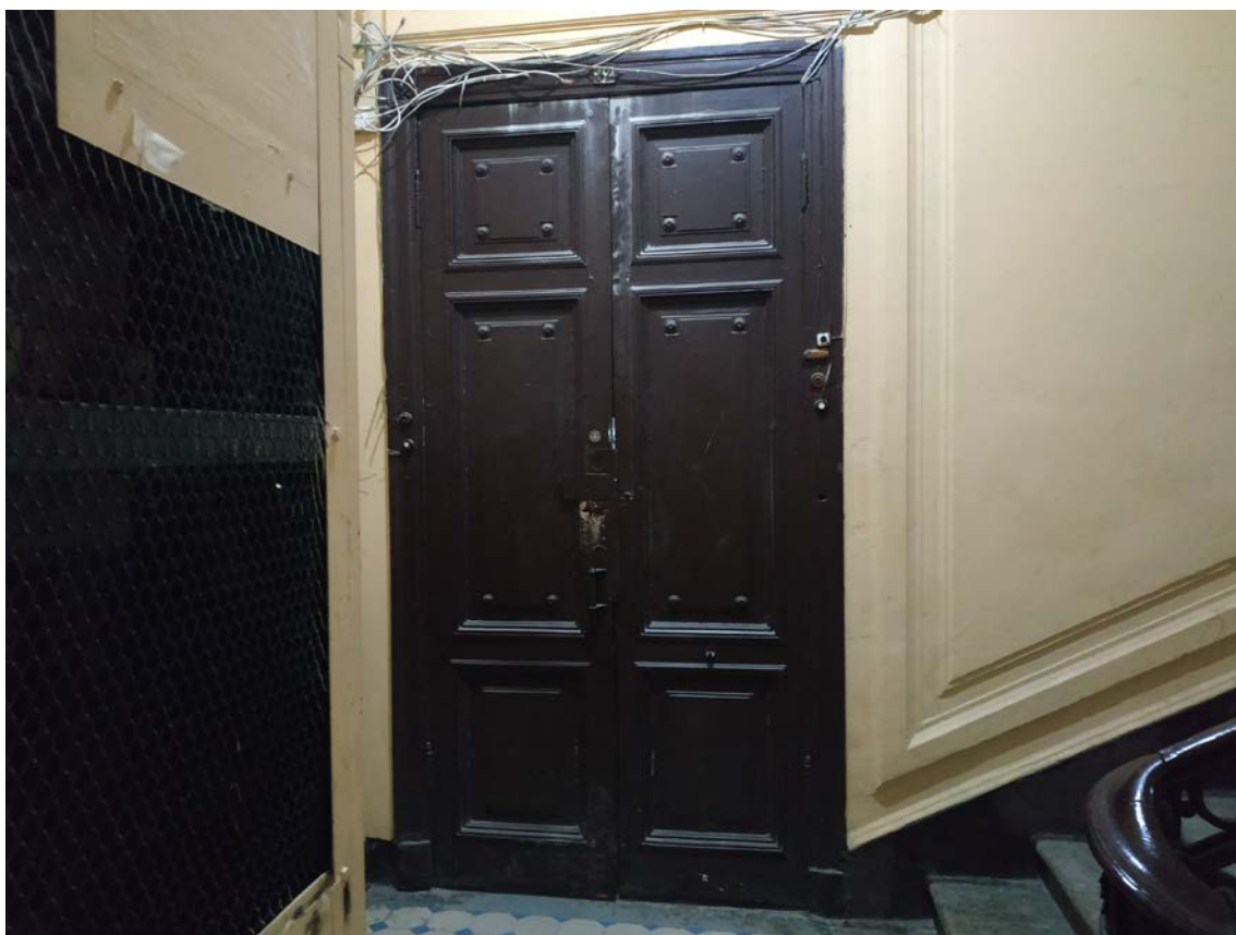
Фото 7. Дверь, ведущая в квартиру № 32.
