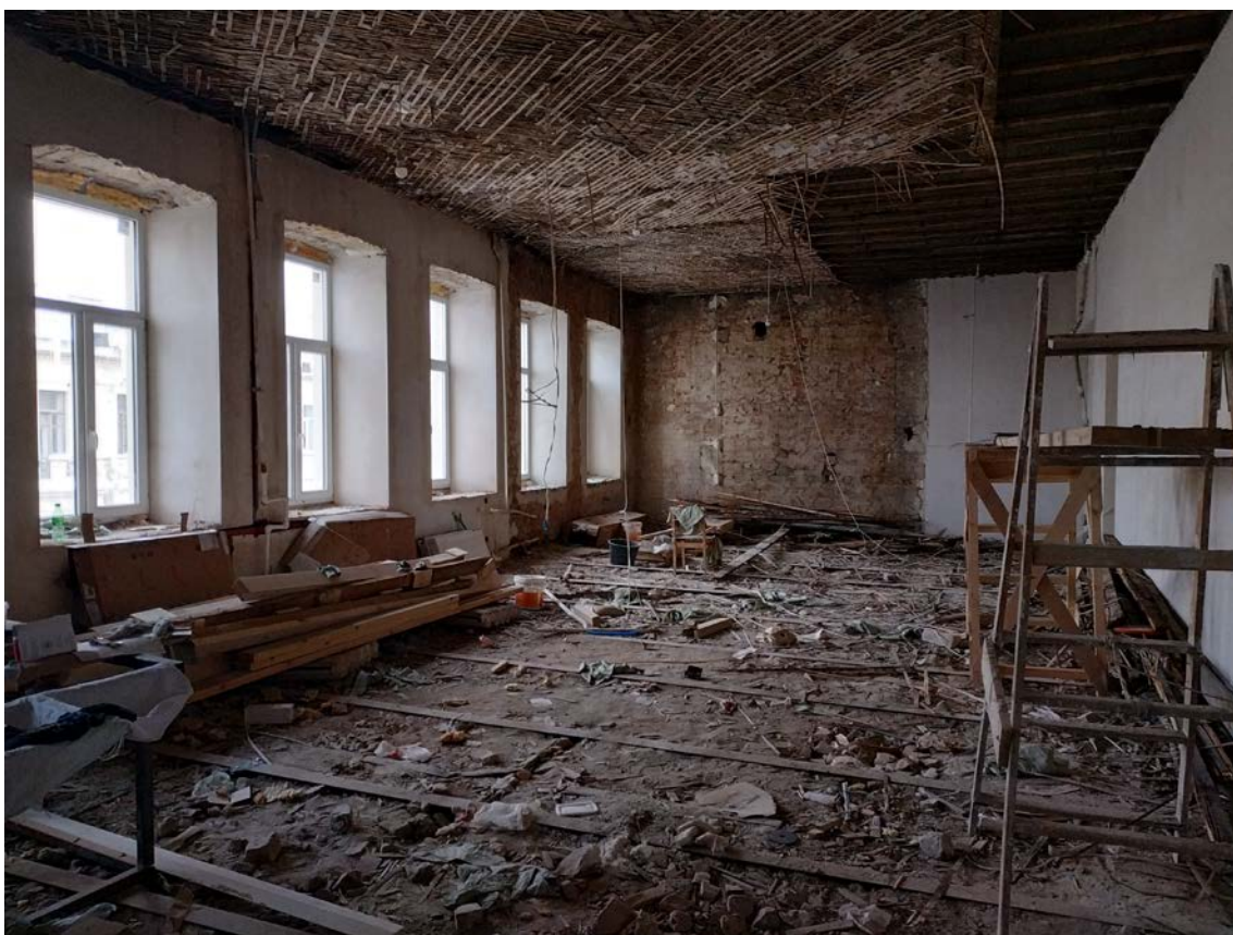
Фото 12. Квартира № 32. Вид на оконные проемы.
