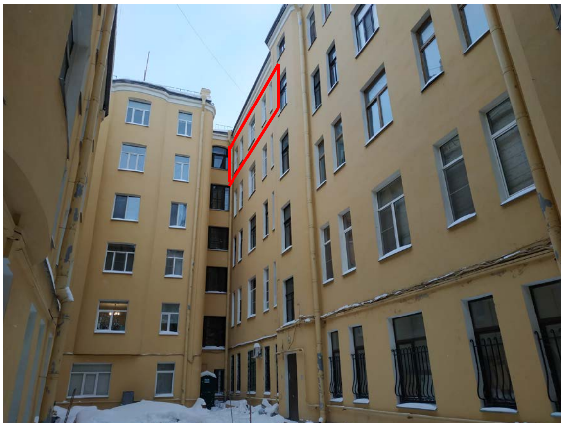
Фото 5. Дворовые фасады дома. Вид на окна квартиры № 32.
