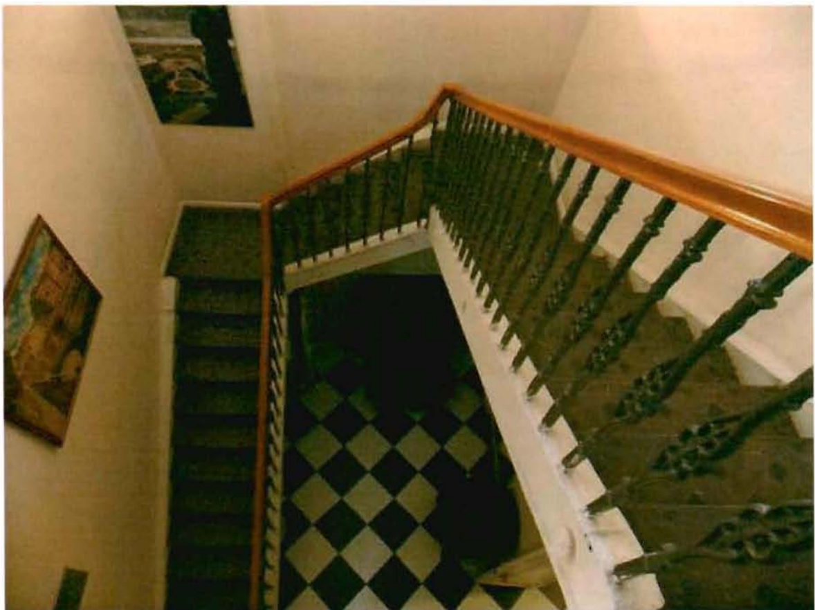
26. Лестница, ведущая со 2 на 3 этаж (северная часть лицевого флигеля)
