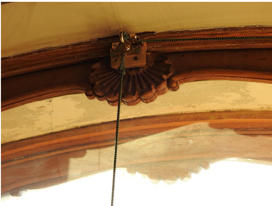
23. «Дома Дубянских (Зиновьева Н. В, Карловой Н.Ф.). Дом жилой», набережная р. Фонтанки, д. 48. Общий вид помещения № 148. Фрагмент оконного заполнения. Верхняя фрамуга. Фото 10.11.2021 г.
