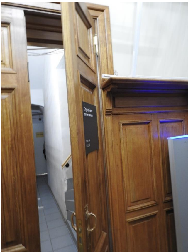
43. «Дома Дубянских (Зиновьева Н. В, Карловой Н.Ф.). Дом жилой», набережная р. Фонтанки, д. 48. Вид на помещение № 112 со стороны коридора. Фото 10.11.2021 г.
