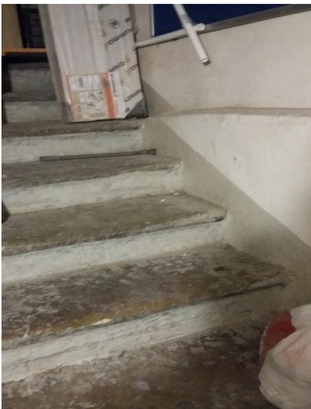
30. «Дома Дубянских (Зиновьева Н. В, Карловой Н.Ф.). Дом жилой», набережная р. Фонтанки, д. 48. Помещение № 60. Верхняя часть лестничного марша, ближе к двери в помещение № 113. Фото 10.11.2021 г.
