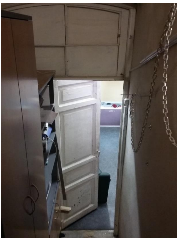
28. «Дома Дубянских (Зиновьева Н. В, Карловой Н.Ф.). Дом жилой», набережная р. Фонтанки, д. 48. Вид на входную дверь в помещение № 58 со стороны лестничного марша помещения № 60. Фото 10.11.2021 г.
