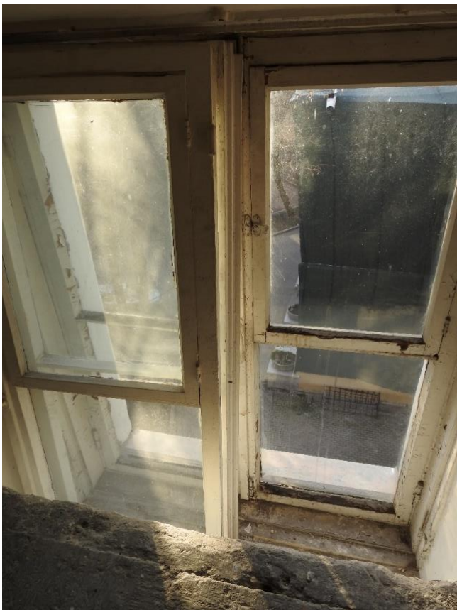
39. «Дома Дубянских (Зиновьева Н. В, Карловой Н.Ф.). Дом жилой», набережная р. Фонтанки, д. 48. Помещение № 134. Вид с переходной площадки со 3-го на 4 этаж. Внутренние оконные рамы сняты с петель. Фото 10.11.2021 г.
