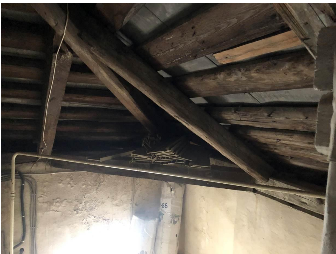
56. «Дома Дубянских (Зиновьева Н. В, Карловой Н.Ф.). Дом жилой», набережная р. Фонтанки, д. 48. Помещение № 173. Деревянные конструкции кровли. Фото 10.11.2021 г.
