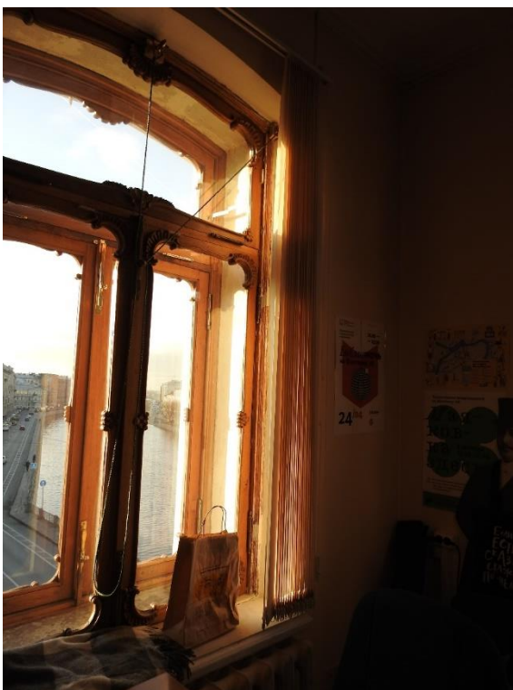
22. «Дома Дубянских (Зиновьева Н. В, Карловой Н.Ф.). Дом жилой», набережная р. Фонтанки, д. 48. Общий вид помещения № 148. Фрагмент оконного заполнения. Фото 10.11.2021 г.
