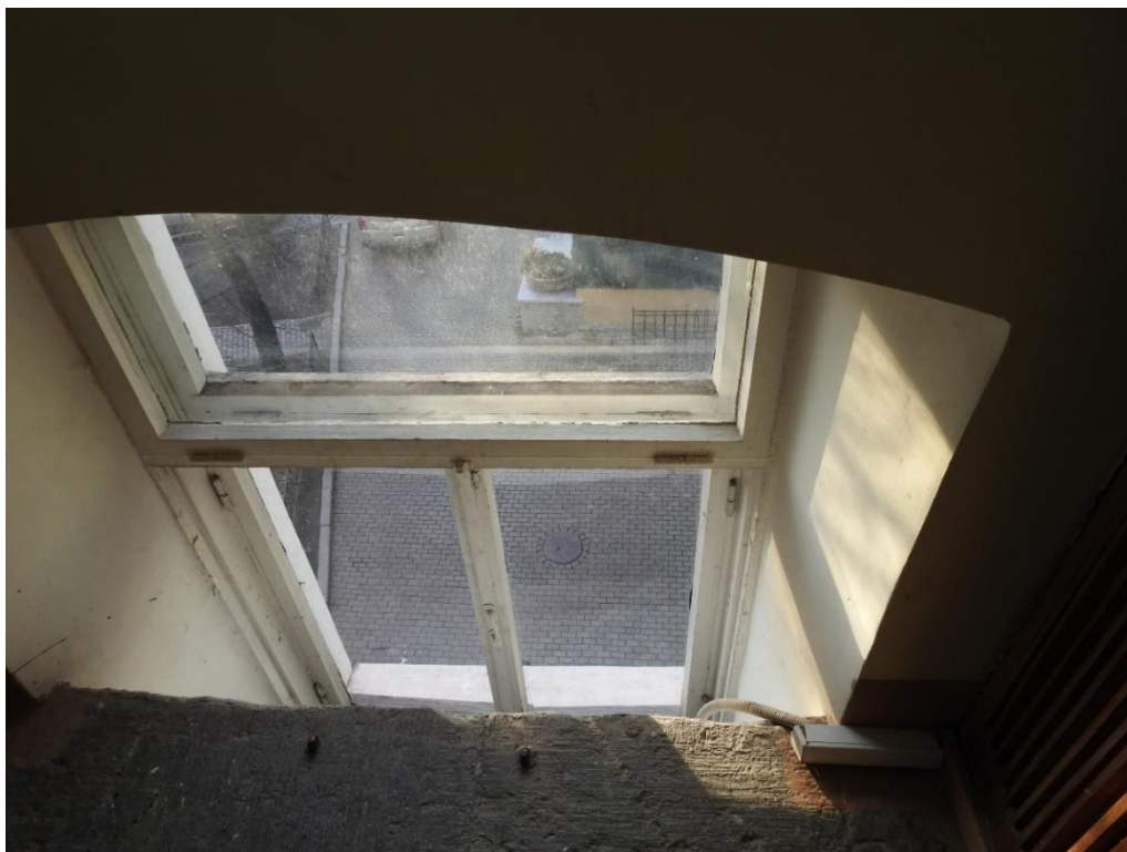
38. «Дома Дубянских (Зиновьева Н. В, Карловой Н.Ф.). Дом жилой», набережная р. Фонтанки, д. 48. Помещение № 129. Вид с переходной площадки со 2-го на 3 этаж. Внутренние оконные рамы сняты с петель. Фото 10.11.2021 г.
