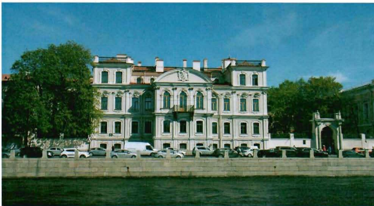
1. Лицевой фасад (северо-западный)
