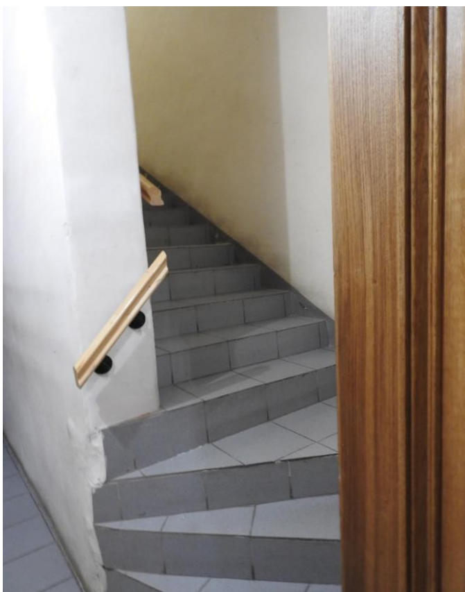
48. «Дома Дубянских (Зиновьева Н. В, Карловой Н.Ф.). Дом жилой», набережная р. Фонтанки, д. 48. Лестничный марш помещения № 112. Фото 10.11.2021 г.
