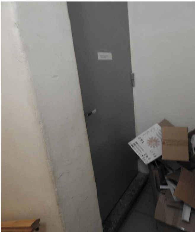
53. «Дома Дубянских (Зиновьева Н. В, Карловой Н.Ф.). Дом жилой», набережная р. Фонтанки, д. 48. Помещение № 172. Площадка третьего этажа. Металлическая дверь к лестничному маршу, ведущему на чердак. Фото 10.11.2021 г.
