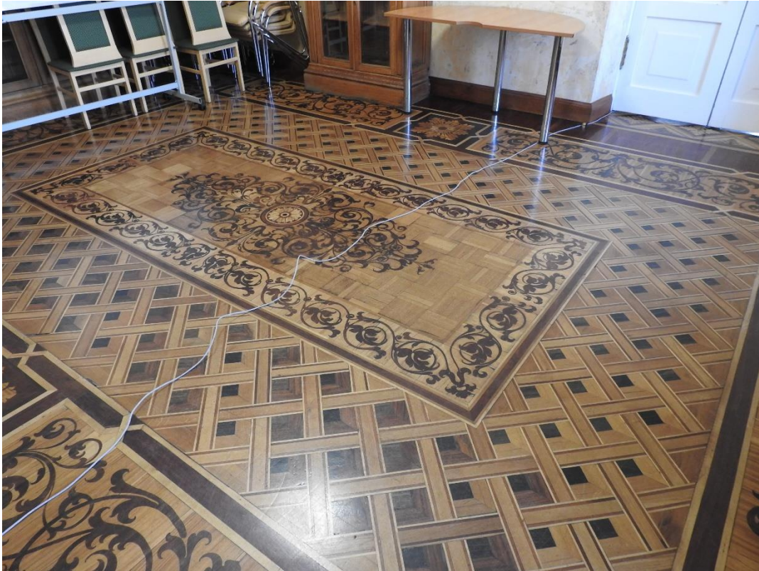
17. «Дома Дубянских (Зиновьева Н. В, Карловой Н.Ф.). Дом жилой», набережная р. Фонтанки, д. 48. Общий вид помещения № 104 (лекторий). Паркет. Фото 10.11.2021 г.
