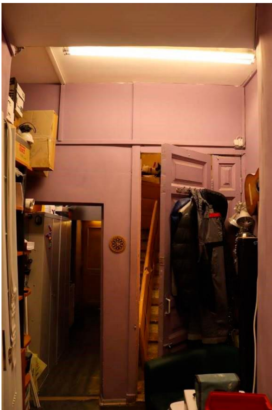
27. «Дома Дубянских (Зиновьева Н. В, Карловой Н.Ф.). Дом жилой», набережная р. Фонтанки, д. 48. Общий вид помещения № 58 с дверью в помещение № 60. Фото 10.11.2021 г.
