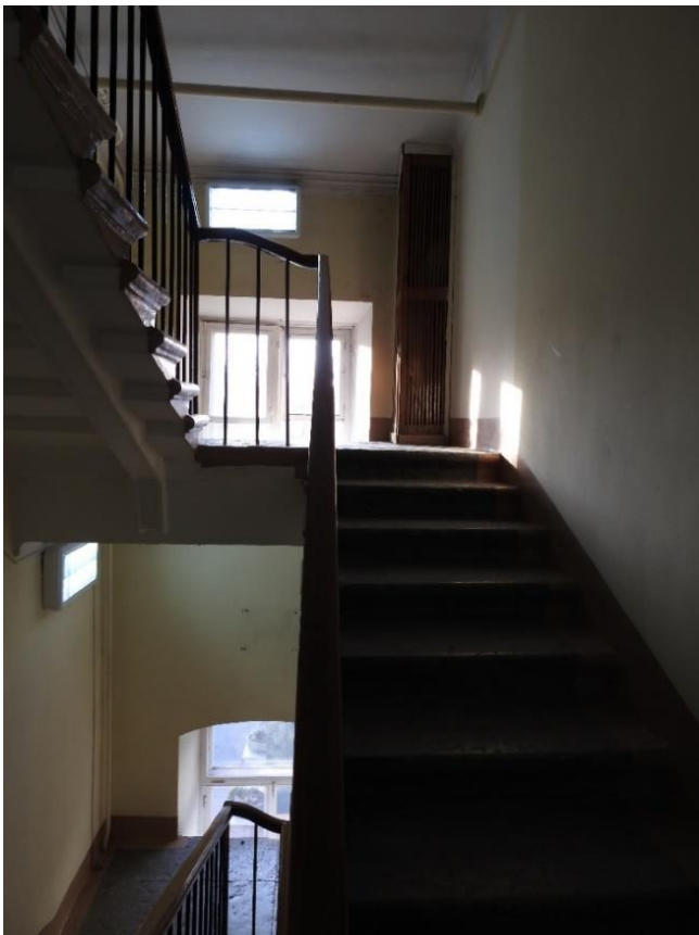
41. «Дома Дубянских (Зиновьева Н. В, Карловой Н.Ф.). Дом жилой», набережная р. Фонтанки, д. 48. Помещение № 134. Фото 10.11.2021 г.
