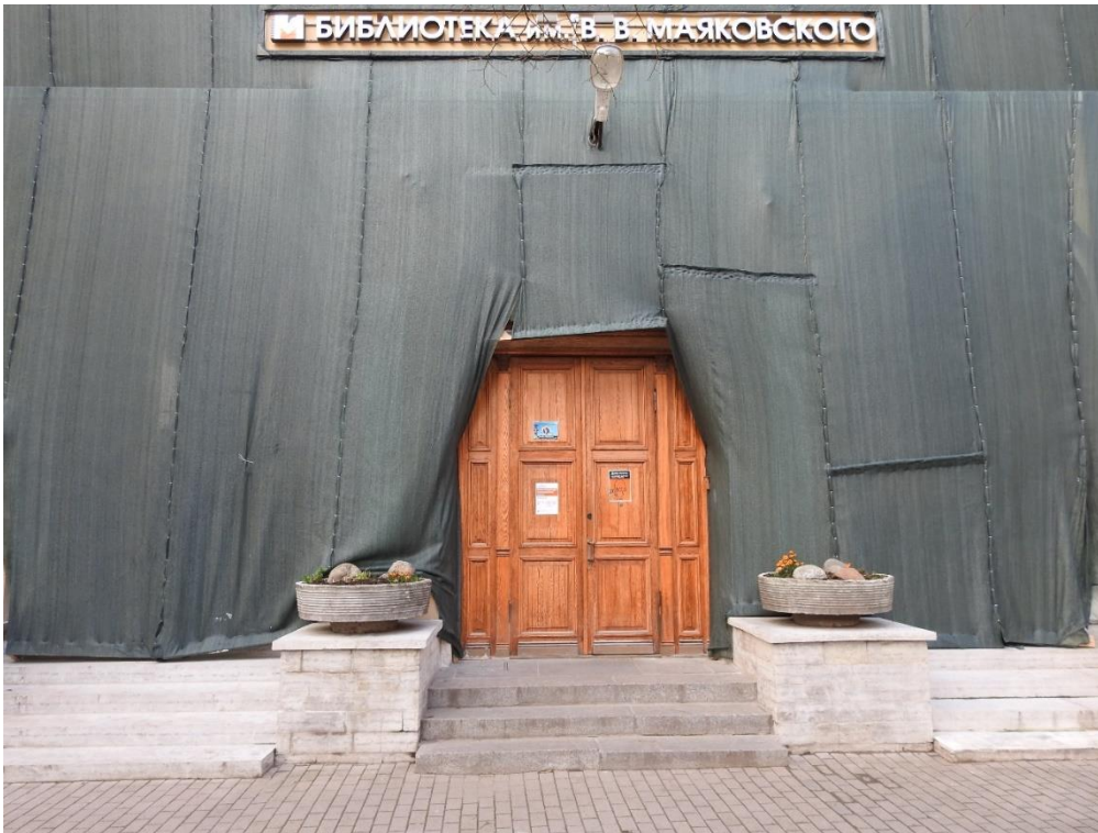
5. «Дома Дубянских (Зиновьева Н. В, Карловой Н.Ф.). Дом жилой», набережная р. Фонтанки, д. 48. Общий вид дворового фасада. Вход в здание. Фото 10.11.2021 г.
