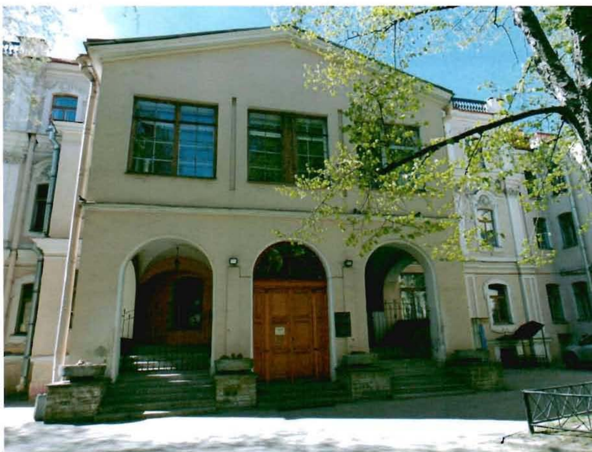
4. Юго-восточный дворовый фасад
