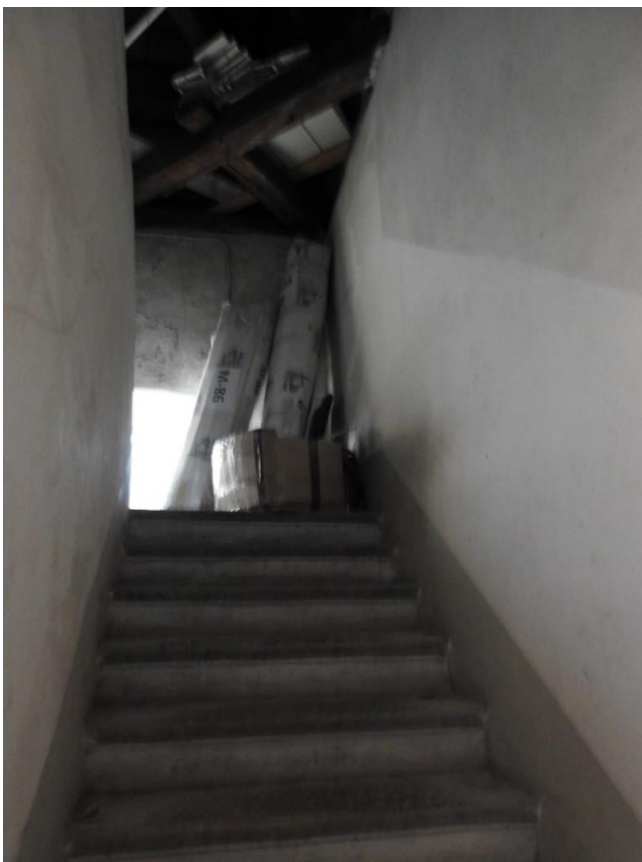
54. «Дома Дубянских (Зиновьева Н. В, Карловой Н.Ф.). Дом жилой», набережная р. Фонтанки, д. 48. Помещение № 173. Лестничный марш, ведущий на чердак. Вид от двери. Фото 10.11.2021 г.
