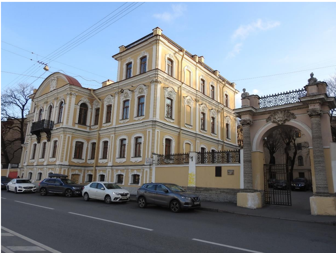
1. «Дома Дубянских (Зиновьева Н. В, Карловой Н.Ф.). Дом жилой», набережная р. Фонтанки, д. 48. Общий вид с юго-запада. Фото 10.11.2021 г.
