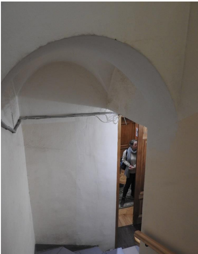
47. «Дома Дубянских (Зиновьева Н. В, Карловой Н.Ф.). Дом жилой», набережная р. Фонтанки, д. 48. Вид на выход из помещения № 112. Фото 10.11.2021 г.
