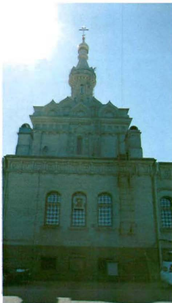
4. Фрагмент северо-восточного фасада объекта культурного наследия.
