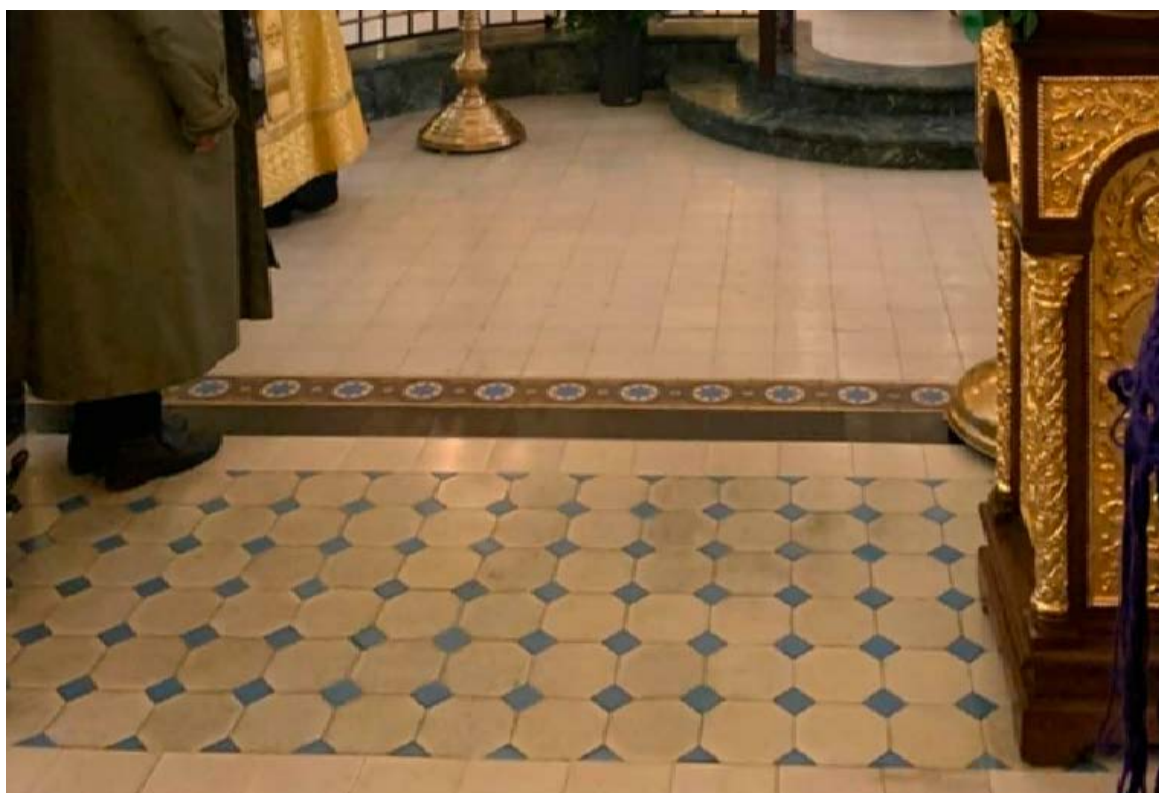
14. Интерьер объекта культурного наследия федерального значения «Часовня церкви Божией Матери Всех Скорбящих Радости», расположенного по адресу: г. Санкт-Петербург, пр. Обуховской Оборона, д. 24, лит. А. Покрытие пола. 30.10.2021
