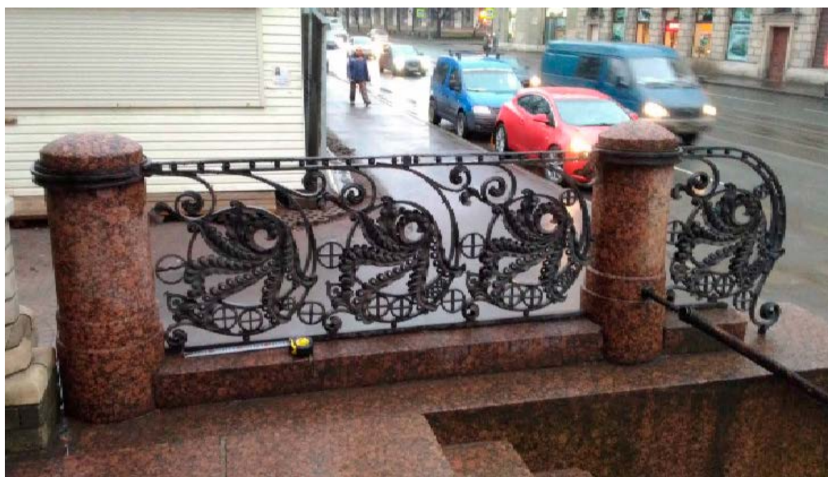
8. Юго-западный фасад объекта культурного наследия федерального значения «Часовня церкви Божией Матери Всех Скорбящих Радости», расположенного по адресу: г. Санкт-Петербург, пр. Обуховской Обороны, д. 24, лит. А. Фрагмент. Юго-западное крыльцо. 30.10.2021
