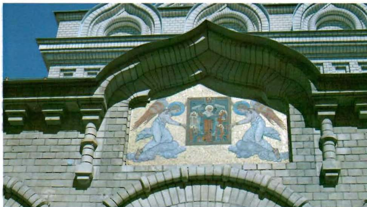
7. Фрагмент юго-западного фасада объекта культурного наследия. Мозаичная икона «Всех Скорбящих радость».
