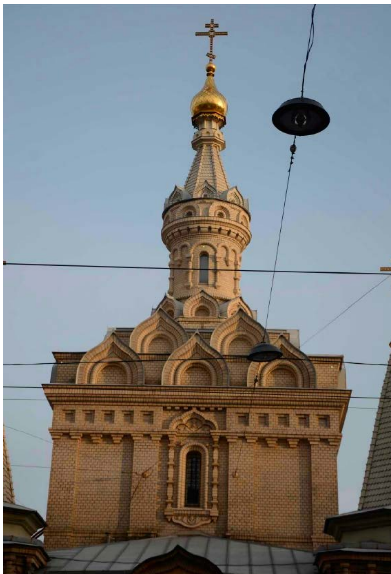
4. Юго-западный фасад объекта культурного наследия федерального значения «Часовня церкви Божией Матери Всех Скорбящих Радости», расположенного по адресу: г. Санкт-Петербург, пр. Обуховской Обороны, д. 24, лит. А. 30.10.2021
