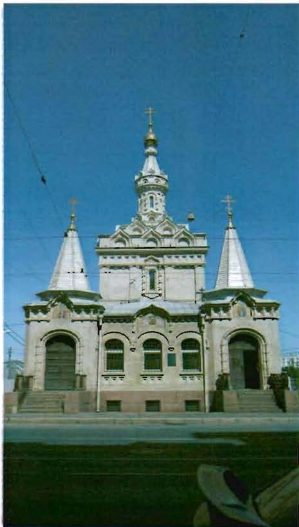
1. Юго-западный фасад объекта культурного наследия.
