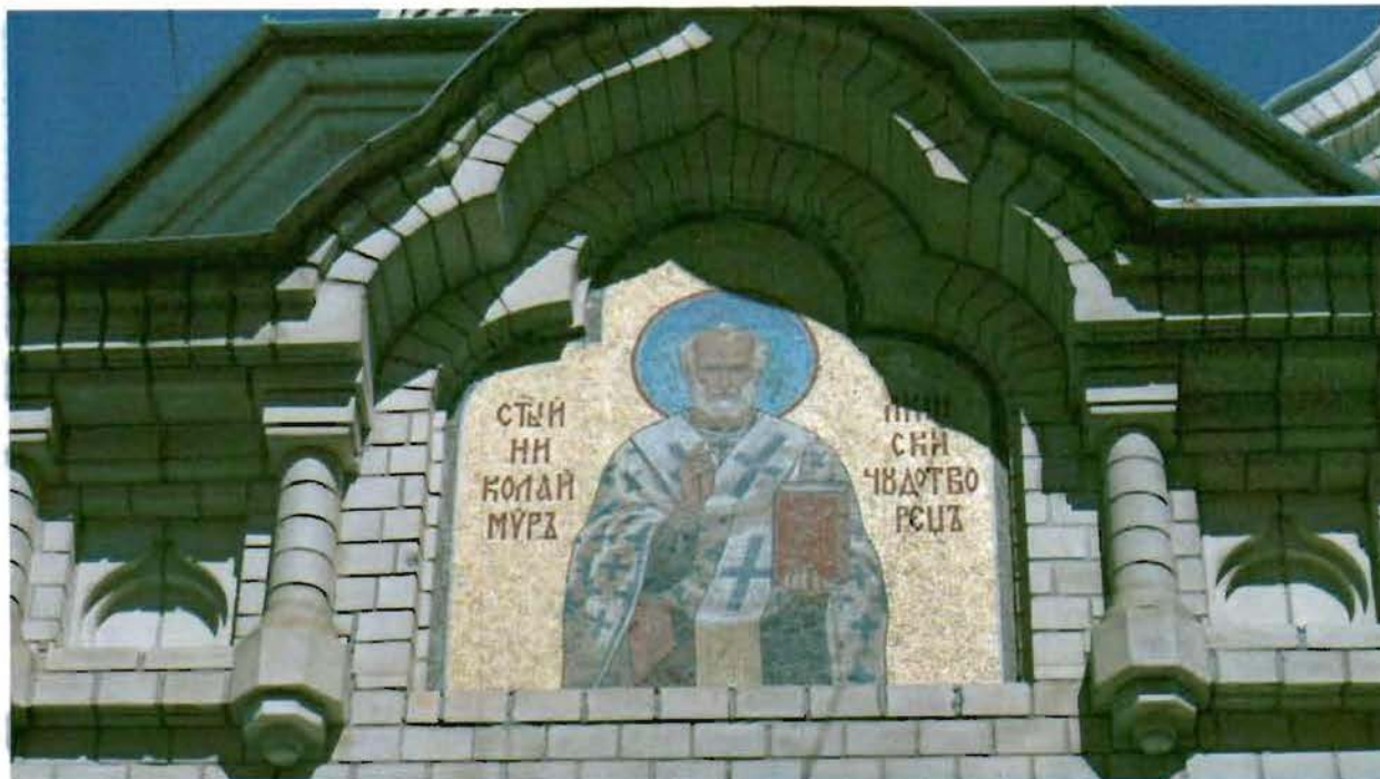
6. Фрагмент юго-западного фасада объекта культурного наследия. Мозаичная икона «Святитель Николай Чудотворец».
