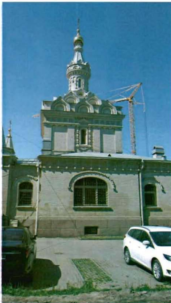
2. Фрагмент юго-восточного фасада объекта культурного наследия.
