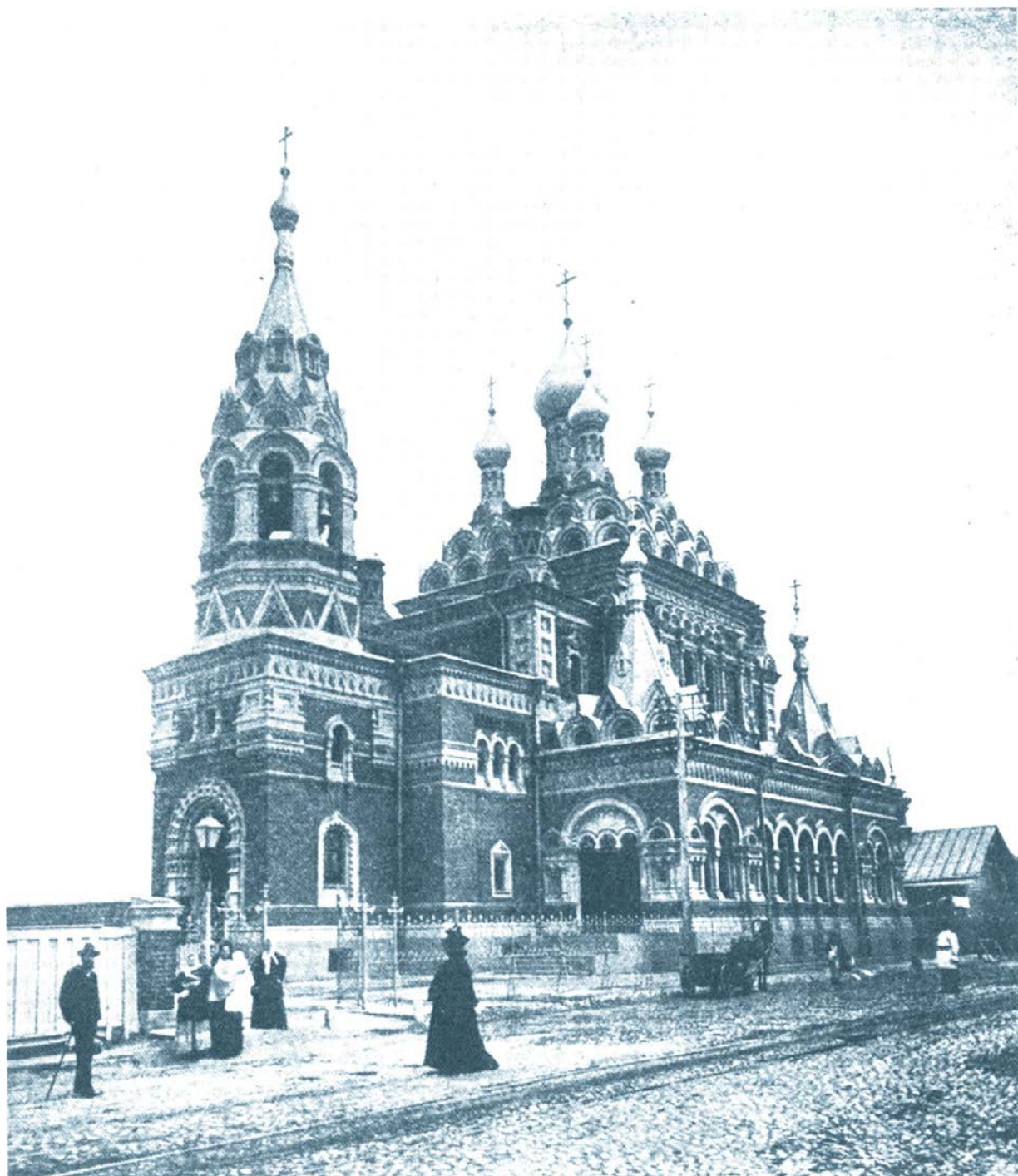
Илл. 21. Церковь при Стеклянном заводе в С. – Петербурге. Общий вид с натуры. 1900г. Акад. Арх. А.И. фон Гоген. Оpubл.: Барановский Г.В. Архитектурная энциклопедия второй половины XIX века. Том I. М., 2006. С.196.
