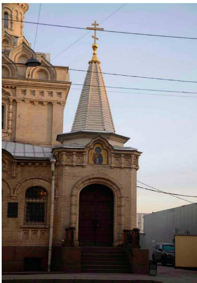
6. Юго-западный фасад объекта культурного наследия федерального значения «Часовня церкви Божией Матери Всех Скорбящих Радости», расположенного по адресу: г. Санкт-Петербург, пр. Обуховской Обороны, д. 24, лит. А. Фрагмент. Юго-западное крыльцо. 30.10.2021
