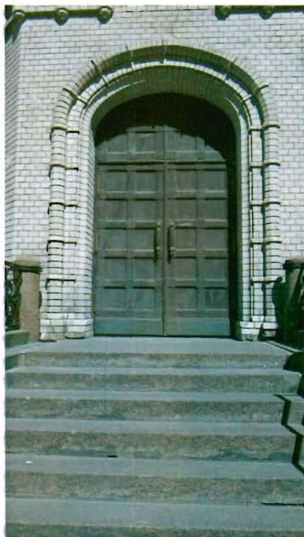
5. Фрагмент юго-западного фасада объекта культурного наследия. Главный вход.
