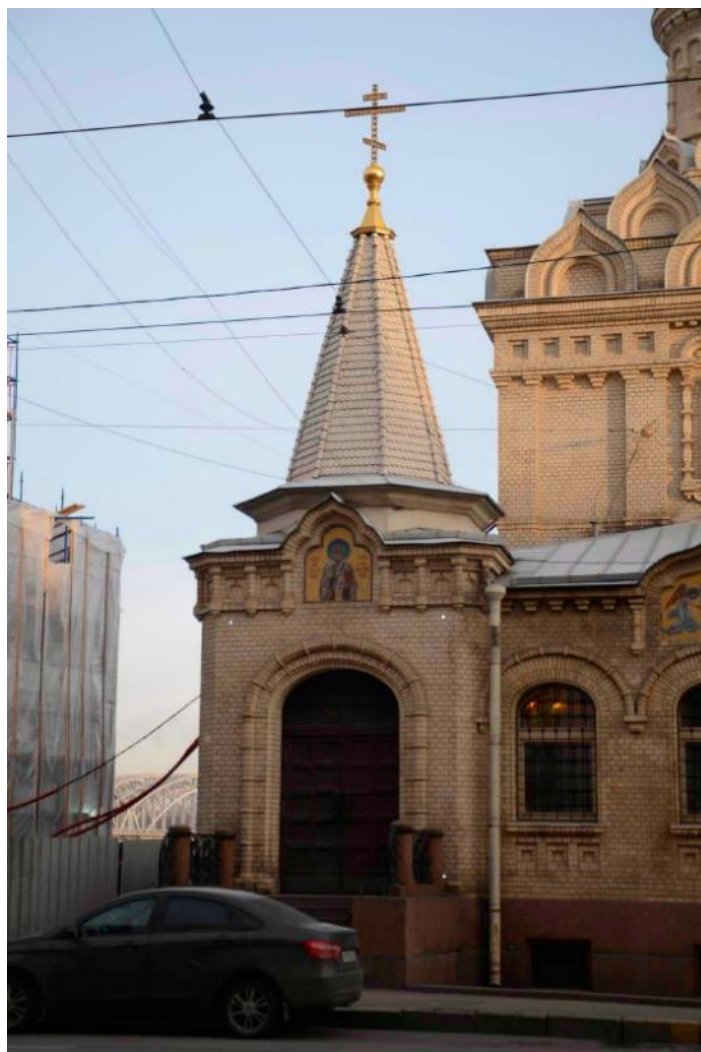
9. Северо-западный фасад объекта культурного наследия федерального значения «Часовня церкви Божией Матери Всех Скорбящих Радости», расположенного по адресу: г. Санкт-Петербург, пр. Обуховской Обороны, д. 24, лит. А. Фрагмент. Северо-западное крыльцо. 30.10.2021
