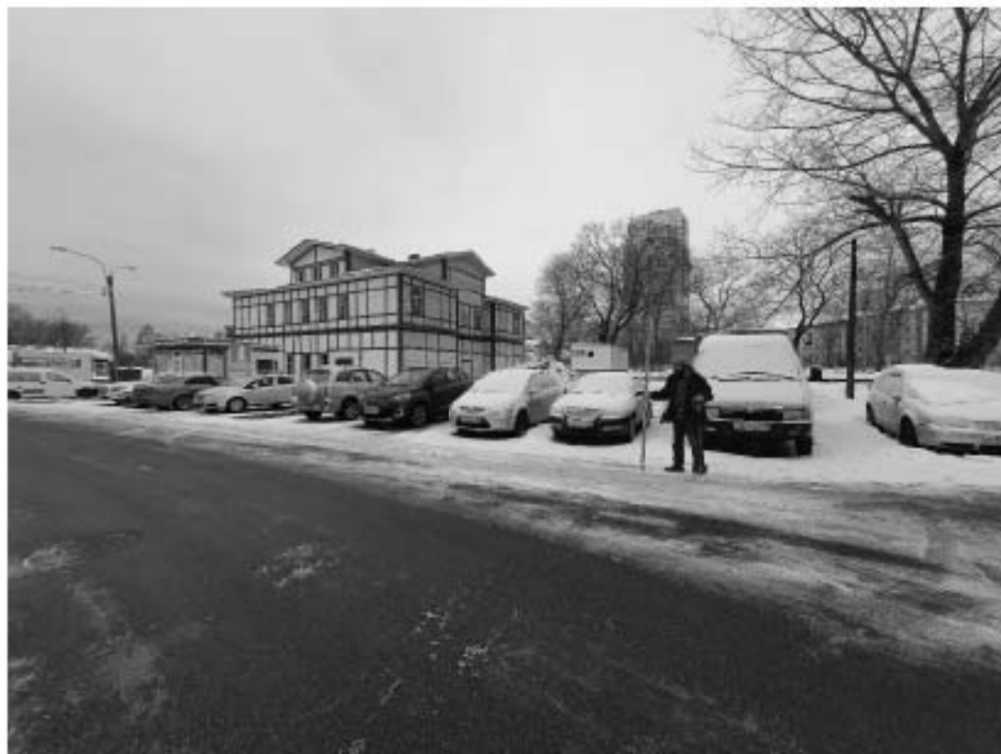
Рис. 14. СПб-2022. Курортный район, г. Сестрорецк. Вокзал. Общий вид участка обследования. Точка фотофиксации 2. Вид с запада
