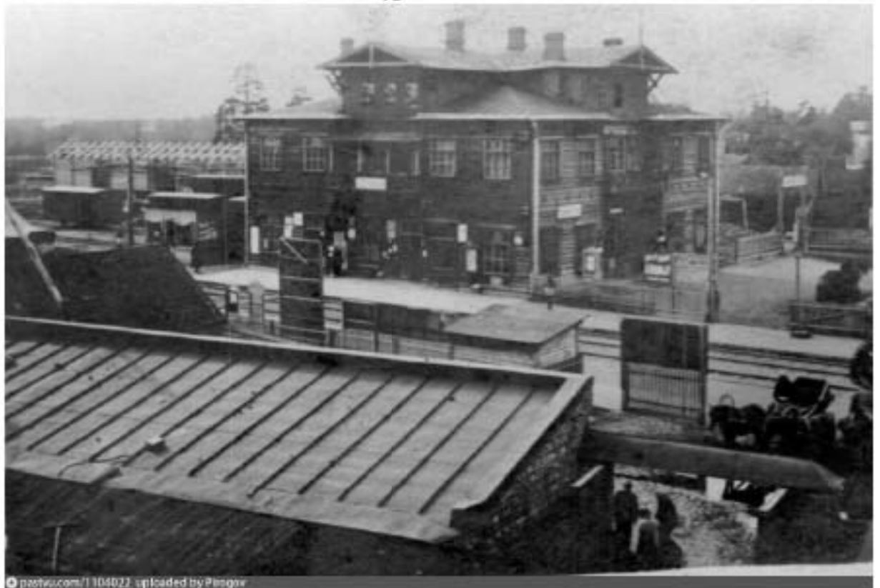
Рис. 10. Фото 1920-х гг. Здание вокзала, с участок обследования (ссылка на источник под фото)
