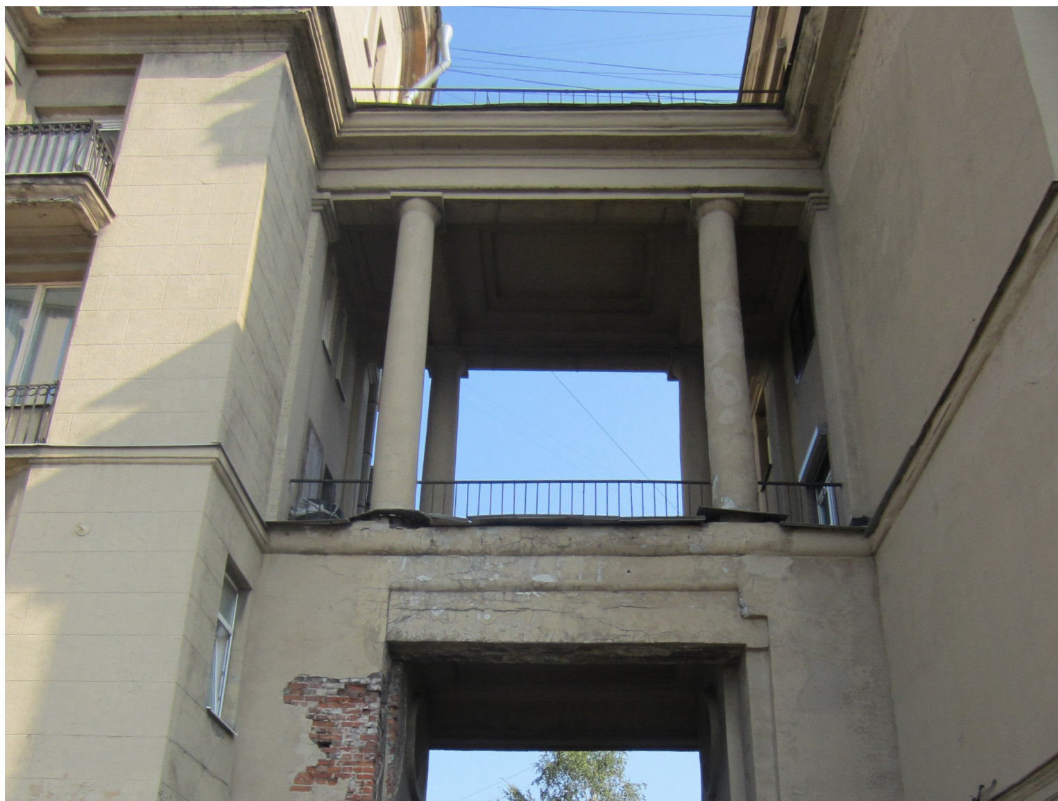
24. Объект культурного наследия регионального значения «Комплекс жилых домов (6 зданий)», расположенный по адресу: Санкт-Петербург, Красногвардейский район, Малоохтинский пр., 86, лит. А. Стилизованные колонны в арочном проеме 2-го яруса пристройки. Съемка: 12 сентября 2019г.
