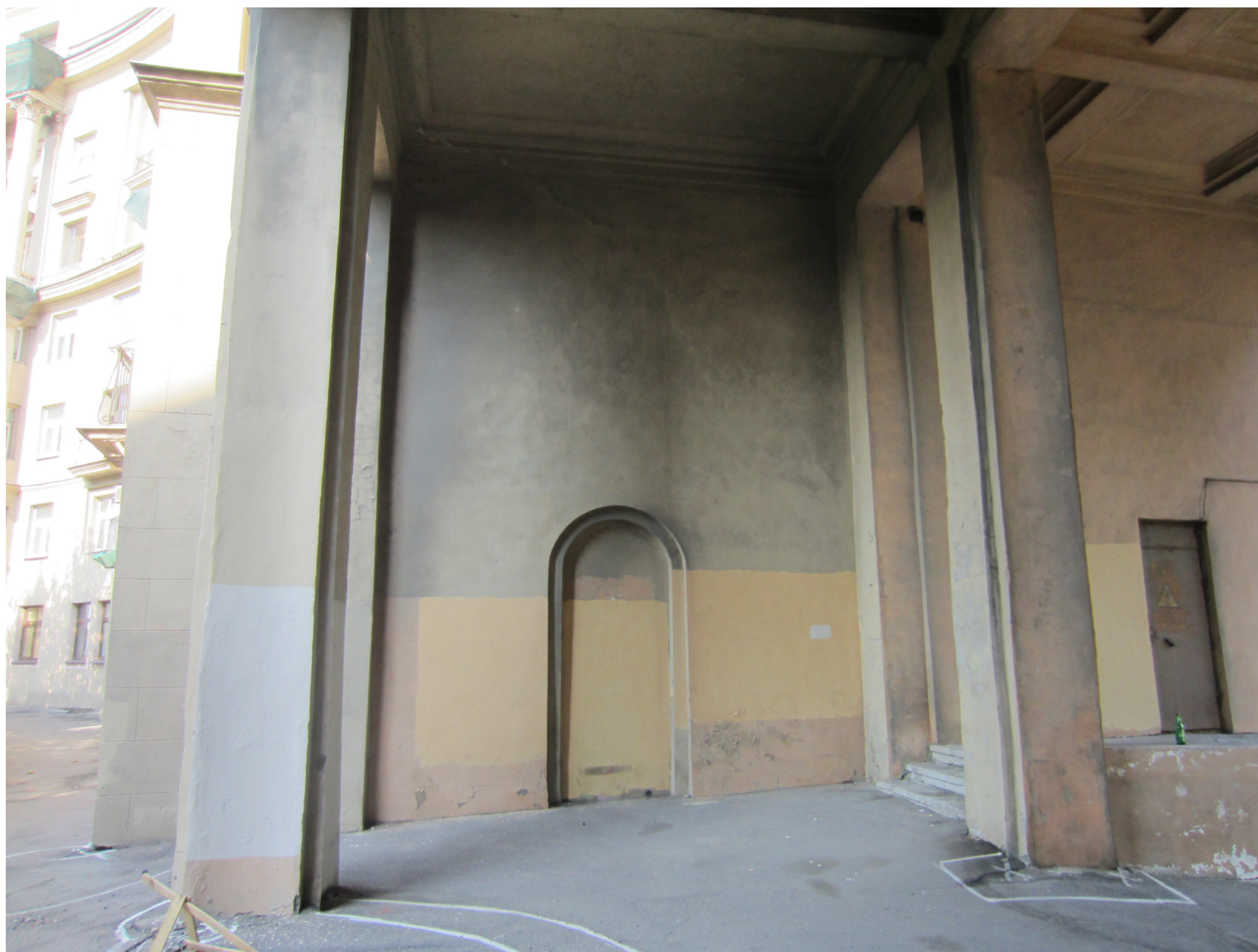
21. Объект культурного наследия регионального значения «Комплекс жилых домов (6 зданий)», расположенный по адресу: Санкт-Петербург, Красногвардейский район, Малоохтинский пр., 86, лит. А Ниша с полуциркульным завершением в стене центрального проезда Съемка: 12 сентября 2019г.
