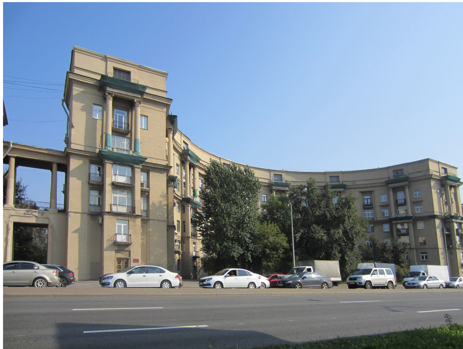
1. Объект культурного наследия регионального значения «Комплекс жилых домов (6 зданий)», расположенный по адресу: Санкт-Петербург, Красногвардейский район, Малоохтинский пр., 86, лит. А Общий вид лицевого фасада с Малоохтинского проспекта Съемка: 12 сентября 2019г.
