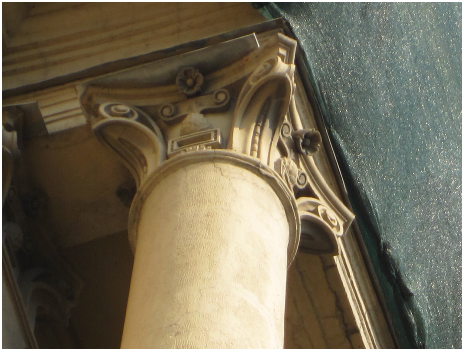
9. Объект культурного наследия регионального значения «Комплекс жилых домов (6 зданий)», расположенный по адресу: Санкт-Петербург, Красногвардейский район, Малоохтинский пр., 86, лит. А Фрагмент фасада. Стилизованная дорическая колонна в эркере на уровне 6 этажа Съемка: 12 сентября 2019г.
