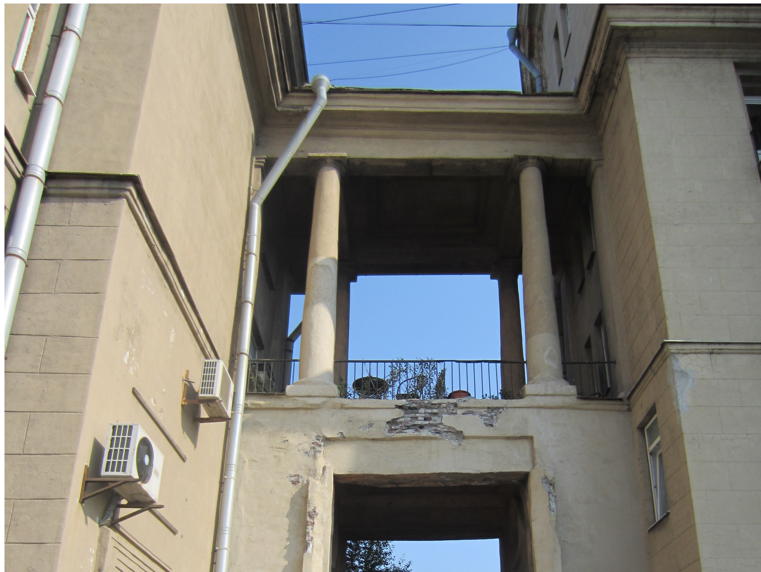
18. Объект культурного наследия регионального значения «Комплекс жилых домов (6 зданий)», расположенный по адресу: Санкт-Петербург, Красногвардейский район, Малоохтинский пр., 86, лит. А Профилированный венчающий карниз северной пристройки, стилизованные колонны Съемка: 12 сентября 2019г.
