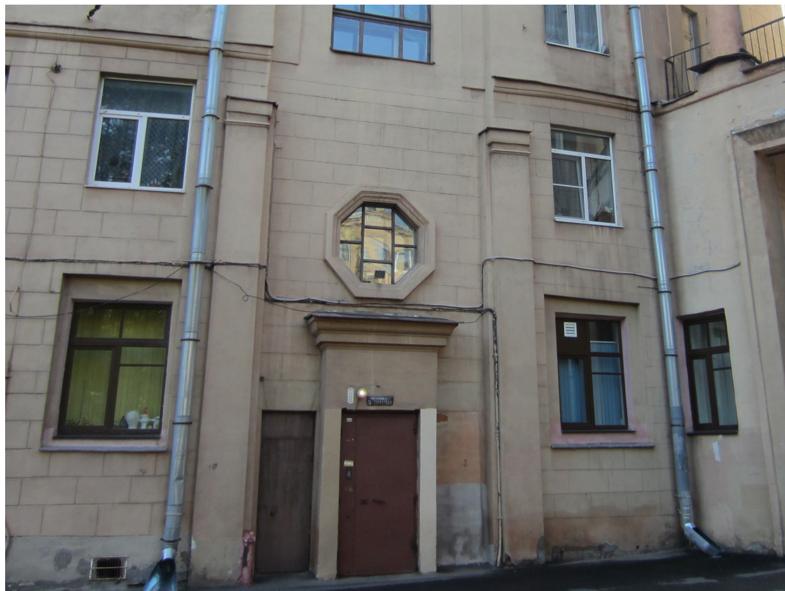
12. Объект культурного наследия регионального значения «Комплекс жилых домов (6 зданий)», расположенный по адресу: Санкт-Петербург, Красногвардейский район, Малоохтинский пр., 86, лит. А Фрагмент дворового фасада. Профилированный наличник восьмигранного окна, прямой сандрик над дверным проемом Съемка: 12 сентября 2019г.
