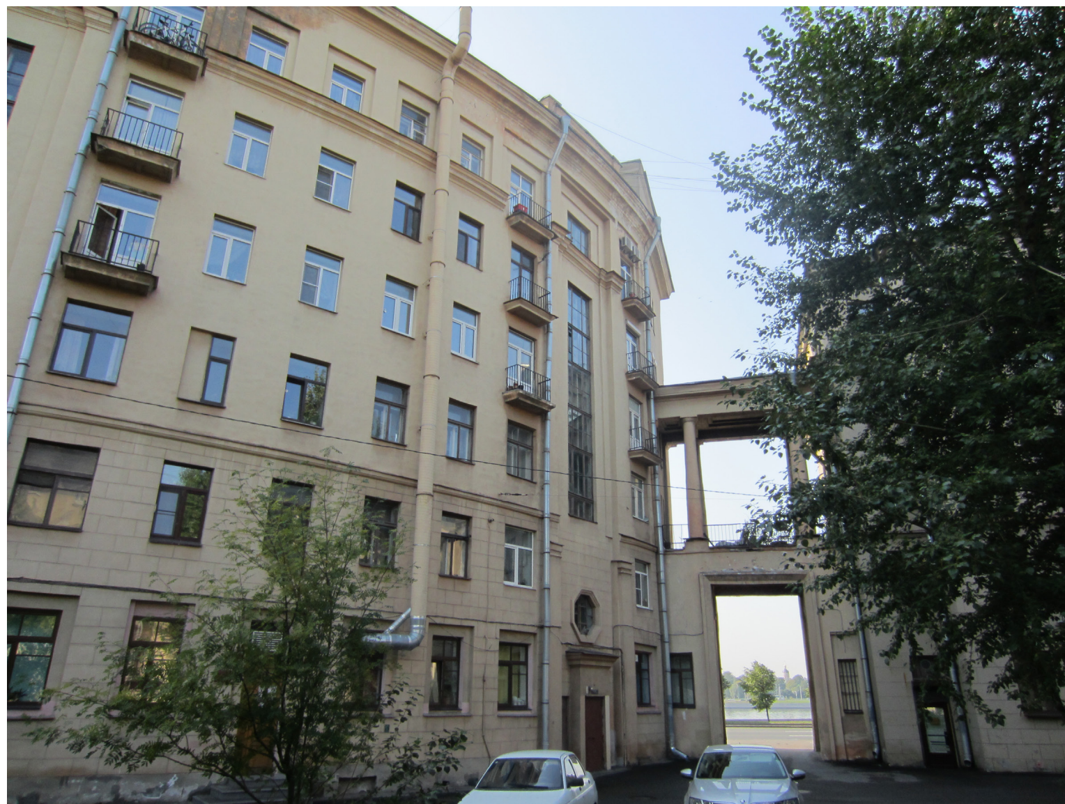
11. Объект культурного наследия регионального значения «Комплекс жилых домов (6 зданий)», расположенный по адресу: Санкт-Петербург, Красногвардейский район, Малоохтинский пр., 86, лит. А Фрагмент дворового фасада. Пристройка к основному объему здания (с северной стороны) Съемка: 12 сентября 2019г.
