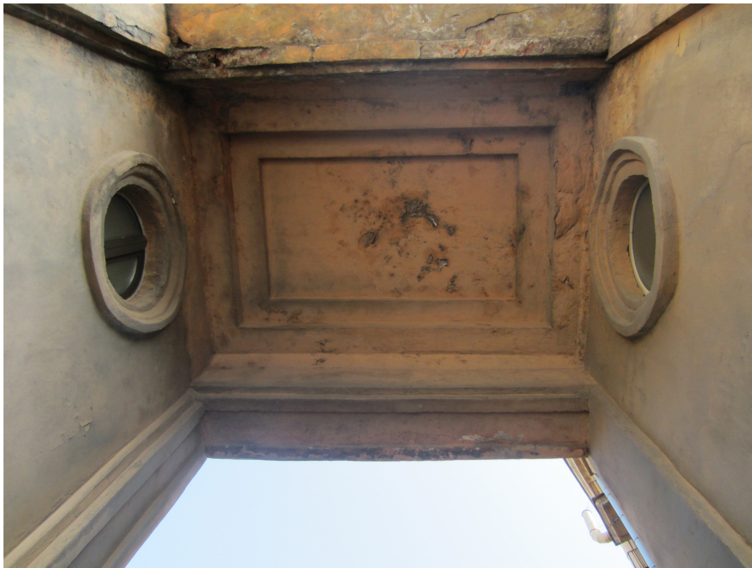
19. Объект культурного наследия регионального значения «Комплекс жилых домов (6 зданий)», расположенный по адресу: Санкт-Петербург, Красногвардейский район, Малоохтинский пр., 86, лит. А Фрагмент декора северной пристройки к основному объему здания Съемка: 12 сентября 2019г.
