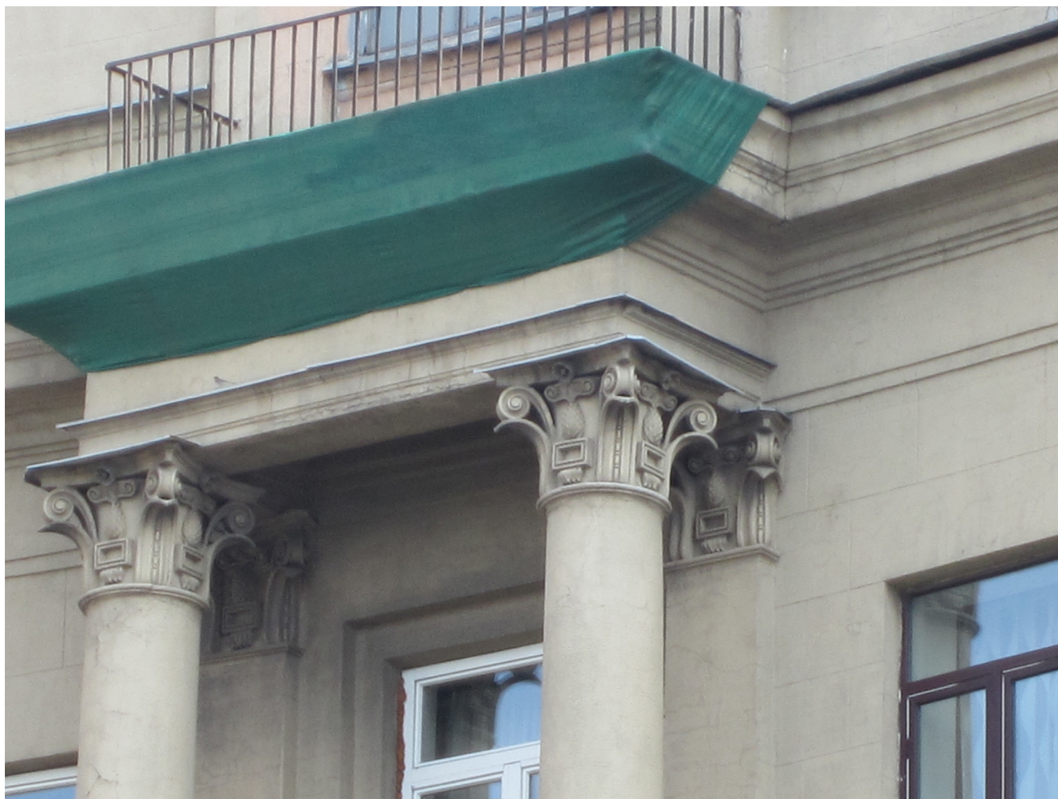
8. Объект культурного наследия регионального значения «Комплекс жилых домов (6 зданий)», расположенный по адресу: Санкт-Петербург, Красногвардейский район, Малоохтинский пр., 86, лит. А Фрагмент лицевого фасада. Межэтажный карниз, колонны и пилястры дорического ордера Съемка: 12 сентября 2019г.
