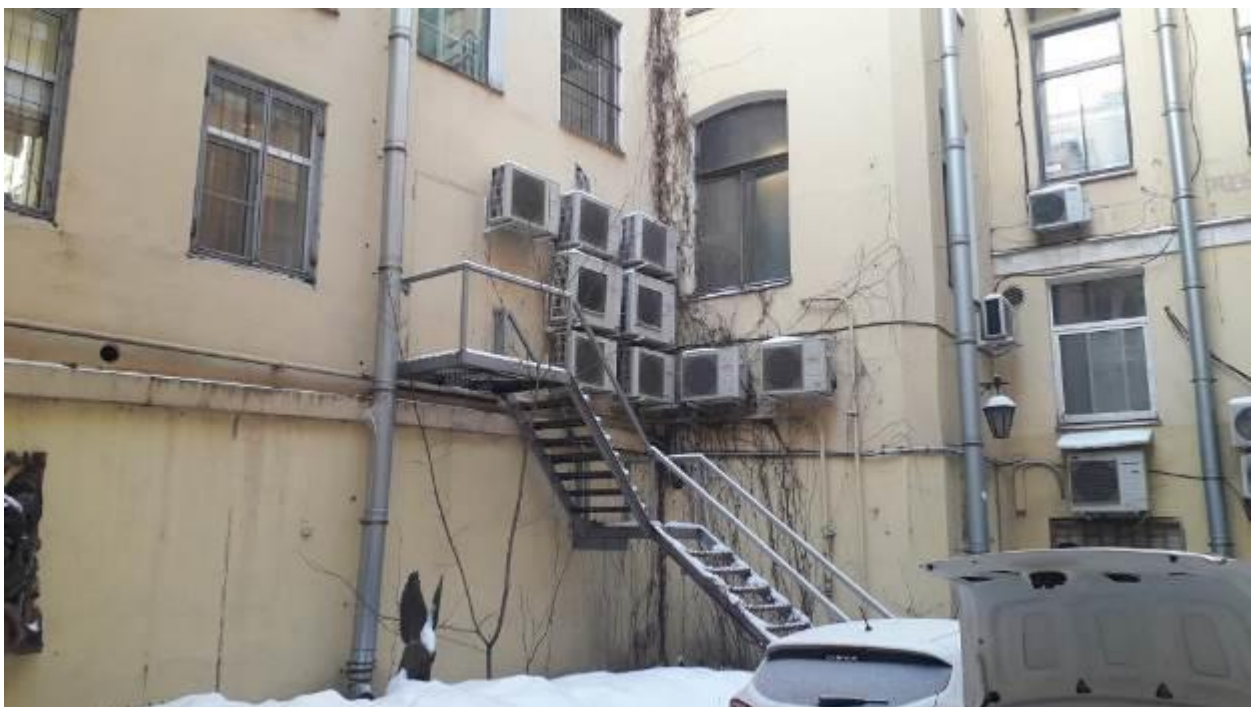
16. Дом А.И. Трейберга. Невский пр., д. 11/2, лит. А. Дворовые фасады. Фото мест установки оборудования и кабельных трасс. Штиглиц М.С. 10.01.2022..
