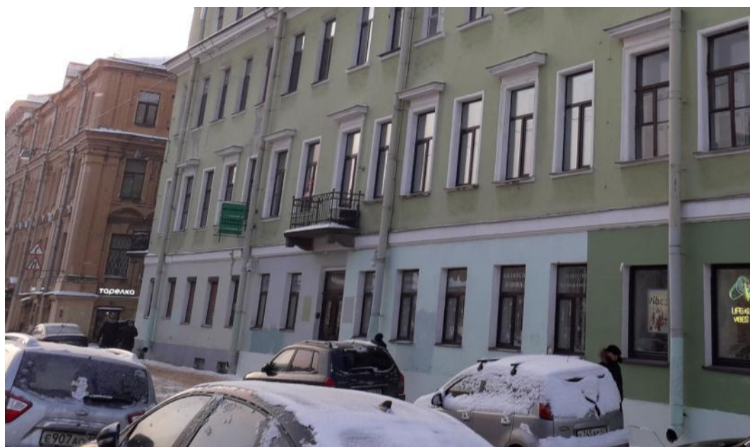
24. Дом Лесниковых. Сергея Тюленина пер., д. 4/23. Лицевой фасад. Фото мест установки оборудования и кабельных трасс. Штиглиц М.С. 10.01.2022.
