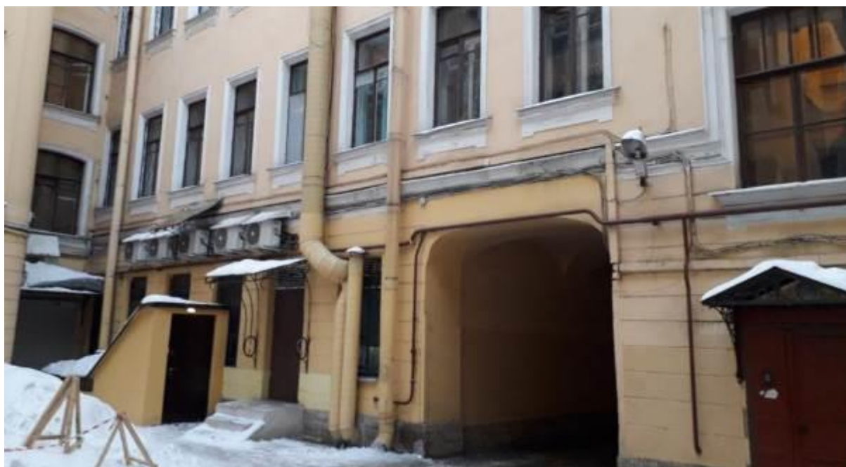
20. Дом Д.И. Тырлова. Невский пр., д. 119, литера А. Дворовые фасады. Фото мест установки оборудования и кабельных трасс. Штиглиц М.С. 10.01.2022.
