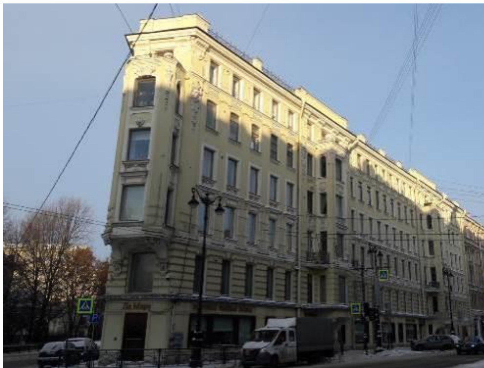
29. Дом А.В. Кашенко. Суворовский пр., д. 34, лит. А. Лицевой фасад. Штиглиц М.С. 10.01.2022.
