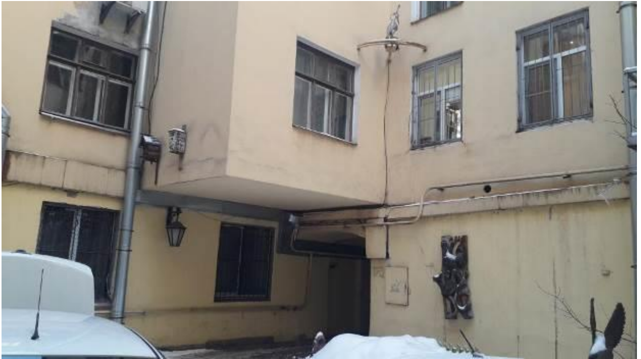
15. Дом А.И. Трейберга. Невский пр., д. 11/2, лит. А. Дворовые фасады. Фото мест установки оборудования и кабельных трасс. Штиглиц М.С. 10.01.2022.
