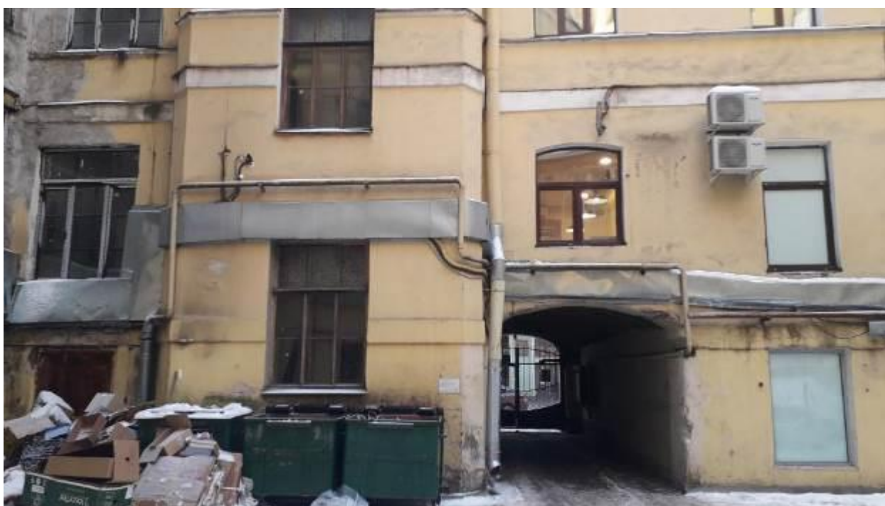
14. Дом А.И. Трейберга. Невский пр., д. 11/2, лит. А. Дворовые фасады. Фото мест установки оборудования и кабельных трасс. Штиглиц М.С. 10.01.2022.
