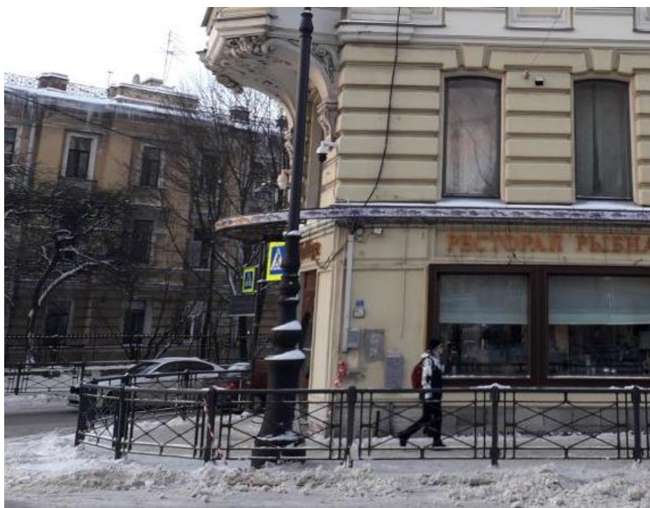
30. Дом А.В. Кашенко. Суворовский пр., д. 34, лит. А. Лицевой фасад. Фото мест установки оборудования и кабельных трасс. Штиглиц М.С. 10.01.2022.
