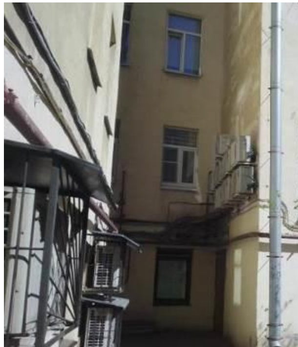
7. Дом К.К. Фелейзена (гостиница «Франция»). Большая Морская ул., д. 6, лит. А. Дворовые фасады. Фото мест установки оборудования и кабельных трасс. Штиглиц М.С. 10.01.2022.
