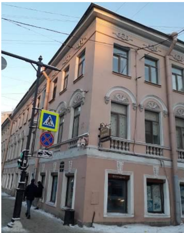
2. Дом А. Александровой. 3-я Советская ул., д. 20/5, лит. А. Лицевой фасад. Фото мест установки оборудования и кабельных трасс. Штиглиц М.С. 10.01.2022.
