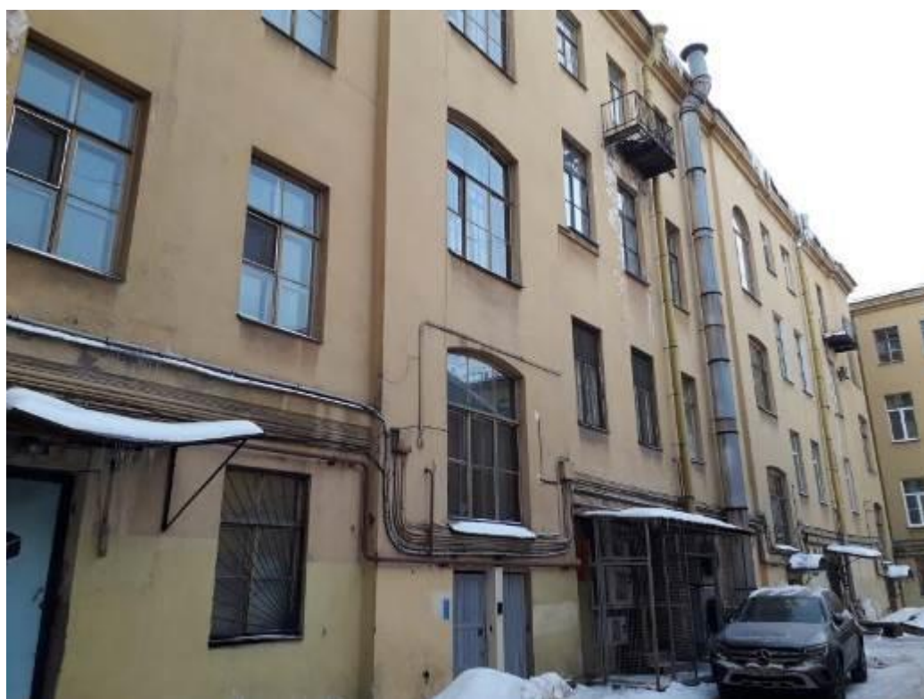
12. Дом А.Х. Пеля. Моховая ул., д. 22, лит. А. Дворовые фасады. Фото мест установки оборудования и кабельных трасс. Штиглиц М.С. 10.01.2022.
