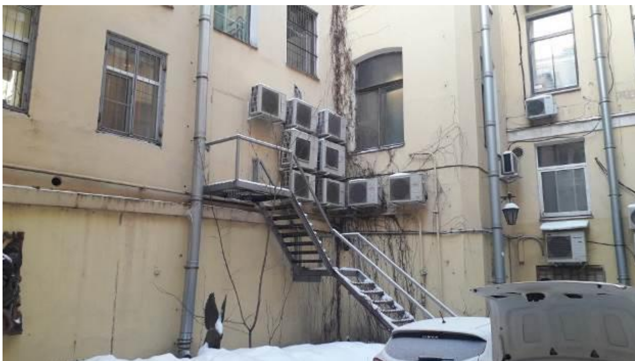
16. Дом А.И. Трейберга. Невский пр., д. 11/2, лит. А. Дворовые фасады. Фото мест установки оборудования и кабельных трасс. Штиглиц М.С. 10.01.2022..
