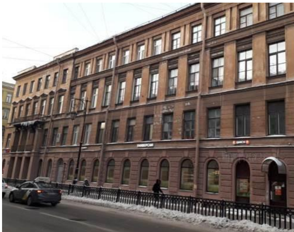
10. Дом А.Х. Пеля. Моховая ул., д. 22, лит. А. Лицевой фасад. Фото мест установки оборудования и кабельных трасс. Штиглиц М.С. 10.01.2022.
