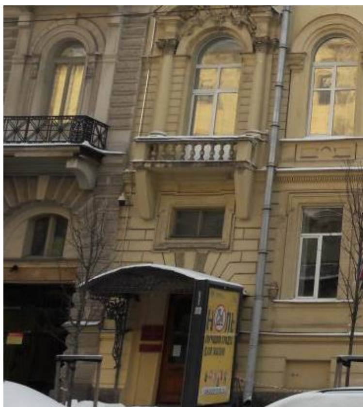
32. Особняк и дом А.К. Кольмана. Чайковского ул., д. 53, лит. А. Лицевой фасад. Фото мест установки оборудования и кабельных трасс. Штиглиц М.С. 10.01.2022.
