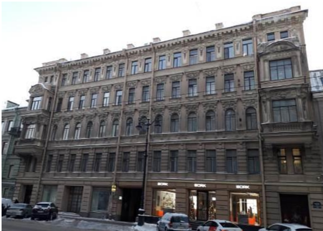
17. Дом Д.И. Тырлова. Невский пр., д. 119, литера А. Лицевой фасад. Фото мест установки оборудования и кабельных трасс. Штиглиц М.С. 10.01.2022.
