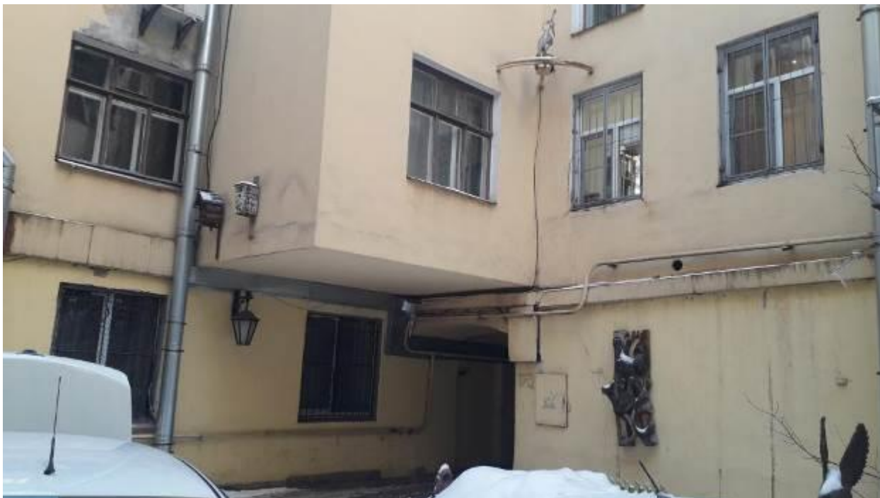
15. Дом А.И. Трейберга. Невский пр., д. 11/2, лит. А. Дворовые фасады. Фото мест установки оборудования и кабельных трасс. Штиглиц М.С. 10.01.2022.
