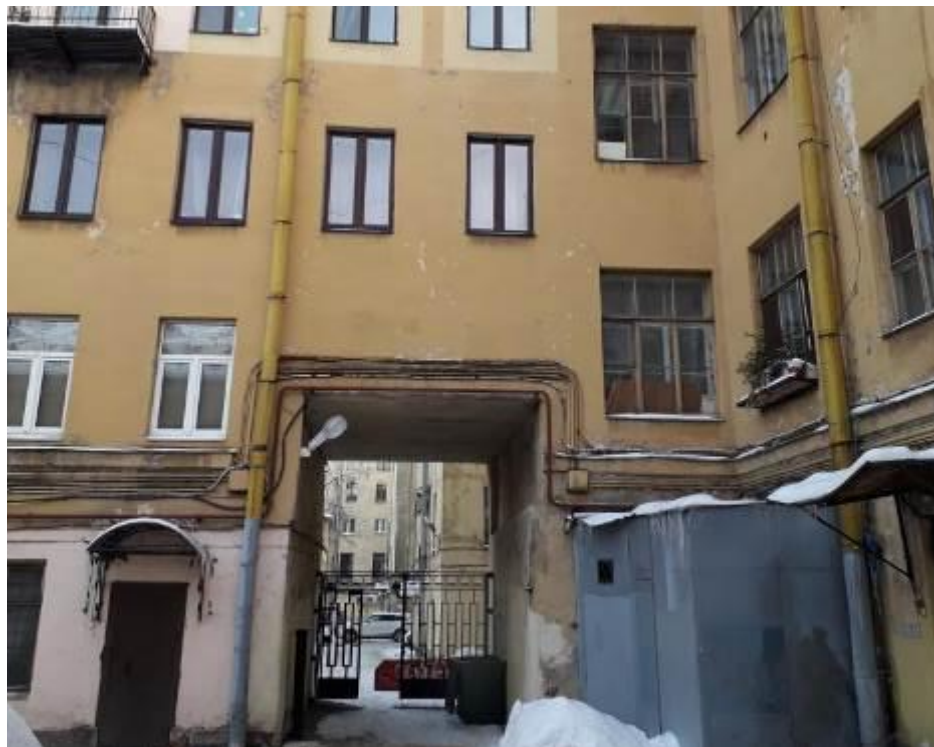
11. Дом А.Х. Пеля. Моховая ул., д. 22, лит. А. Дворовые фасады. Фото мест установки оборудования и кабельных трасс. Штиглиц М.С. 10.01.2022.
