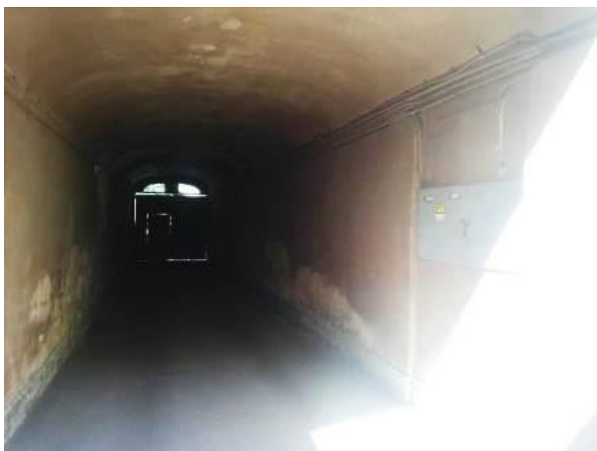
34. Особняк и дом А.К. Кольмана. Чайковского ул., д. 53, лит. А. Арочный проезд. Фото мест установки оборудования и кабельных трасс. Штиглиц М.С. 10.01.2022.
