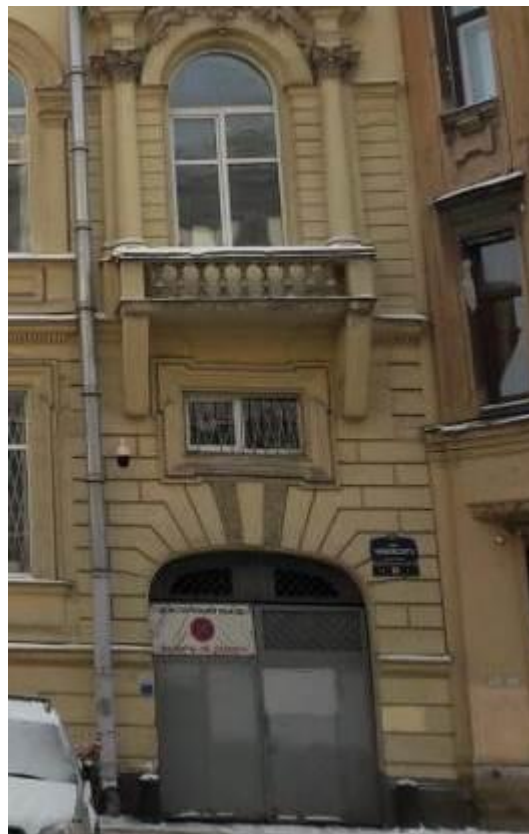
33. Особняк и дом А.К. Кольмана. Чайковского ул., д. 53, лит. А. Лицевой фасад. Фото мест установки оборудования и кабельных трасс. Штиглиц М.С. 10.01.2022.
