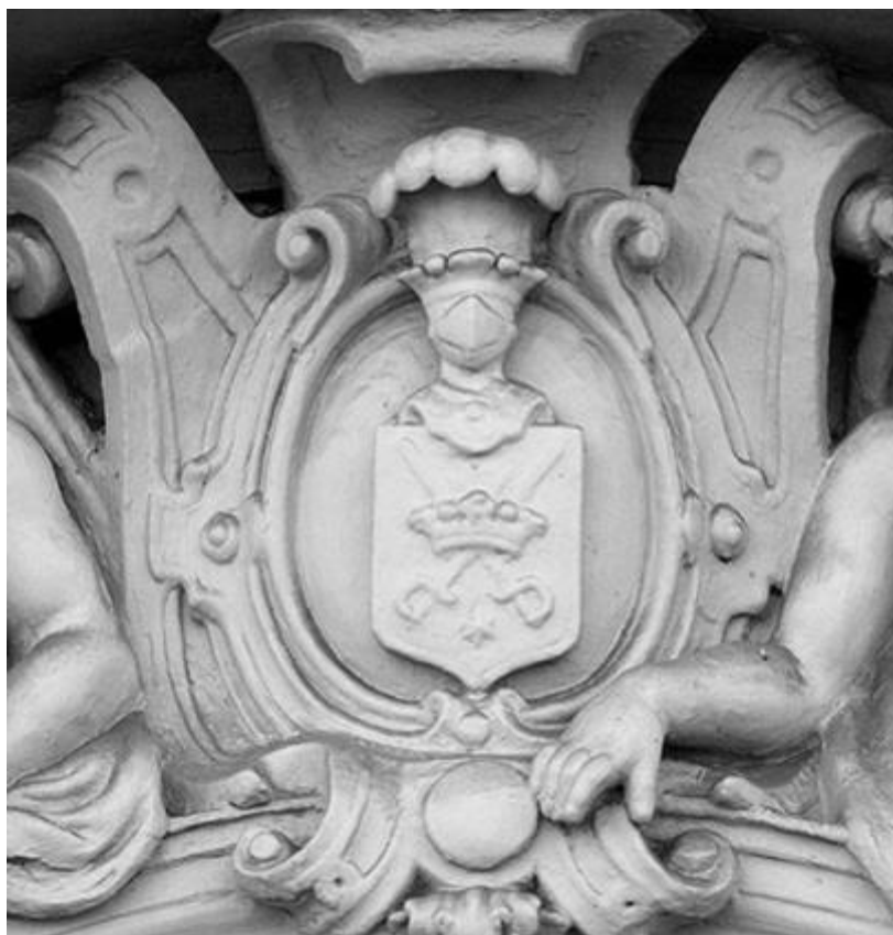
52. Особняк А.К.Кольмана. Чайковского ул., д. 53, лит. А. Фото 2008. (25).
