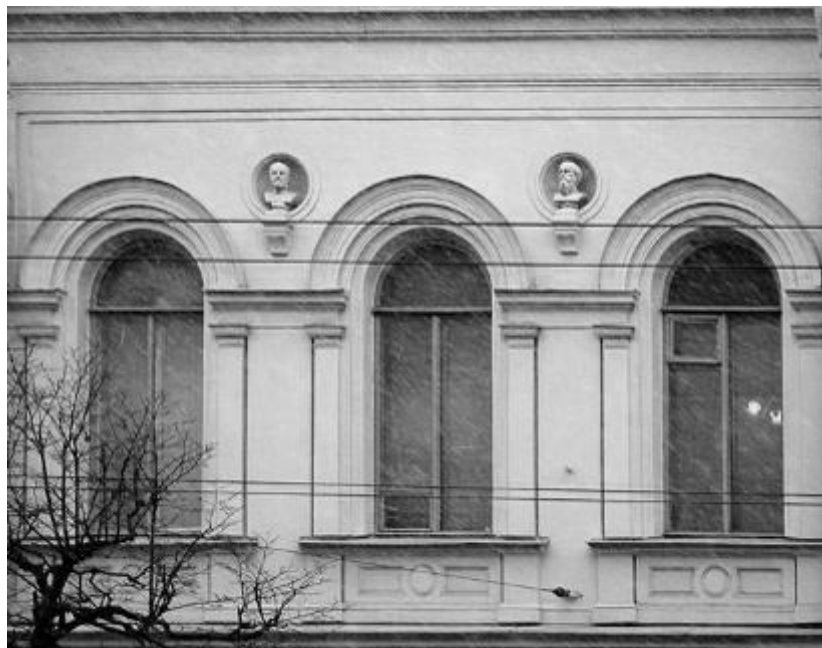
51. Особняк А.К.Кольмана. Чайковского ул., д. 53, лит. А. Фото 2008. (25).
