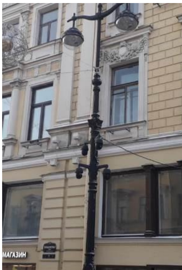
4. Дом С.М. Тедески (П.А. Зубова). Большая Морская ул., д. 7, лит. А. Лицевой фасад. Фото мест установки оборудования и кабельных трасс. Штиглиц М.С. 10.01.2022.
