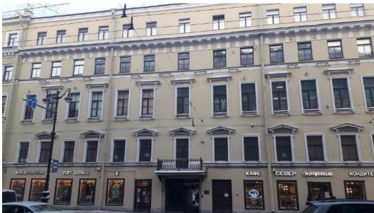
22. Дом Таля. Невский пр., д. 6, лит. А. Лицевой фасад. Фото мест установки оборудования и кабельных трасс. Штиглиц М.С. 10.01.2022.
