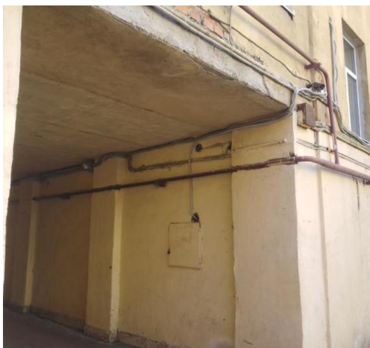
8. Дом К.К. Фелейзена (гостиница «Франция»). Большая Морская ул., д. 6, лит. А. Арочный проезд. Фото мест установки оборудования и кабельных трасс. Штиглиц М.С. 10.01.2022.
