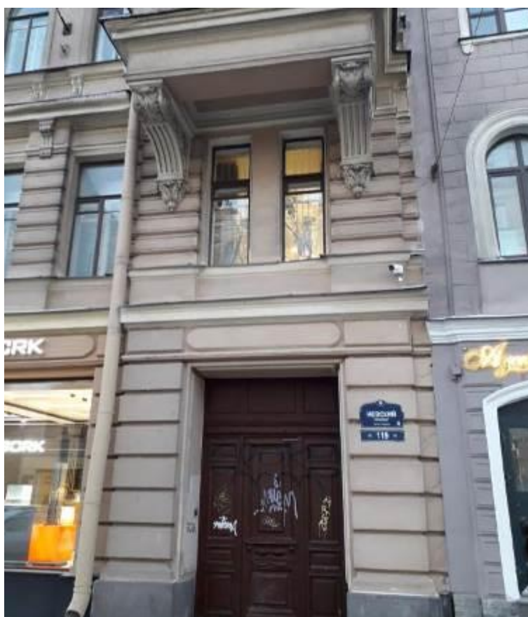
18. Дом Д.И. Тырлова. Невский пр., д. 119, литера А. Лицевой фасад. Фото мест установки оборудования и кабельных трасс. Штиглиц М.С. 10.01.2022.
