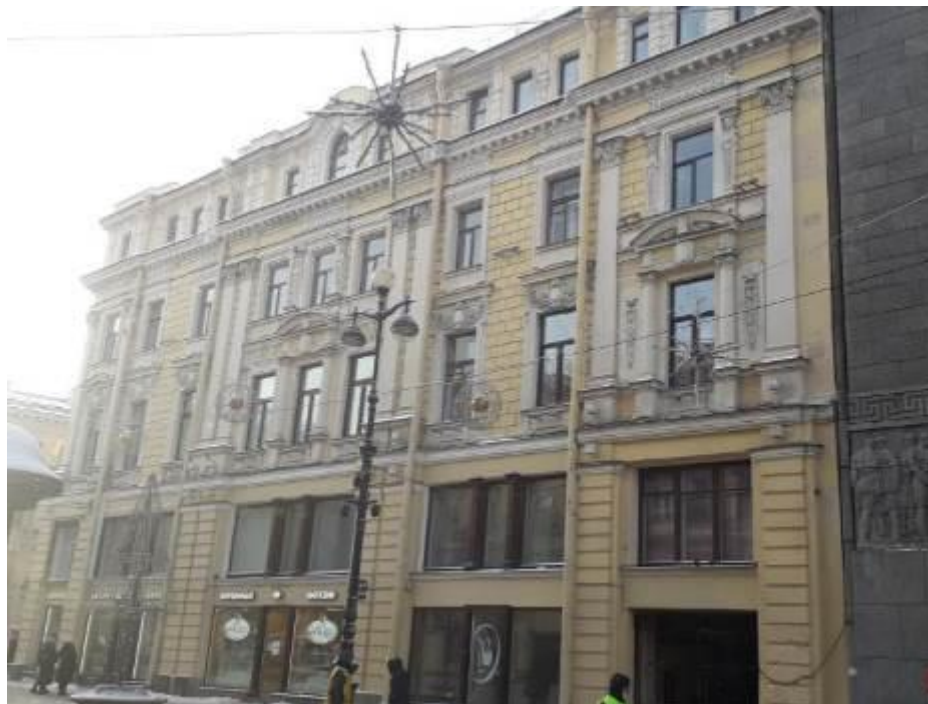
3. Дом С.М. Тедески (П.А. Зубова). Большая Морская ул., д. 7, лит. А. Лицевой фасад. Фото мест установки оборудования и кабельных трасс. Штиглиц М.С. 10.01.2022.
