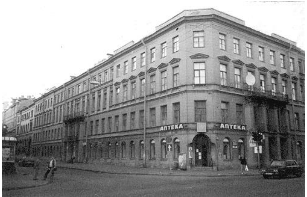
23. Дом А.Х. Пеля. Моховая ул., д. 22, лит. А. Фото 1999 г. (20).
