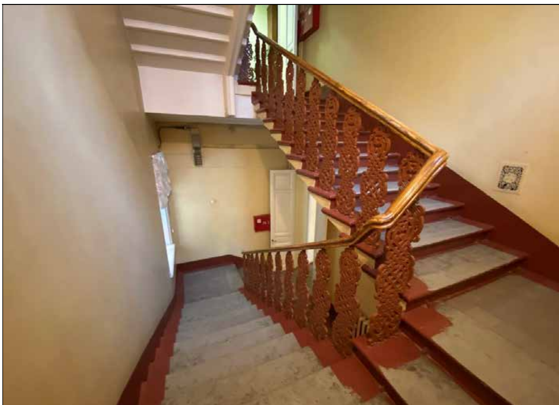
212. Объект культурного наследия регионального значения «Дом, в котором в 1902-1929 и 1933-1936 годах жил историк Н.П. Лихачев». Парадная лестница Л-1 (помещение IV). Лестничные марши 1-го и 2-го этажей. 16.01.2022 г.
