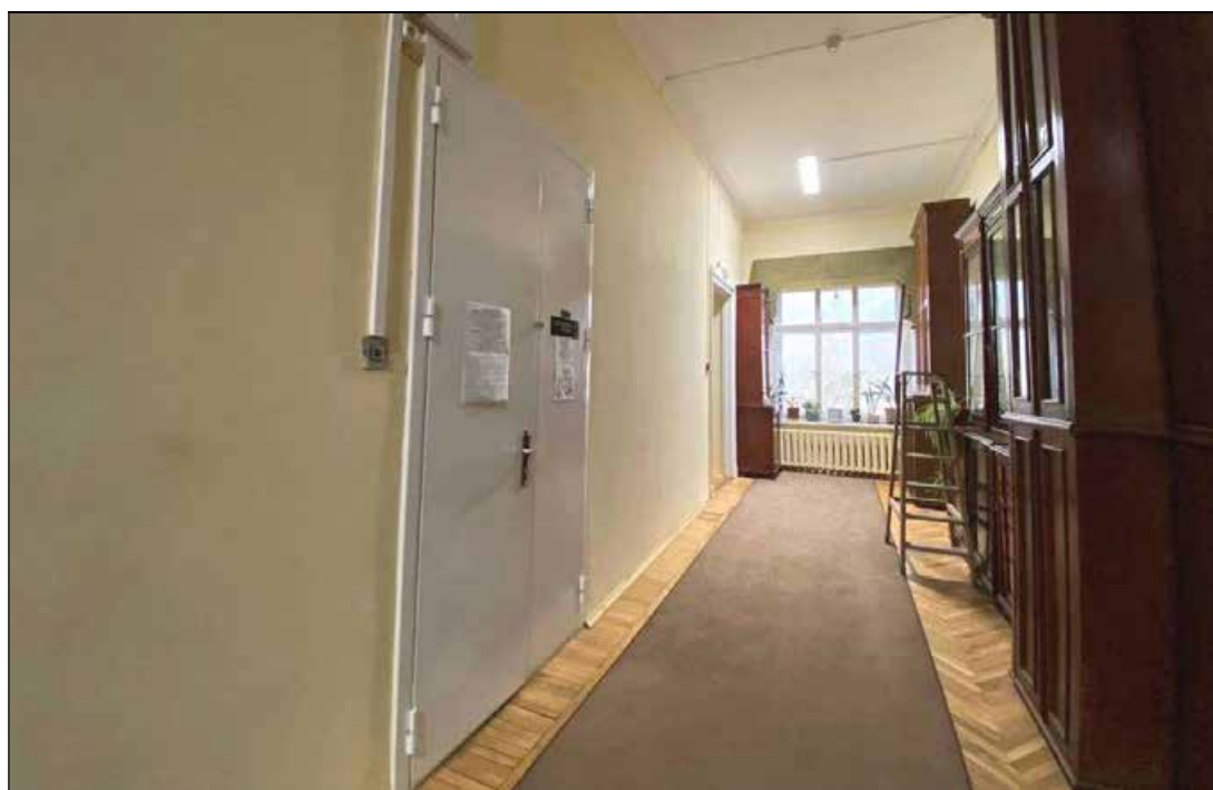
169. Объект культурного наследия регионального значения «Дом, в котором в 1902-1929 и 1933-1936 годах жил историк Н.П. Лихачев». 3-й этаж. Западная часть коридора (помещение № 1). Вход в помещение № 18. 16.01.2022 г.
