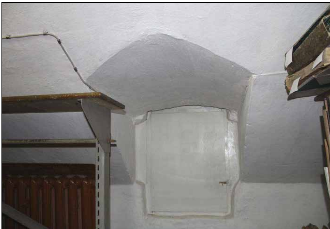
59. Объект культурного наследия регионального значения «Дом, в котором в 1902-1929 и 1933-1936 годах жил историк Н.П. Лихачев». Цокольный этаж. Помещение № 8. Оконный проем. 16.01.2022 г.
