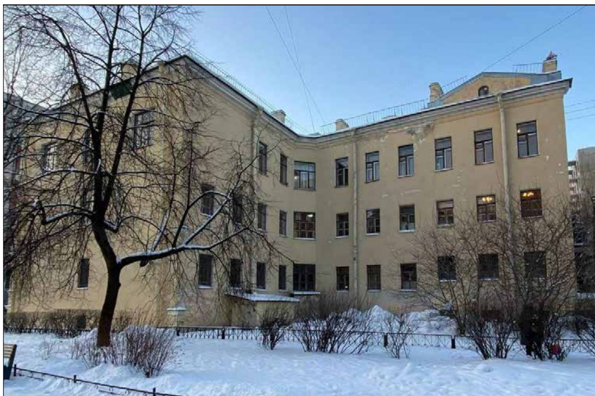
22. Объект культурного наследия регионального значения «Дом, в котором в 1902-1929 и 1933-1936 годах жил историк Н.П. Лихачев». Дворовые фасады. Вид на запад. 16.01.2022 г.
