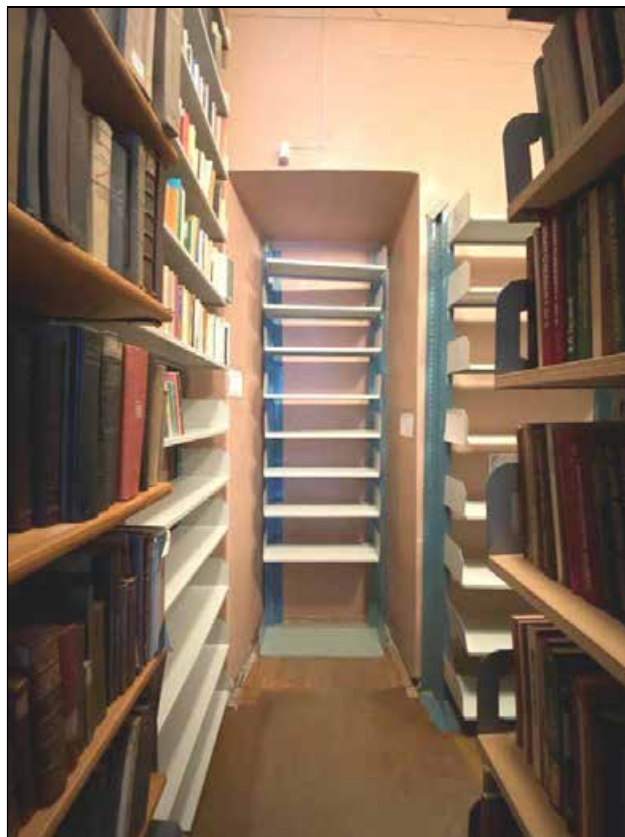
147. Объект культурного наследия регионального значения «Дом, в котором в 1902-1929 и 1933-1936 годах жил историк Н.П. Лихачев». 2-й этаж. Ниша в северо-восточной части помещения № 3. 16.01.2022 г.
