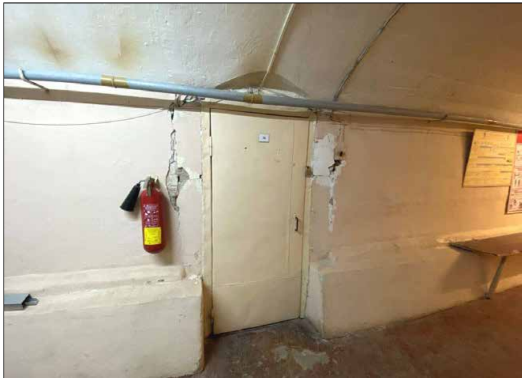
42. Объект культурного наследия регионального значения «Дом, в котором в 1902-1929 и 1933-1936 годах жил историк Н.П. Лихачев». Цокольный этаж. Помещение № 2 (коридор). Вход в помещение № 12. 16.01.2022 г.
