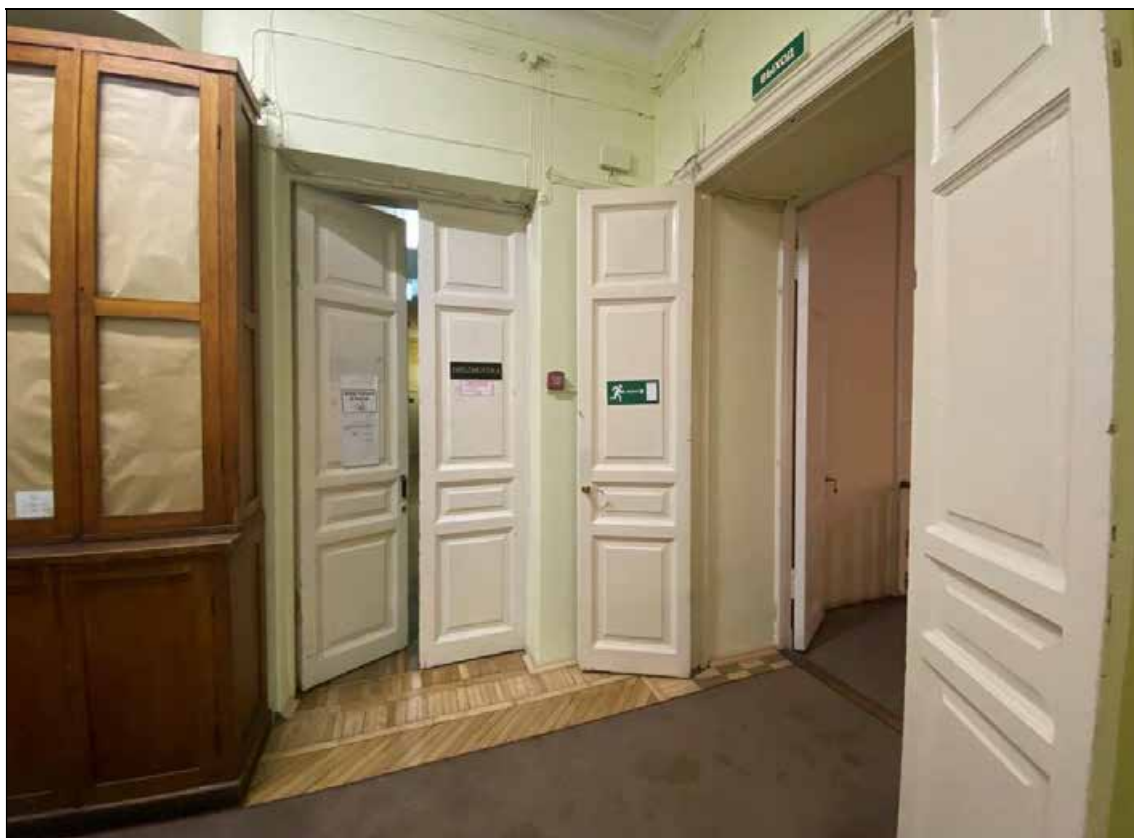
75. Объект культурного наследия регионального значения «Дом, в котором в 1902-1929 и 1933-1936 годах жил историк Н.П. Лихачев». 1-й этаж. Помещение № 1 (коридор). Дверные проемы в вестибюль и помещение № 21. 16.01.2022 г.
