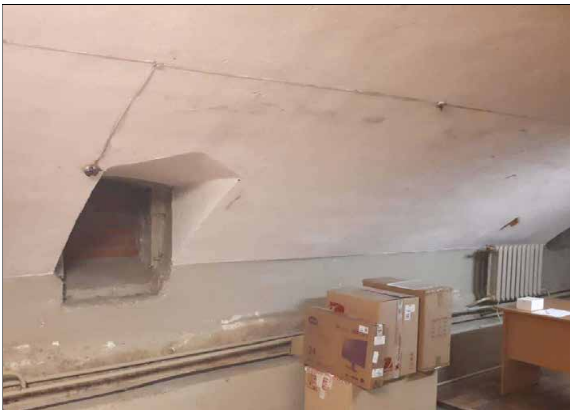
55. Объект культурного наследия регионального значения «Дом, в котором в 1902-1929 и 1933-1936 годах жил историк Н.П. Лихачев». Цокольный этаж. Помещение № 7. Оконный проем. 16.01.2022 г.
