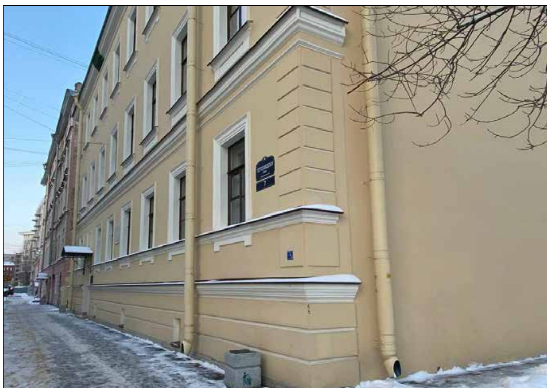
5. Объект культурного наследия регионального значения «Дом, в котором в 1902-1929 и 1933-1936 годах жил историк Н.П. Лихачев». Фрагмент лицевого фасада. Ленточный руст цокольного этажа и юго-восточного угла здания. Вид на северо-запад. 16.01.2022 г.
