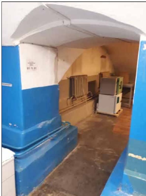
50. Объект культурного наследия регионального значения «Дом, в котором в 1902-1929 и 1933-1936 годах жил историк Н.П. Лихачев». Цокольный этаж. Восточная часть помещения № 6. Вход в помещение № 7. 16.01.2022 г.
