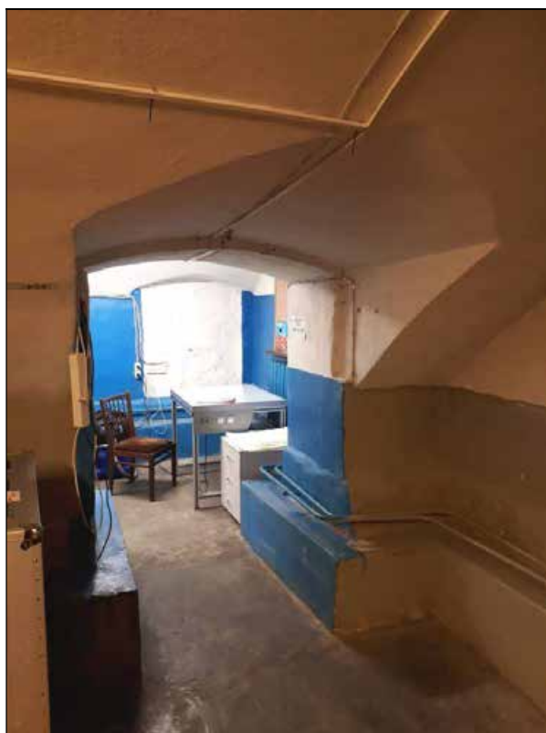
56. Объект культурного наследия регионального значения «Дом, в котором в 1902-1929 и 1933-1936 годах жил историк Н.П. Лихачев». Цокольный этаж. Помещение № 7. Дверной проем. 16.01.2022 г.
