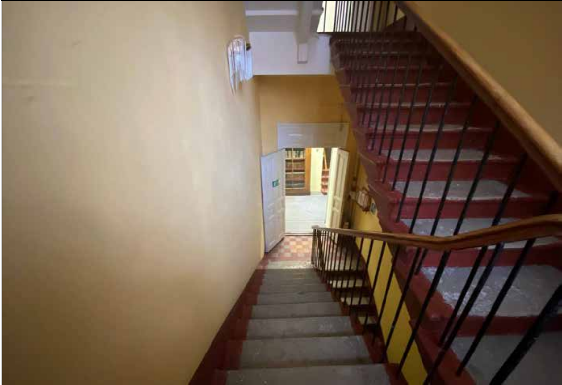
218. Объект культурного наследия регионального значения «Дом, в котором в 1902-1929 и 1933-1936 годах жил историк Н.П. Лихачев». Лестница Л-2 (помещение II). Лестничные марши 2-го этажа. 16.01.2022 г.
