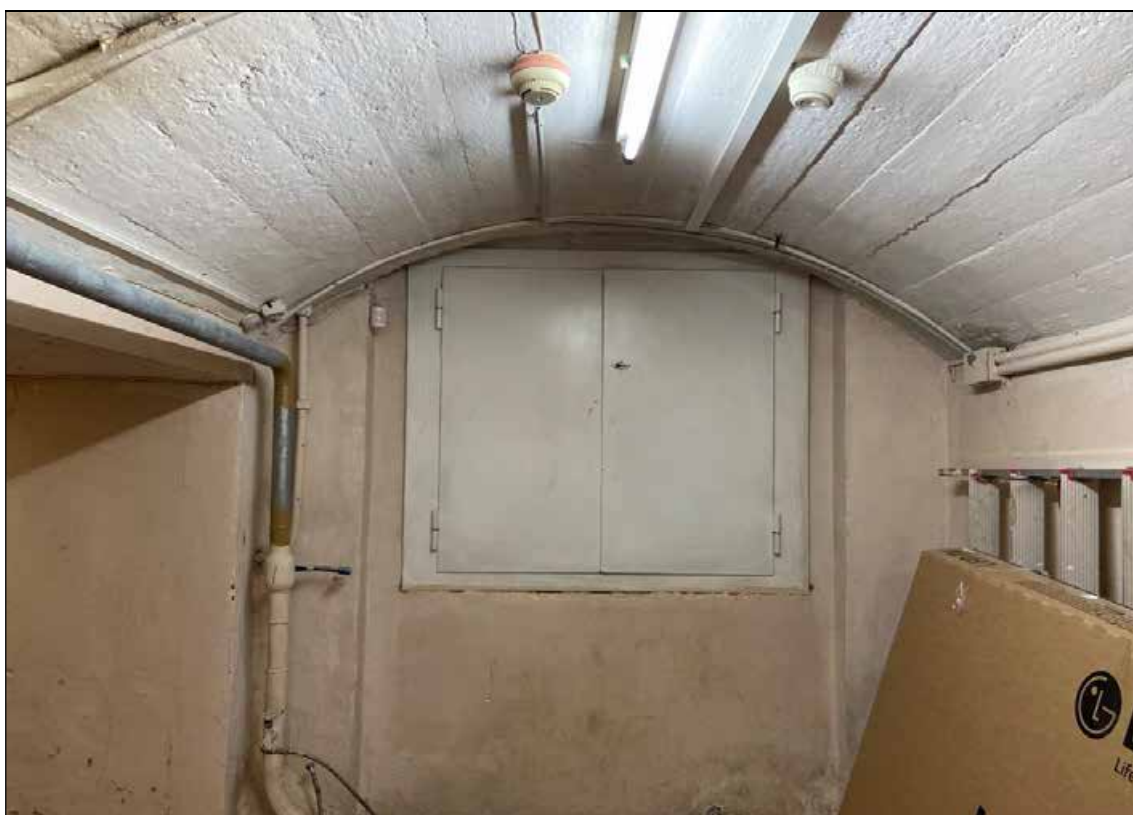
36. Объект культурного наследия регионального значения «Дом, в котором в 1902-1929 и 1933-1936 годах жил историк Н.П. Лихачев». Цокольный этаж. Оконный проем в северной части коридора (помещение № 1). 16.01.2022 г.
