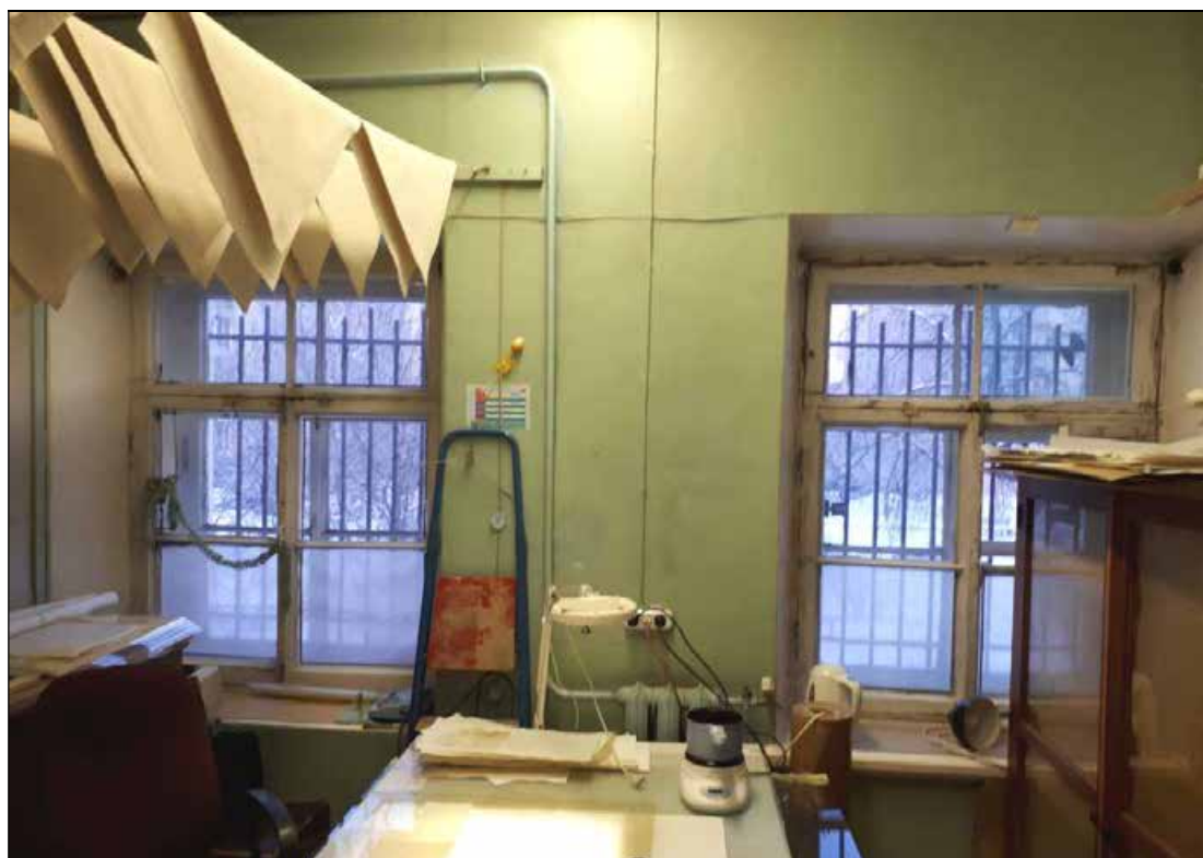
94. Объект культурного наследия регионального значения «Дом, в котором в 1902-1929 и 1933-1936 годах жил историк Н.П. Лихачев». 1-й этаж. Помещение № 8. 16.01.2022 г.
