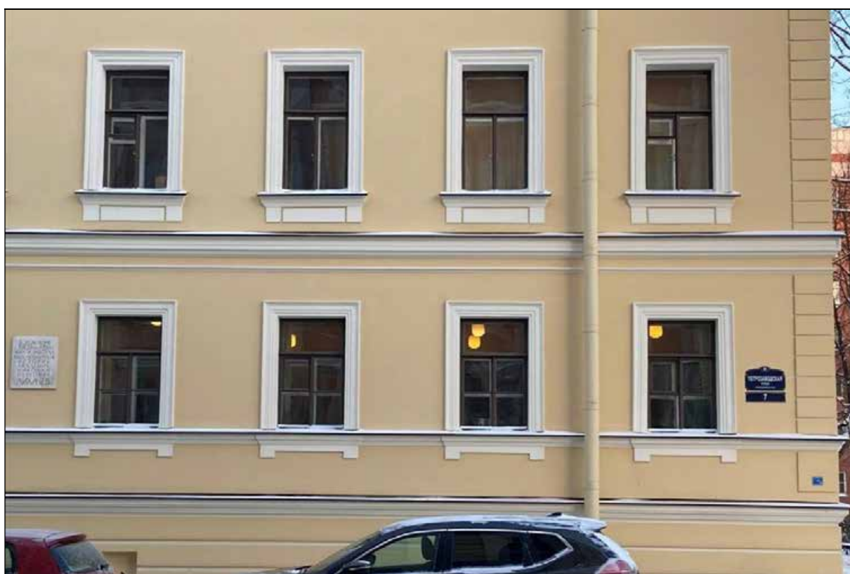
9. Объект культурного наследия регионального значения «Дом, в котором в 1902-1929 и 1933-1936 годах жил историк Н.П. Лихачев». Фрагмент лицевого фасада. Оконные проемы 1-го и 2-го этажей. 16.01.2022 г.
