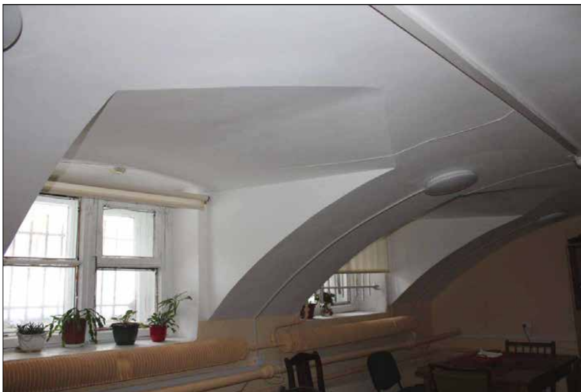
51. Объект культурного наследия регионального значения «Дом, в котором в 1902-1929 и 1933-1936 годах жил историк Н.П. Лихачев». Цокольный этаж. Помещение № 3. Оконные проемы. 16.01.2022 г.
