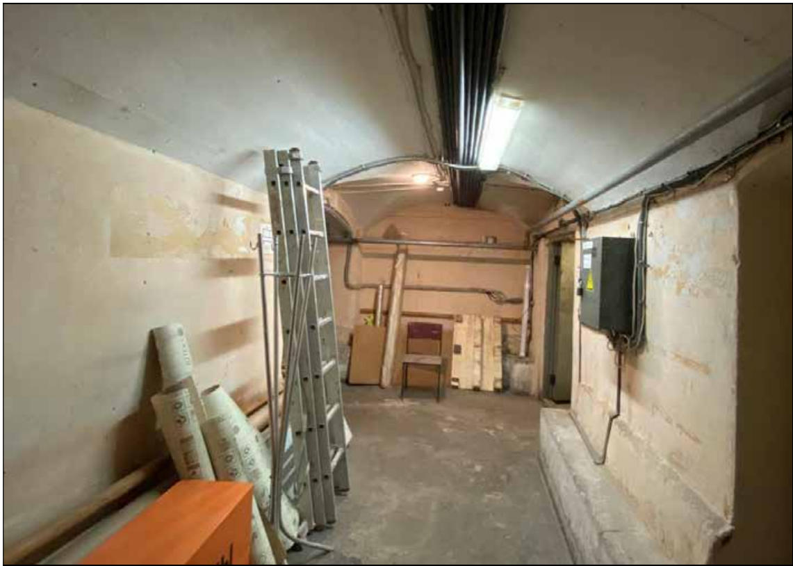
45. Объект культурного наследия регионального значения «Дом, в котором в 1902-1929 и 1933-1936 годах жил историк Н.П. Лихачев». Цокольный этаж. Западная часть помещения № 6 (коридор). 16.01.2022 г.
