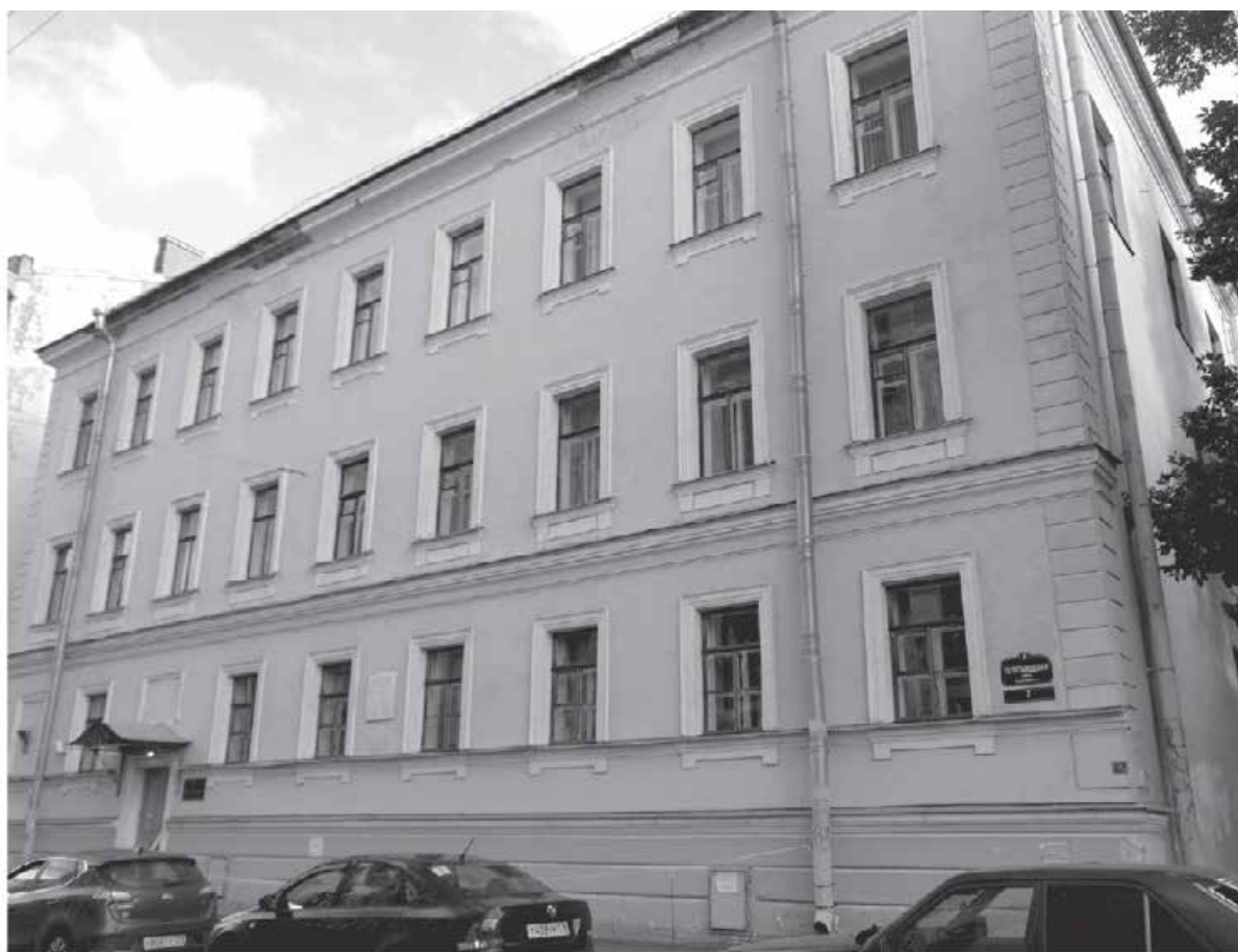
Илл. 34. Фасад по Петрозаводской ул. 2017 г. // Панченко Е. З. Дом Н. П. Лихачева (Петрозаводская, 7) Фонтанка. Культурно-исторический альманах. 2017. № 22. С. 6-20
