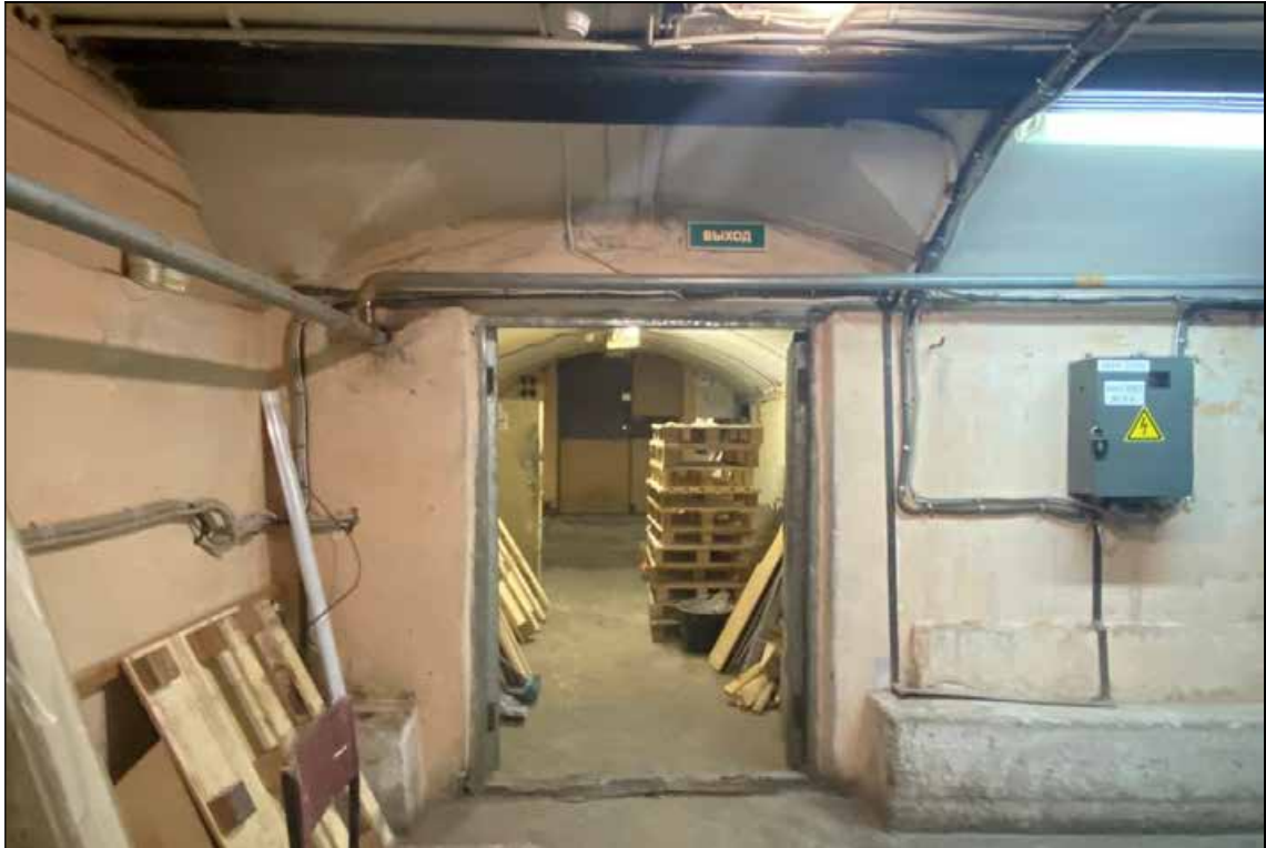
46. Объект культурного наследия регионального значения «Дом, в котором в 1902-1929 и 1933-1936 годах жил историк Н.П. Лихачев». Цокольный этаж. Западная часть помещения № 6 (коридор). Вход в помещение № 10. 16.01.2022 г.
