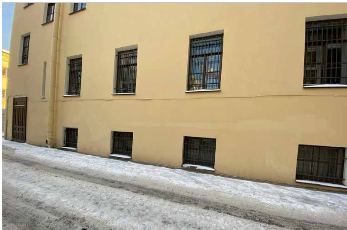
18. Объект культурного наследия регионального значения «Дом, в котором в 1902-1929 и 1933-1936 годах жил историк Н.П. Лихачев». Фрагмент западного торцевого фасада. Оконные проемы цокольного и 1-го этажей. 16.01.2022 г.
