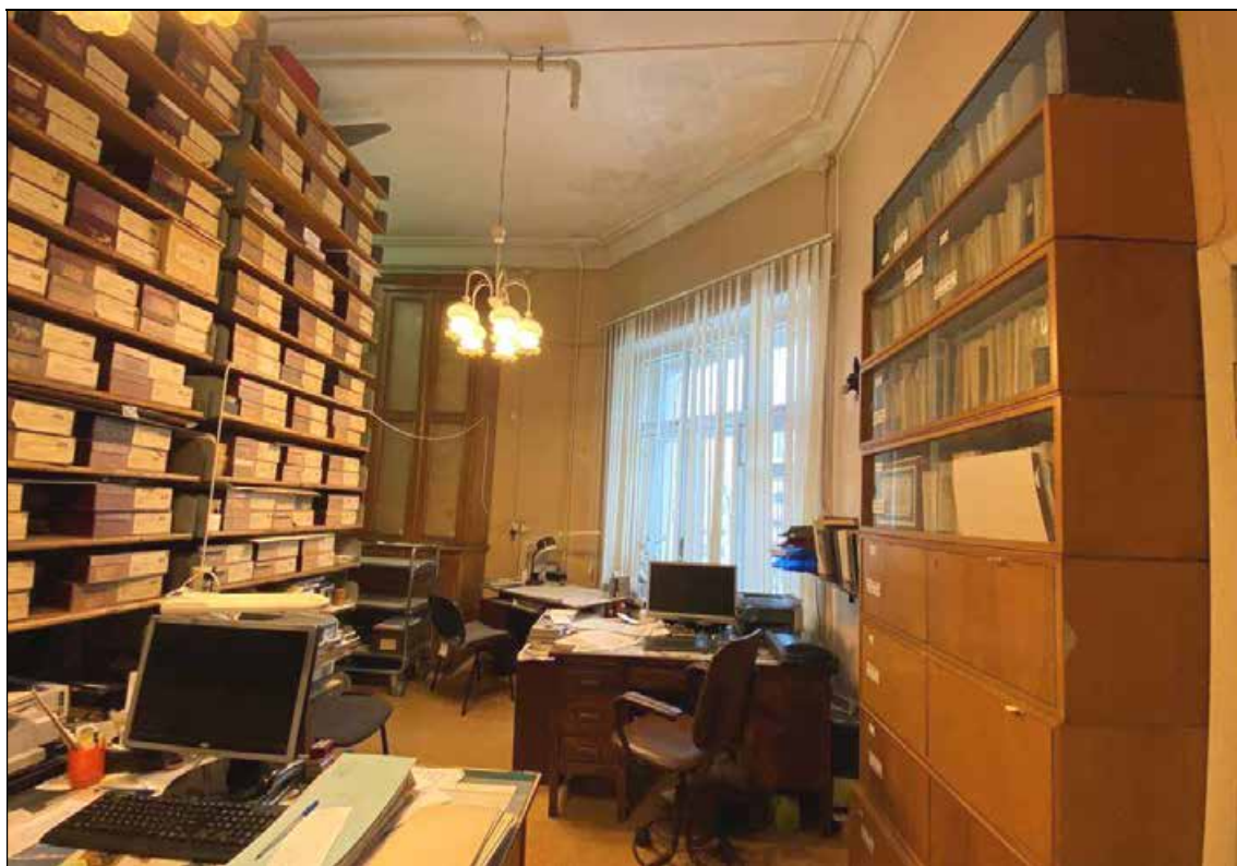
198. Объект культурного наследия регионального значения «Дом, в котором в 1902-1929 и 1933-1936 годах жил историк Н.П. Лихачев». 3-й этаж. Восточная часть помещения № 8. 16.01.2022 г.
