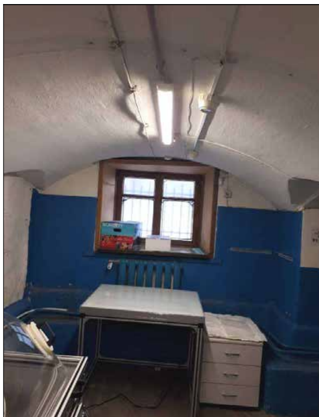
49. Объект культурного наследия регионального значения «Дом, в котором в 1902-1929 и 1933-1936 годах жил историк Н.П. Лихачев». Цокольный этаж. Оконный проем в восточной части коридора (помещение № 6). 16.01.2022 г.
