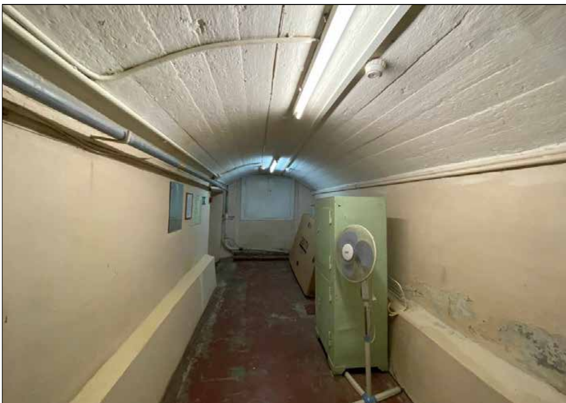
35. Объект культурного наследия регионального значения «Дом, в котором в 1902-1929 и 1933-1936 годах жил историк Н.П. Лихачев». Цокольный этаж. Помещение № 1 (коридор). Вид от входа в помещение № 14. 16.01.2022 г.
