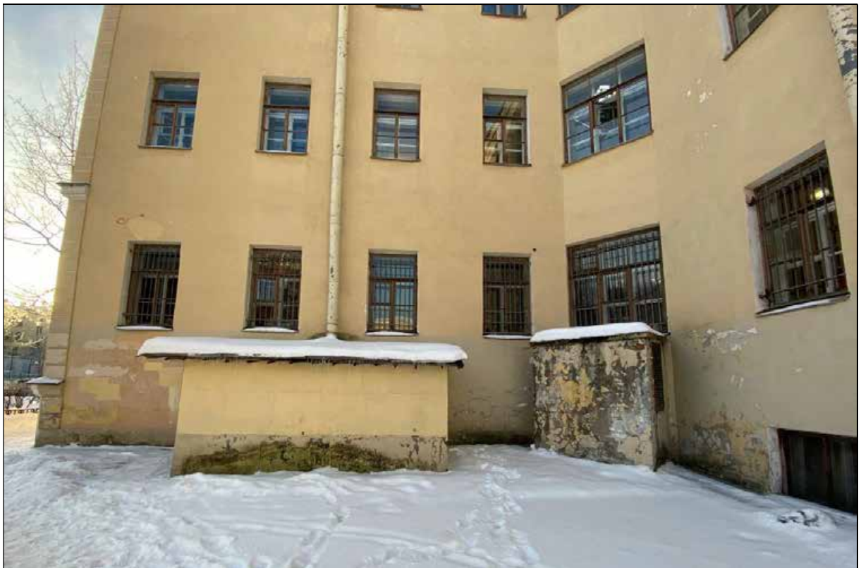
26. Объект культурного наследия регионального значения «Дом, в котором в 1902-1929 и 1933-1936 годах жил историк Н.П. Лихачев». Фрагмент северного дворового фасада. Оконные проемы 1-го и 2-го этажей. 16.01.2022 г.
