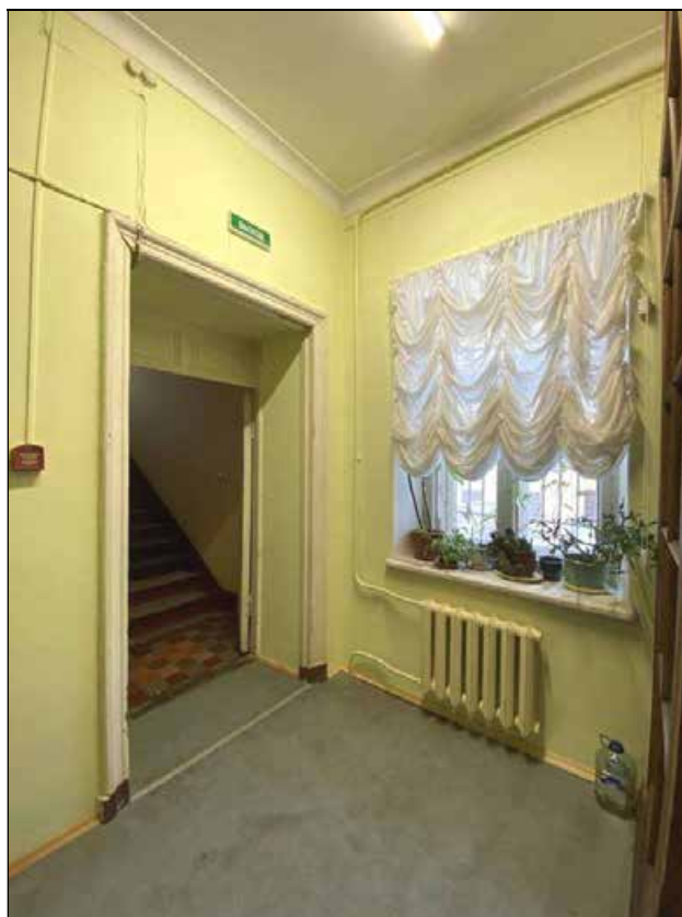
81. Объект культурного наследия регионального значения «Дом, в котором в 1902-1929 и 1933-1936 годах жил историк Н.П. Лихачев». 1-й этаж. Оконный проем в помещении № 6. Выход на лестницу Л-2. 16.01.2022 г.
