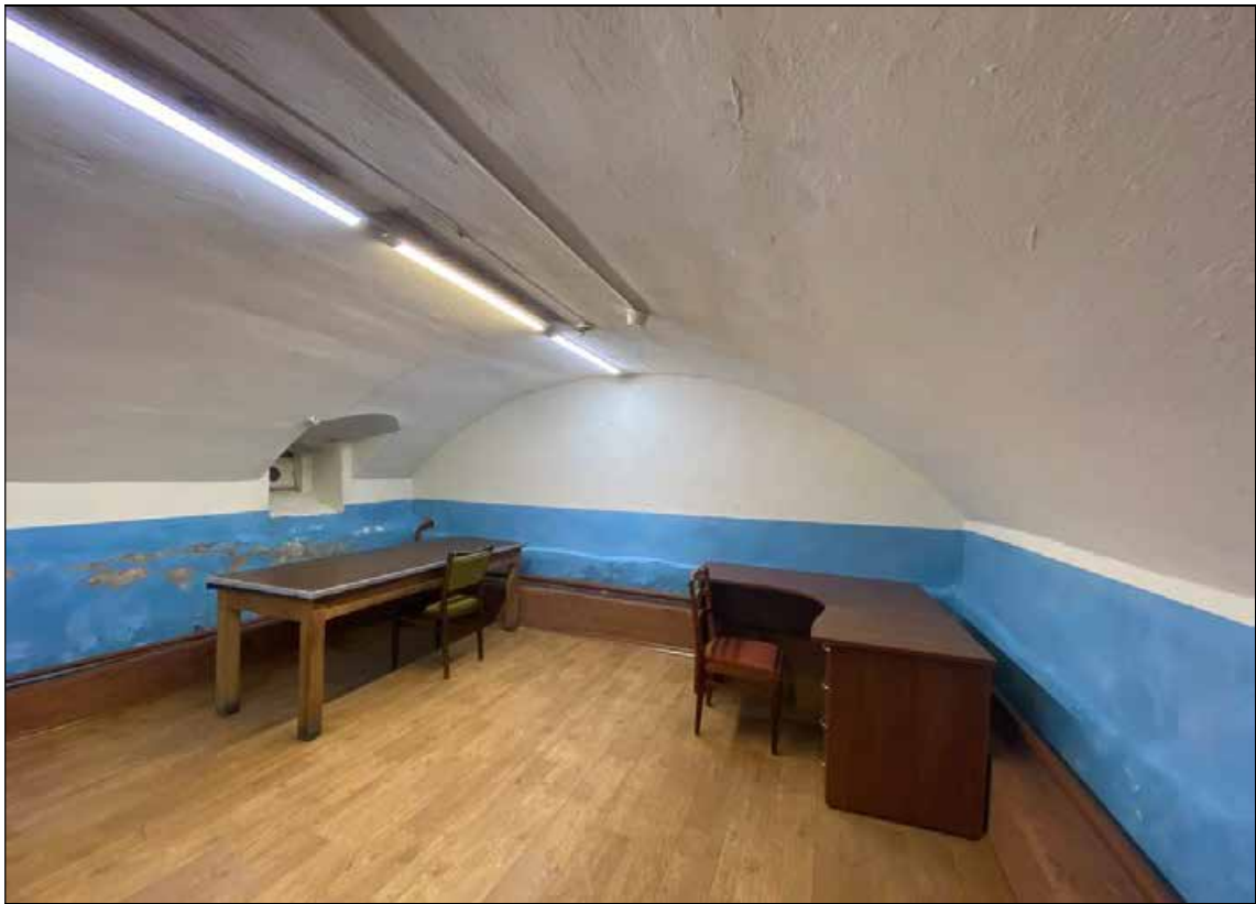
63. Объект культурного наследия регионального значения «Дом, в котором в 1902-1929 и 1933-1936 годах жил историк Н.П. Лихачев». Цокольный этаж. Северная часть помещения № 11. 16.01.2022 г.
