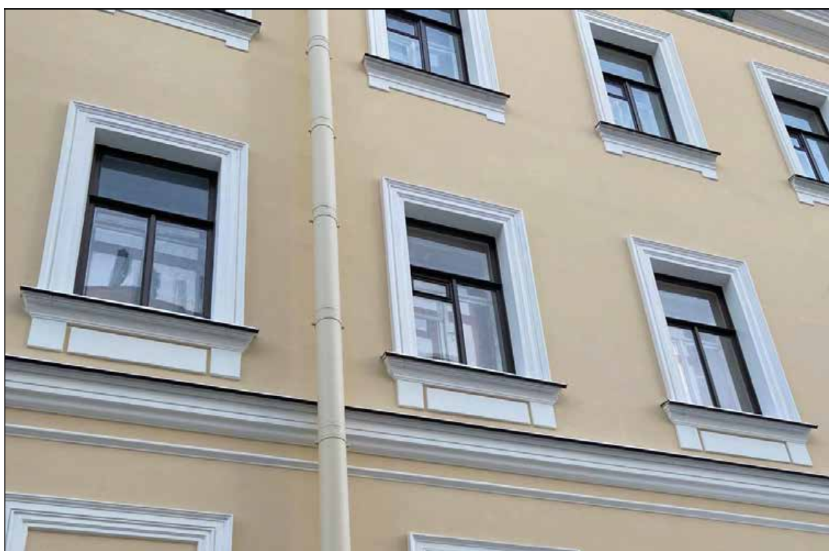
13. Объект культурного наследия регионального значения «Дом, в котором в 1902-1929 и 1933-1936 годах жил историк Н.П. Лихачев». Фрагмент лицевого фасада. Оконные проемы 2-го этажа. Междуэтажный карниз. 16.01.2022 г.
