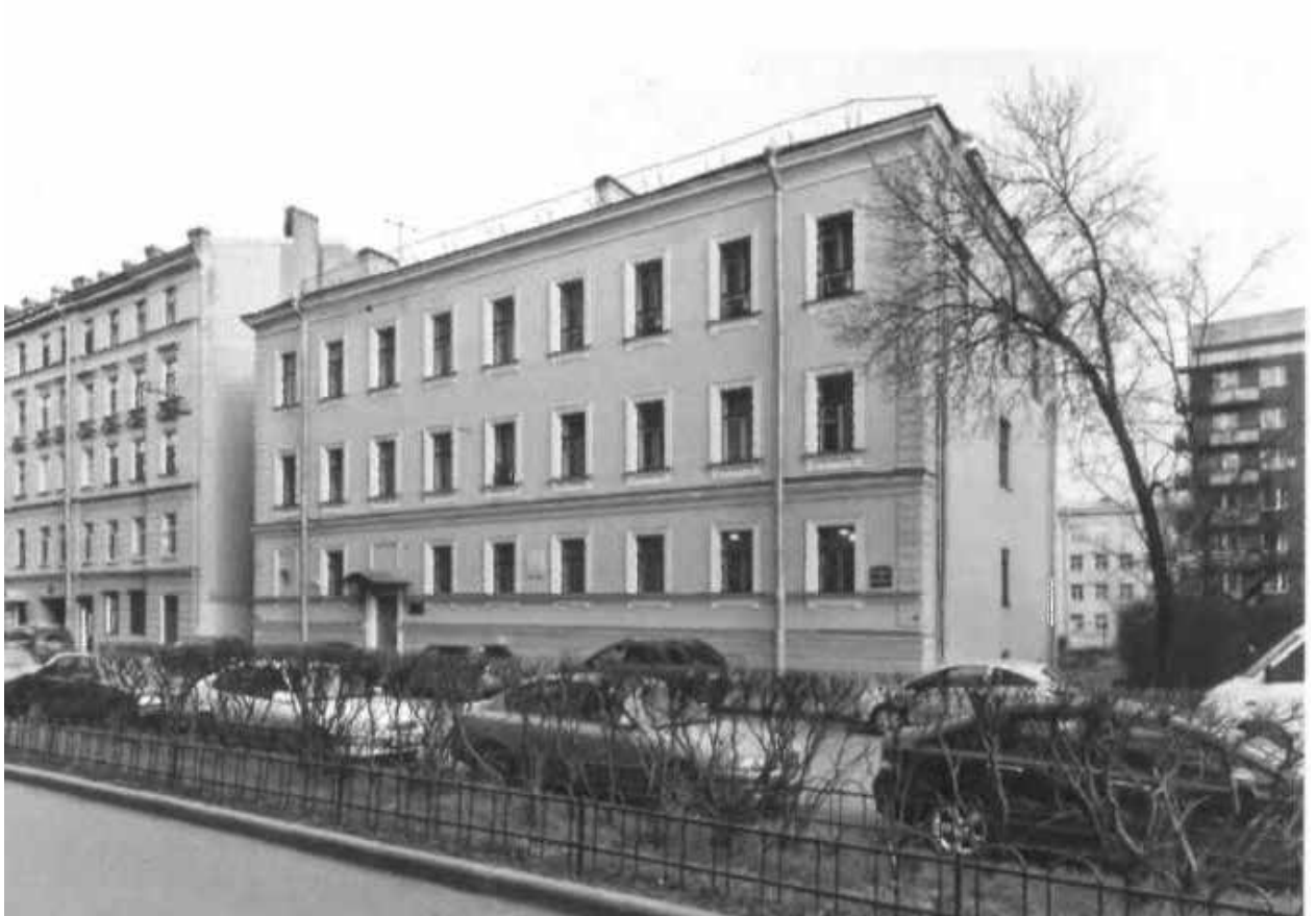
Илл. 33. Фасад по Петрозаводской ул. 2012 г. // Мещерская Е. Н., Пиотровская Е. К. Музей палеографии академика Н. П. Лихачева и его судьба (1925—1930) // «Звучат лишь письма...»: к 150-летию со дня рождения академика Н. П. Лихачева. СПб., 2012. С. 56-57.
