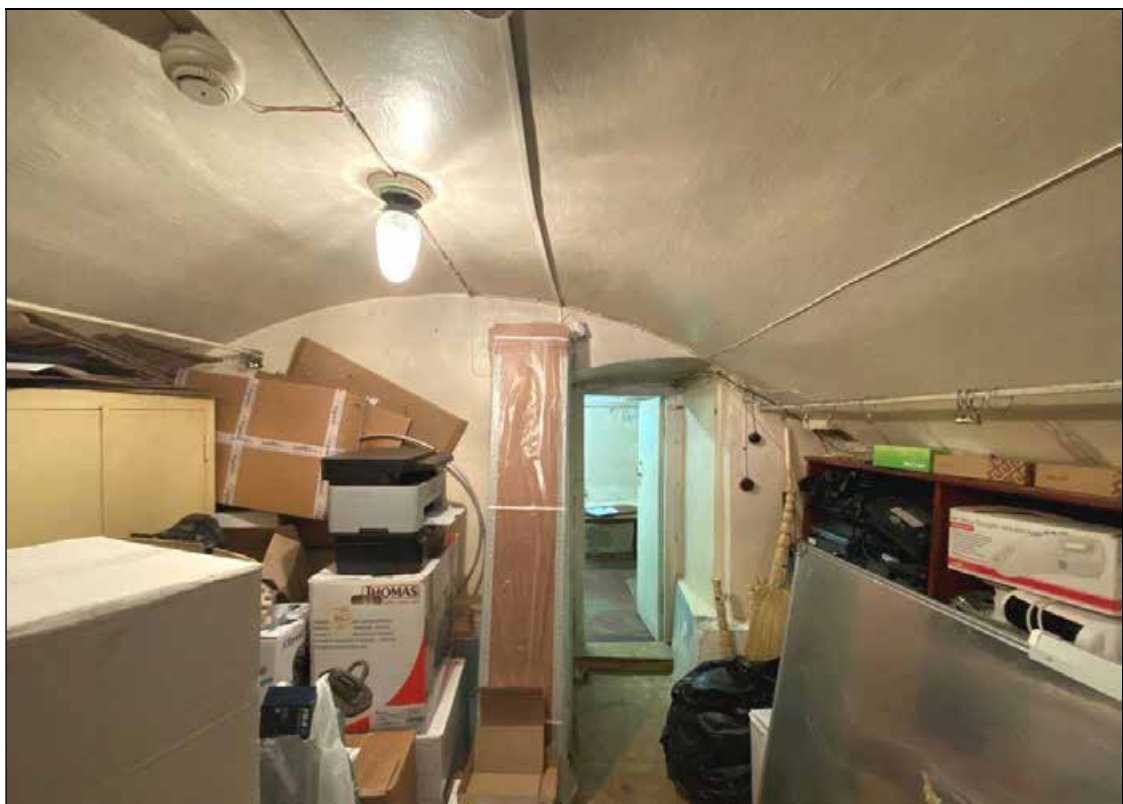
70. Объект культурного наследия регионального значения «Дом, в котором в 1902-1929 и 1933-1936 годах жил историк Н.П. Лихачев». Цокольный этаж. Восточная часть помещения № 14. 16.01.2022 г.
