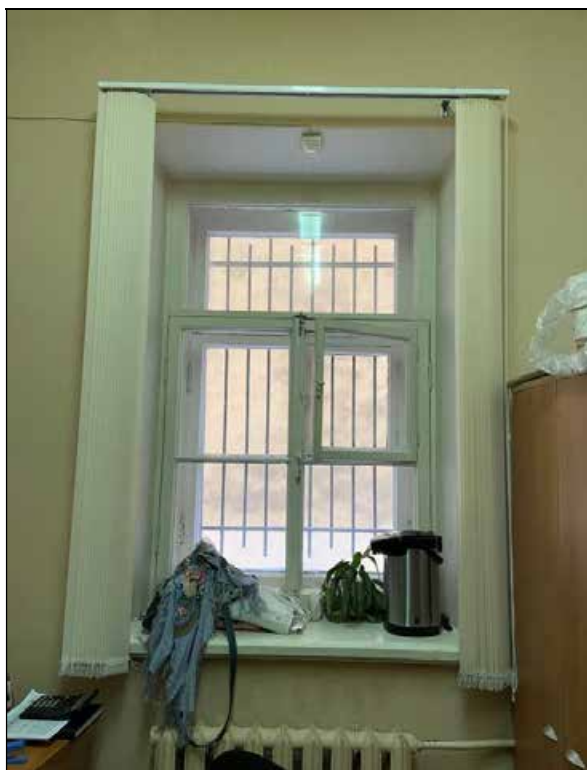
84. Объект культурного наследия регионального значения «Дом, в котором в 1902-1929 и 1933-1936 годах жил историк Н.П. Лихачев». 1-й этаж. Оконный проем в помещении № 2. 16.01.2022 г.
