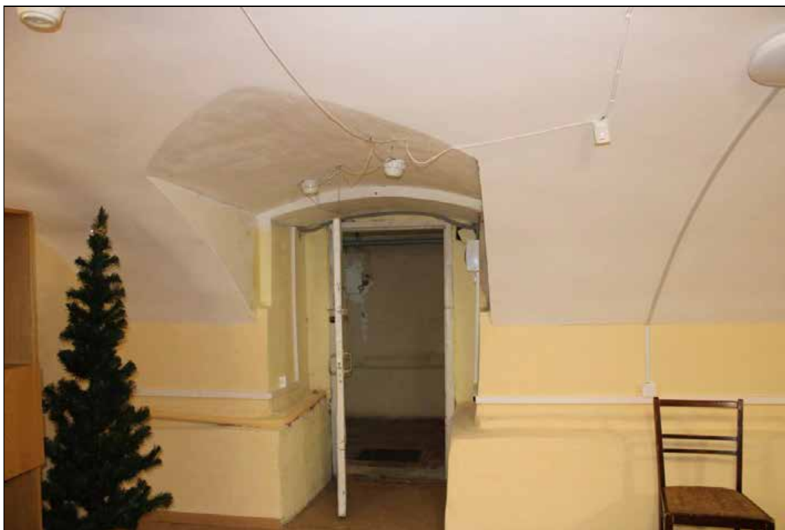
52. Объект культурного наследия регионального значения «Дом, в котором в 1902-1929 и 1933-1936 годах жил историк Н.П. Лихачев». Цокольный этаж. Помещение № 3. Дверной проем. 16.01.2022 г.
