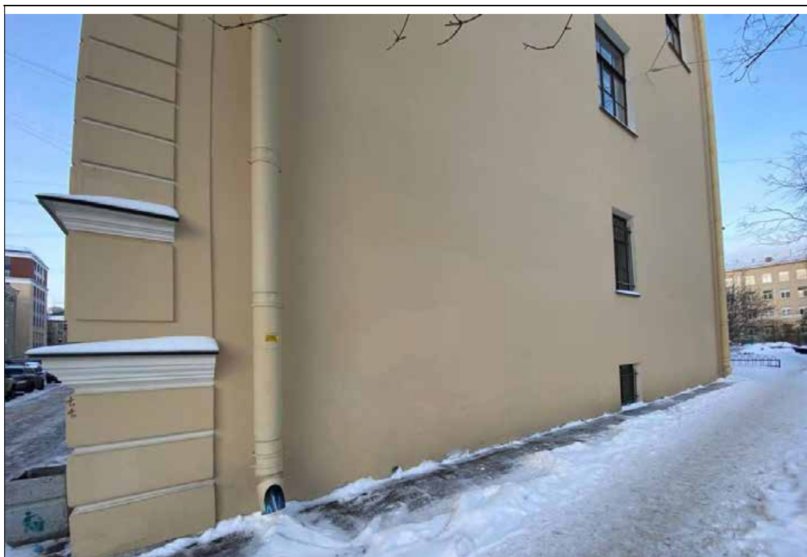
31. Объект культурного наследия регионального значения «Дом, в котором в 1902-1929 и 1933-1936 годах жил историк Н.П. Лихачев». Фрагмент восточного торцевого фасада. Вид на север. 16.01.2022 г.
