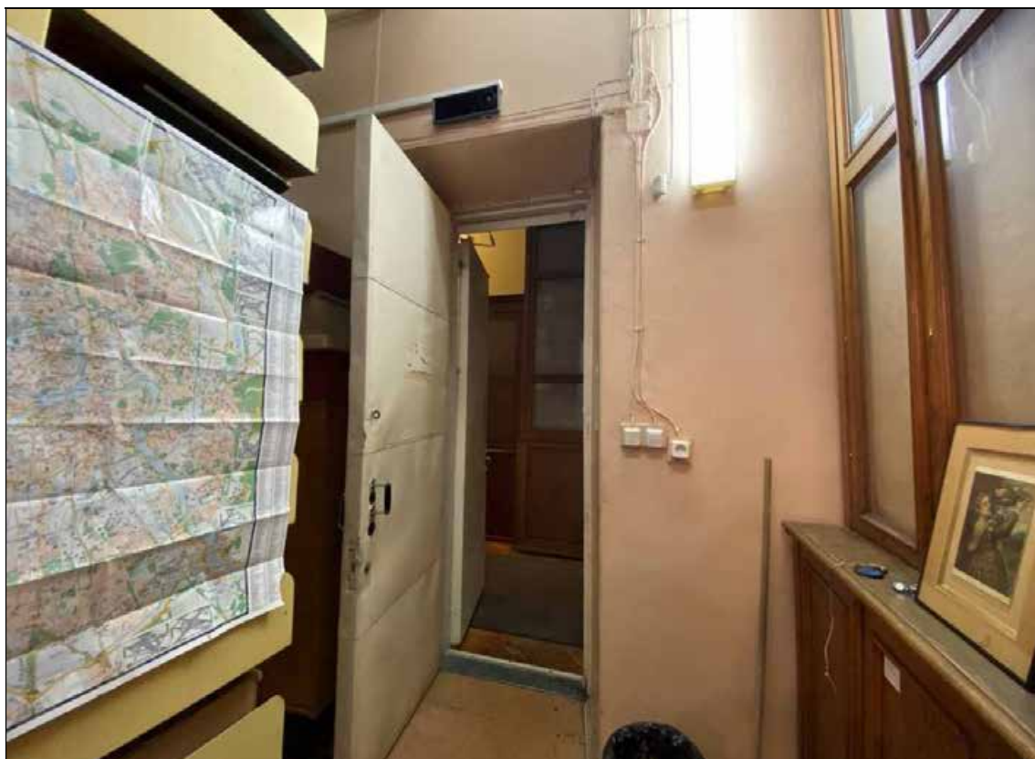
199. Объект культурного наследия регионального значения «Дом, в котором в 1902-1929 и 1933-1936 годах жил историк Н.П. Лихачев». 3-й этаж. Западная часть помещения № 8. Дверной проем. 16.01.2022 г.
