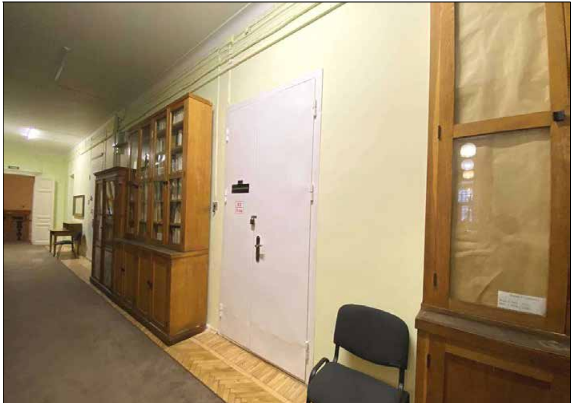
78. Объект культурного наследия регионального значения «Дом, в котором в 1902-1929 и 1933-1936 годах жил историк Н.П. Лихачев». 1-й этаж. Помещение № 1 (коридор). Вход в помещение № 4. 16.01.2022 г.
