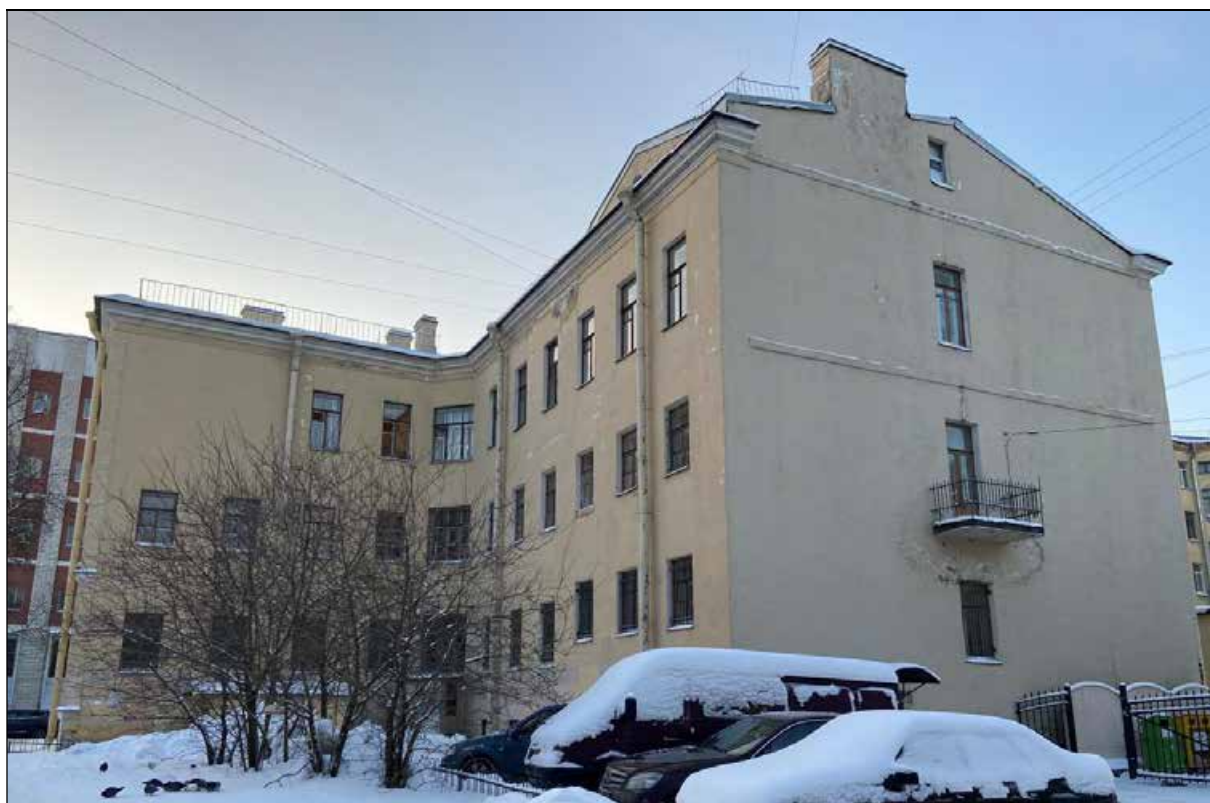
19. Объект культурного наследия регионального значения «Дом, в котором в 1902-1929 и 1933-1936 годах жил историк Н.П. Лихачев». Дворовые и северный торцевой фасады. Вид на юго-запад. 16.01.2022 г.
