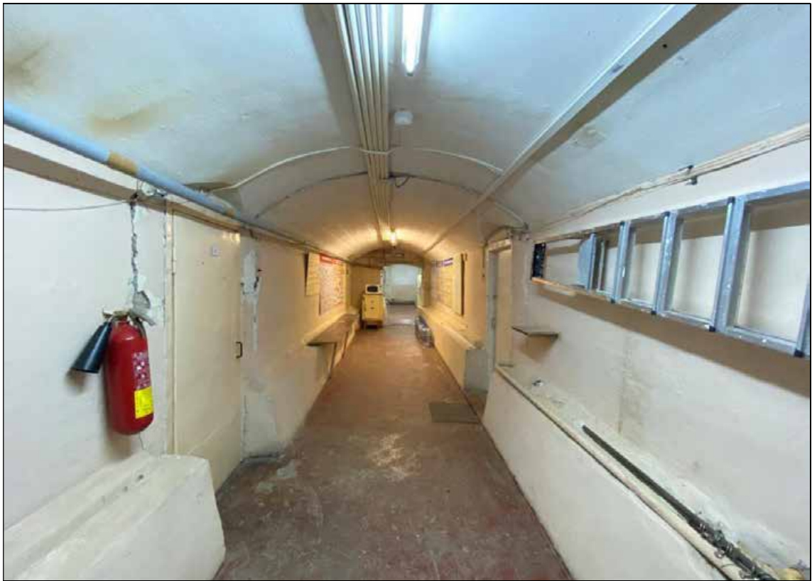
41. Объект культурного наследия регионального значения «Дом, в котором в 1902-1929 и 1933-1936 годах жил историк Н.П. Лихачев». Цокольный этаж. Помещение № 2 (коридор). Вид от входа в помещение № 4. 16.01.2022 г.
