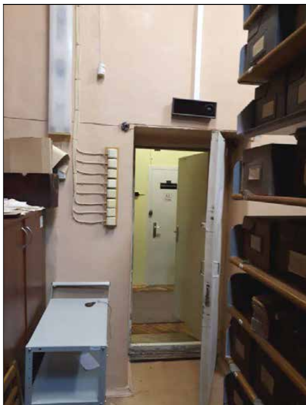
184. Объект культурного наследия регионального значения «Дом, в котором в 1902-1929 и 1933-1936 годах жил историк Н.П. Лихачев». 3-й этаж. Дверной проем в северо-восточной части помещения № 2. 16.01.2022 г.
