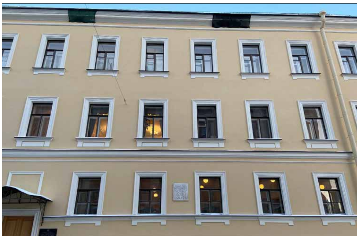
10. Объект культурного наследия регионального значения «Дом, в котором в 1902-1929 и 1933-1936 годах жил историк Н.П. Лихачев». Центральная часть лицевого фасада. Оконные проемы 1-го, 2-го и 3-го этажей. 16.01.2022 г.
