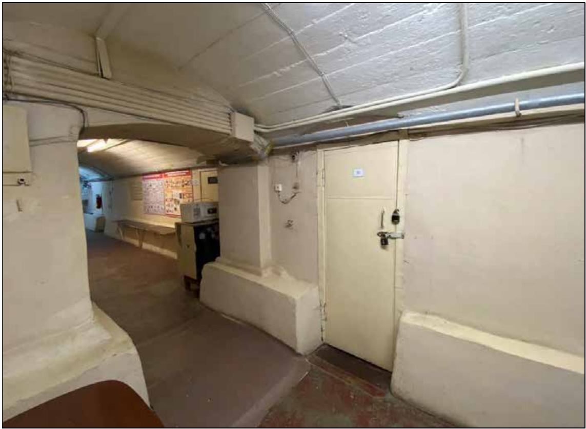
37. Объект культурного наследия регионального значения «Дом, в котором в 1902-1929 и 1933-1936 годах жил историк Н.П. Лихачев». Цокольный этаж. Помещение № 1 (коридор). Вход в помещение № 14. 16.01.2022 г.
