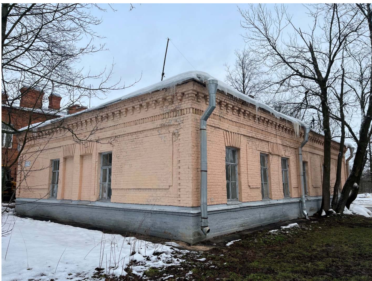
Фото №2. Юго-западный и юго-восточный фасады здания.
