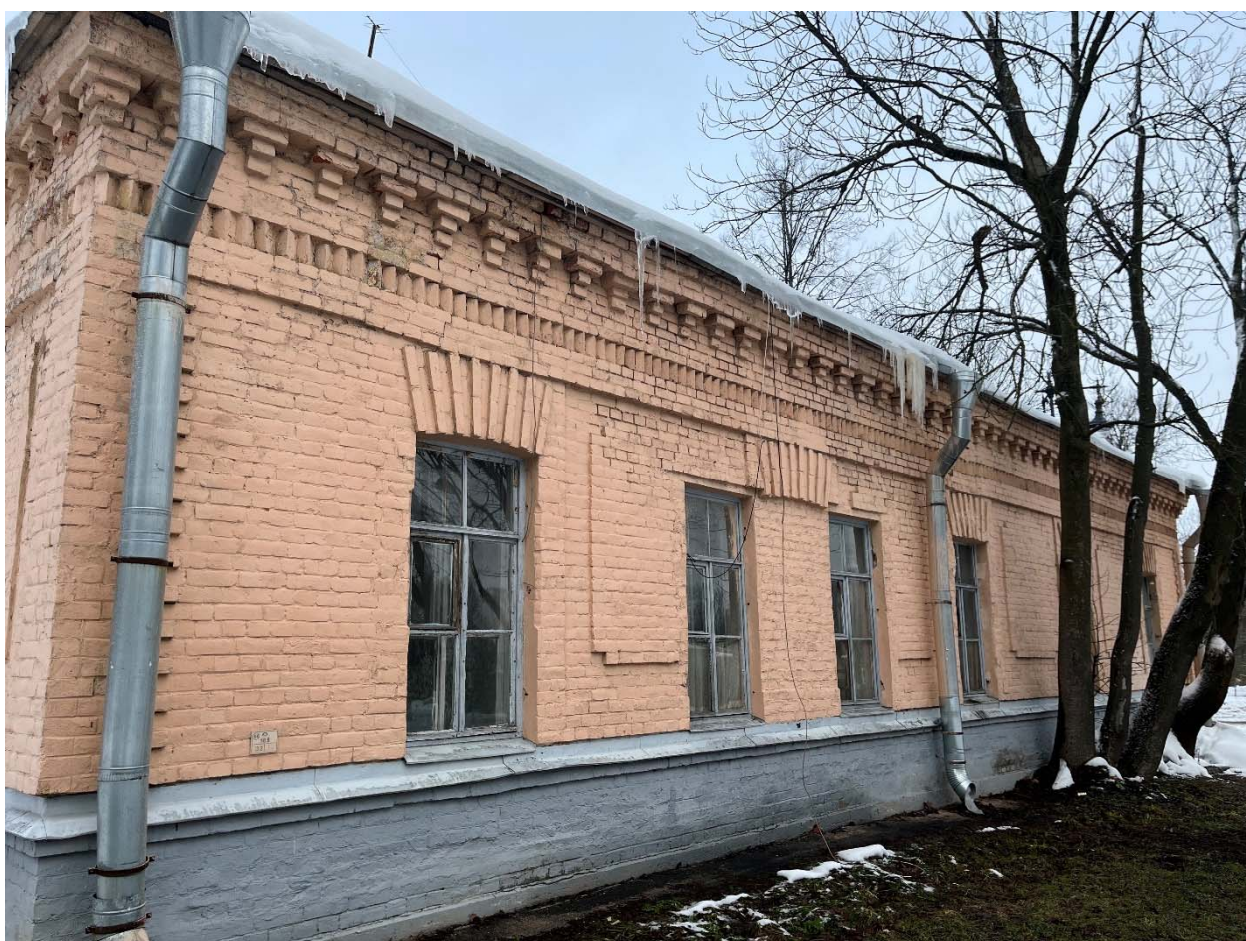
Фото №3. Юго-восточный фасад здания.
