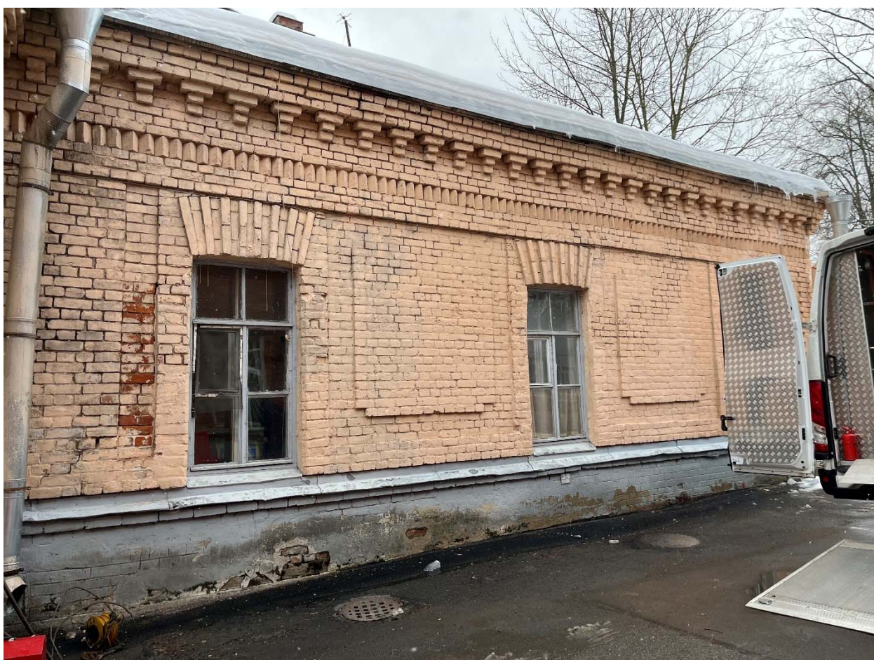
Фото №6. Северо-западный фасад, вход в здание.
