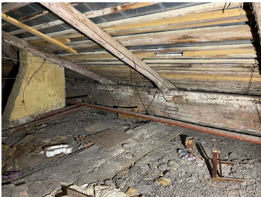
Фото №40. Чердачное пространство.
