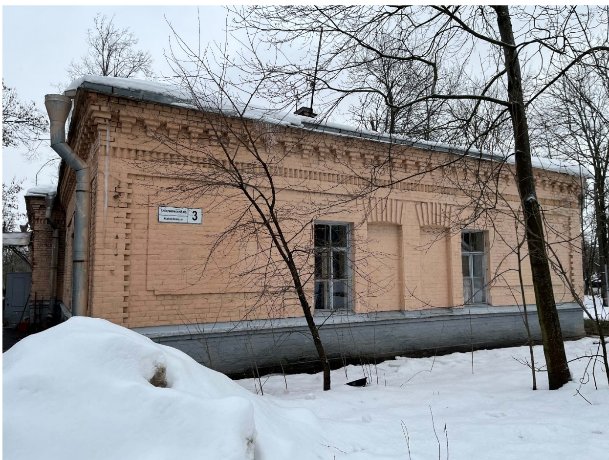
Фото №4. Юго-западный фасад здания.
