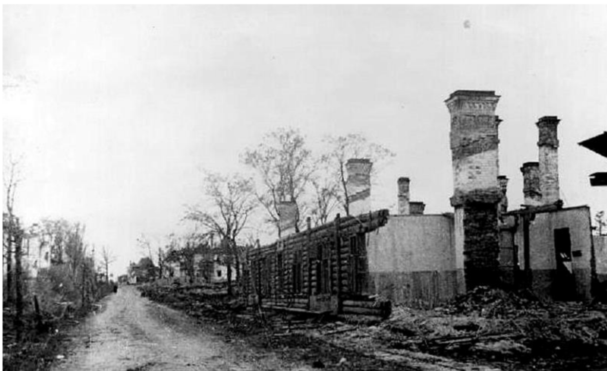
Илл. 8. Академический проспект. Вид разрушений. Фото 1945 г. ЦГАКФФД СПб. Шифр: Ар 107559.
