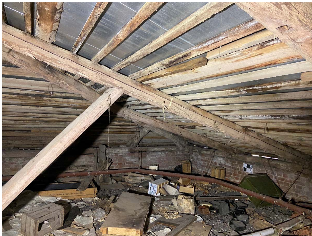
Фото №39. Чердачное пространство.
