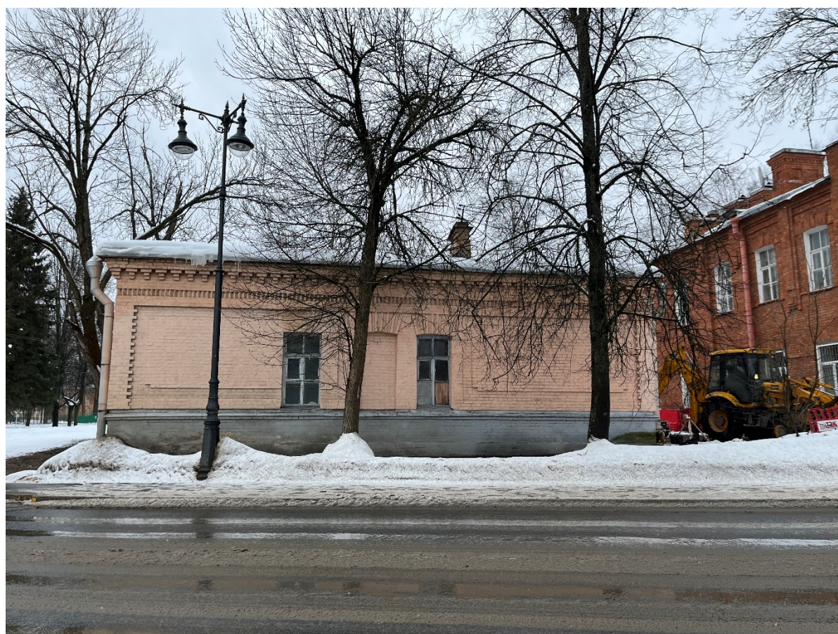
Фото №1. Северо-восточный фасад, общий вид.
