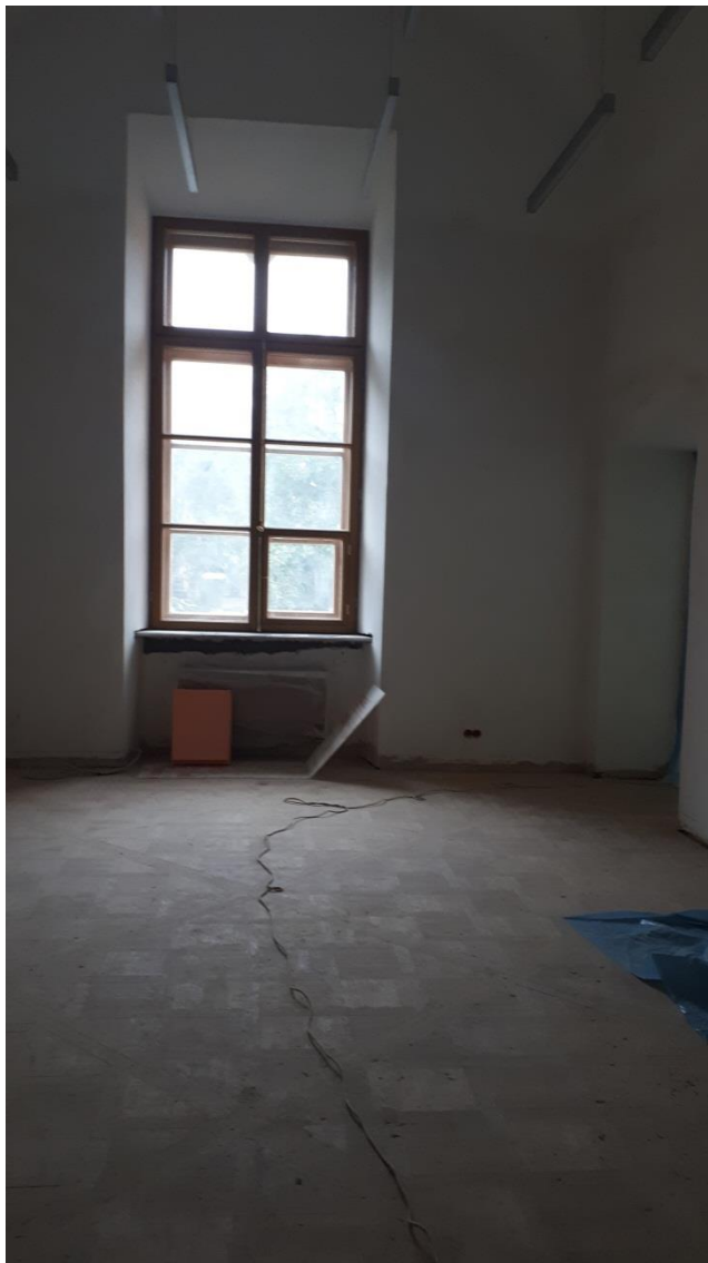
12. Объект культурного наследия федерального значения «Замок», входящий в состав объекта культурного наследия федерального значения «Михайловский (Инженерный) замок», по адресу: г. Санкт-Петербург, Центральный район, ул. Садовая, д. 2, лит. А (Садовая ул., 2). Первый этаж. Помещение 142. Фрагмент интерьера.
