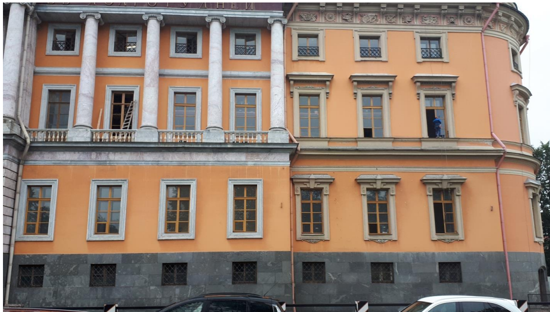
6. Объект культурного наследия федерального значения «Замок», входящий в состав объекта культурного наследия федерального значения «Михайловский (Инженерный) замок», по адресу: г. Санкт-Петербург, Центральный район, ул. Садовая, д. 2, лит. А (Садовая ул., 2). Главный (южный) фасад. Фрагмент.
