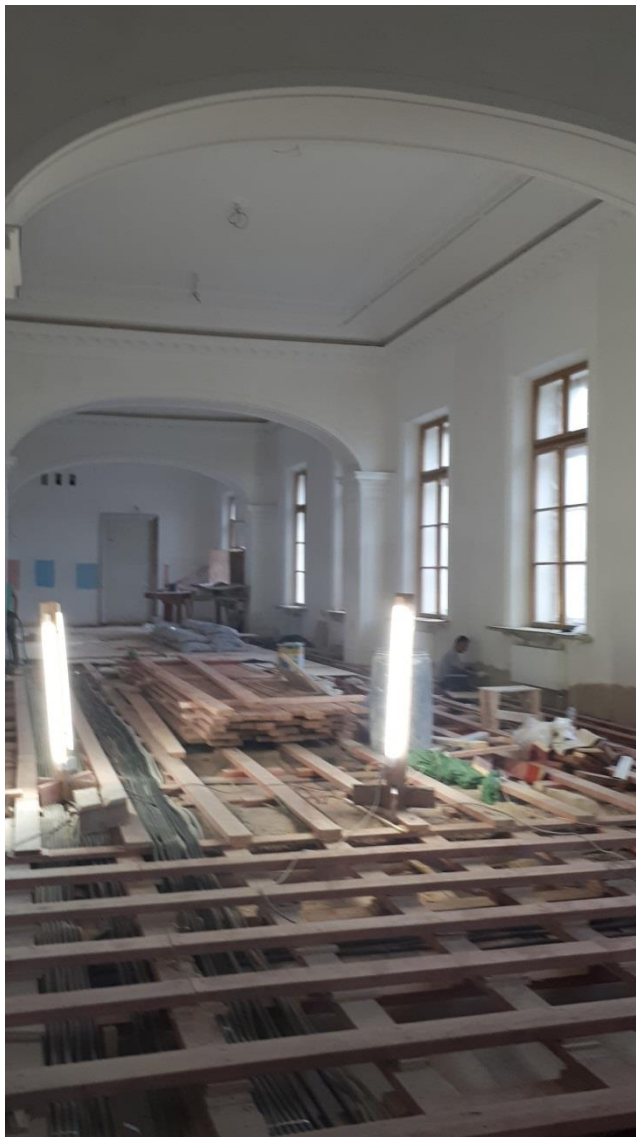
26. Объект культурного наследия федерального значения «Замок», входящий в состав объекта культурного наследия федерального значения «Михайловский (Инженерный) замок», по адресу: г. Санкт-Петербург, Центральный район, ул. Садовая, д. 2, лит. А (Садовая ул., 2). Второй этаж. Помещение 263,265. Общий вид.
