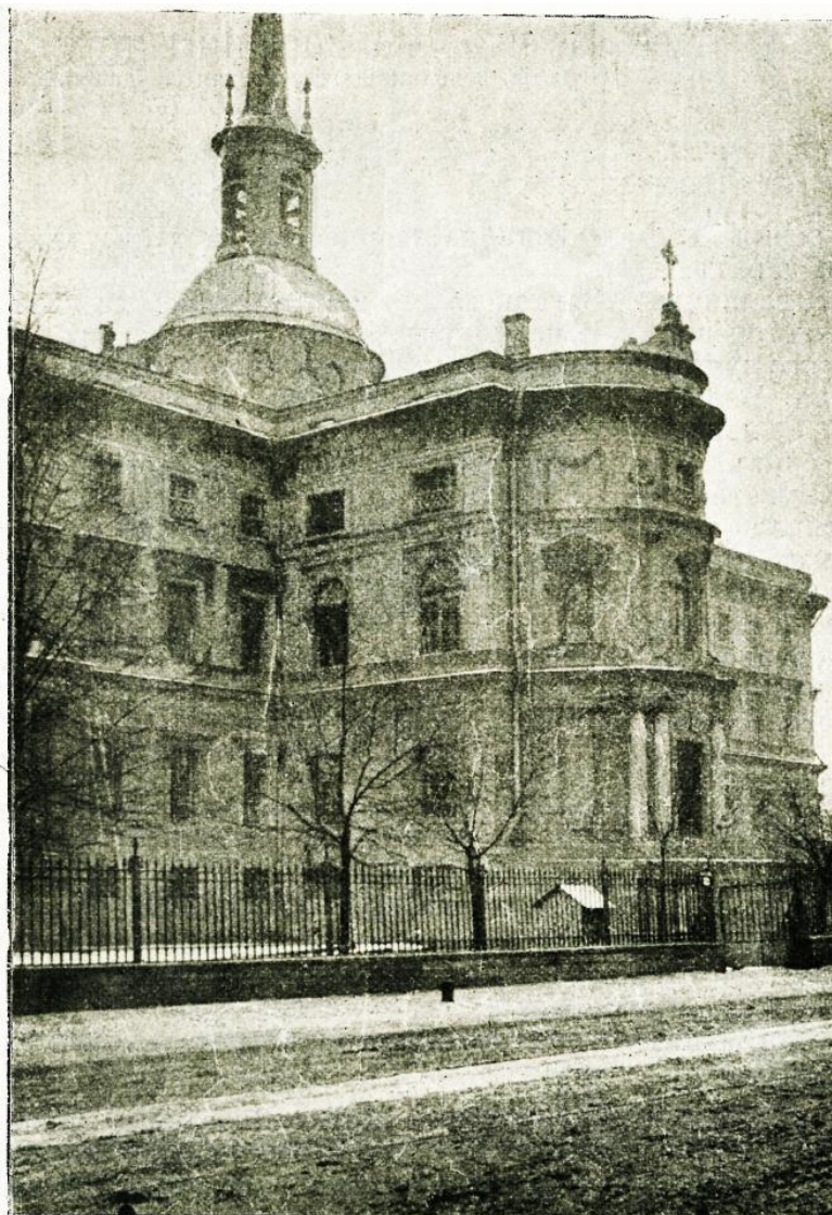
22. Михайловский (Инженерный) замок. Западный (церковный) фасад. Фрагмент. Начало XX вв. Фотография.
