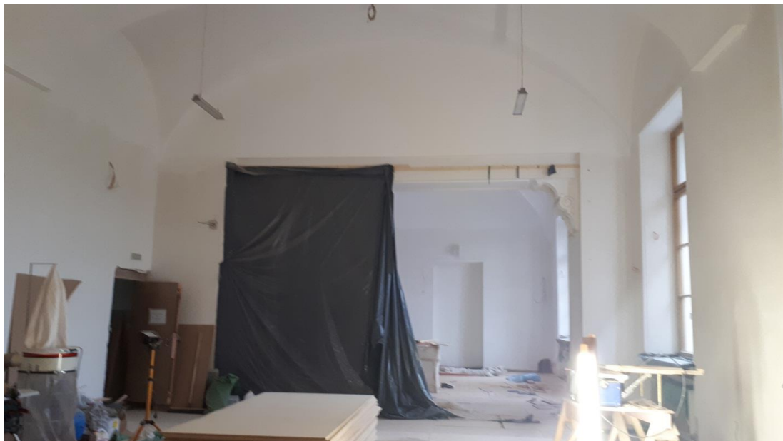
18. Объект культурного наследия федерального значения «Замок», входящий в состав объекта культурного наследия федерального значения «Михайловский (Инженерный) замок», по адресу: г. Санкт-Петербург, Центральный район, ул. Садовая, д. 2, лит. А (Садовая ул., 2). Первый этаж. Помещение 121. Фрагмент интерьера.
