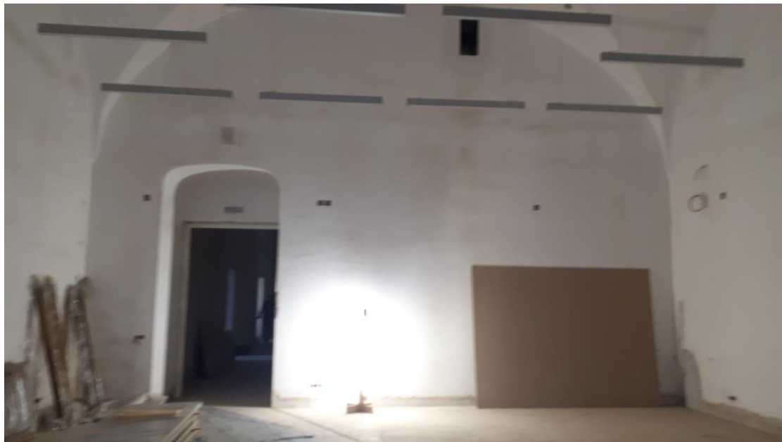
16. Объект культурного наследия федерального значения «Замок», входящий в состав объекта культурного наследия федерального значения «Михайловский (Инженерный) замок», по адресу: г. Санкт-Петербург, Центральный район, ул. Садовая, д. 2, лит. А (Садовая ул., 2). Первый этаж. Помещение 148. Фрагмент интерьера.
