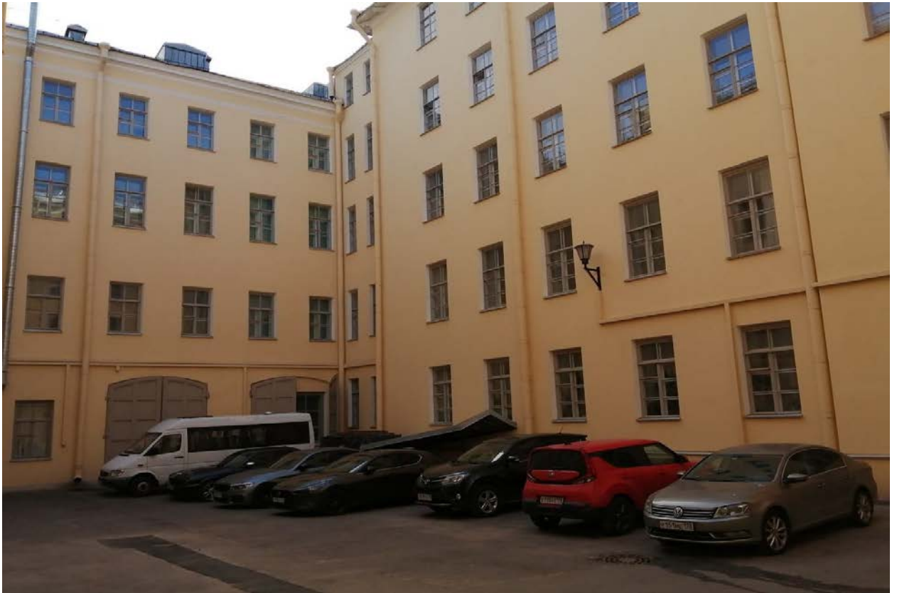
Фото 4. Объект культурного наследия федерального значения «Дирекция императорских театров», расположенный по адресу: Санкт-Петербург, Зодчего Росси ул., 2 Островского пл., 6 Ломоносова пл., 4, в составе объекта культурного наследия федерального значения «Ансамбль улицы Зодчего Росси», расположенного по адресу: Санкт-Петербург, Зодчего Росси ул., 1-3, 2, Островского пл., 6,11, Ломоносова пл., 1,2,4, Торговый пер., 2 . северный фасад среднего дворового корпуса (фрагмент).
