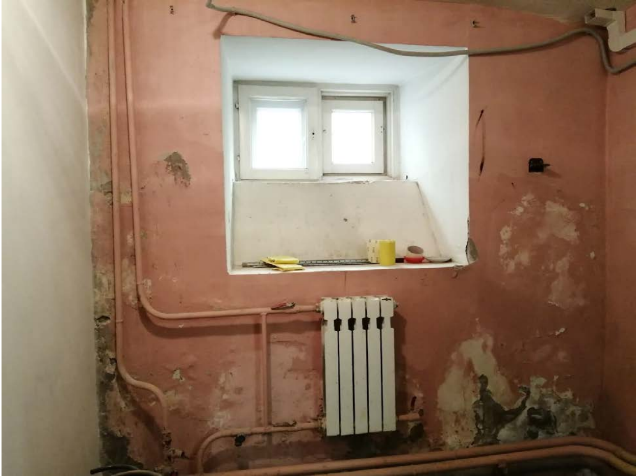
Фото 8. Объект культурного наследия федерального значения «Дирекция императорских театров», расположенный по адресу: Санкт-Петербург, Зодчего Росси ул., 2 Островского пл., 6 Ломоносова пл., 4, в составе объекта культурного наследия федерального значения «Ансамбль улицы Зодчего Росси», расположенного по адресу: Санкт-Петербург, Зодчего Росси ул., 1-3, 2, Островского пл., 6,11, Ломоносова пл., 1,2,4, Торговый пер., 2 . Помещение ЛК-13. Подвал.
