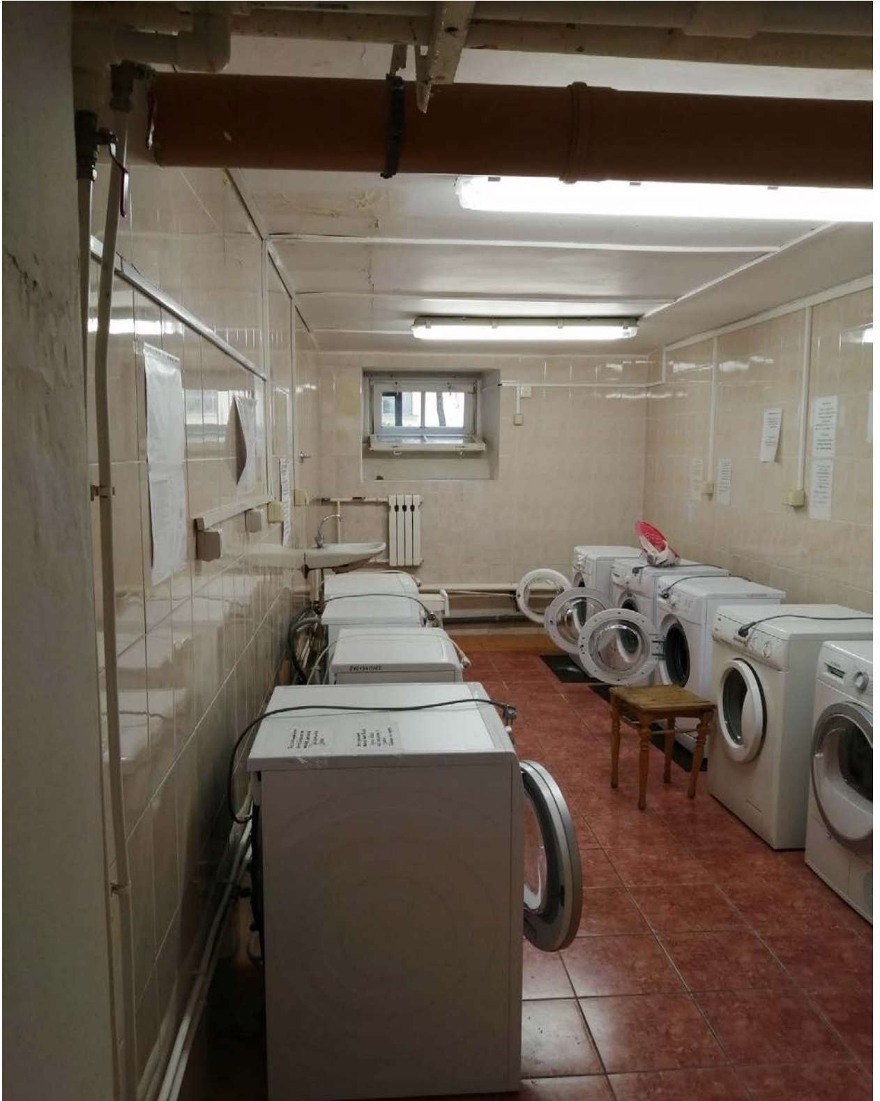
Фото 6. Объект культурного наследия федерального значения «Дирекция императорских театров», расположенный по адресу: Санкт-Петербург, Зодчего Росси ул., 2 Островского пл., 6 Ломоносова пл., 4, в составе объекта культурного наследия федерального значения «Ансамбль улицы Зодчего Росси», расположенного по адресу: Санкт-Петербург, Зодчего Росси ул., 1-3, 2, Островского пл., 6,11, Ломоносова пл., 1,2,4, Торговый пер., 2. Помещение 12-Н. Помещение постирочной.
