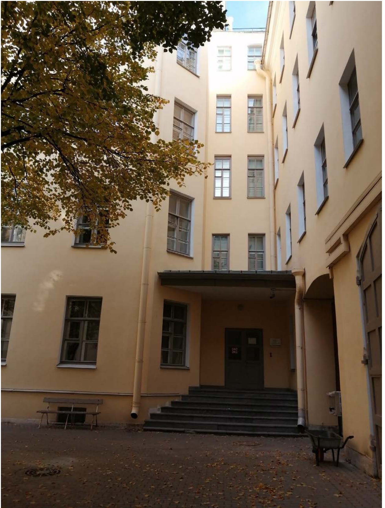
Фото 3. Объект культурного наследия федерального значения «Дирекция императорских театров», расположенный по адресу: Санкт-Петербург, Зодчего Росси ул., 2 Островского пл., 6 Ломоносова пл., 4, в составе объекта культурного наследия федерального значения «Ансамбль улицы Зодчего Росси», расположенного по адресу: Санкт-Петербург, Зодчего Росси ул., 1-3, 2, Островского пл., 6,11, Ломоносова пл., 1,2,4, Торговый пер., 2 . Южный фасад среднего дворового корпуса (фрагмент).
