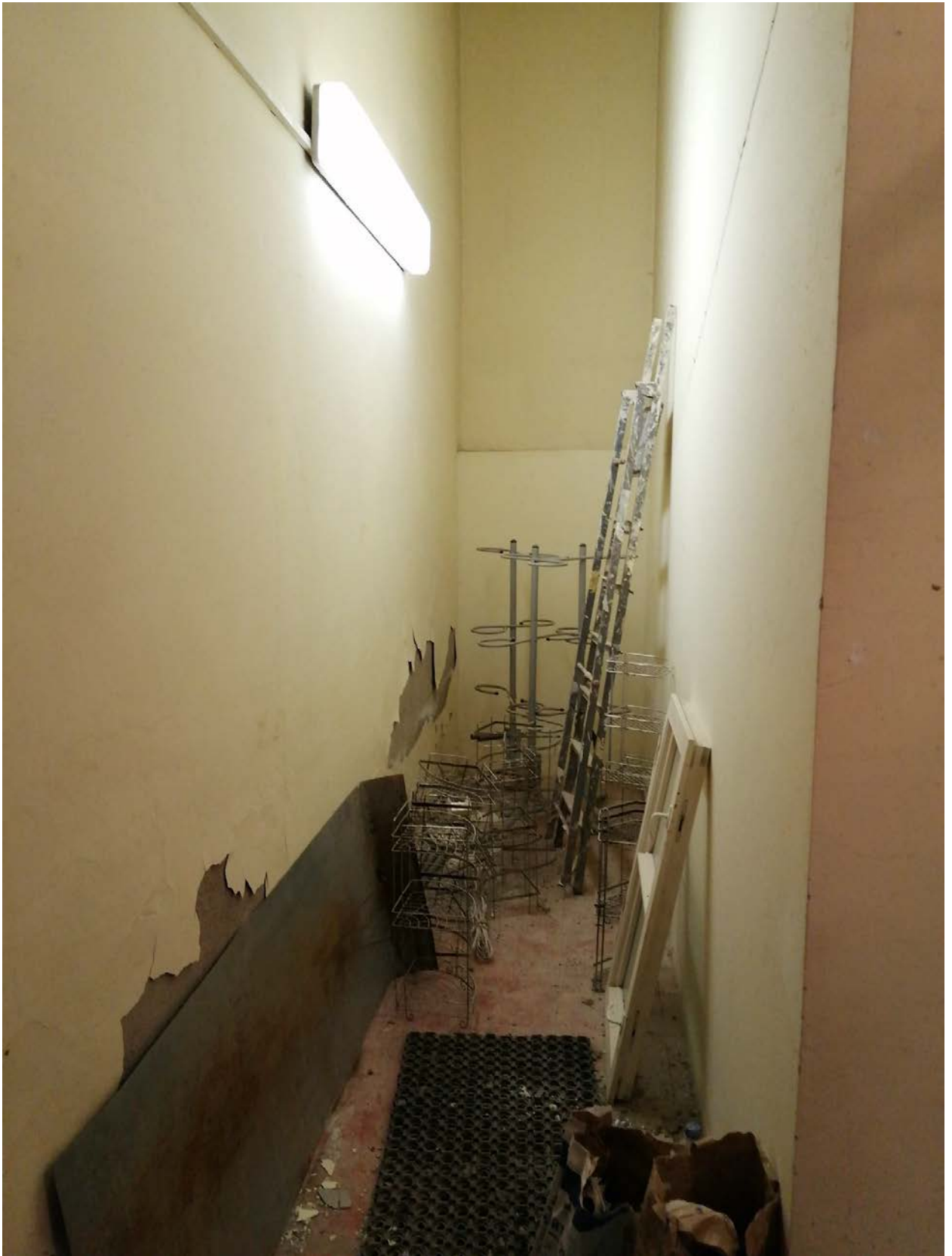
Фото 9. Объект культурного наследия федерального значения «Дирекция императорских театров», расположенный по адресу: Санкт-Петербург, Зодчего Росси ул., 2 Островского пл., 6 Ломоносова пл., 4, в составе объекта культурного наследия федерального значения «Ансамбль улицы Зодчего Росси», расположенного по адресу: Санкт-Петербург, Зодчего Росси ул., 1-3, 2, Островского пл., 6,11, Ломоносова пл., 1,2,4, Торговый пер., 2 . Подвал. ЛК -13 .Фрагмент.
