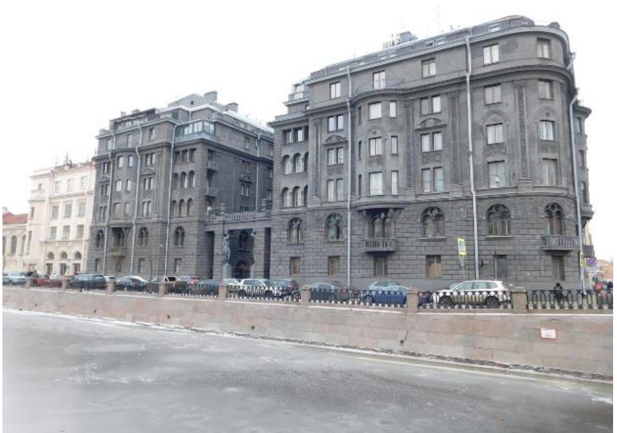
1. Юго-западный лицевой фасад объекта культурного наследия регионального значения «Доходный дом Р.Г. Вега», расположенного по адресу: г. Санкт-Петербург, наб. Крюкова канала, д. 14, литера А. 20.02.2022
