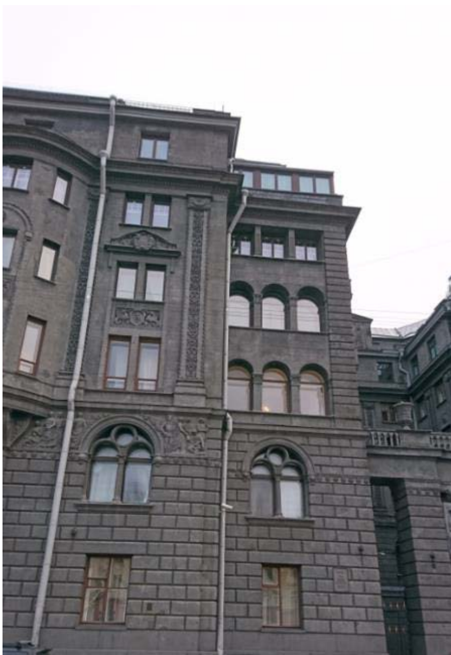
9. Юго- западный лицевой фасад объекта культурного наследия регионального значения «Доходный дом Р.Г. Веge», расположенного по адресу: г. Санкт-Петербург, наб. Крюкова канала, д. 14, литера А. Фрагмент. 20.02.2022
