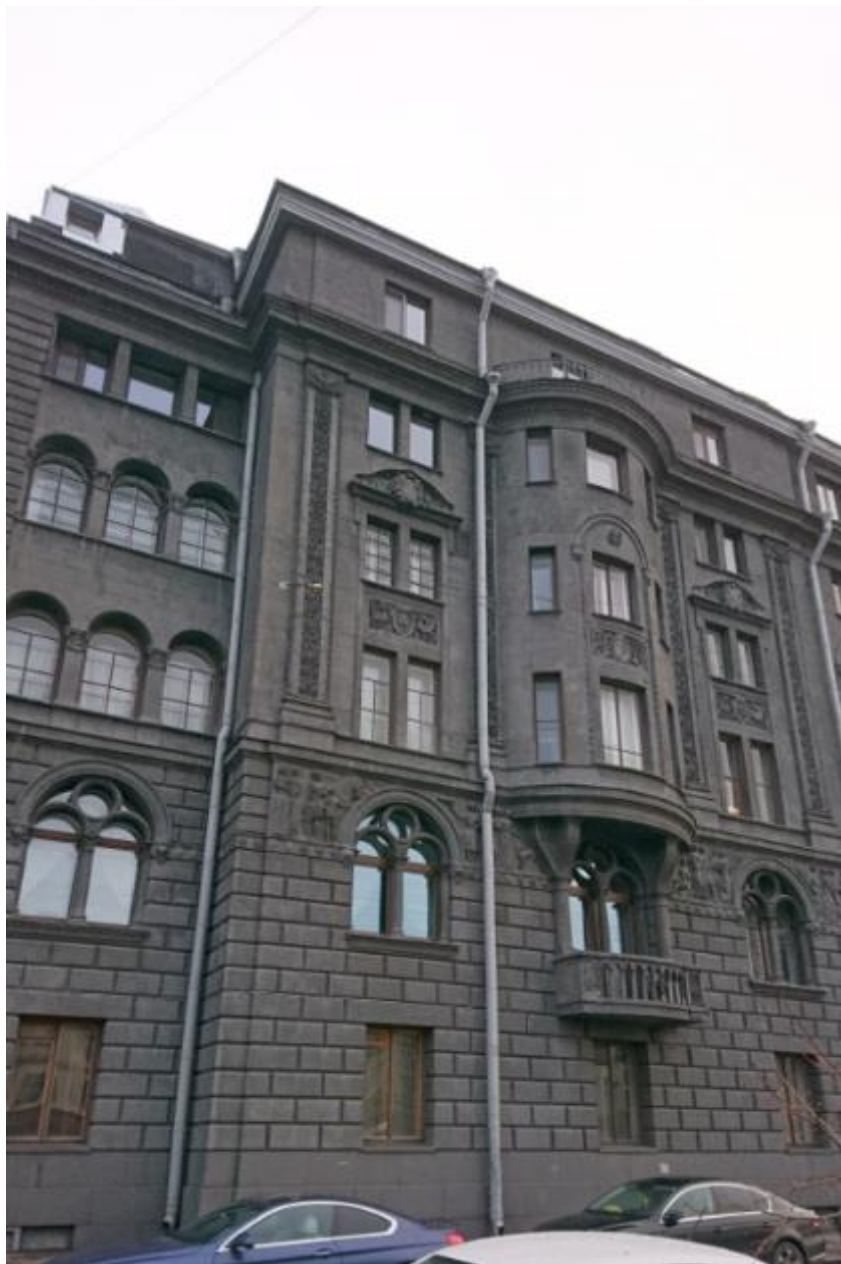
4. Юго- западный лицевой фасад объекта культурного наследия регионального значения «Доходный дом Р.Г. Веге», расположенного по адресу: г. Санкт-Петербург, наб. Крюкова канала, д. 14, литера А. Фрагмент. 20.02.2022
