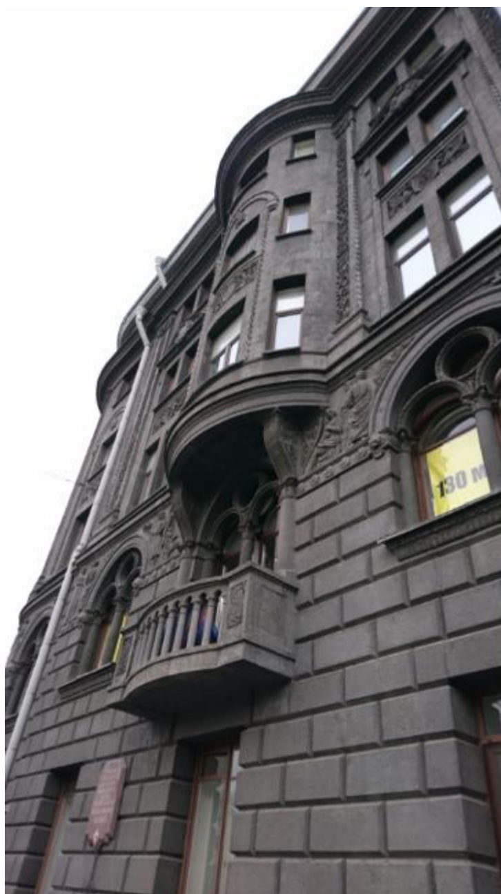
8. Юго- восточный лицевой фасад объекта культурного наследия регионального значения «Доходный дом Р.Г. Вега», расположенного по адресу: г. Санкт-Петербург, наб. Крюкова канала, д. 14, литера А. Фрагмент. 20.02.2022
