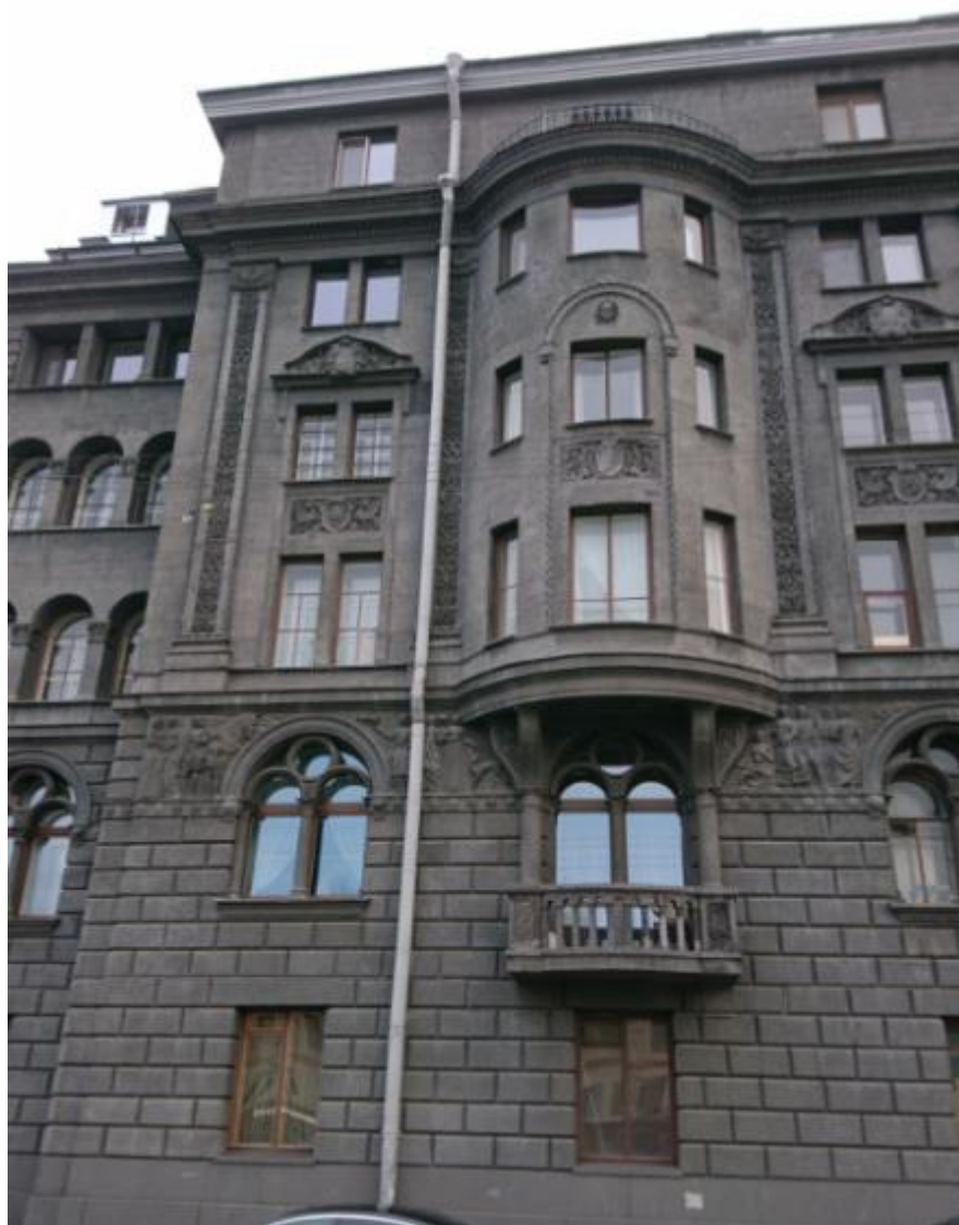
5. Юго- западный лицевой фасад объекта культурного наследия регионального значения «Доходный дом Р.Г. Веге», расположенного по адресу: г. Санкт-Петербург, наб. Крюкова канала, д. 14, литера А. Фрагмент. 20.02.2022
