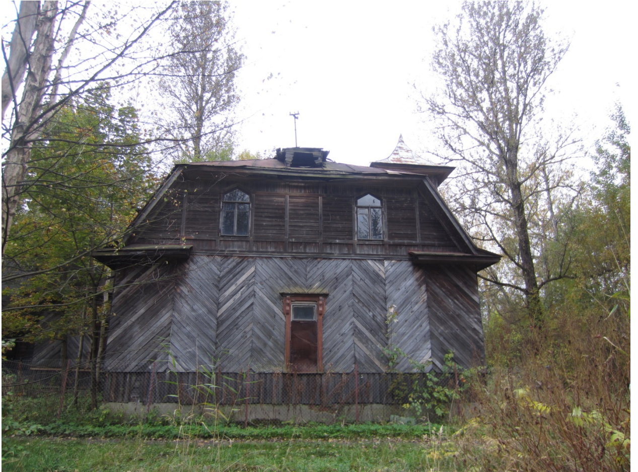
17. Северо-восточный фасад, фото 2014 г. Акт по результатам государственной историко-культурной экспертизы выявленного объекта культурного наследия: «Дача», расположенного по адресу: Санкт-Петербург, Выборгский район, поселок Левашово, улица Чкалова, дом 8, литера «А», с целью обоснования включения объекта в Единый государственный реестр объектов культурного наследия (памятников истории и культуры) народов Российской Федерации. СПб., 2014.
