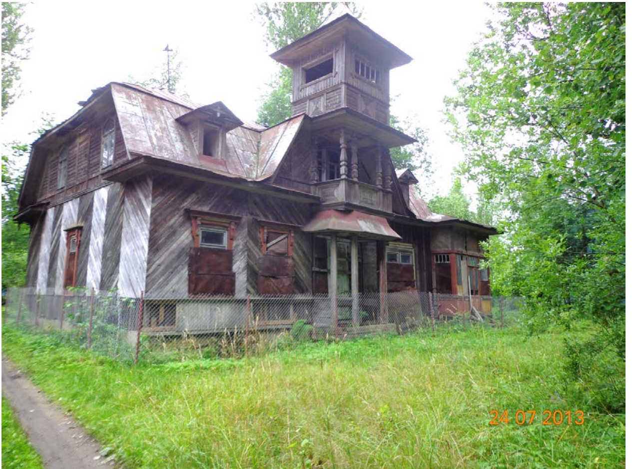
15. Общий вид исследуемого здания, фото 2013 г.
