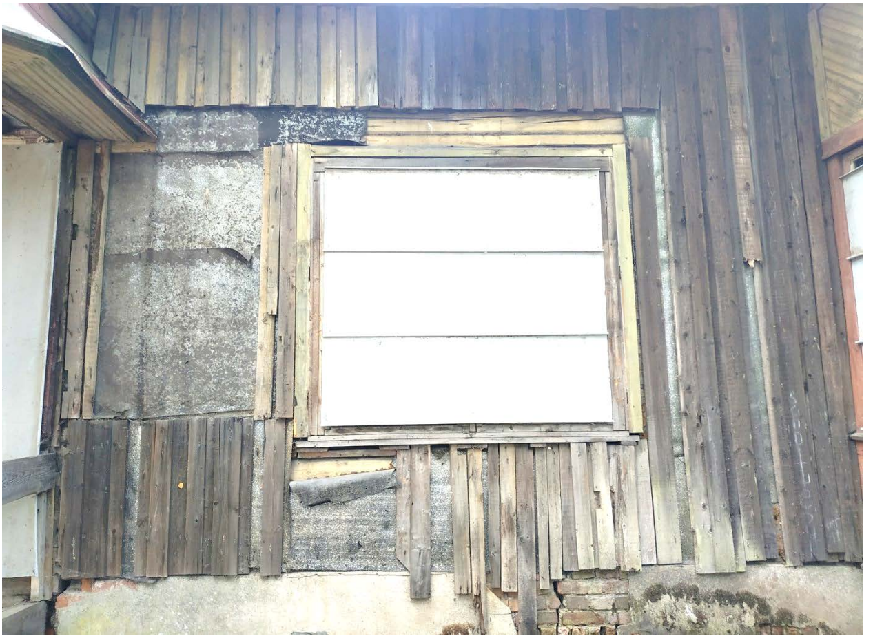
8. Объект культурного наследия регионального значения «Дача (деревянная 2-этажная)». Лицевой фасад, под обшивкой – позднее утепление с ветрозащитой рубероидом.
