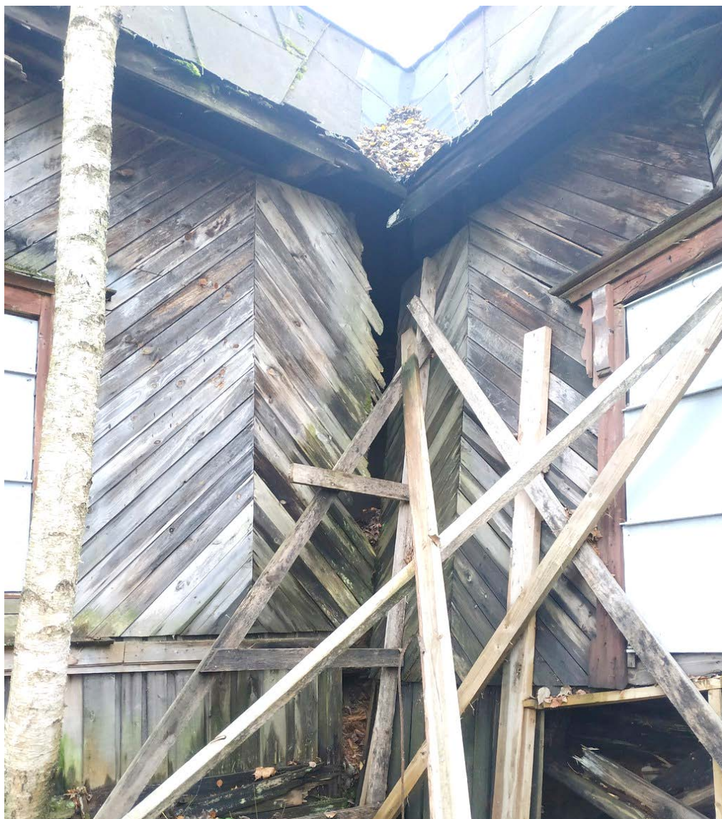
17. Объект культурного наследия регионального значения «Дача (деревянная 2-этажная)». Восточный угол (участок сруба в аварийном состоянии).
