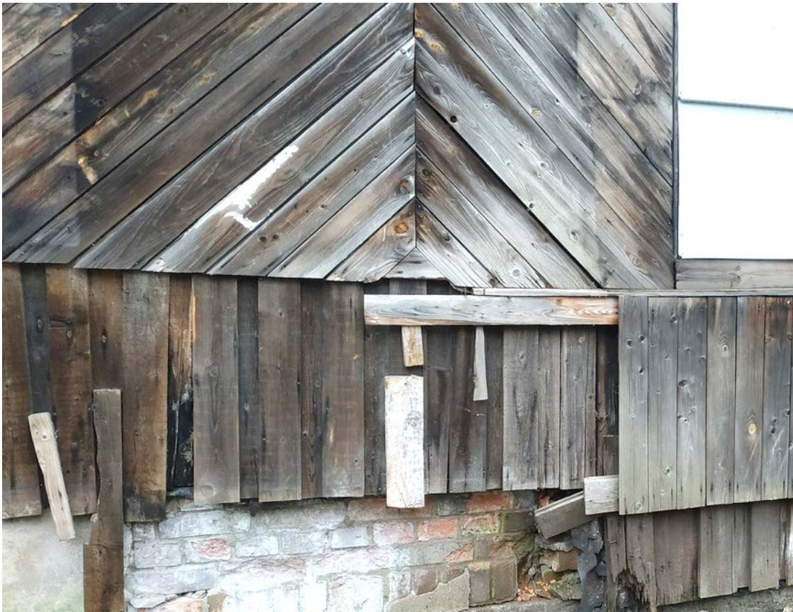
13. Объект культурного наследия регионального значения «Дача (деревянная 2-этажная)». Юго-западный фасад, фрагмент. Многослойная обшивка.
