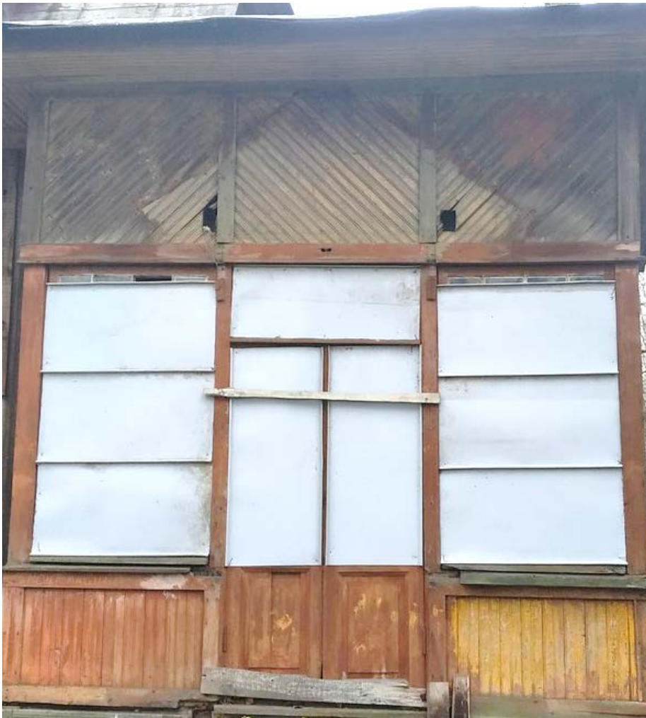
9. Объект культурного наследия регионального значения «Дача (деревянная 2-этажная)». Веранда (вид со стороны лицевого фасада). На обшивке – след фронтона утраченного крыльца.
