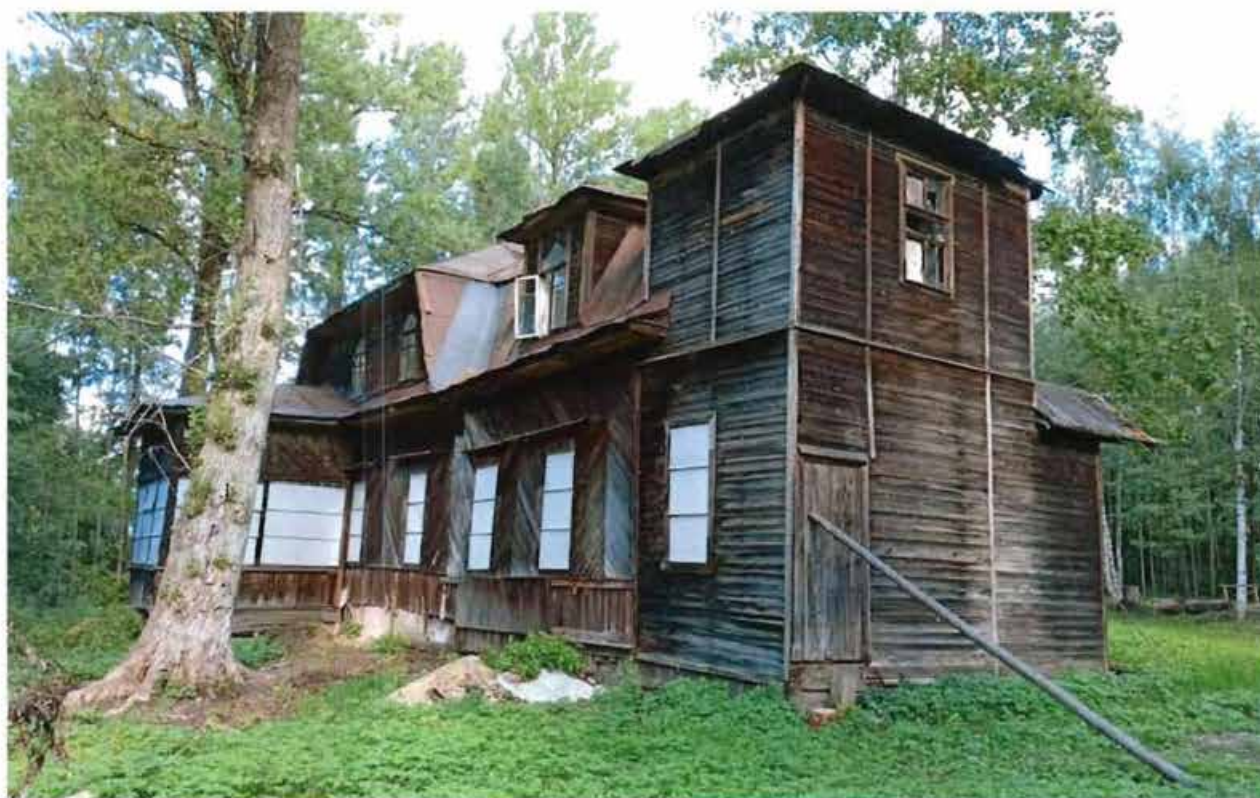
3. Вид на объект культурного наследия с южной стороны.
