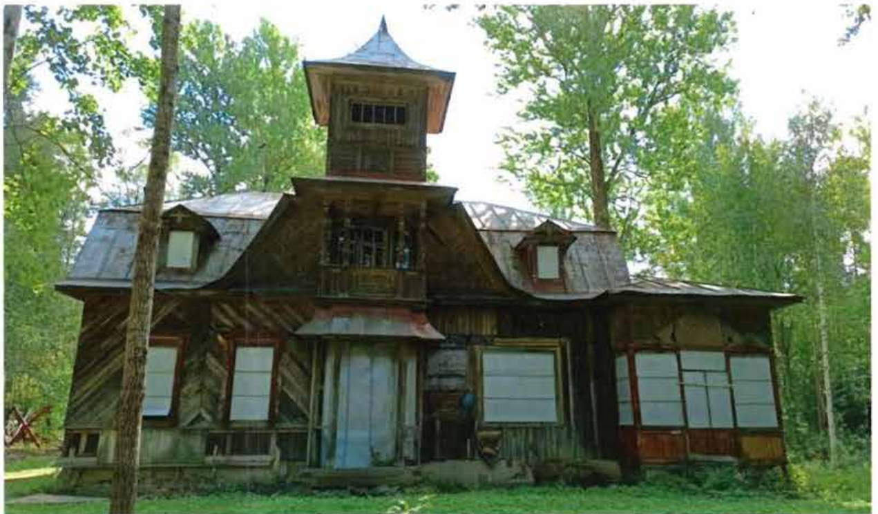
1. Вид на объект культурного наследия с северо-западной стороны.
