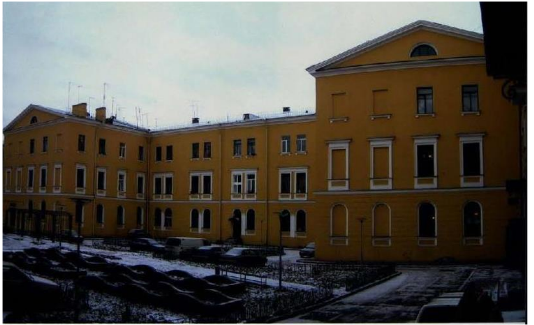
40. Дача Сиверса (Кировский городок). Корпус для неизлечимых больных (пр. Стачек, д. 144, лит.А). Юго-восточный фасад. Фото декабрь 2005 г. (11).
