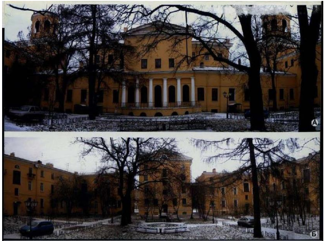
26. Дача Сиверса (Кировский городок). Главное здание (пр. Стачек, д. 158, лит.А). Дворовые фасады. А. Северо-западная сторона двора. Б. Юго-восточная сторона двора. Фото декабрь 2005 г. (11)..
