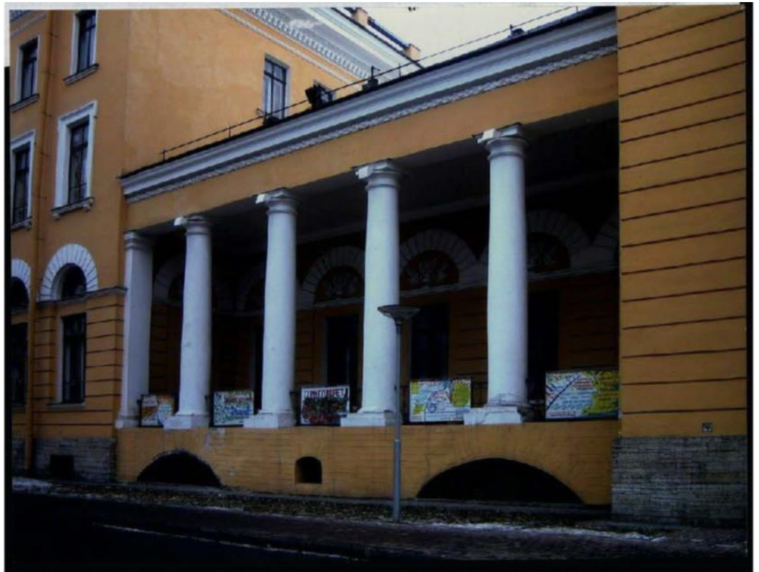
17. Дача Сиверса (Кировский городок). Главное здание (пр. Стачек, д. 158, лит.А). Главный фасад. Лоджия. Фото декабрь 2005 г. (11).
