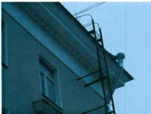
13. Профилированный карниз.
