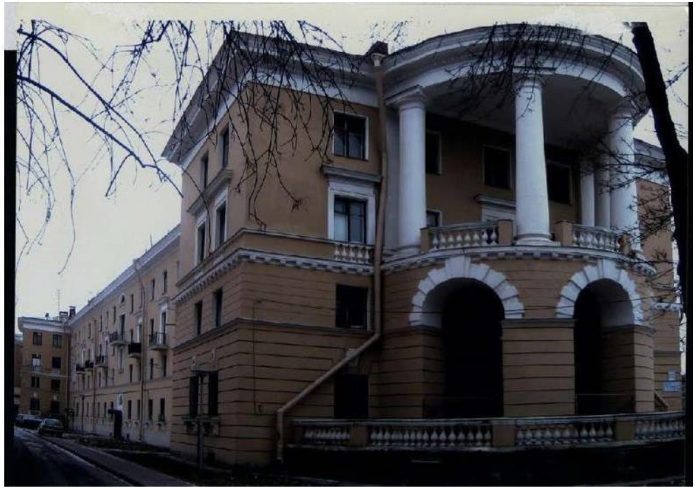
58. Дача Сиверса (Кировский городок). Жилой дом (пр. Стачек, д. 172, лит.А). Северо-западный и северо-восточный (дворовый) фасады. Вид с пр. Стачек. Фото декабрь 2005 г. (11).
