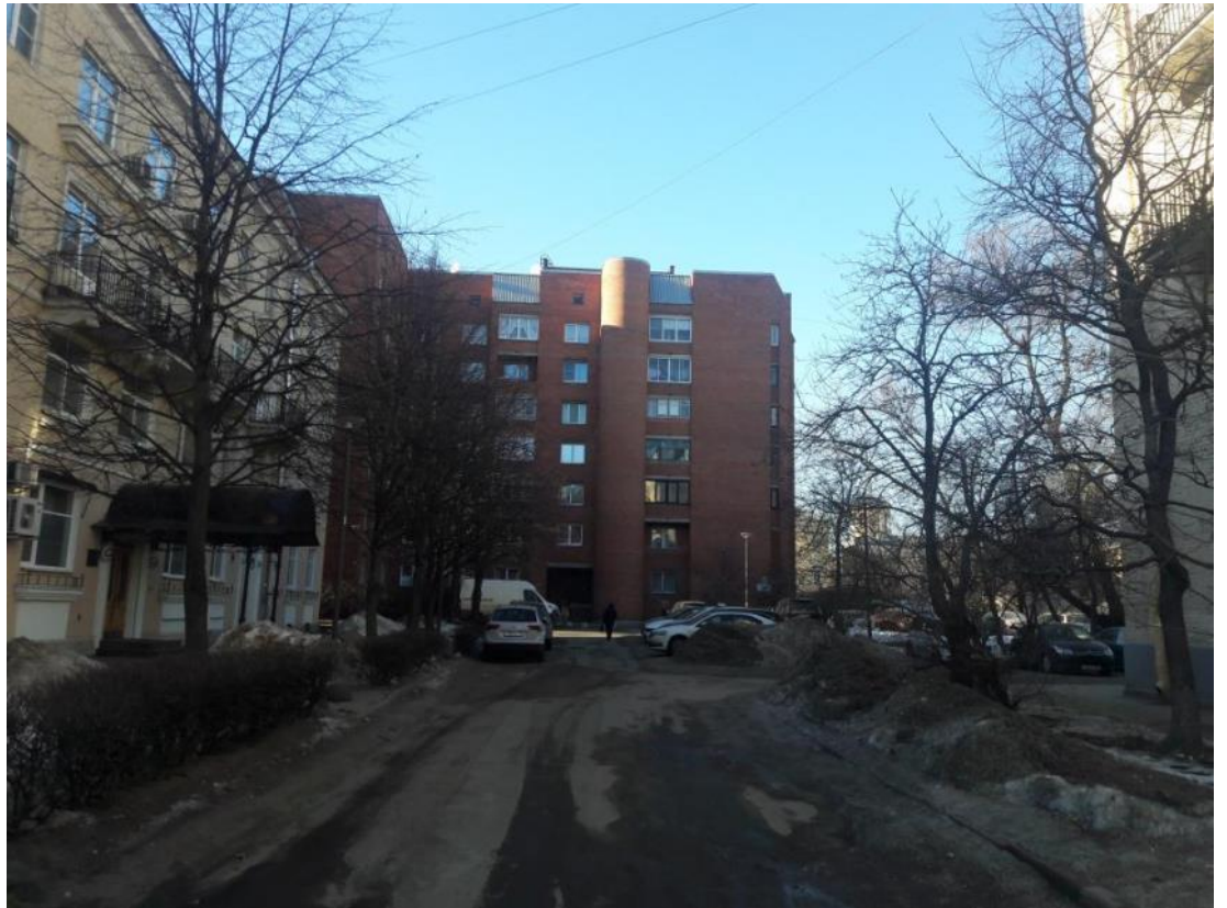
13. Дача Сиверса (Кировский городок). Участок 2 расположения трассы ремонта сетей в непосредственной близости от объекта культурного наследия. Полетайкин В.В. 28.02.2022.
