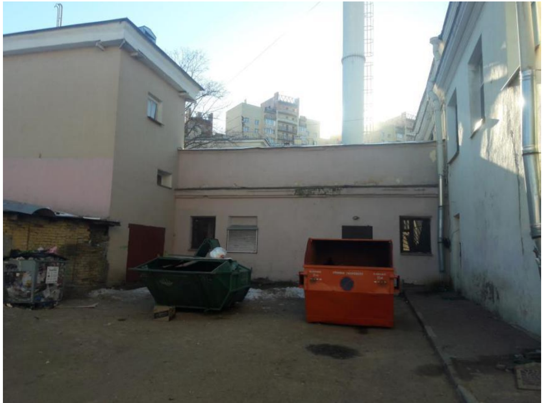
9. Дача Сиверса (Кировский городок). Участок 1 расположения трассы ремонта сетей в непосредственной близости от объекта культурного наследия. Полетайкин В.В. 28.02.2022.
