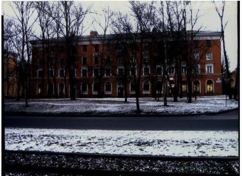
51. Дача Сиверса (Кировский городок). Жилой дом (пр. Стачек, д. 142, лит.А). Общий вид со стороны пр.Стачек. Фото декабрь 2005 г. (11).
