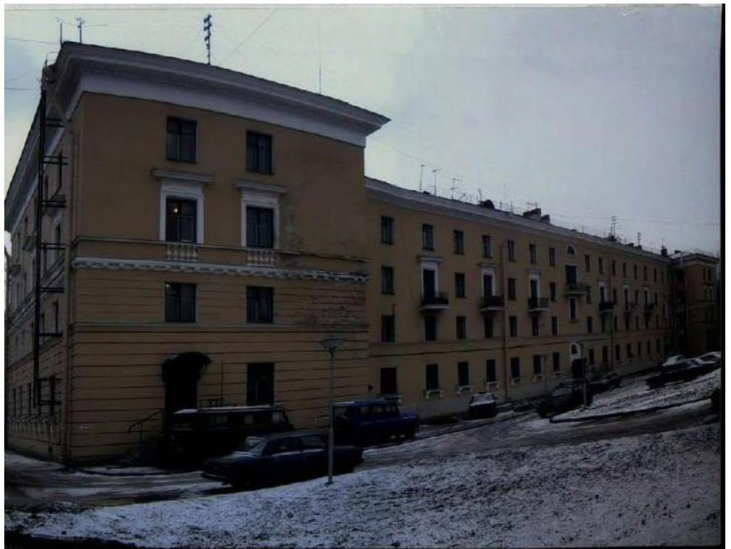
59. Дача Сиверса (Кировский городок). Жилой дом (пр. Стачек, д. 172, лит.А). Северо-восточный (дворовый) фасад. Вид с пр. Стачек. Фото декабрь 2005 г. (11).
