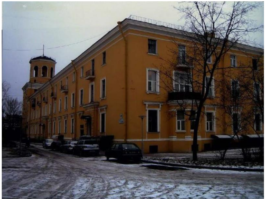
21. Дача Сиверса (Кировский городок). Главное здание (пр. Стачек, д. 158, лит.А). Юго-западный фасад. Вид от южного угла. Фото декабрь 2005 г. (11).
