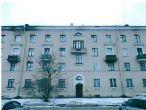
5. Фрагмент фасада. Вид с северо-востока.
