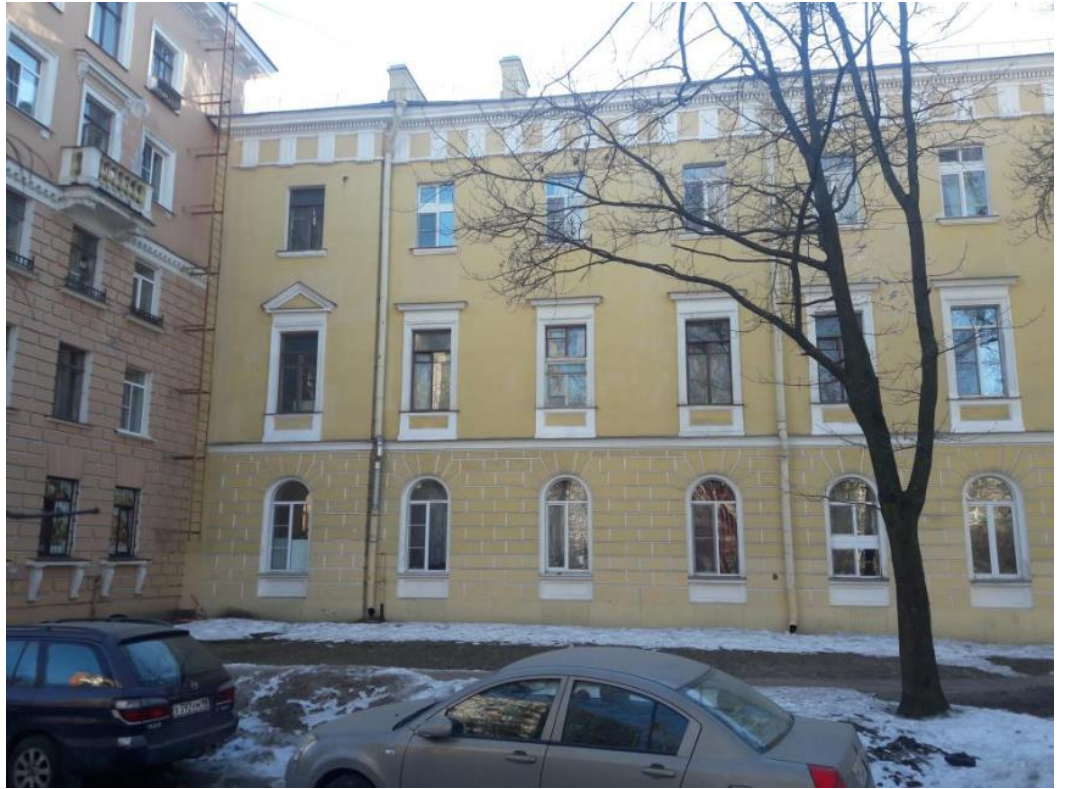
19. Дача Сиверса (Кировский городок). Участок 3 расположения трассы ремонта сетей в непосредственной близости от объекта культурного наследия. Полетайкин В.В. 28.02.2022.
