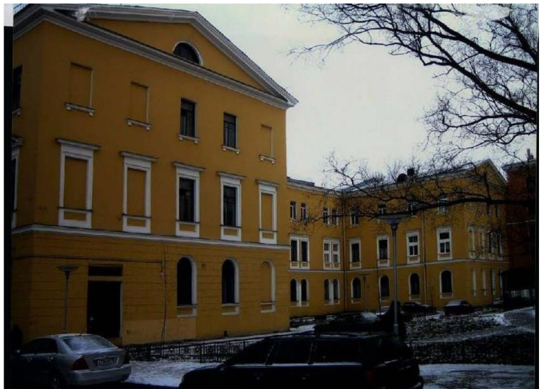
41. Дача Сиверса (Кировский городок). Корпус для неизлечимых больных (пр. Стачек, д. 144, лит.А). Юго-восточный фасад. Вид с юга. Фото декабрь 2005 г. (11).
