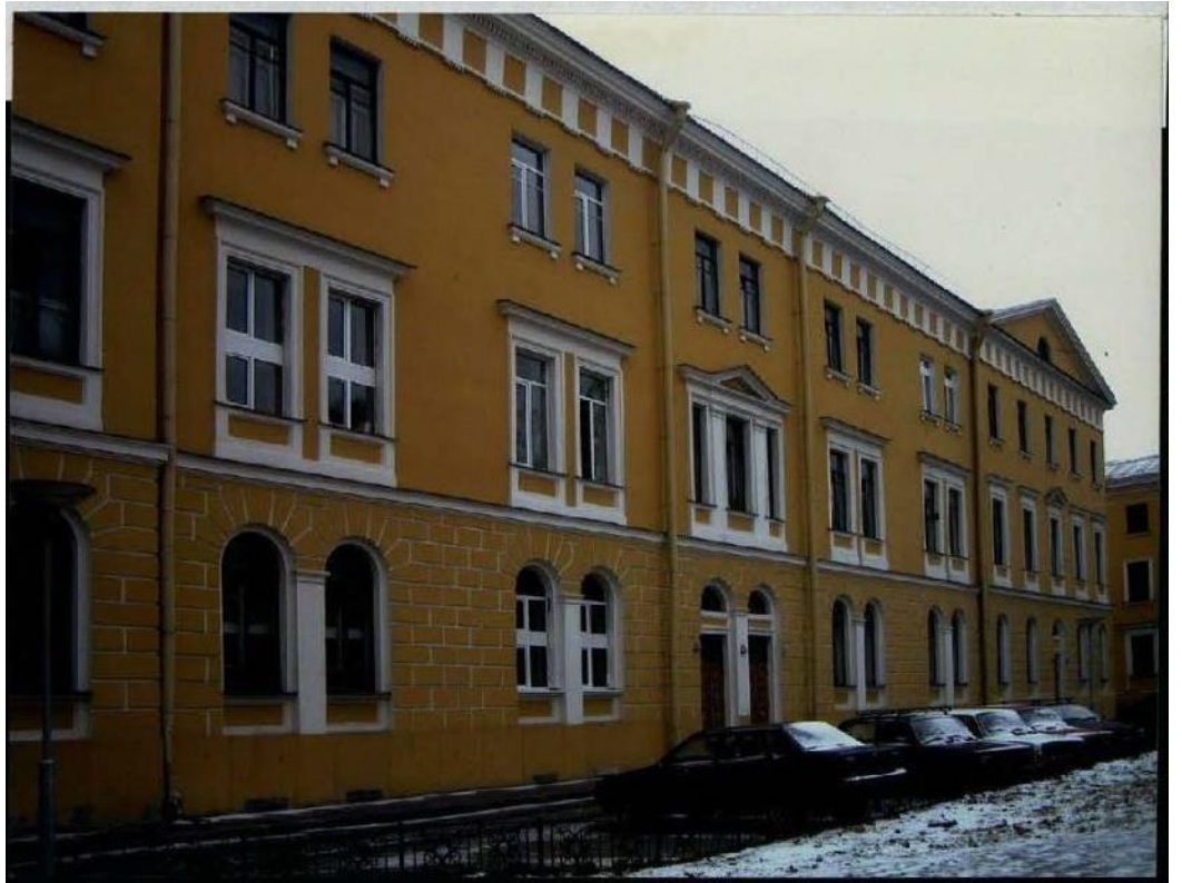
38. Дача Сиверса (Кировский городок). Корпус для неизлечимых больных (пр. Стачек, д. 144, лит.А). Главный (северо-западный) фасад. Фото декабрь 2005 г. (11).
