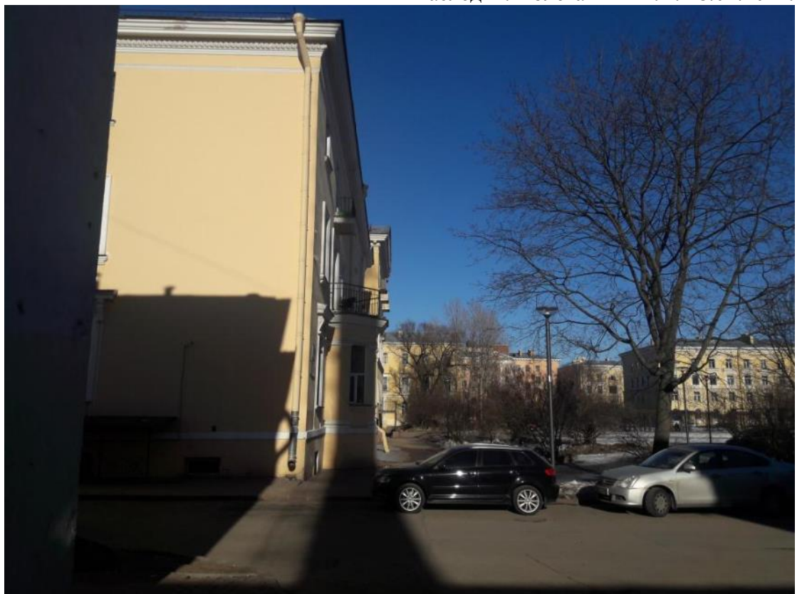
10. Дача Сиверса (Кировский городок). Участок 1 расположения трассы ремонта сетей в непосредственной близости от объекта культурного наследия. Полетайкин В.В. 28.02.2022.
