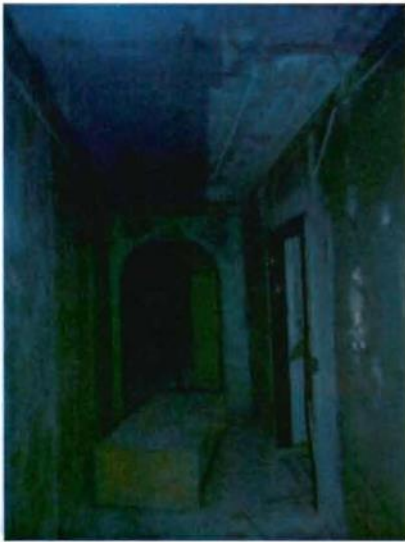
17. Помещение первого этажа.
