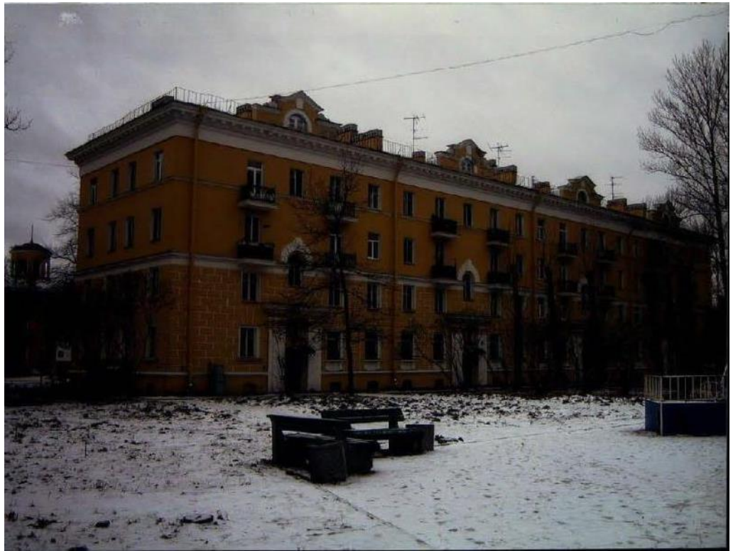
48. Дача Сиверса (Кировский городок). Жилой дом (пр. Стачек, д. 140, лит.А). Северо-восточный и юго-восточный фасады. Вид со стороны пр.Стачек. Фото декабрь 2005 г. (11).
