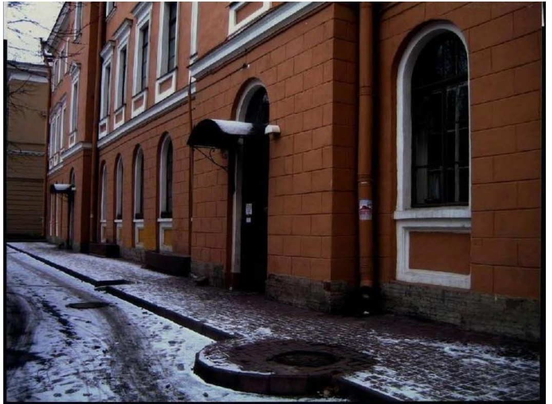
46. Дача Сиверса (Кировский городок). Дом для служащих больницы (пр. Стачек, д. 160, лит.А). Юго-восточный (дворовый) фасад. Фото декабрь 2005 г. (11).
