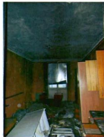
20. Помещение третьего этажа.
