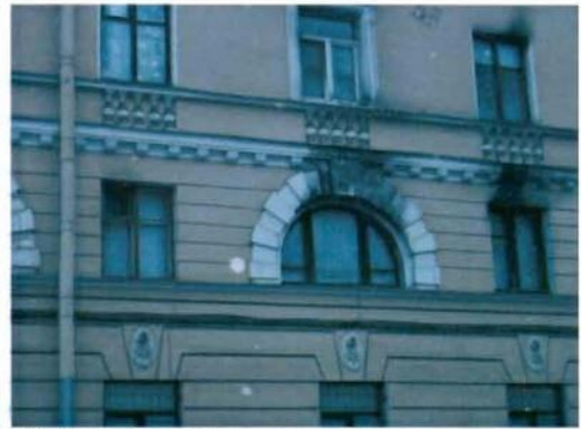
12. Оконные проемы второго этажа.
