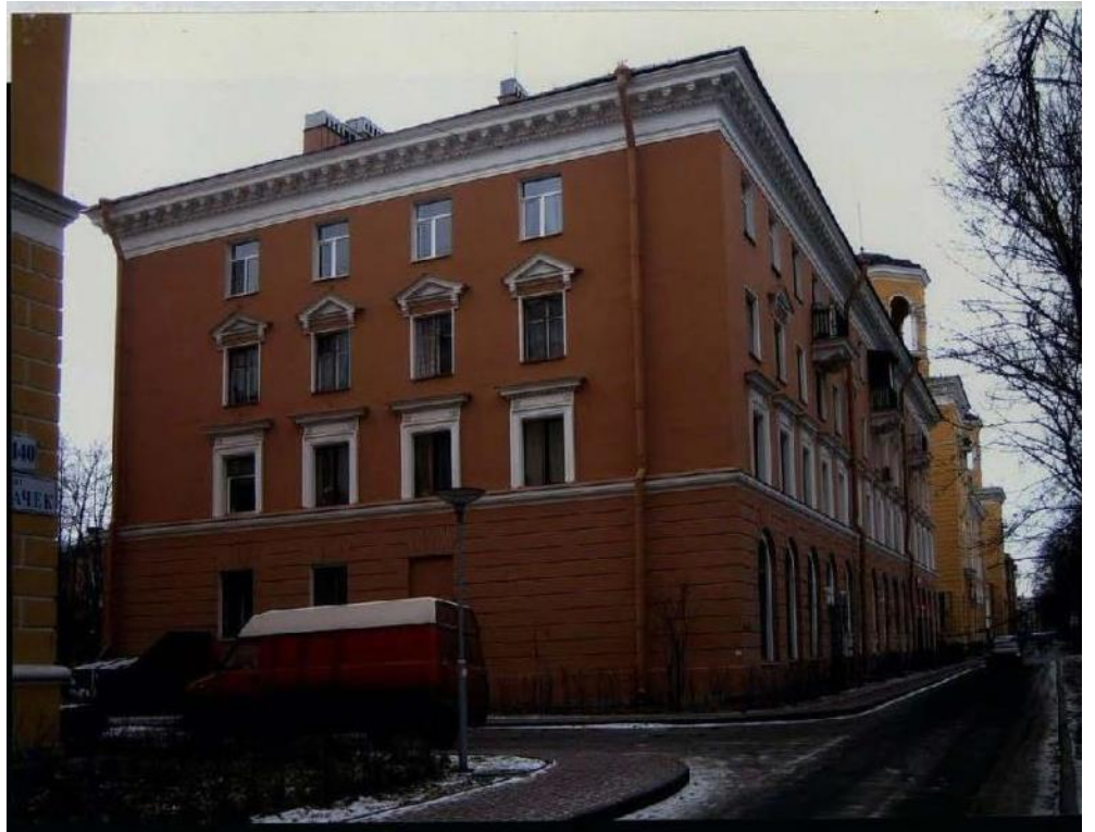
52. Дача Сиверса (Кировский городок). Жилой дом (пр. Стачек, д. 142, лит.А). Северо-восточный и северо-западный (главный) фасады. Фото декабрь 2005 г. (11).
