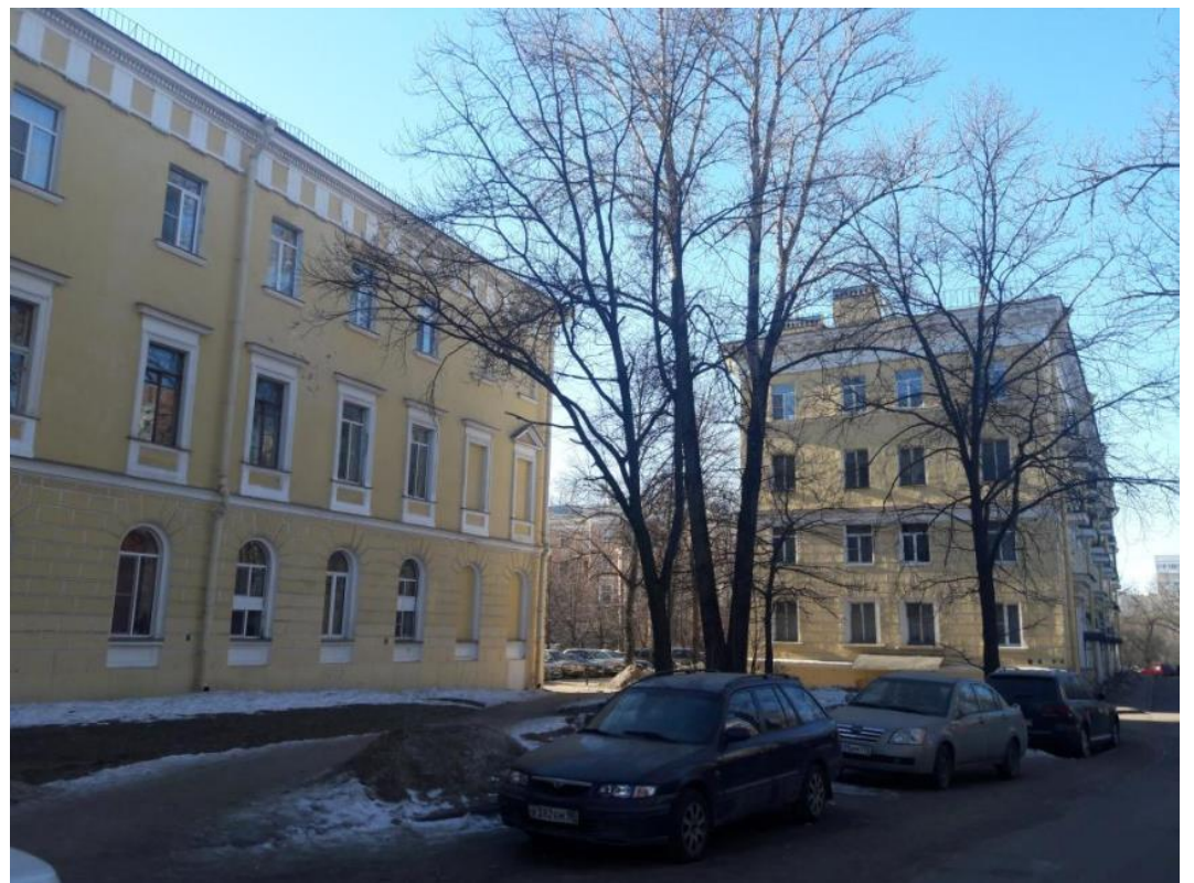
18. Дача Сиверса (Кировский городок). Участок 4 расположения трассы ремонта сетей в непосредственной близости от объекта культурного наследия. Полетайкин В.В. 28.02.2022.
