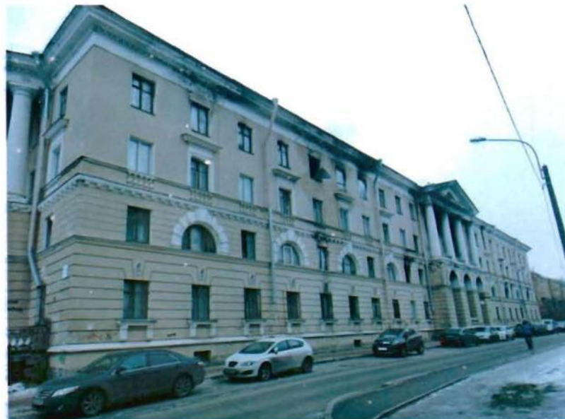
2. Лицевой фасад. Вид с запада.
