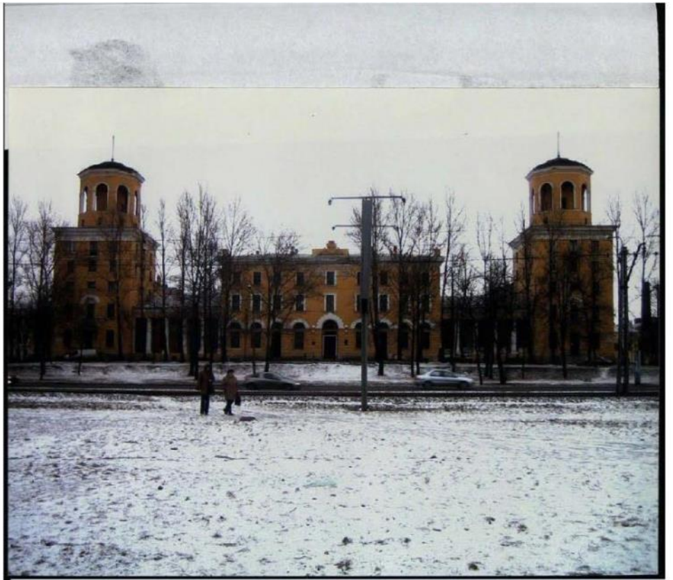
12. Дача Сиверса (Кировский городок). Главное здание (пр. Стачек, д.158, лит.А). Главный фасад. Общий вид с пр. Стачек. Фото декабрь 2005 г. (11).
