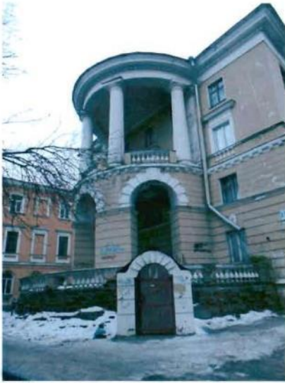
9. Полуциркульный ризалит с балконом и террасой.
