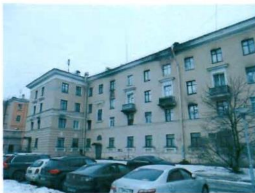
7. Фрагмент фасада. Вид с севера.
