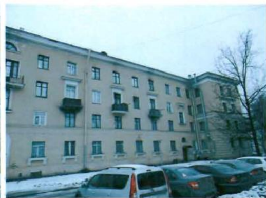
8. Фрагмент фасада. Вид с северо-востока.
