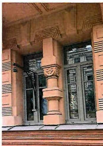
исторический рисунок, материал (дерево), цвет и оформление (полуколонки с фигурными перехватами) заполнения оконных проемов;
