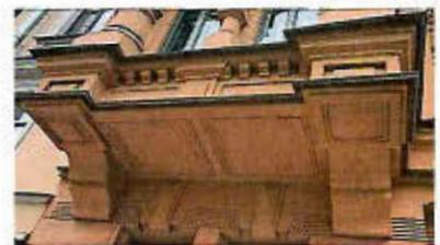
три балкона в одну световую ось – в уровне 3-го этажа эркером (многогранный в плане, с граненым основанием – центрального эркера, прямоугольные в плане – боковых эркером), с оштукатуренными ограждениями\* (опорные стойки в виде орнаментированных колонок, секции сквозного геометрического орнамента с растительными элементами);
