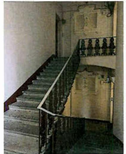
межэтажная двухмаршевая лестница ЛК с известняковыми ступенями по металлическим косоурам, с перильным литым металлическим ограждением (стойки растительно-цветочного рисунка с геометрическими элементами в неорусском стиле), профилированный деревянный поручень.
