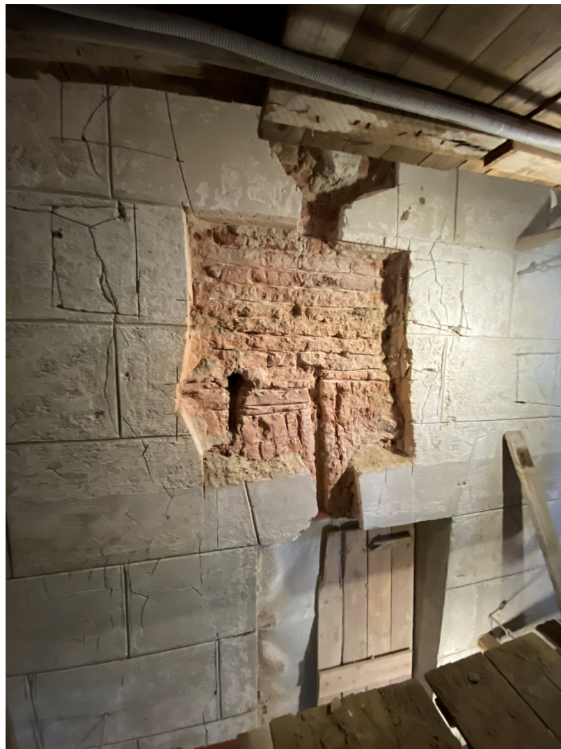
11. Юго-восточный лицевой фасад выявленного объекта культурного наследия «Главный корпус с 1-м солдатским корпусом, офицерским флигелем и Михайловское артиллерийское училище», расположенного по адресу: г. Санкт-Петербург, ул. Комсомола, д. 22, литера А. 06.12.2021
