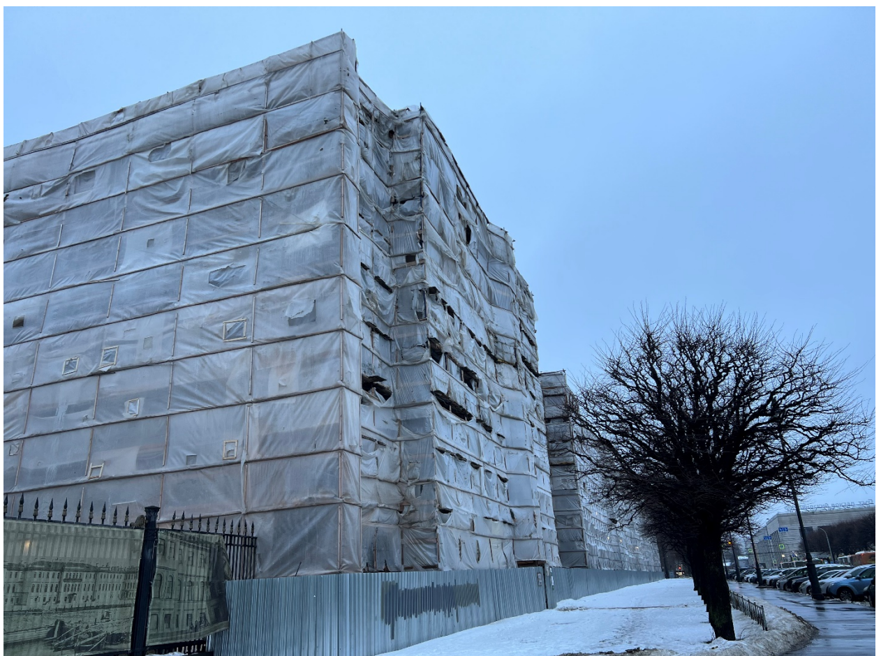
3. Юго-восточный лицевой фасад выявленного объекта культурного наследия «Главный корпус с 1-м солдатским корпусом, офицерским флигелем и Михайловское артиллерийское училище», расположенного по адресу: г. Санкт-Петербург, ул. Комсомола, д. 22, литера А. 06.12.2021
