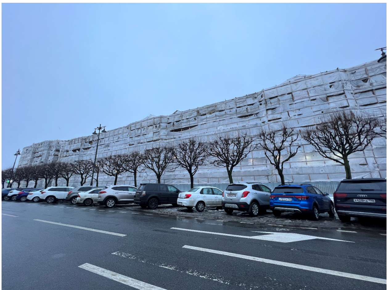
4. Юго-восточный лицевой фасад выявленного объекта культурного наследия «Главный корпус с 1-м солдатским корпусом, офицерским флигелем и Михайловское артиллерийское училище», расположенного по адресу: г. Санкт-Петербург, ул. Комсомола, д. 22, литера А. 06.12.2021
