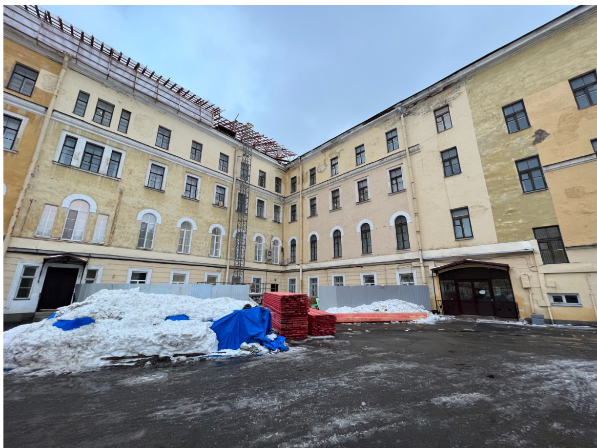
18. Юго-восточный дворовый фасад выявленного объекта культурного наследия «Главный корпус с 1-м солдатским корпусом, офицерским флигелем и Михайловское артиллерийское училище», расположенного по адресу: г. Санкт-Петербург, ул. Комсомола, д. 22, литера А. 06.12.2021
