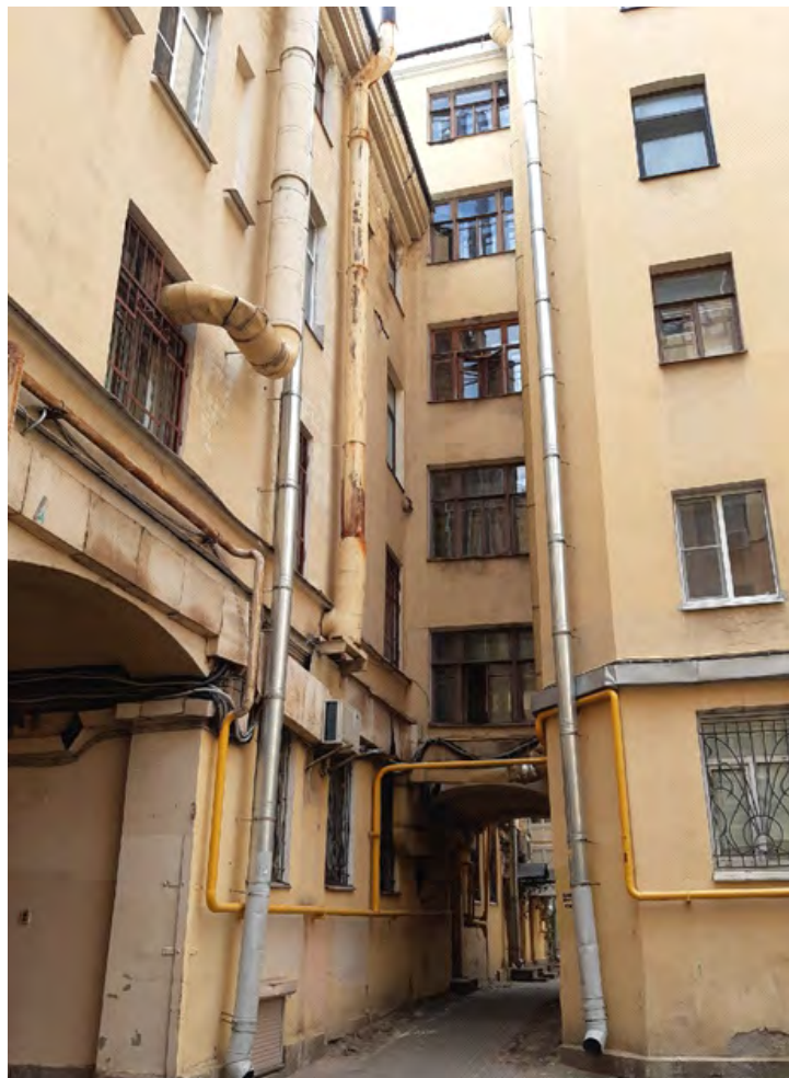
7. Дворовые фасады. Дата фотофиксации: 02.09.2020 г.
