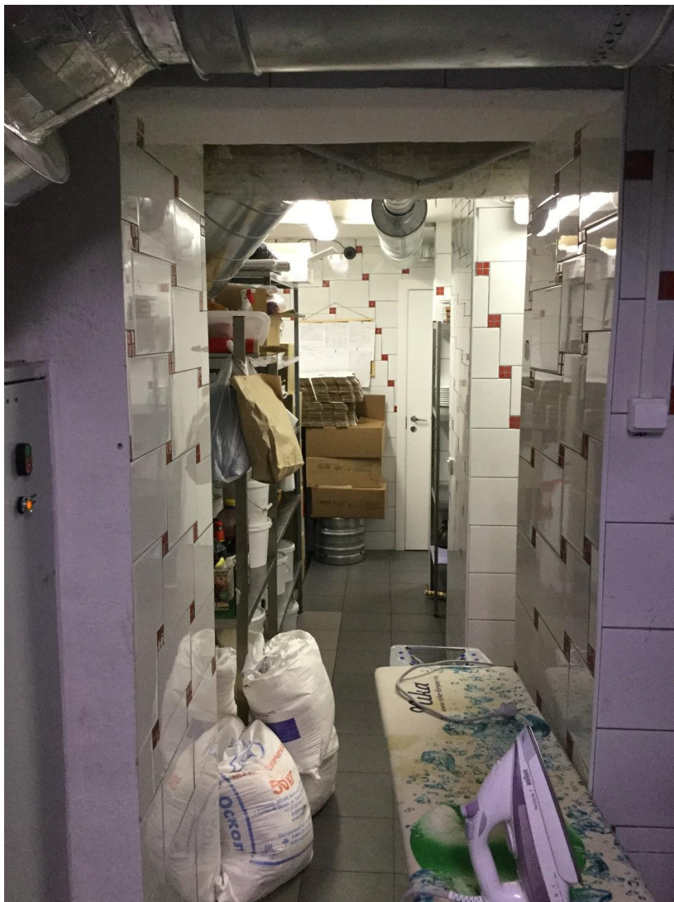
24. Интерьеры здания. Фрагмент помещения 40-Н (17) Дата съемки: 02.09.2020
