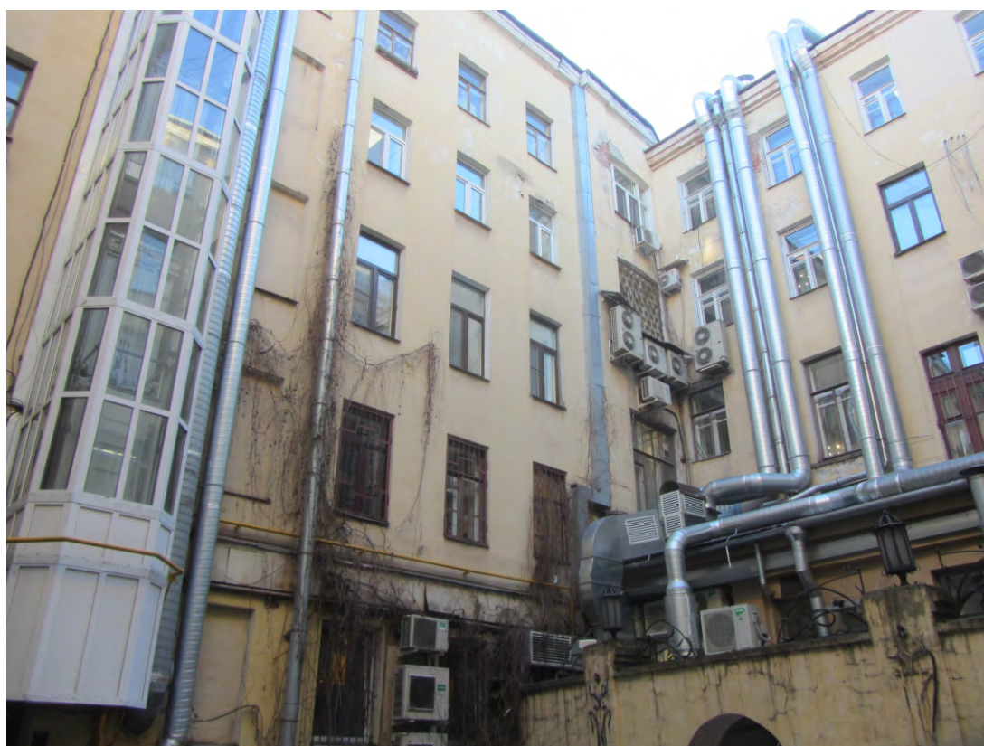
8. Северо-западный вид на дворовые фасады. Дата фотофиксации: 02.09.2020 г.
