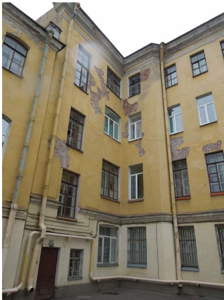
14. Объект культурного наследия регионального значения «Академия Михайловская артиллерийская, где преподавали ученые Ленц Э.Х., Остроградский М.В., Петрушевский В.Ф.» по адресу: Санкт-Петербург, улица Комсомола, дом 22, литера А. Дворовый фасад здания. Фрагмент. Оконные заполнения (деревянные, металлопластиковые).
