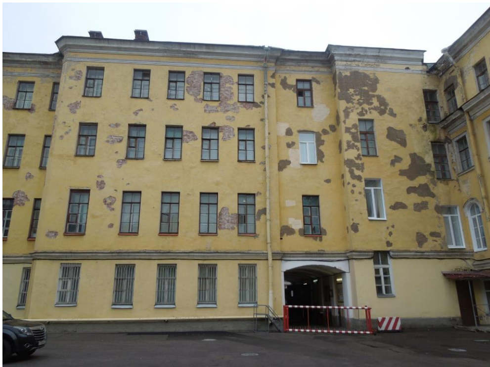
12. Объект культурного наследия регионального значения «Академия Михайловская артиллерийская, где преподавали ученые Ленц Э.Х., Остроградский М.В., Петрушевский В.Ф.» по адресу: Санкт-Петербург, улица Комсомола, дом 22, литера А. Дворовый фасад. Вид в северном направлении.
