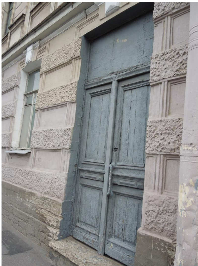
10. Объект культурного наследия регионального значения «Академия Михайловская артиллерийская, где преподавали ученые Ленц Э.Х., Остроградский М.В., Петрушевский В.Ф.» по адресу: Санкт-Петербург, улица Комсомола, дом 22, литера А. Лицевой фасад по улице Академика Лебедева. Историческое деревянное филеичатое дверное заполнение.
