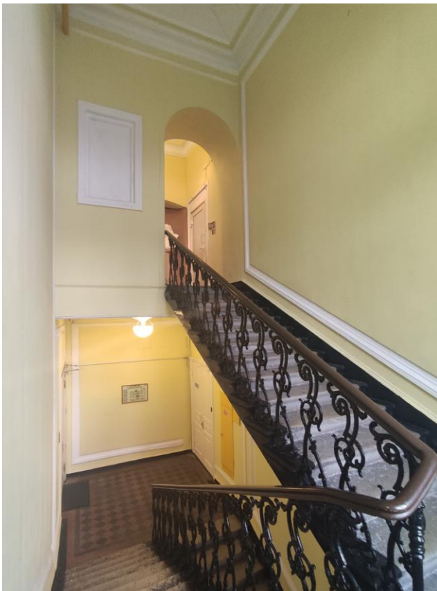
Фото 22. Лестничная площадка (на отм. +5.800)
