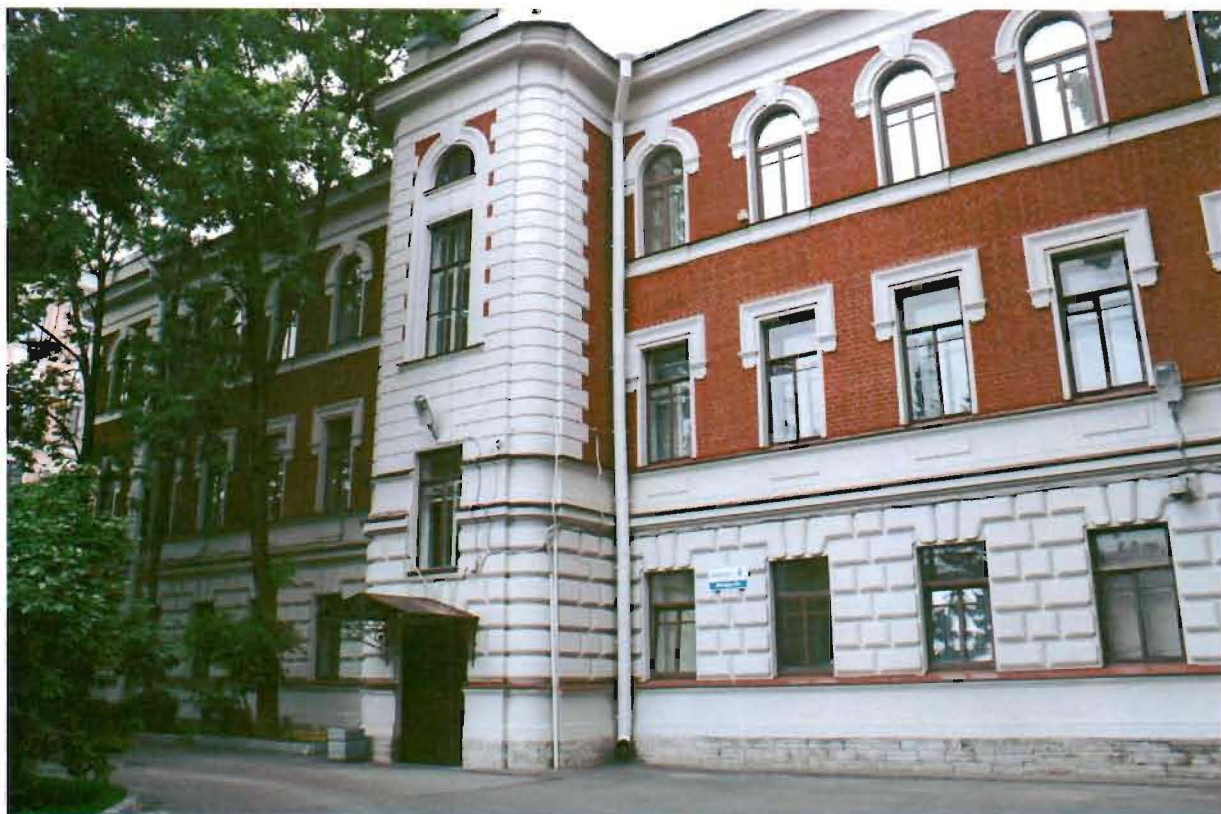
Фото №2. Вид на южный фасад со стороны внутреннего двора.
