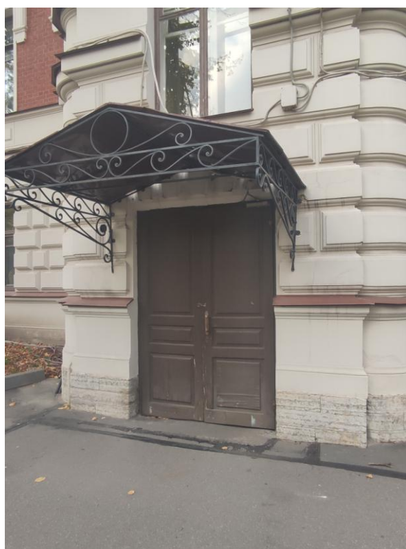
Фото 6. Фрагмент фасада объекта культурного наследия федерального значения «Жилой дом палаты мер и весов. Здесь в 1897-1907 гг. жил и работал химик Менделеев Д.И.», входное дверное заполнение
