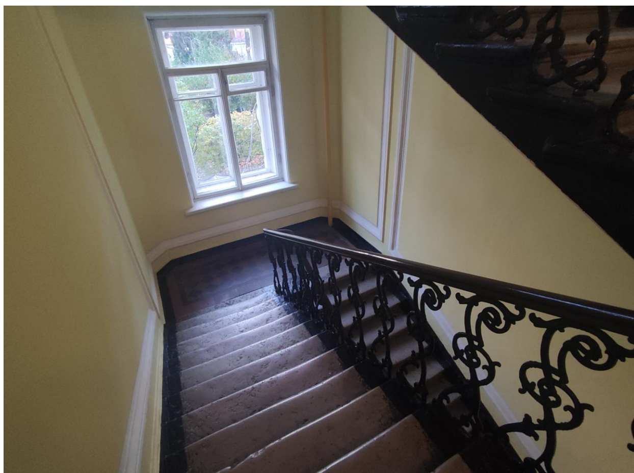
Фото 24. Лестничная площадка (на отм. +7.800)
