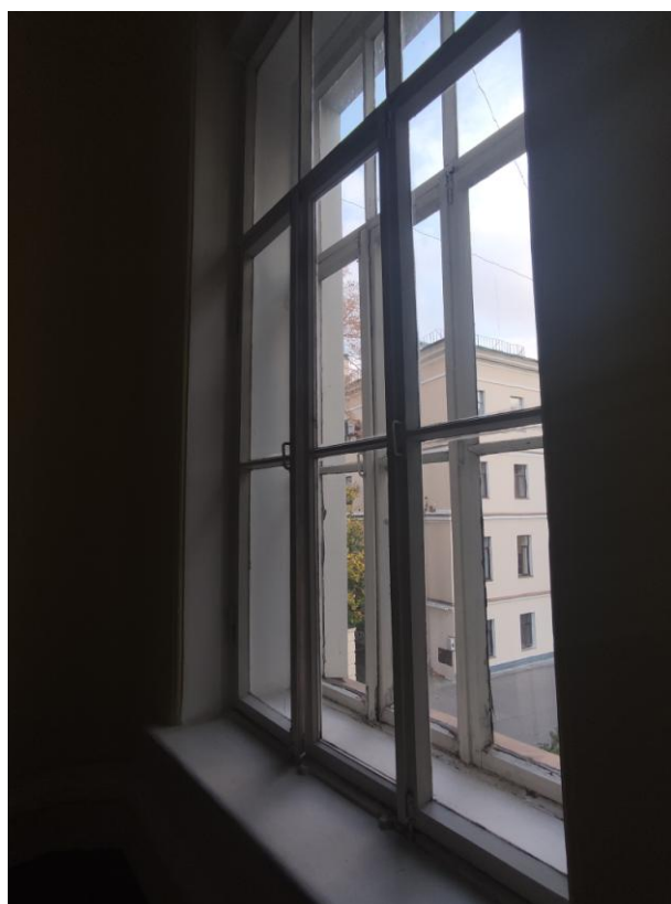
Фото 21. Лестничная площадка (на отм. +5.800), оконное заполнение
