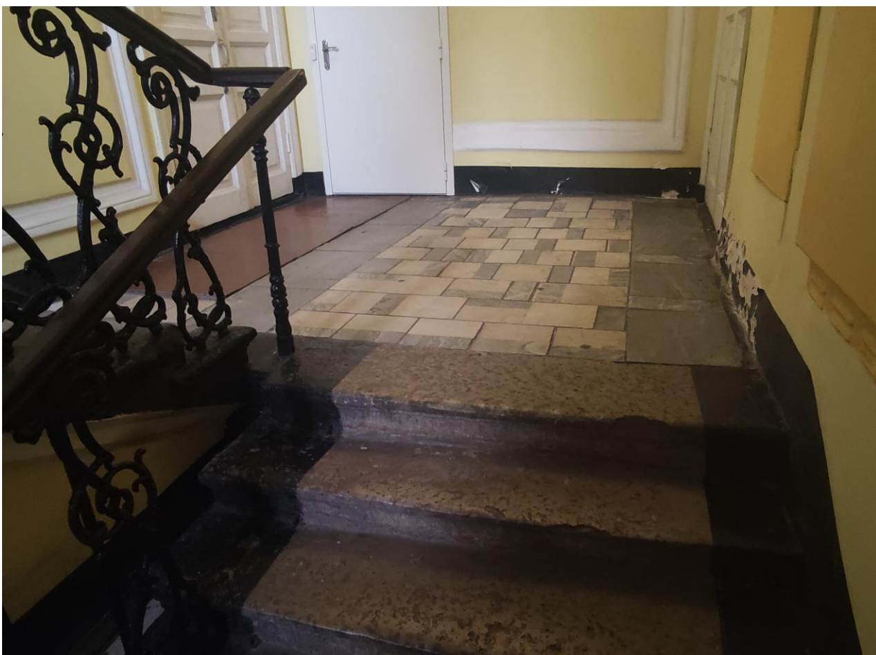
Фото 11. Лестничная площадка, напольная плитка первый этаж
