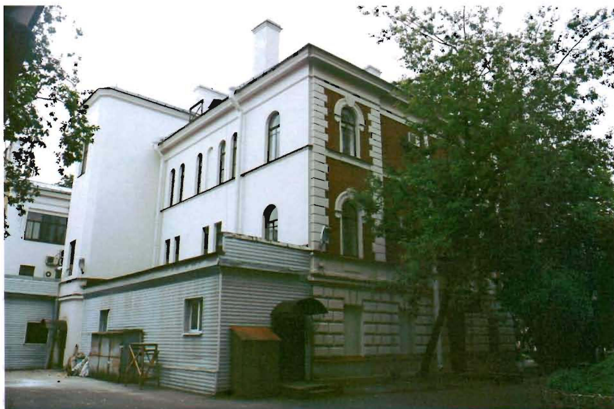
Фото №3. Вид на западный и северный фасады со стороны внутреннего двора.
