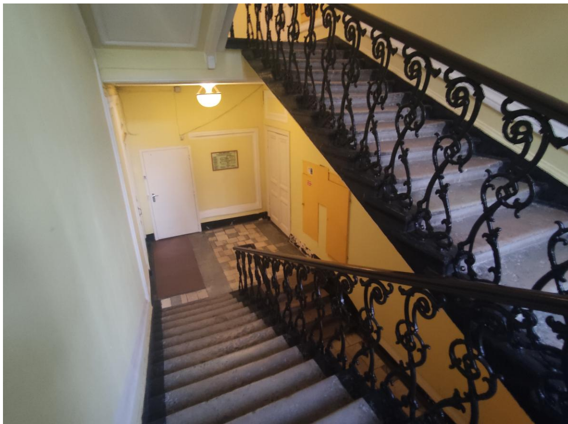
Фото 15. Лестничная площадка (на отм. +1.950)
