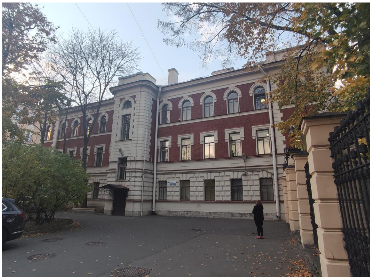
Фото 2. Фрагмент фасада объекта культурного наследия федерального значения «Жилой дом палаты мер и весов. Здесь в 1897-1907 гг. жил и работал химик Менделеев Д.И.»
