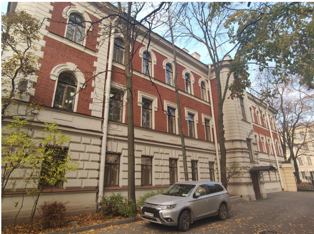
Фото 1. Фрагмент фасада объекта культурного наследия федерального значения «Жилой дом палаты мер и весов. Здесь в 1897-1907 гг. жил и работал химик Менделеев Д.И.»
