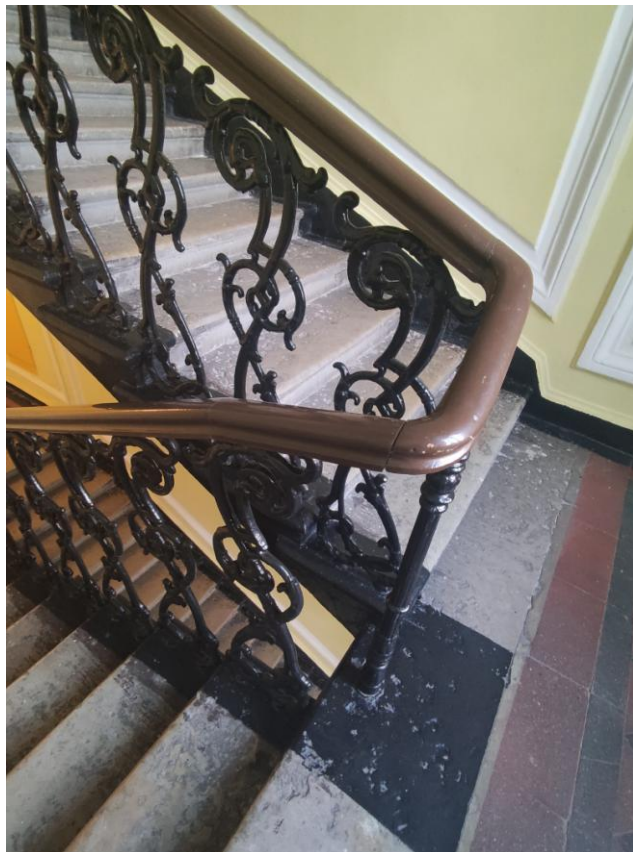
Фото 23. Лестничная площадка (на отм. +5.800), ограждение лестницы
