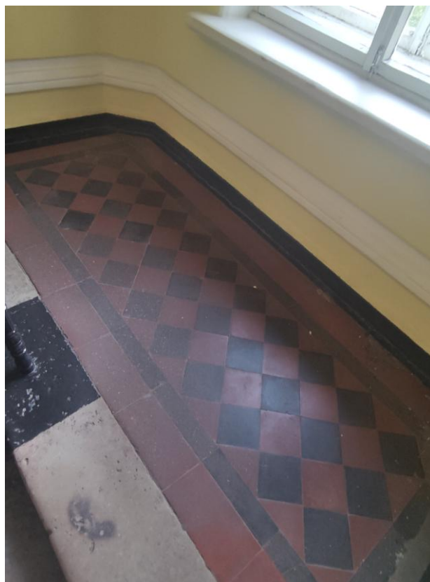
Фото 14. Лестничная площадка (на отм. +1.950), напольное покрытие
