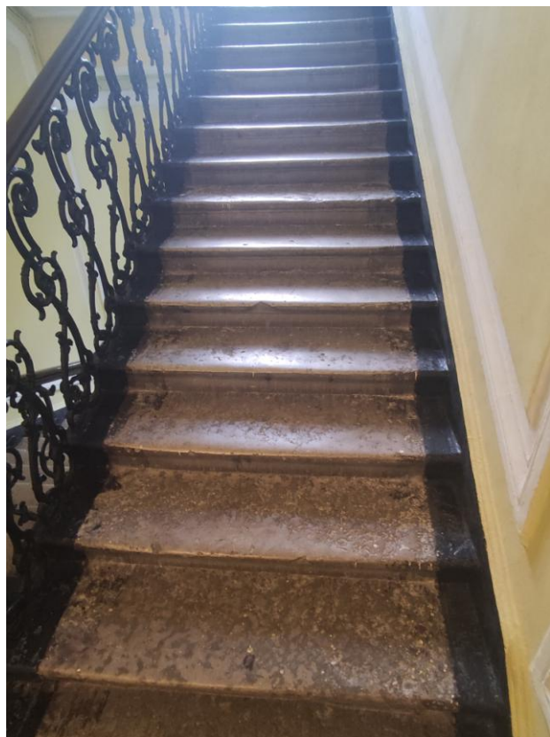
Фото 19. Лестничная площадка, ступени лестницы
