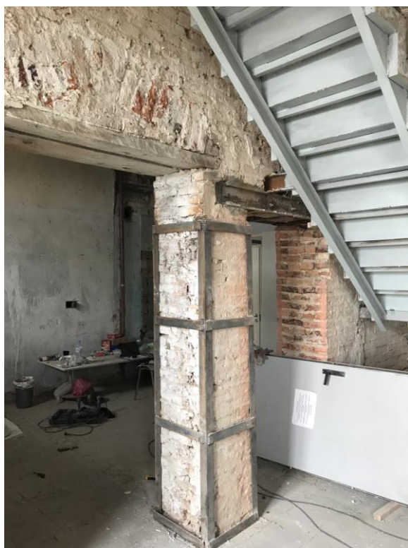
Фото 6. Интерьер квартиры №1, расположенной в объекте культурного наследия регионального значения «Дом № 48», входящем в состав объекта культурного наследия регионального значения «Дома П.К. Ферзена (А.Я. Прозорова)», 1 эт.
