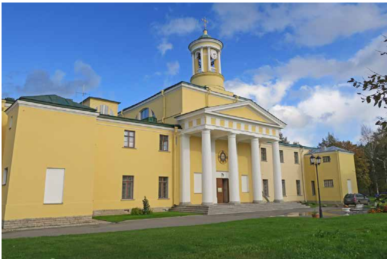
Ил. 73. Павловск. Церковь Св. Марии Магдалины. Западный фасад. Фотография 2016 г.
