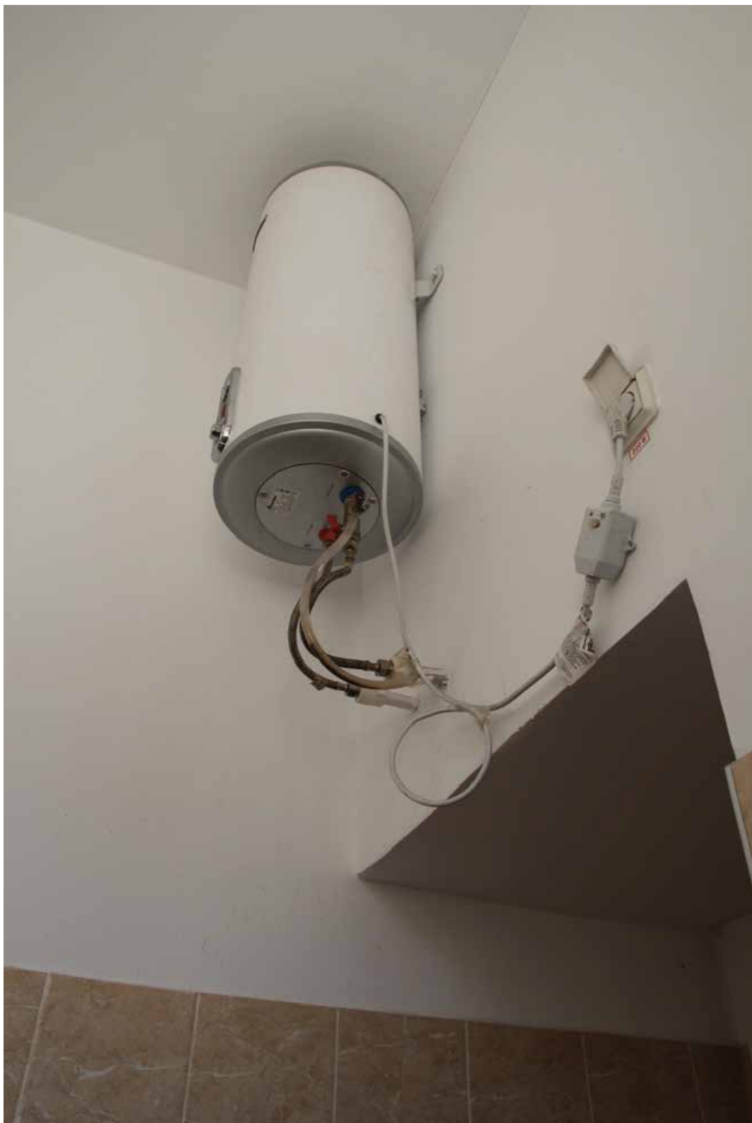
Фото №18. Общий вид санузла
