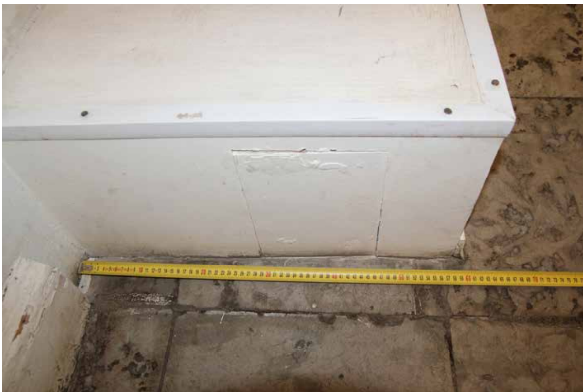
Фото №11. Известняковые плиты пола.
