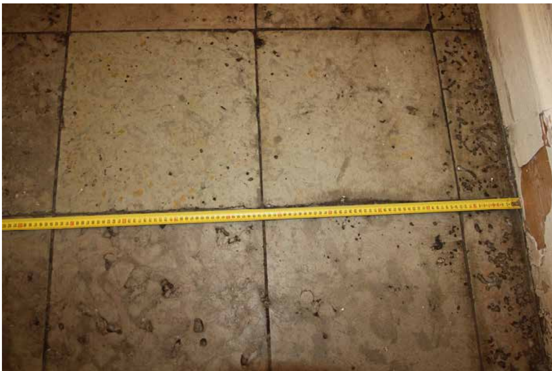
Фото №10. Известняковые плиты пола.
