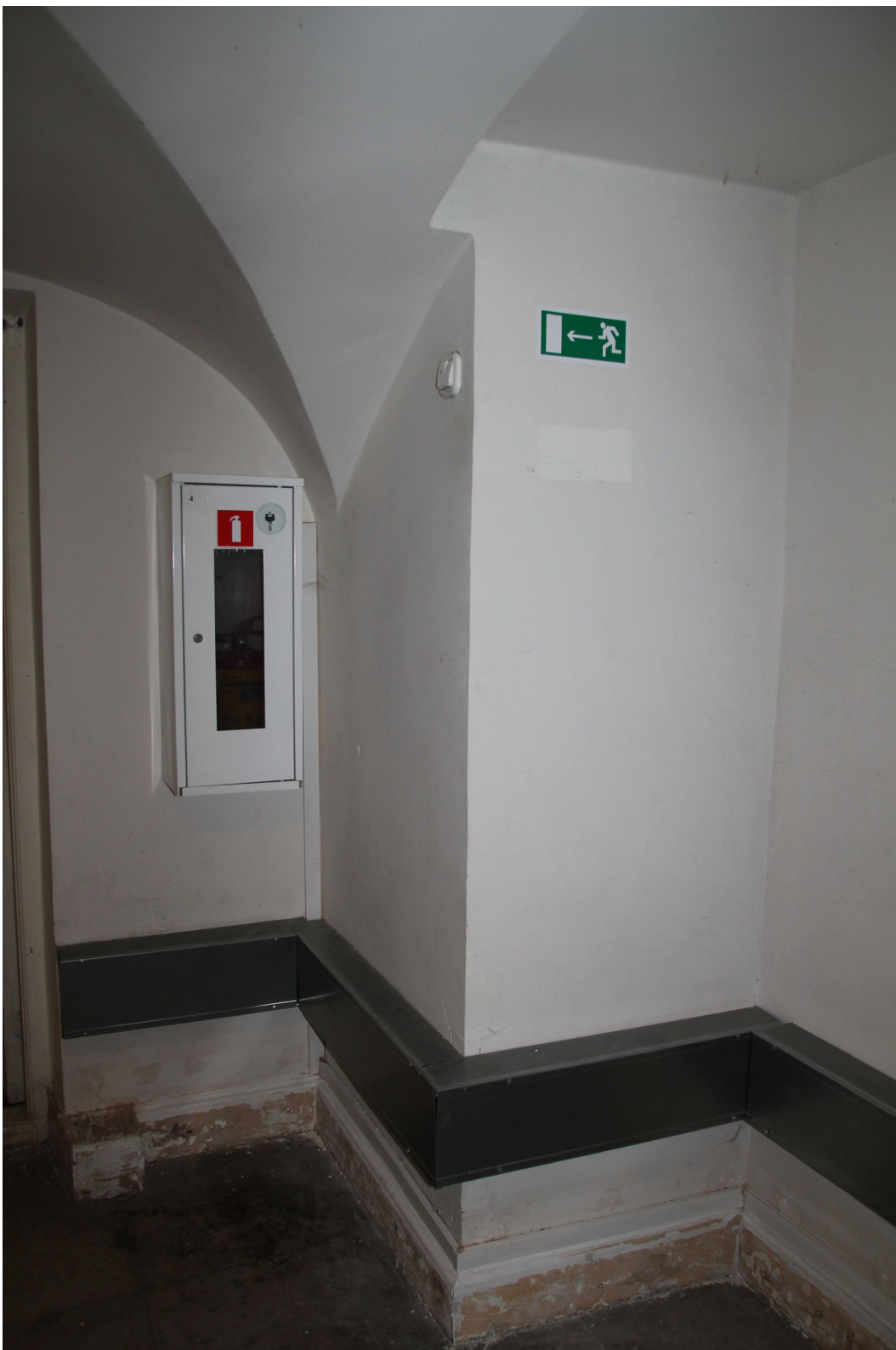
Фото №9. Общий вид на дверь и угол свода под лестницей.
