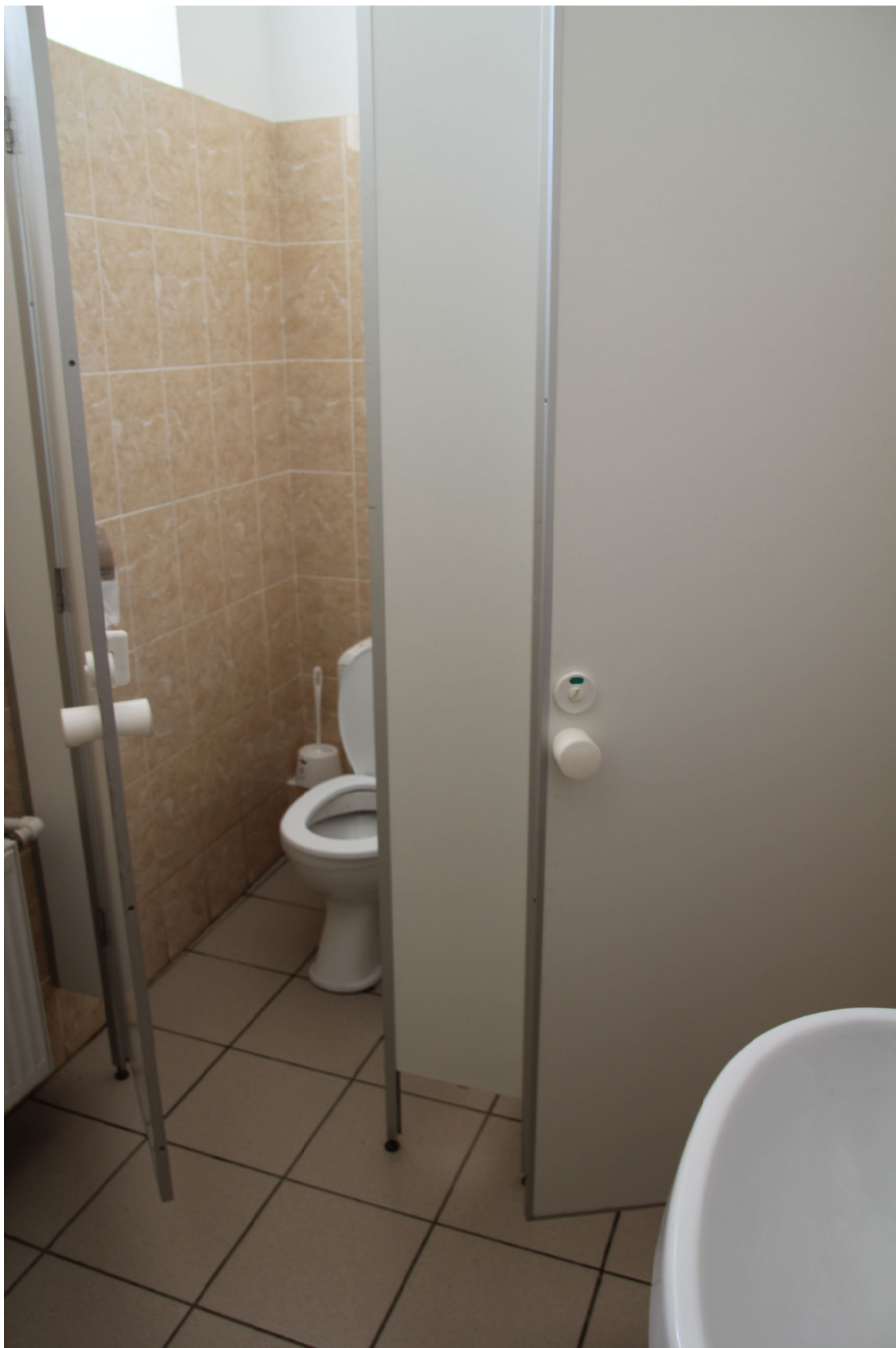
Фото №15. Общій вид санузла
