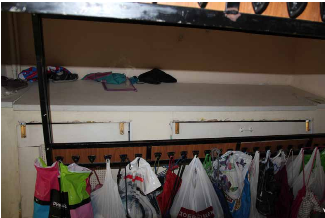
Фото №4. Помещение гардероба. Ревизионные лючки.
