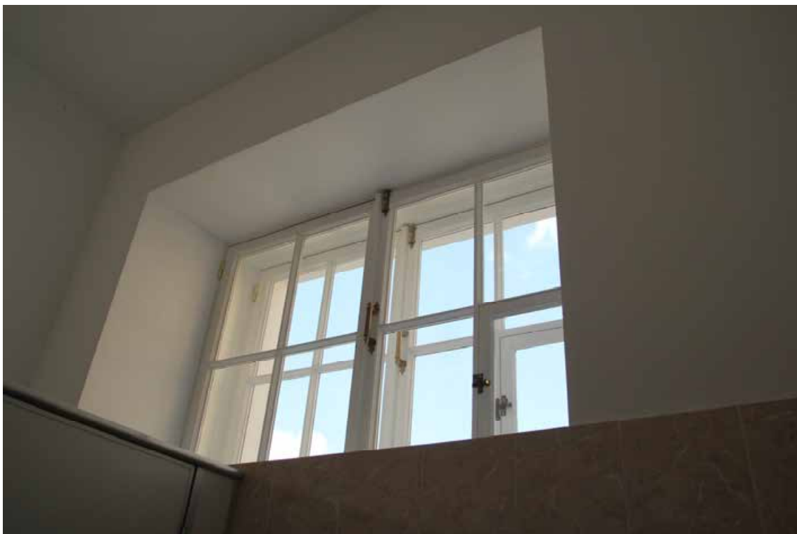
Фото №16. Общий вид санузла.
