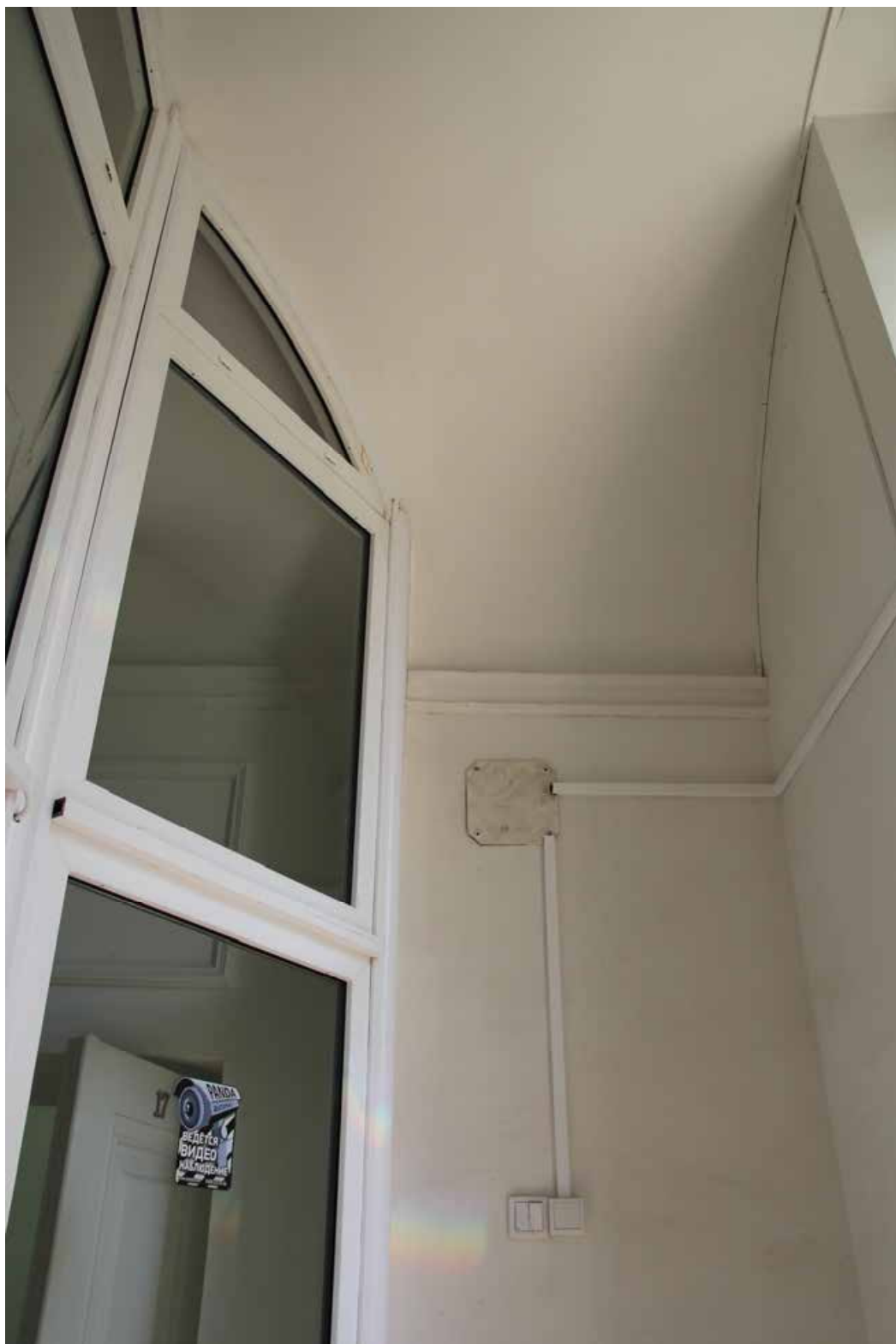
Фото №1. Тамбур внутри
