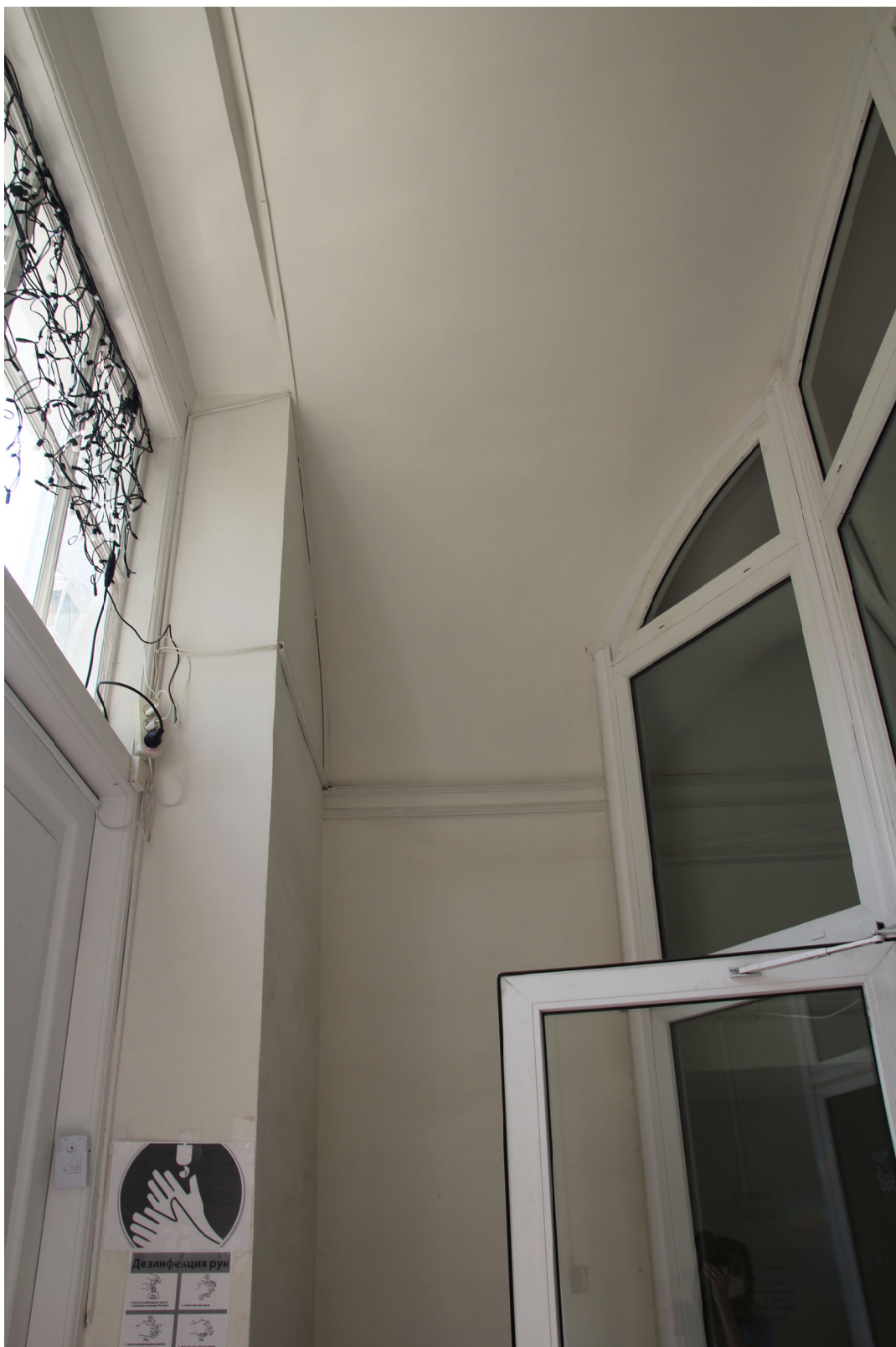
Фото №2. Тамбур внутри
