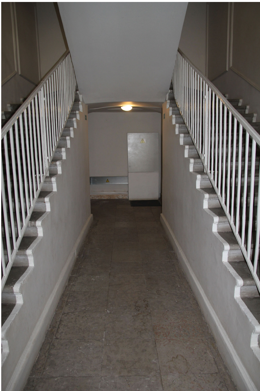
Фото №5. Общий вид на лестницу
