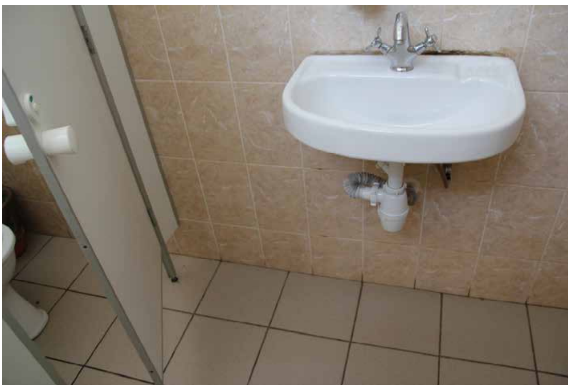
Фото №17. Общий вид санузла.
