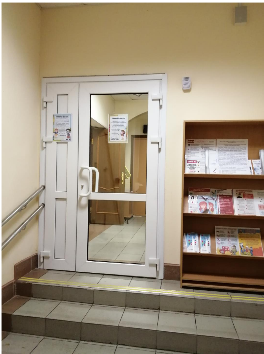
Фото 1. Объект культурного наследия регионального значения «Комплекс жилых домов по ул. Урицкого», расположенный по адресу: Санкт-Петербург, город Кронштадт, Посадская улица, дом 35, литера А; дом 43, литера А; дом 52, литера А; дом 54, литера Б. Здание по адресу: ул. Посадская, дом 43, литера А. Пом. № 2-Н(1), 1-й этаж.
