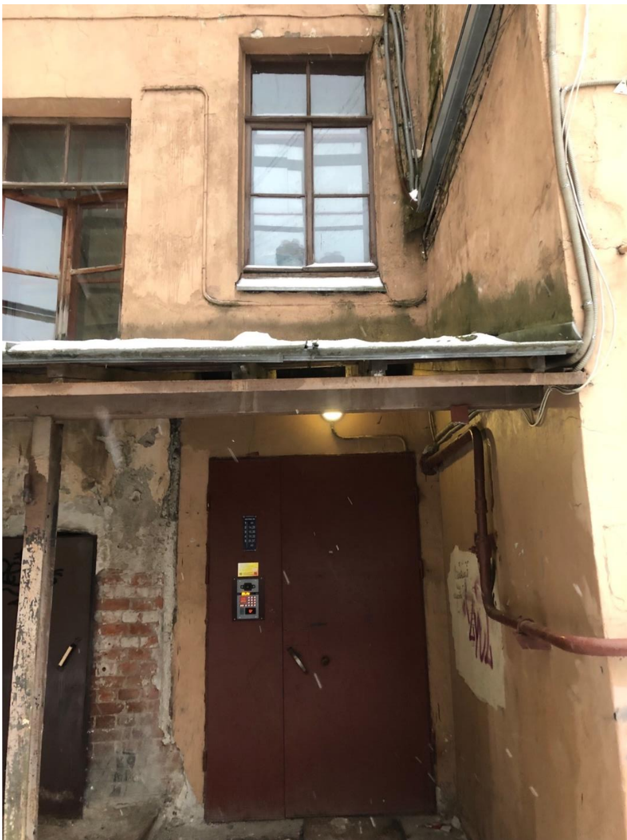
Фото 7. Вход на лестницу, через которую осуществляется вход в квартиру № 35.
