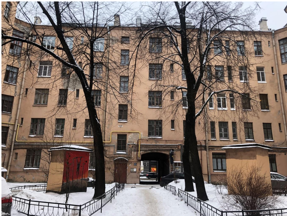
Фото 3. Северный дворовый фасад лицевого корпуса.
