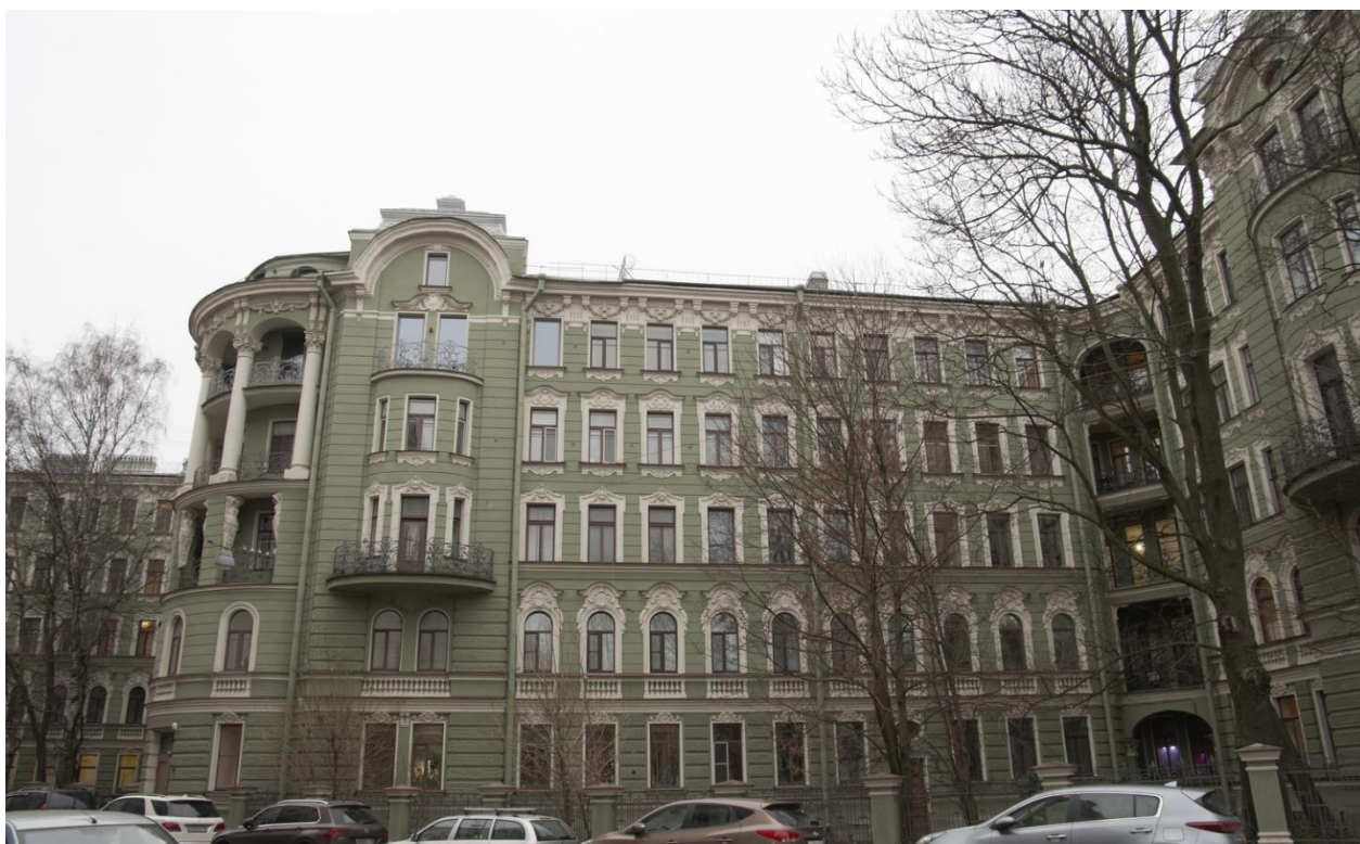
Фото 12. Фрагмент лицевого фасада по Пушкарскому переулку
