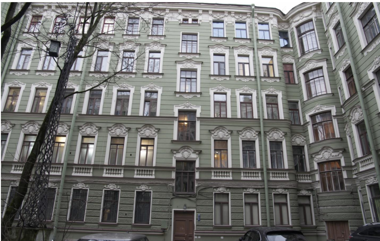
Фото 7. Фрагмент северо-западного и северо-восточного фасада двора-курдонера.
