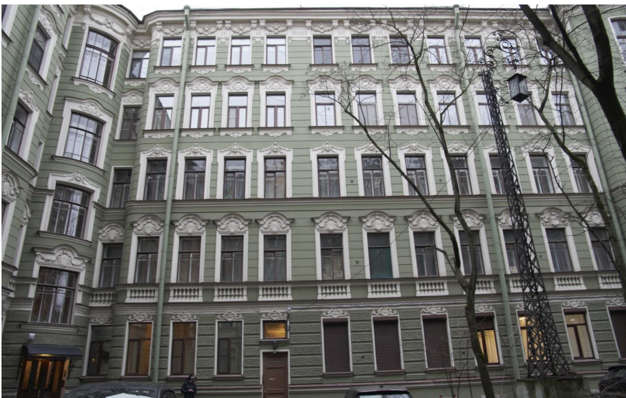
Фото 8. Фрагмент северо-восточного фасада двора с окнами квартиры № 34
