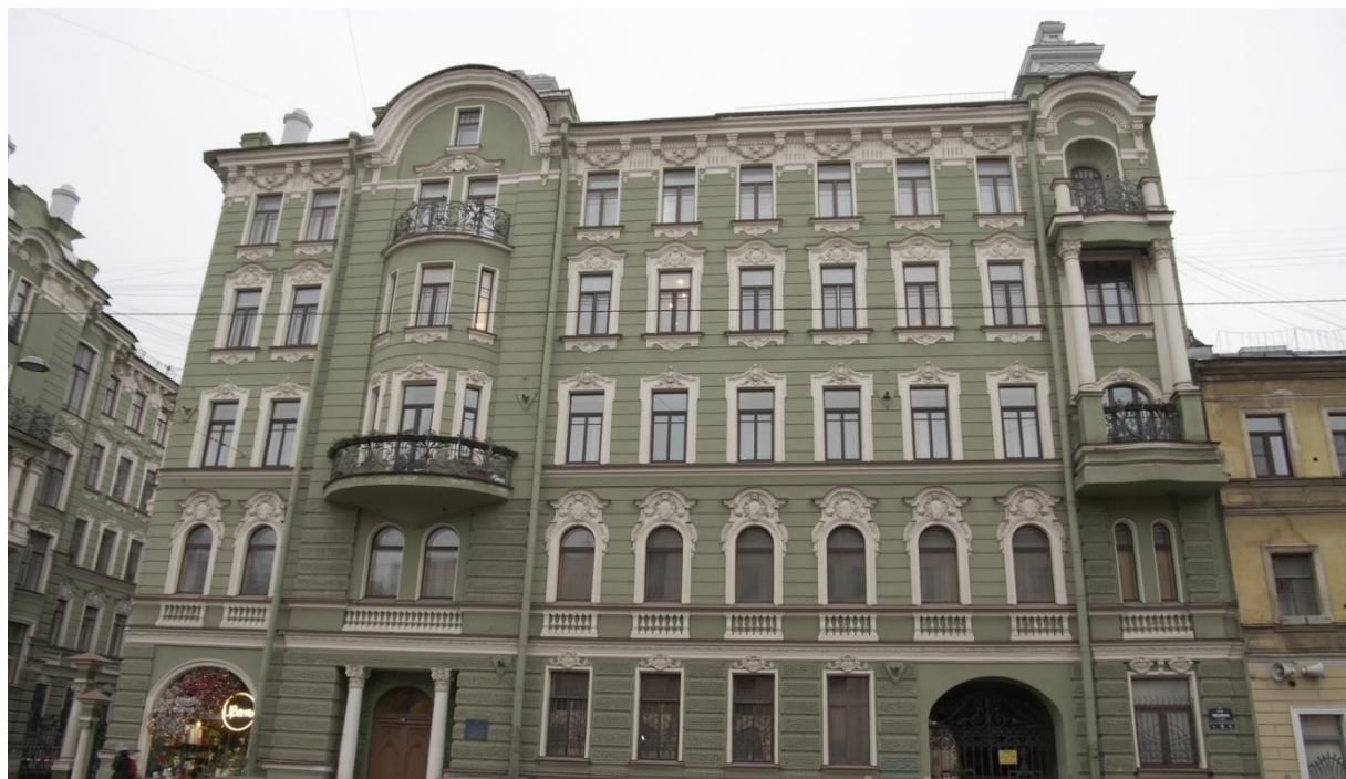
Фото 3. Фрагмент фасада по ул. Ленина (правая часть)
