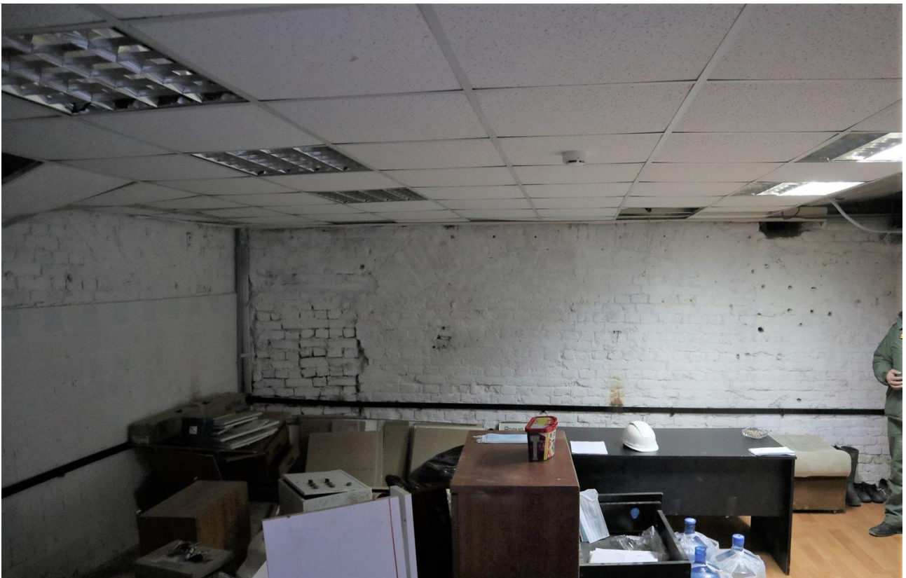
Фото 1.52. 1 этаж, помещение 6Н (7).
