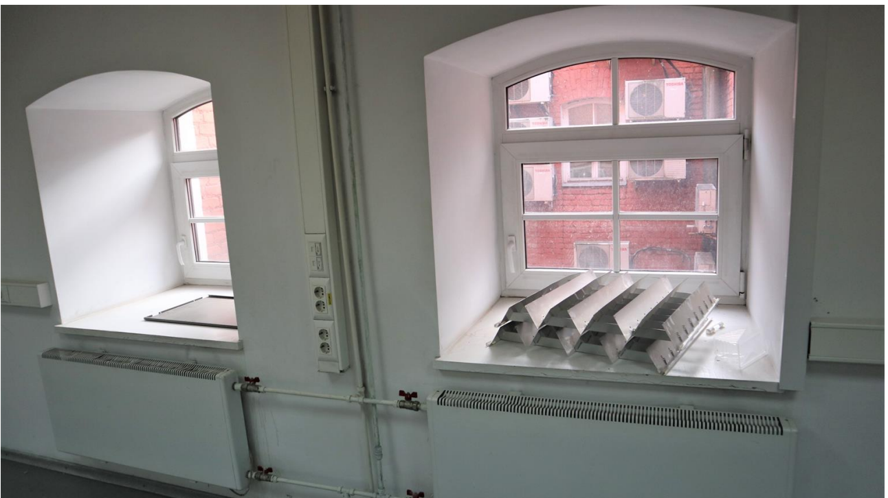
Фото 4.18. 4 этаж, помещение 10Н (22).
