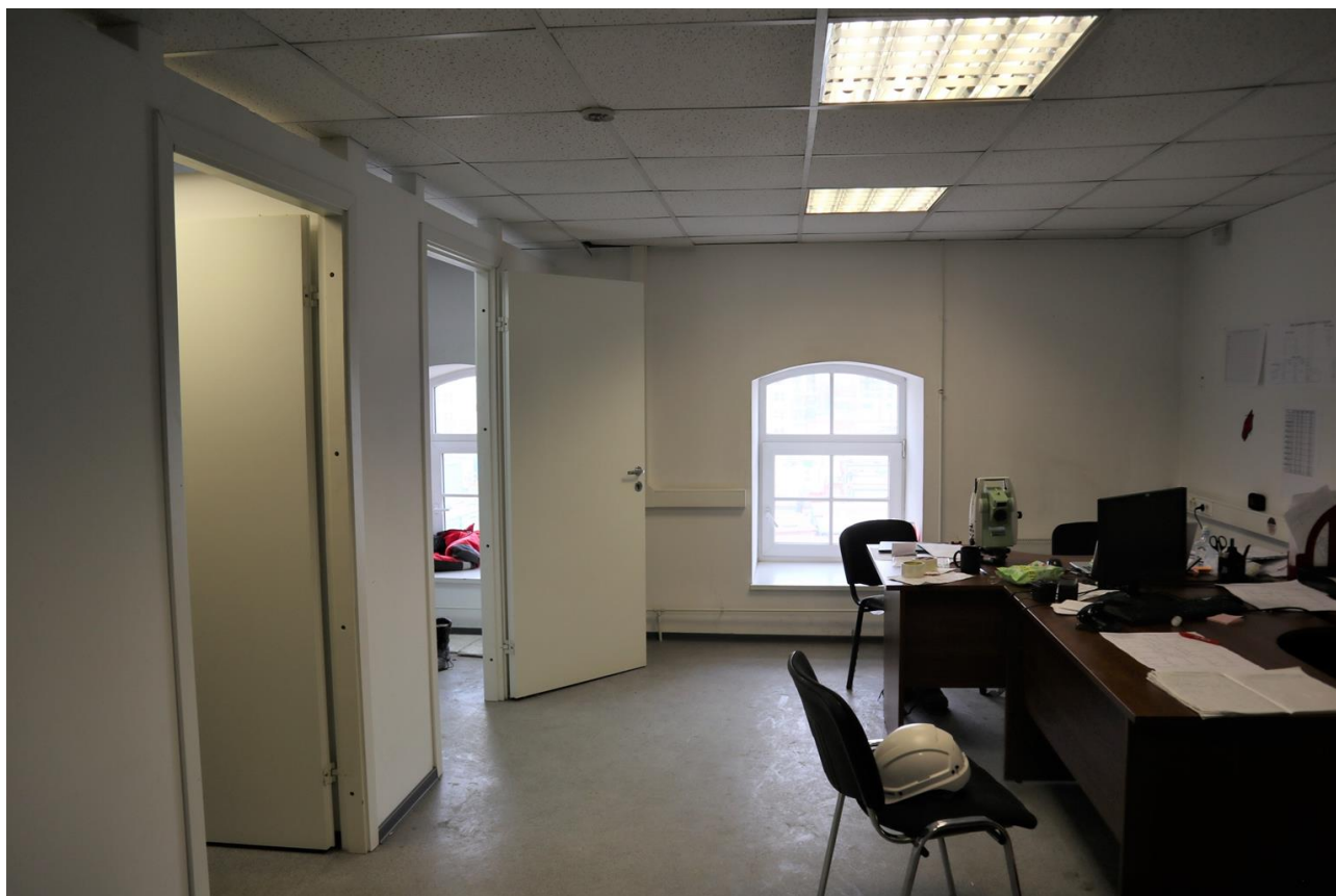
Фото 4.7. 4 этаж, помещение 10Н (28).
