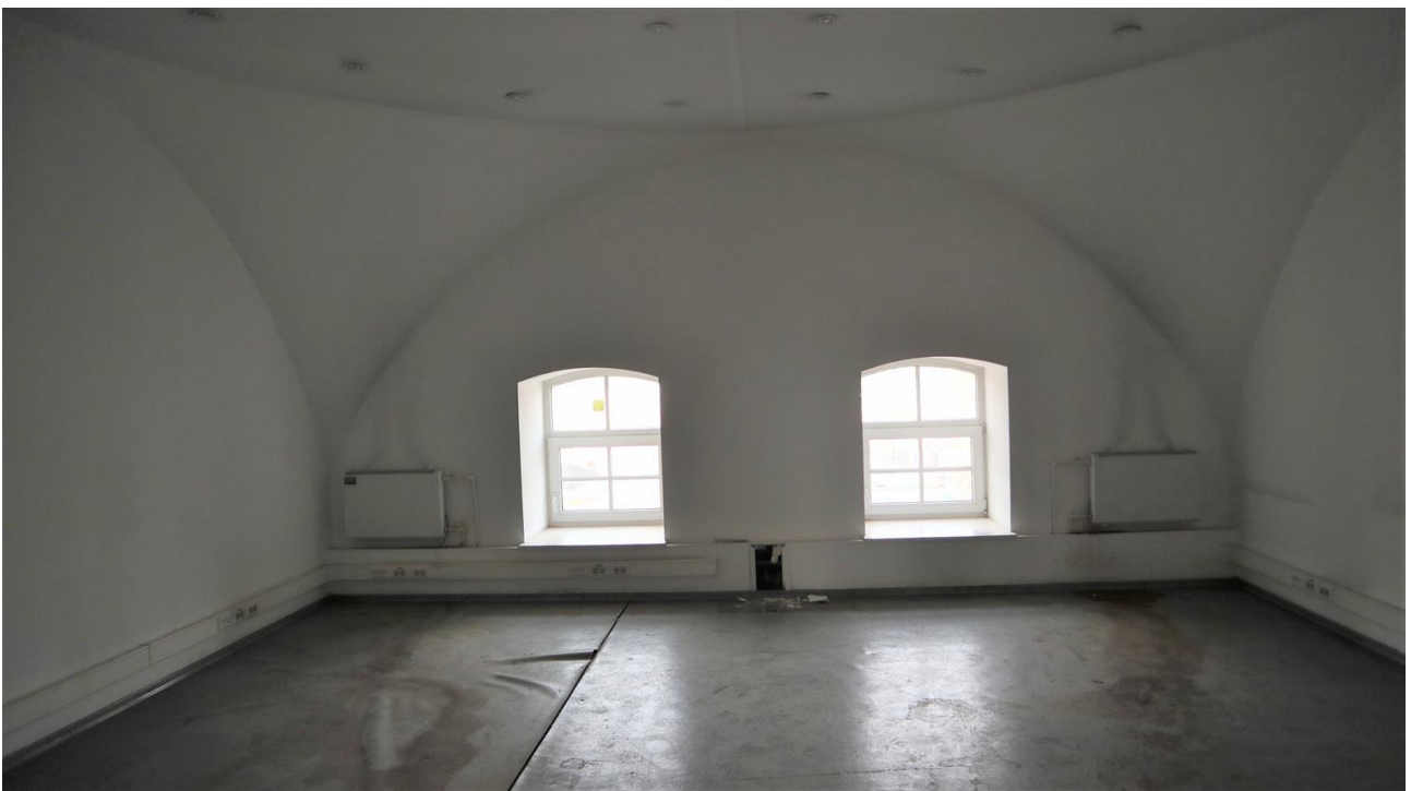
Фото 5.4. 5 этаж, помещение 10Н (38).
