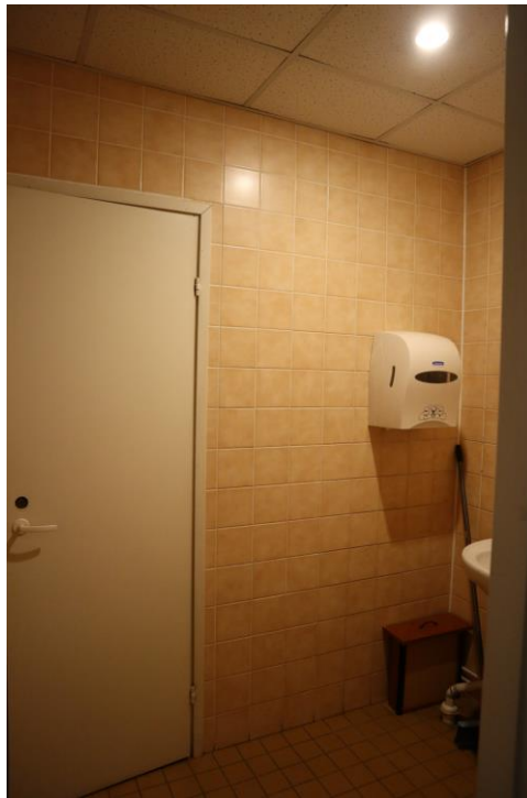
Фото 3.7. 3 этаж, помещение 8Н (18).
