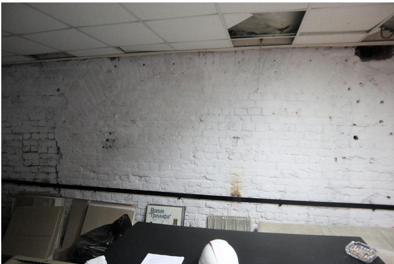
Фото 1.53. 1 этаж, помещение 6Н (7).
