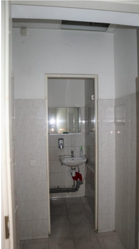
Фото 1.15. 1 этаж, помещение 1Н (8).
