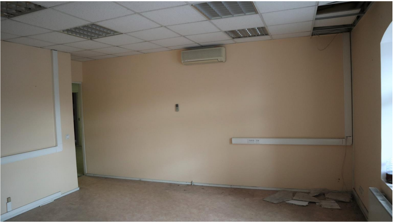
Фото 4.47. 4 этаж, помещение 10Н (6).
