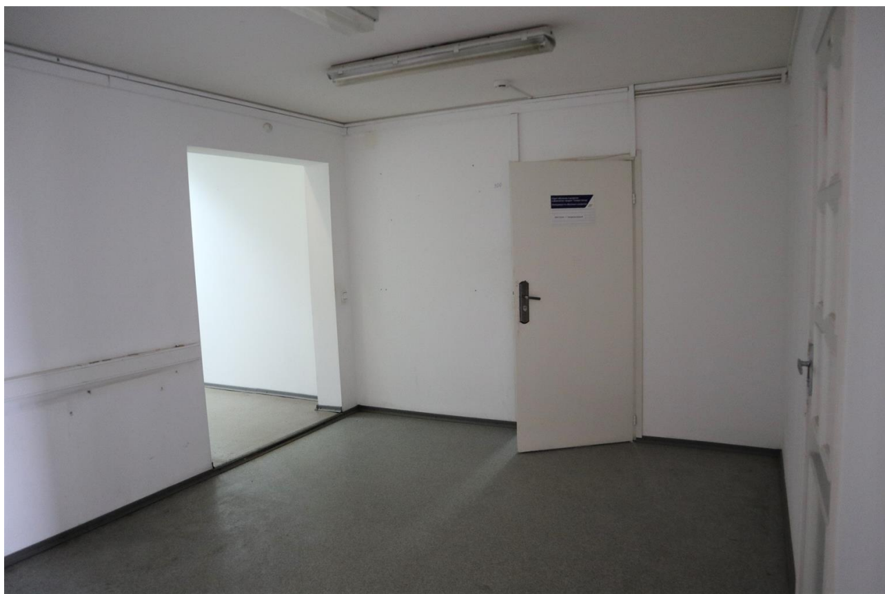
Фото 3.30. 3 этаж, помещение 8Н (11).
