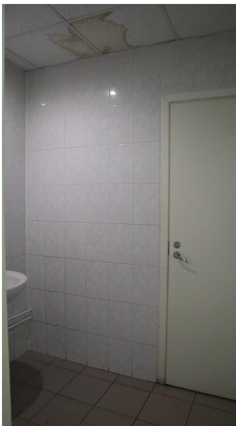
Фото 5.9. 5 этаж, помещение 10Н (46).
