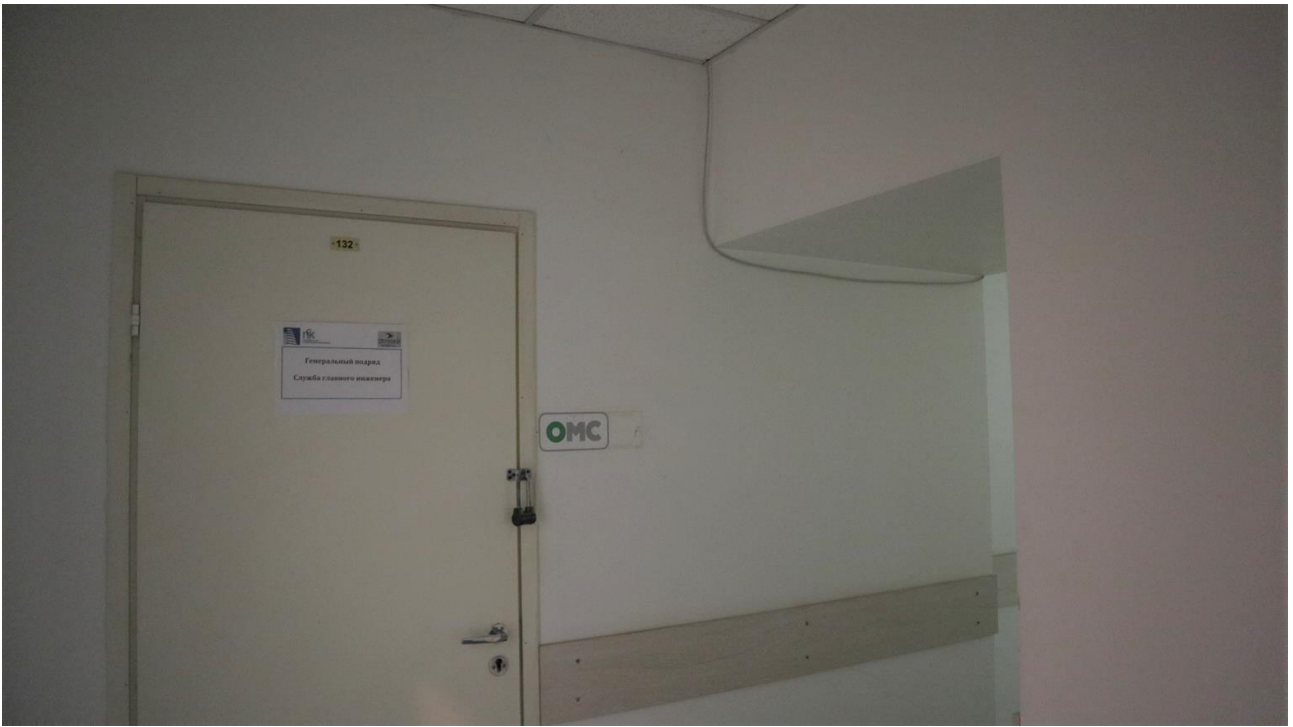
Фото 1.51. 1 этаж, помещение 2Н (4).
