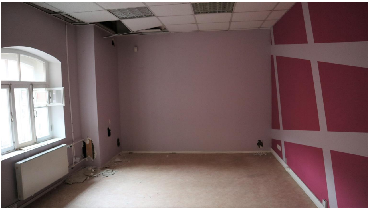
Фото 4.42. 4 этаж, помещение 10Н (4).
