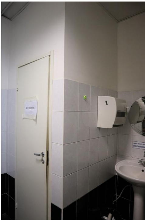
Фото 2.51. 2 этаж, помещение 7Н (22).
