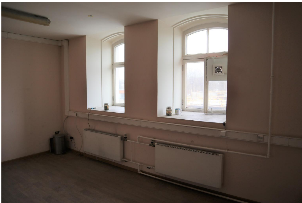
Фото 3.48. 3 этаж, помещение 8Н (10).
