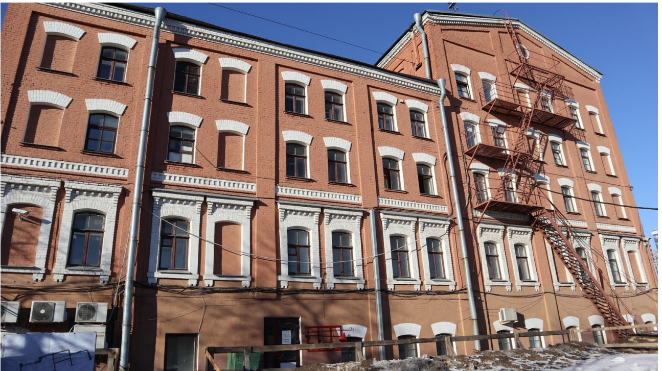
Фото 4. Восточный фасад со стороны улицы Бабушкина.
