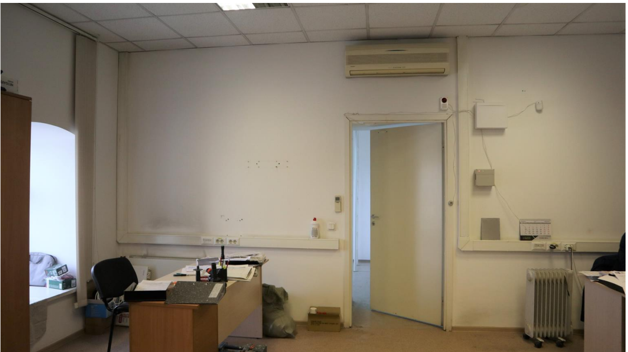
Фото 5.20. 5 этаж, помещение 10Н (41).
