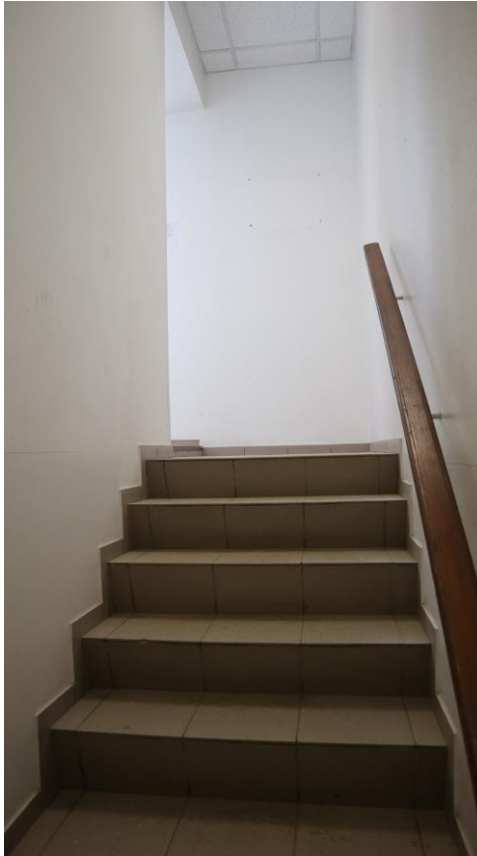
Фото 4.51. 4 этаж, помещение 10Н (49), лестница двухмаршевая, в северо-западной части здания, на плане ПИБ от 24.12.2018 не обозначена.
