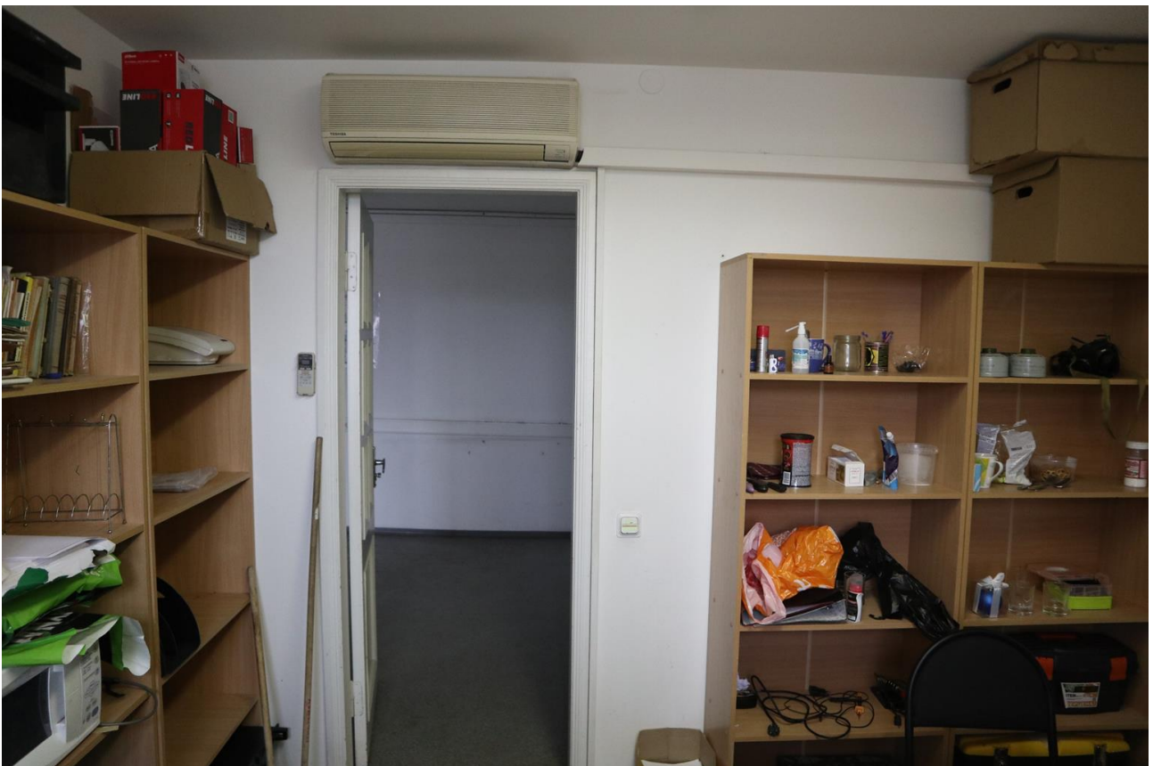
Фото 3.38. 3 этаж, помещение 8Н (13).
