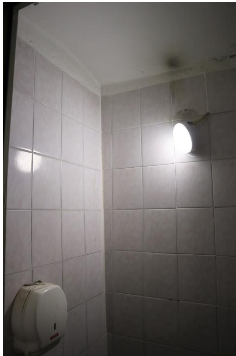
Фото 1.66. 1 этаж, помещение 6Н (5).
