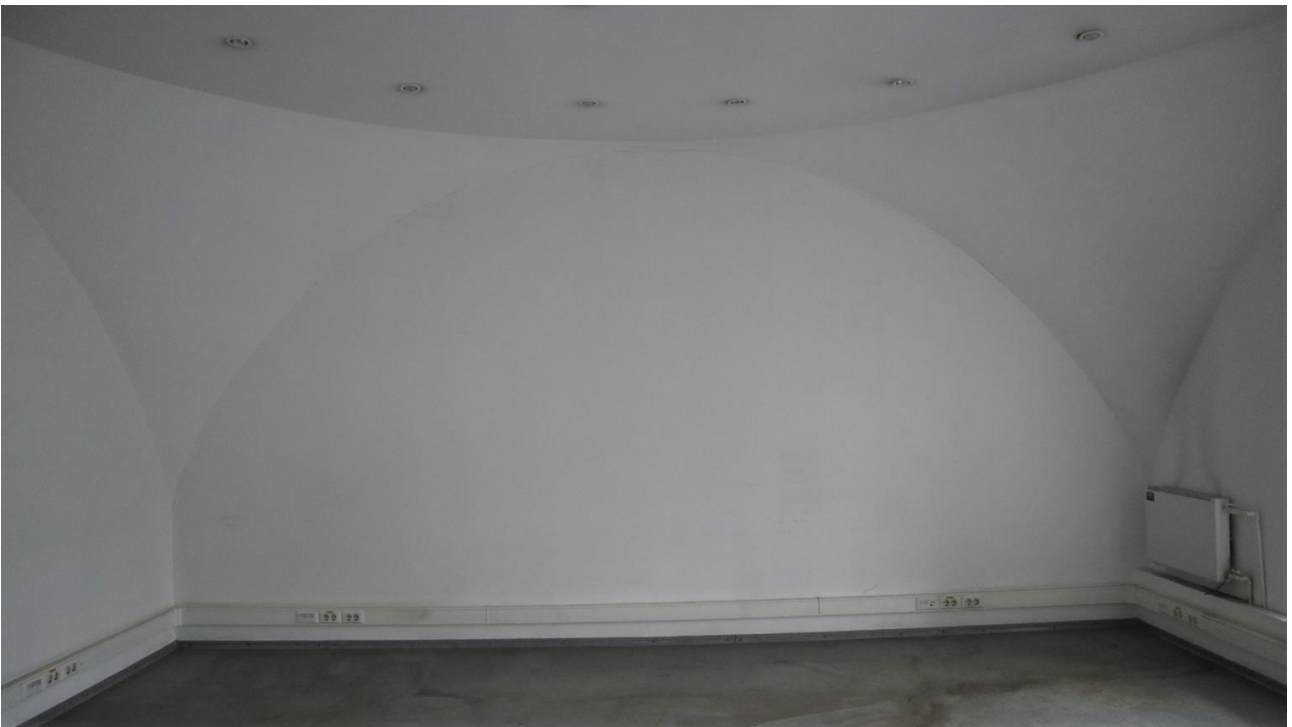
Фото 5.6. 5 этаж, помещение 10Н (38).
