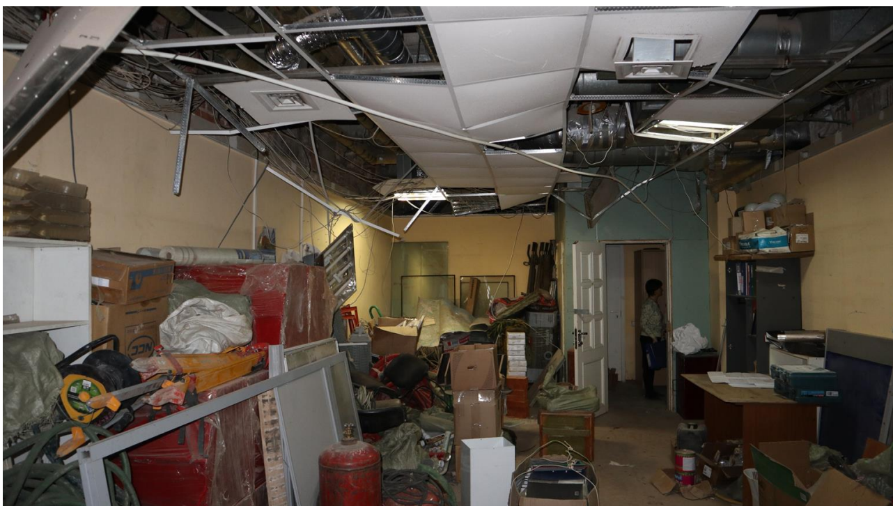
Фото 1.38. 1 этаж, помещение 5Н (1).
