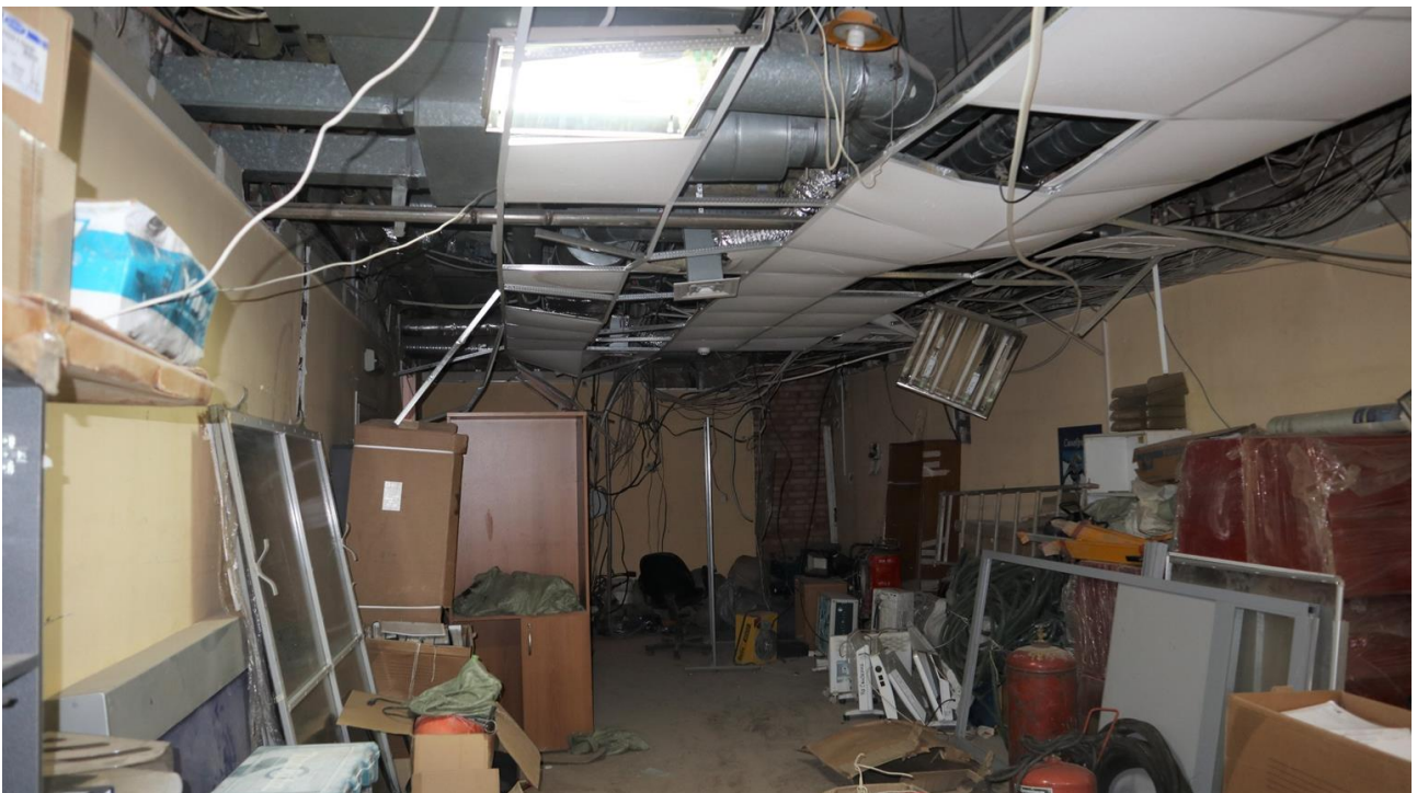
Фото 1.36. 1 этаж, помещение 5Н (1).
