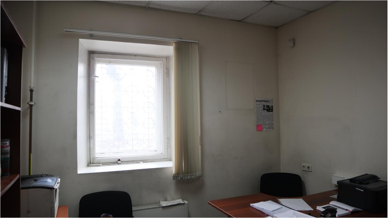
Фото 1.25. 1 этаж, помещение 1Н (5).
