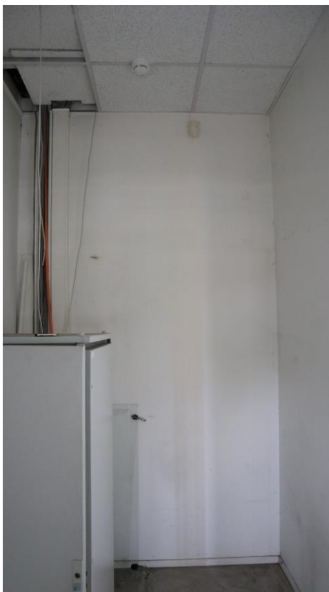
Фото 5.22. 5 этаж, помещение 10Н (42).
