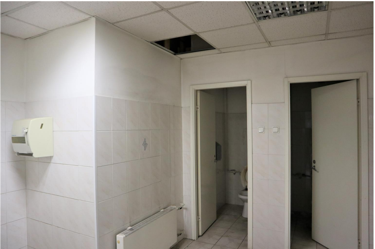
Фото 4.3. 4 этаж, помещение 10Н (34).
