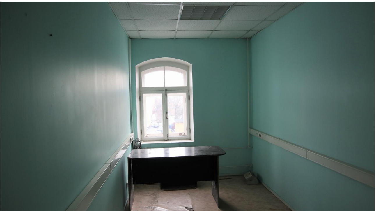
Фото 4.28. 4 этаж, помещение 10Н (10).
