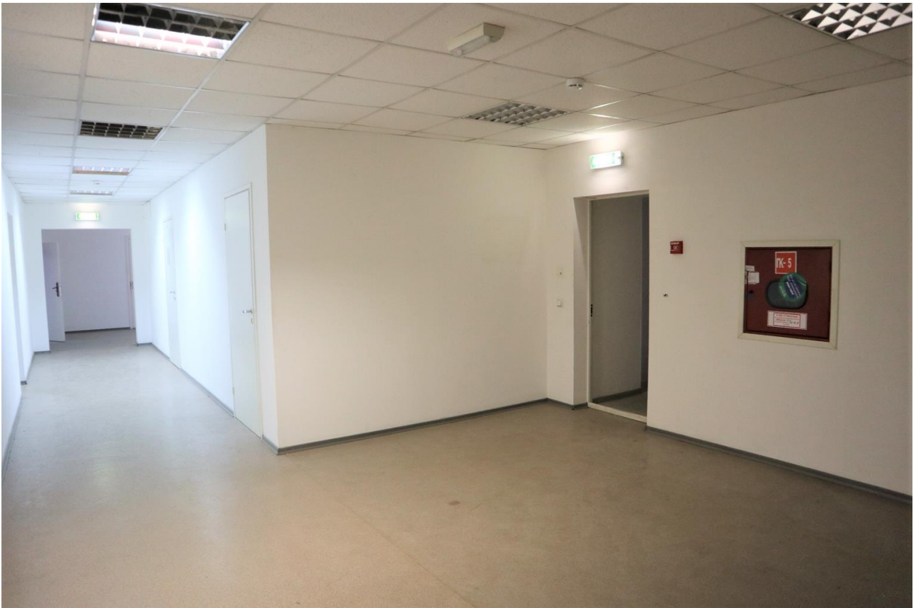
Фото 3.5. 3 этаж, помещение 8Н (17).
