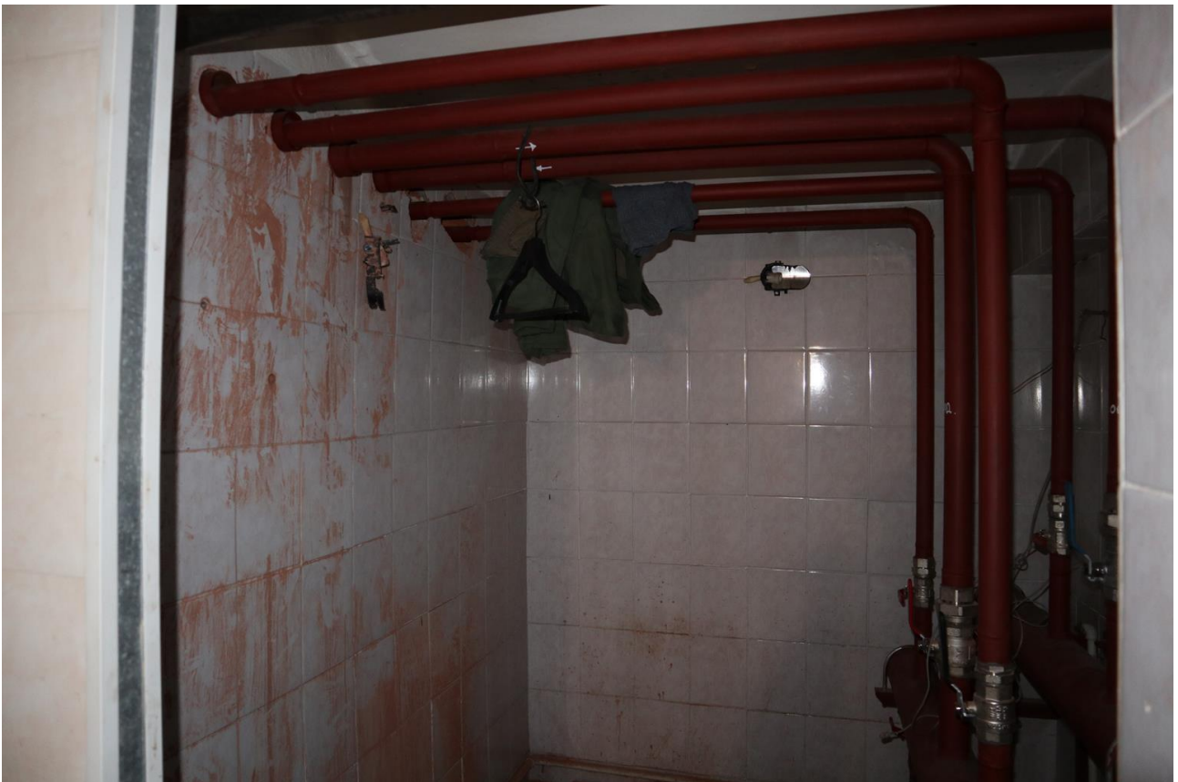
Фото 1.64. 1 этаж, помещение 6Н (3).
