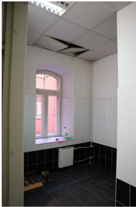
Фото 2.54. 2 этаж, помещение 7Н (19).
