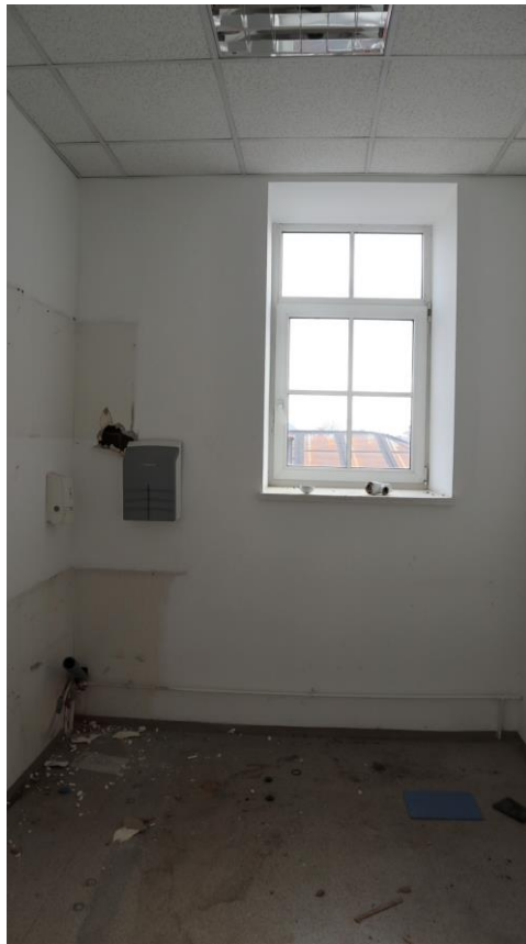
Фото 5.7. 5 этаж, помещение 10Н (48).
