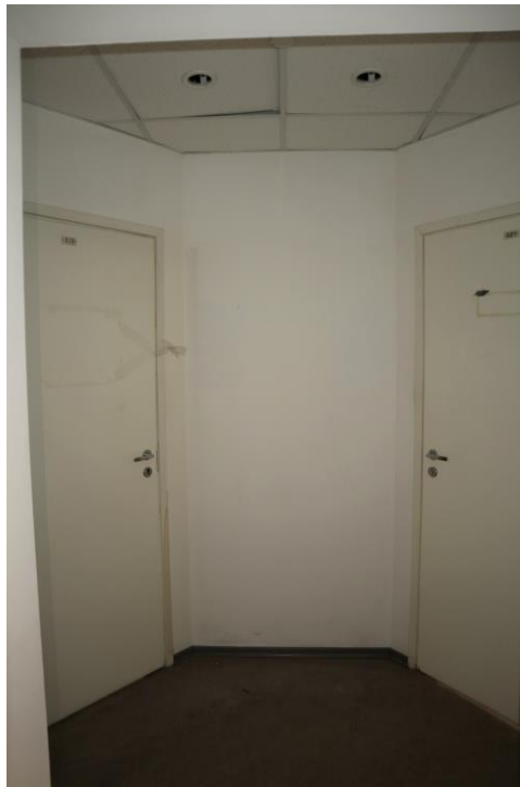
Фото 3.17. 3 этаж, помещение 8Н (23).
