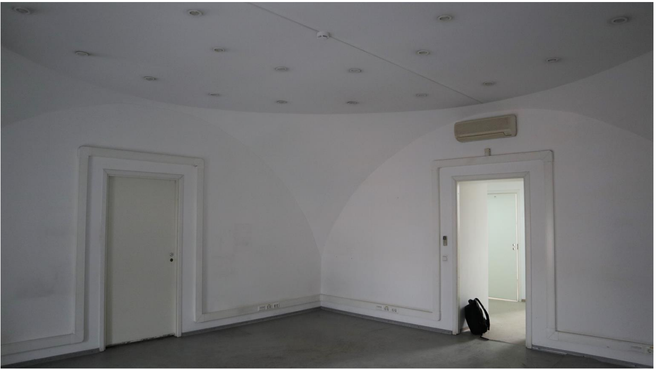
Фото 5.5. 5 этаж, помещение 10Н (38).
