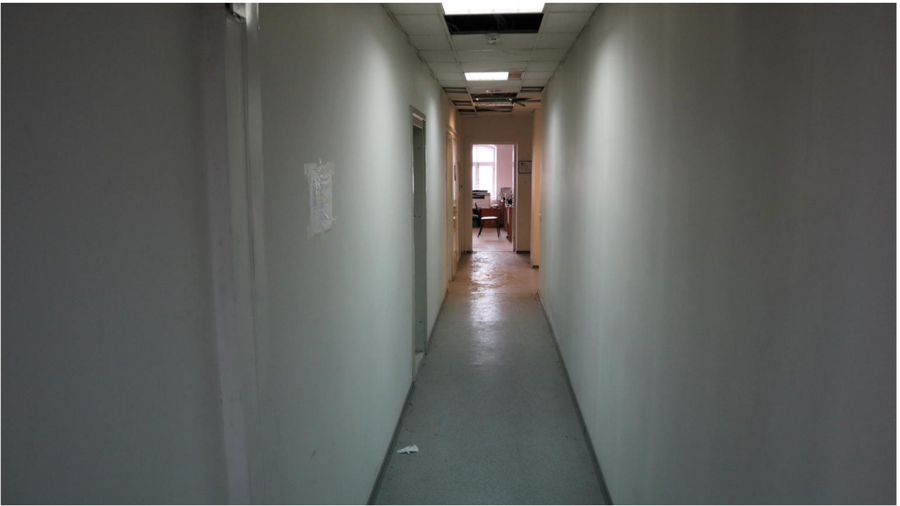
Фото 4.25. 4 этаж, помещение 10Н (11).
