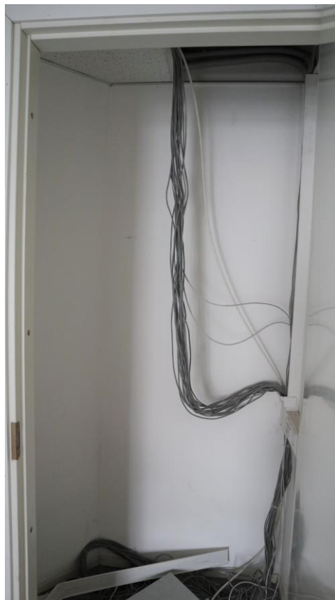
Фото 4.16. 4 этаж, помещение 10Н (27).
