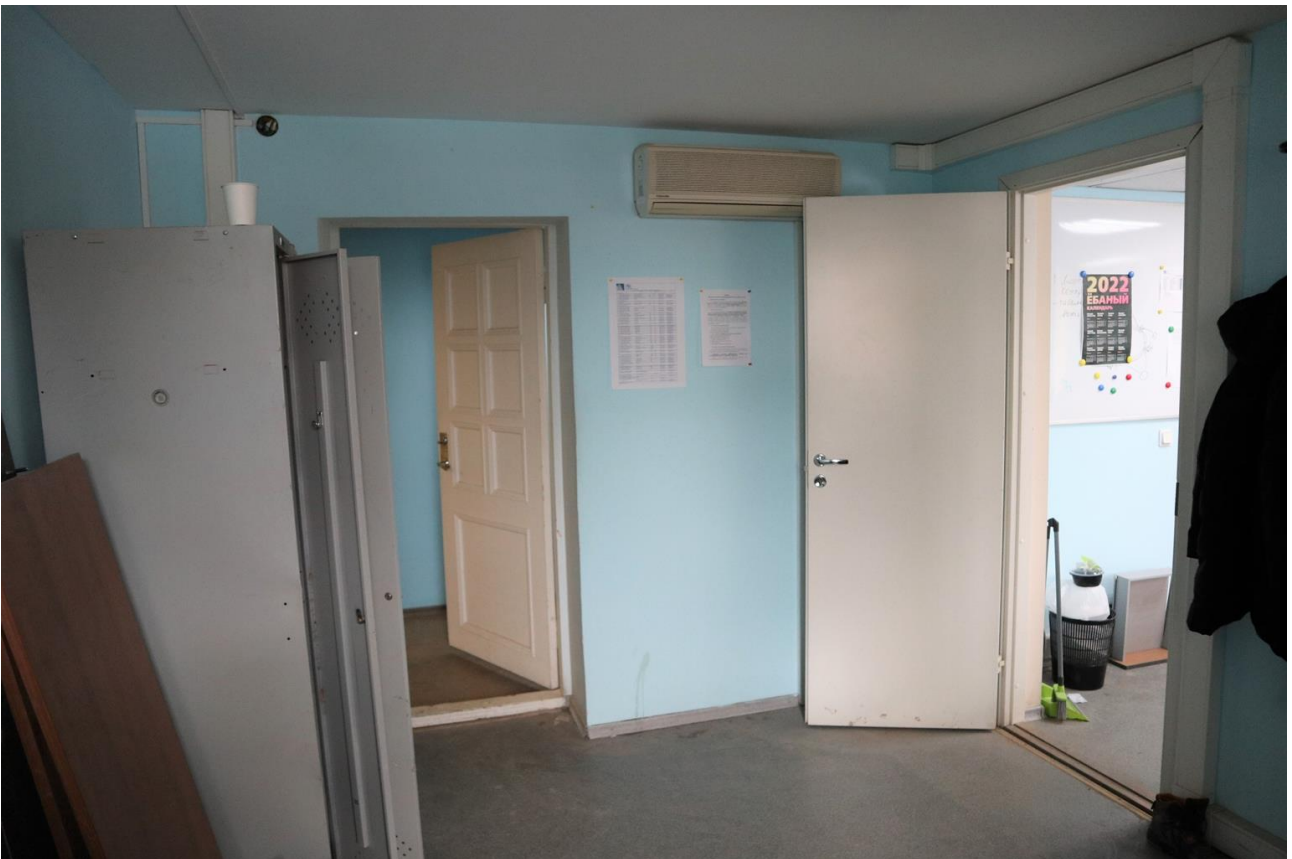
Фото 3.54. 3 этаж, помещение 8Н (2).
