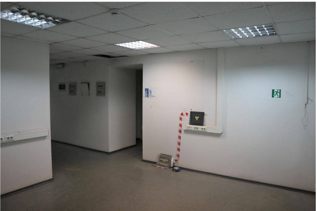
Фото 4.4. 4 этаж, помещение 10Н (29).
