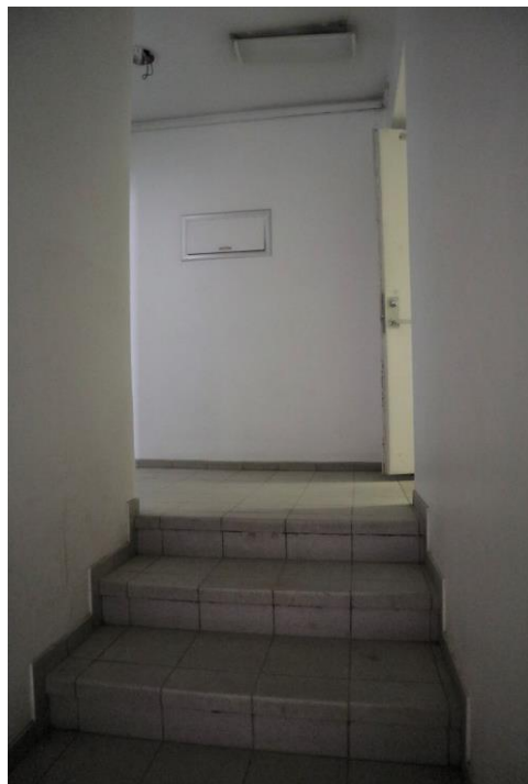
Фото 3.2. 3 этаж, лестница ЛК-1 (6).
