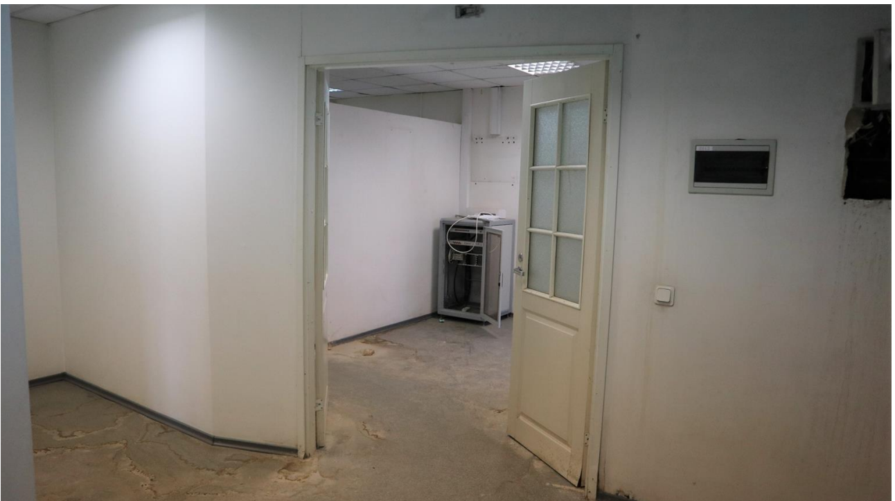
Фото 4.34. 4 этаж, помещение 10Н (11).
