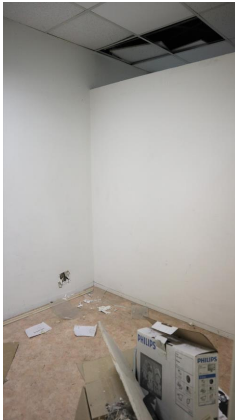
Фото 4.38. 4 этаж, помещение 10Н (3).
