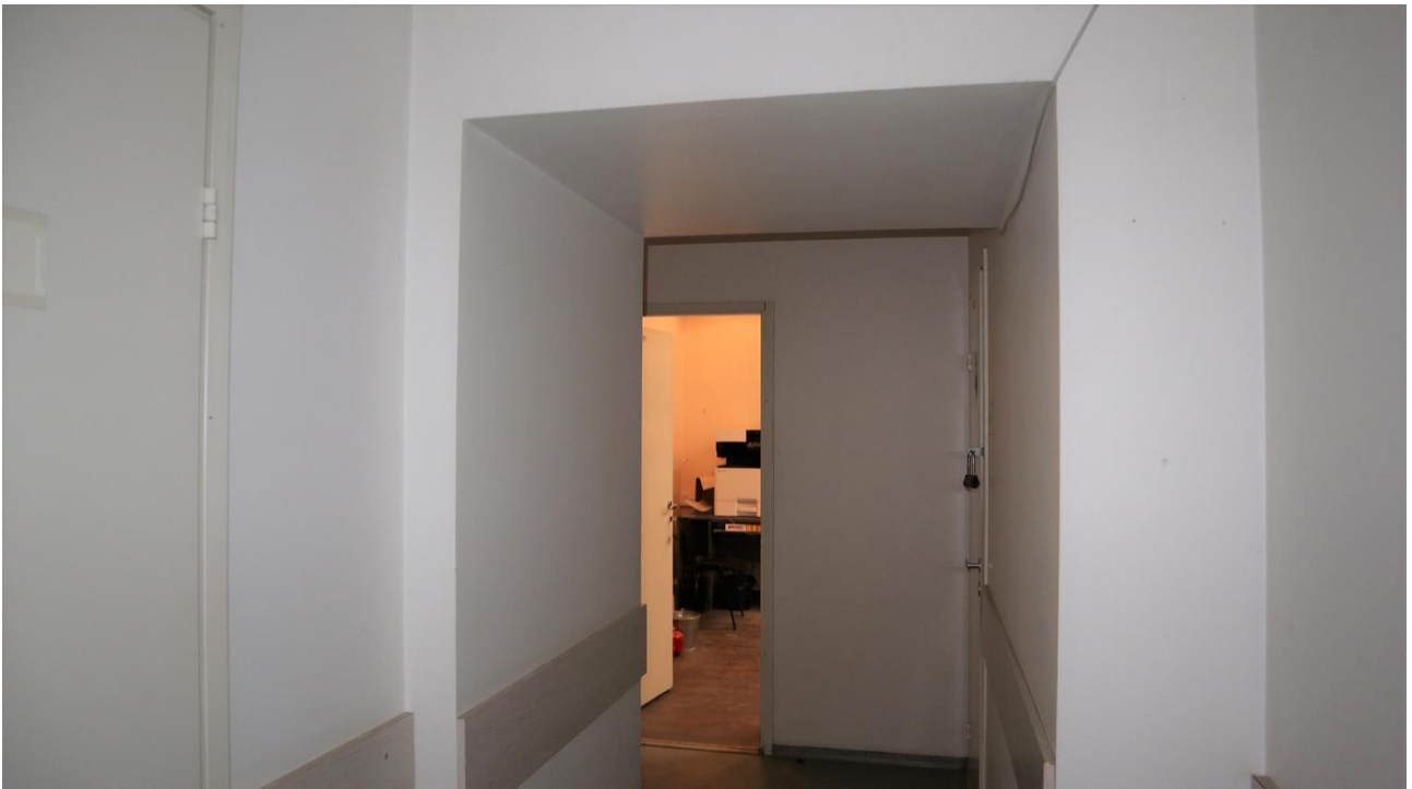
Фото 1.46. 1 этаж, помещение 2Н (4).
