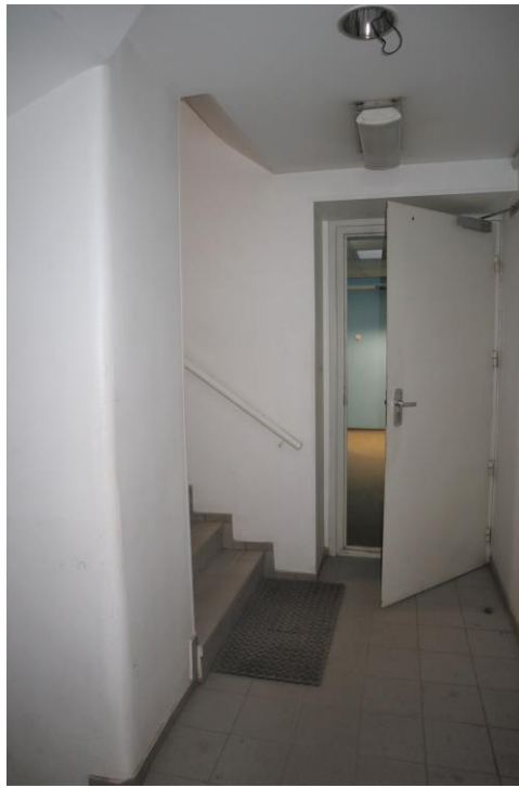
Фото 3.3. 3 этаж, лестничная площадка лестницы ЛК-1 (6).
