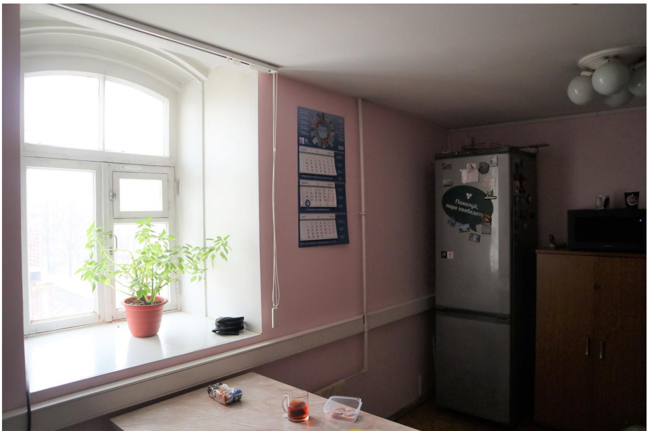
Фото 3.46. 3 этаж, помещение 8Н (9).
