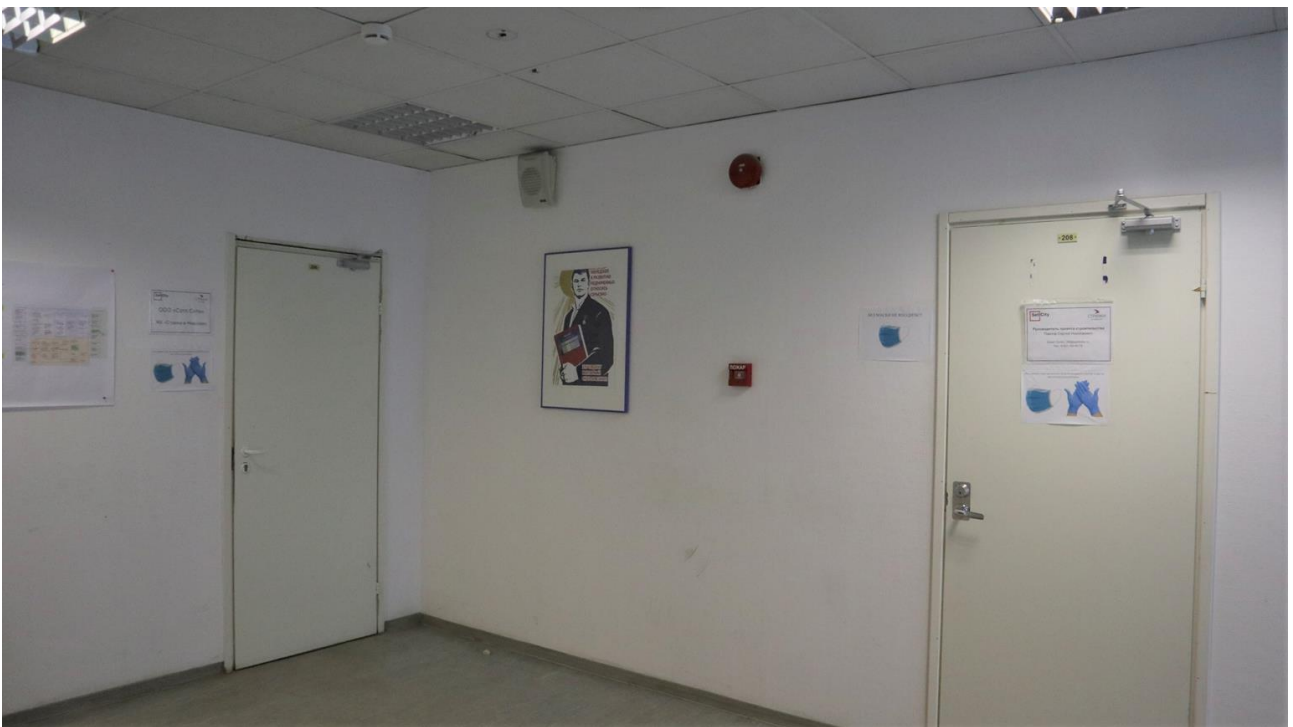
Фото 2.3. 2 этаж, помещение 7Н (8).
