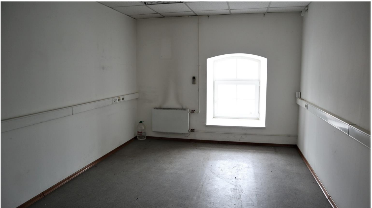
Фото 4.14 4 этаж, помещение 10Н (27).
