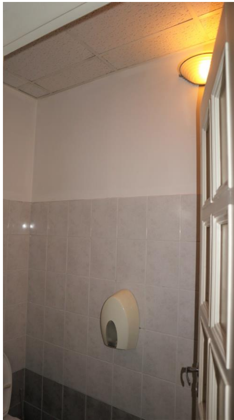
Фото 2.28. 2 этаж, помещение 7Н (32).
