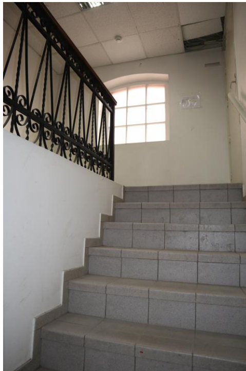
Фото 4.1. 4 этаж, лестница ЛК-1 (7).
