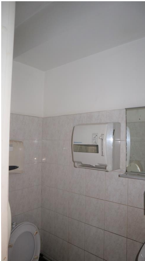
Фото 1.16. 1 этаж, помещение 1Н (8).
