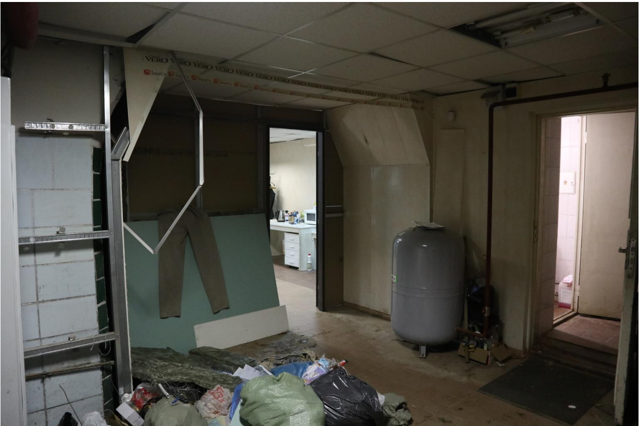
Фото 1.61. 1 этаж, помещение 6Н (2).
