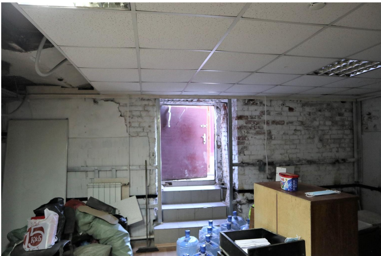
Фото 1.55. 1 этаж, помещение 6Н (7).
