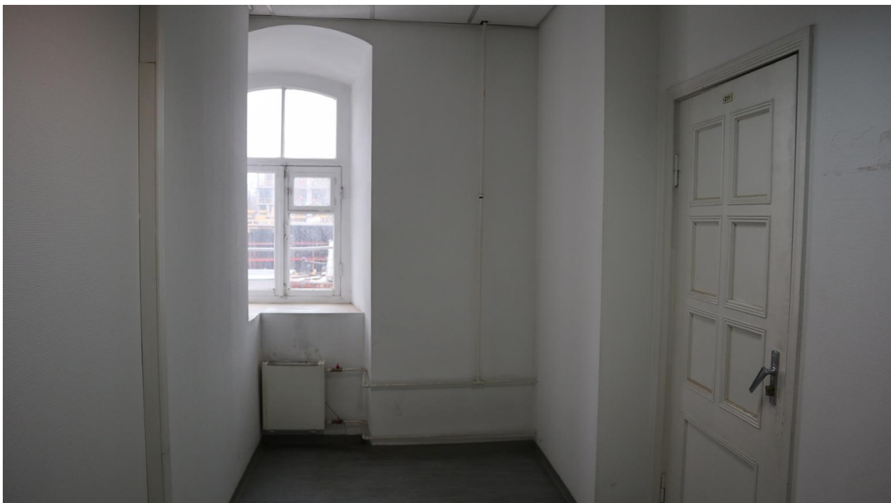
Фото 2.7. 2 этаж, помещение 7Н (8).
