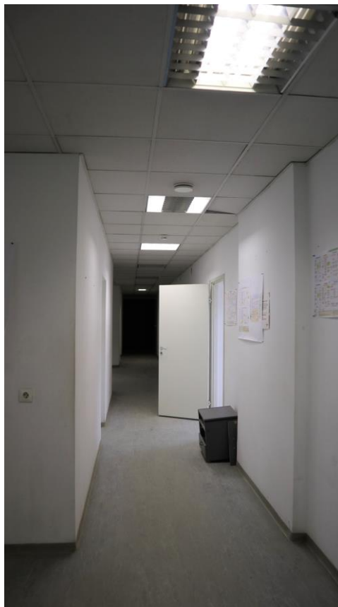
Фото 2.4. 2 этаж, помещение 7Н (8).
