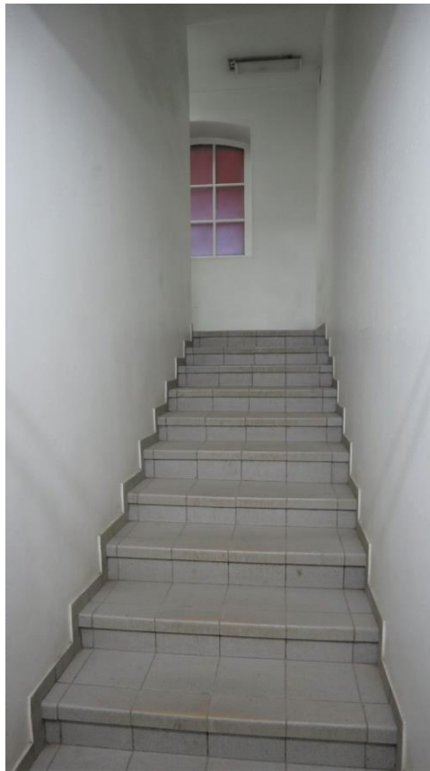
Фото 1.21. 1 этаж, лестница ЛК-1 (3).
