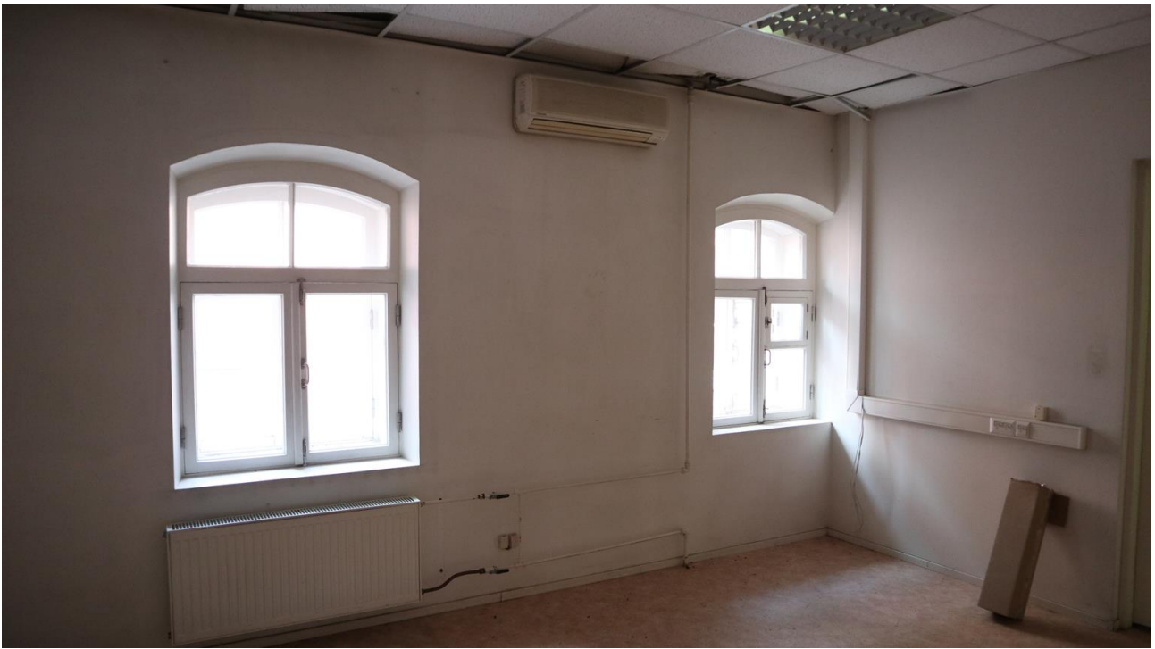
Фото 4.45. 4 этаж, помещение 10Н (5).
