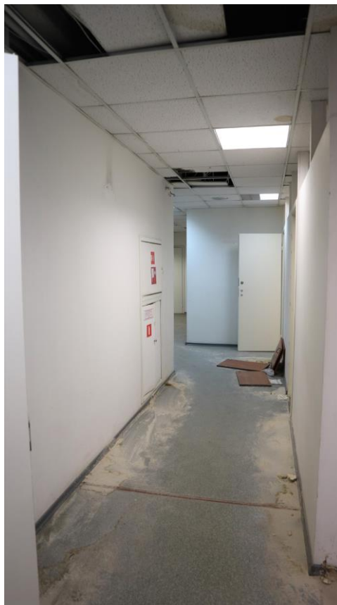
Фото 4.36. 4 этаж, помещение 10Н (1).
