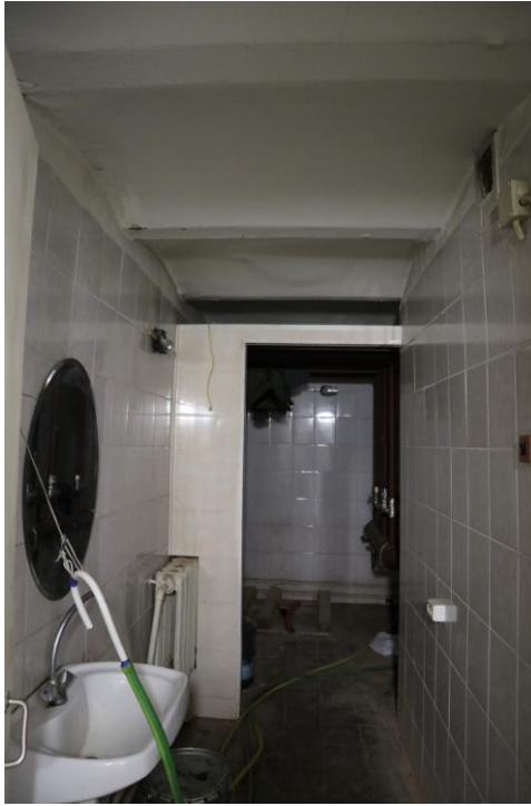
Фото 1.63. 1 этаж, помещение 6Н (4).
