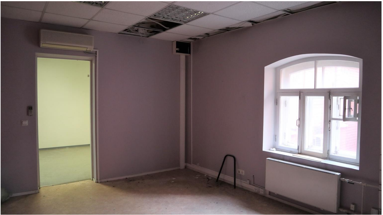
Фото 4.43. 4 этаж, помещение 10Н (4).
