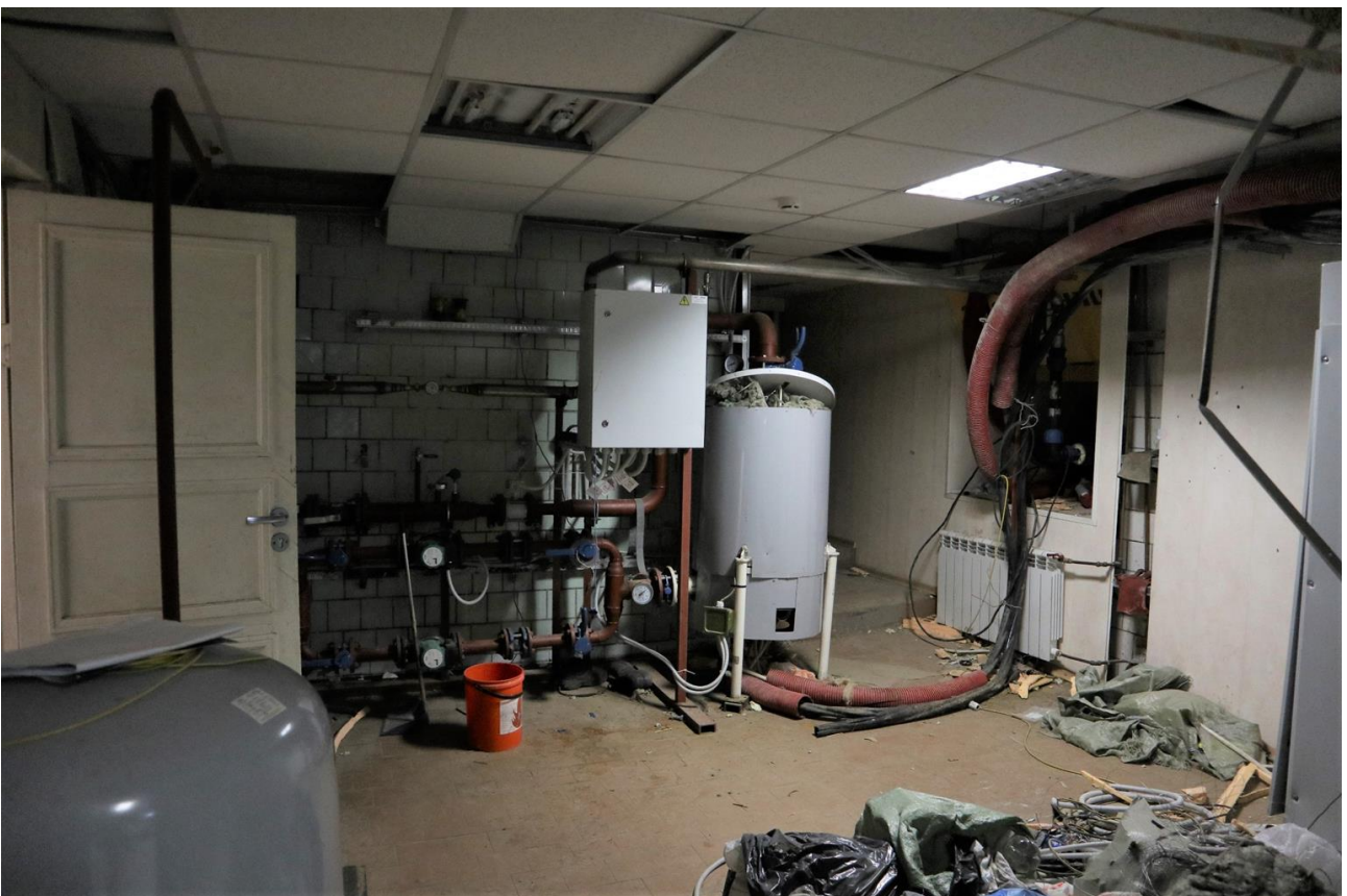
Фото 1.60. 1 этаж, помещение 6Н (2).
