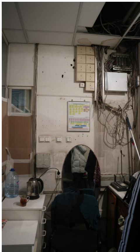
Фото 1.4. 1 этаж, помещение ЗН (1).
