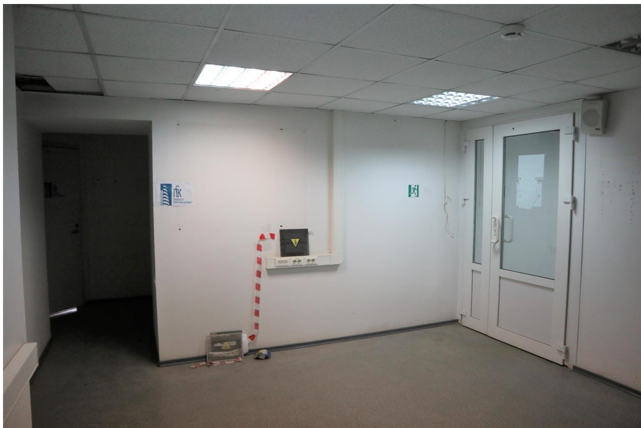
Фото 4.5. 4 этаж, помещение 10Н (29).
