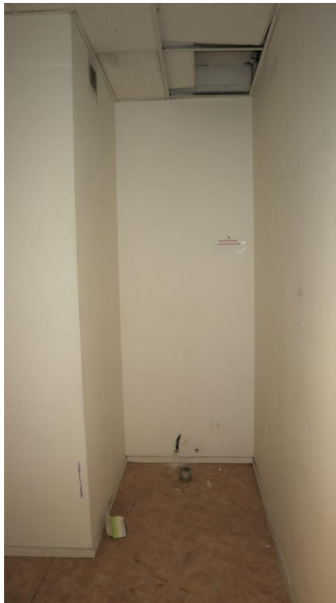
Фото 4.41. 4 этаж, помещение 10Н (8).
