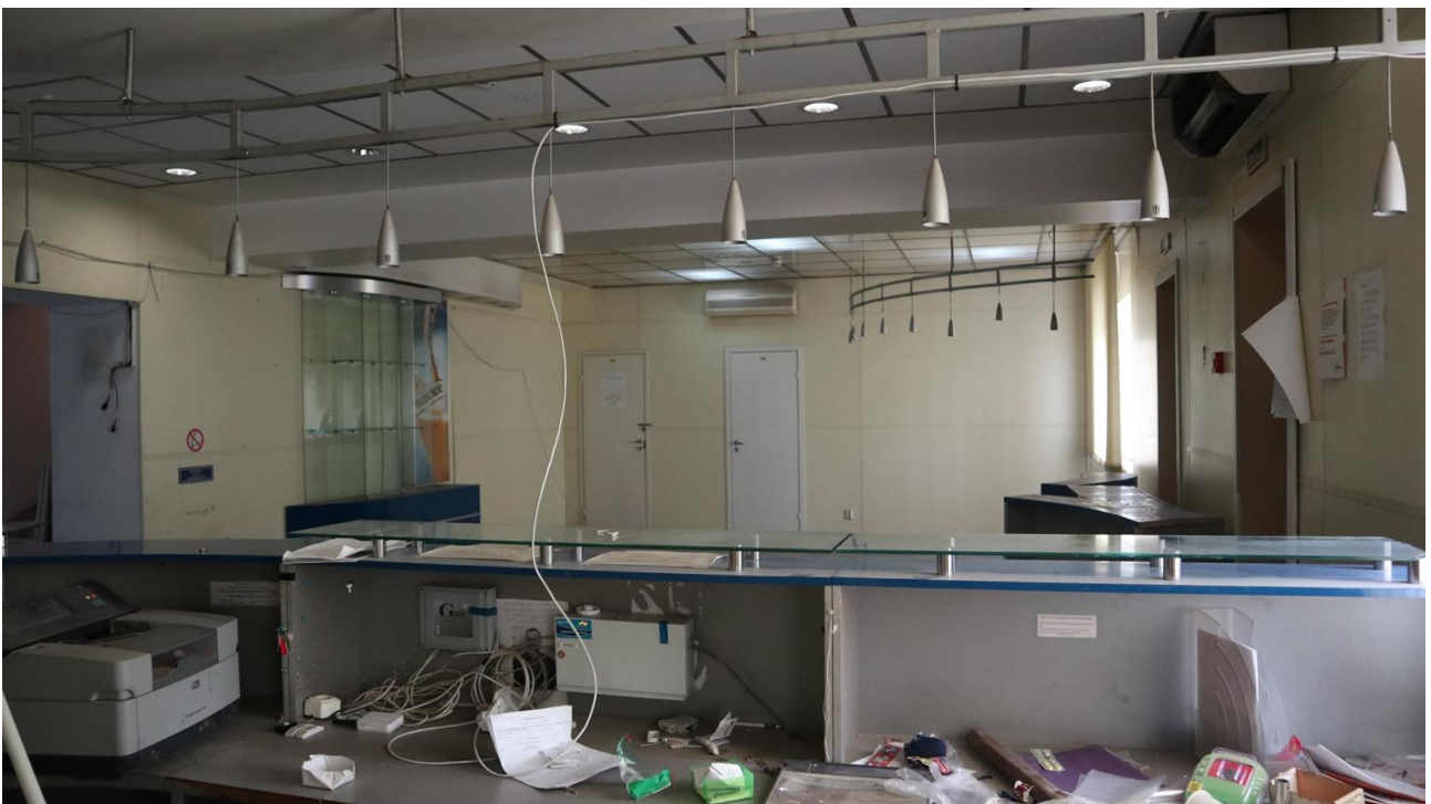
Фото 1.12. 1 этаж, помещение 1Н (4).
