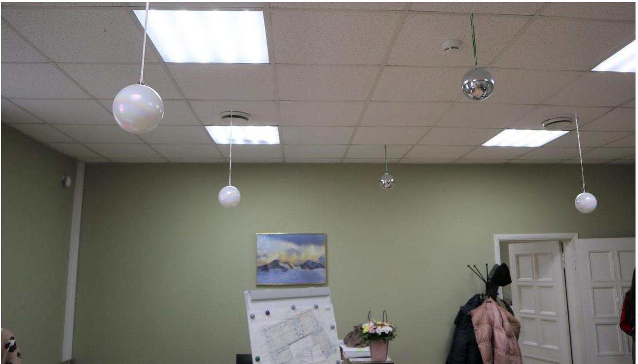
Фото 2.22. 2 этаж, помещение 7Н (2).
