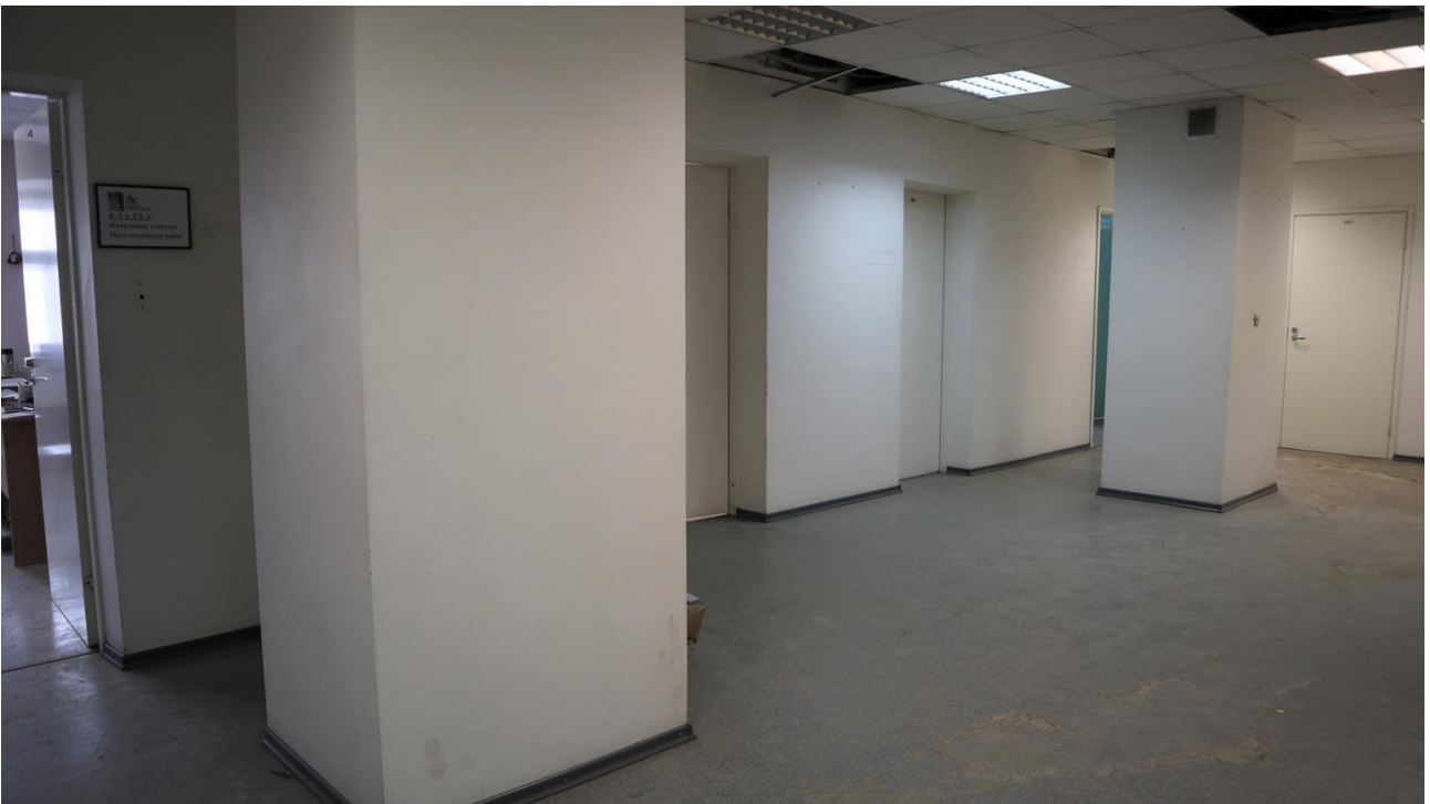
Фото 4.26. 4 этаж, помещение 10Н (11).
