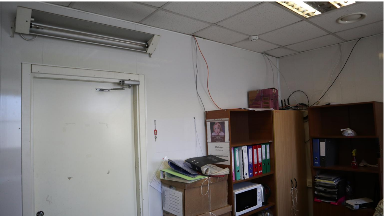
Фото 1.30. 1 этаж, помещение 2Н (3).
