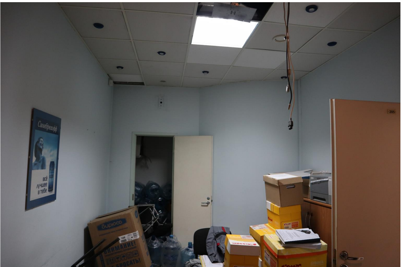
Фото 2.43. 2 этаж, помещение 7Н (25).
