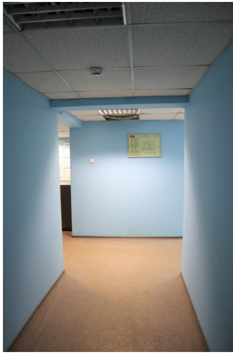
Фото 3.39. 3 этаж, помещение 9Н (4).
