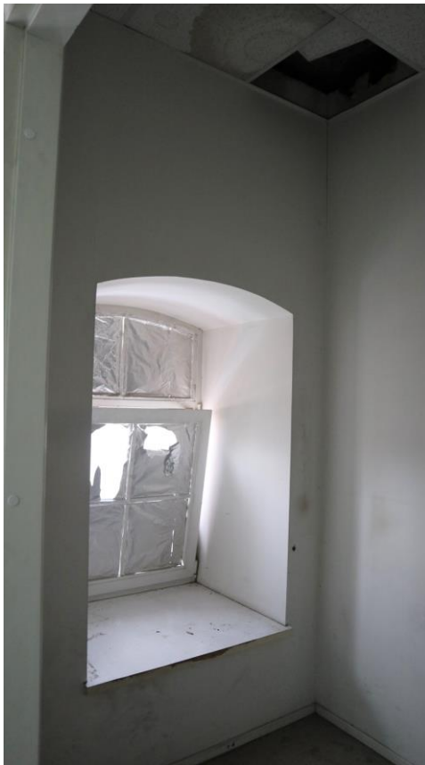
Фото 5.21. 5 этаж, помещение 10Н (42).
