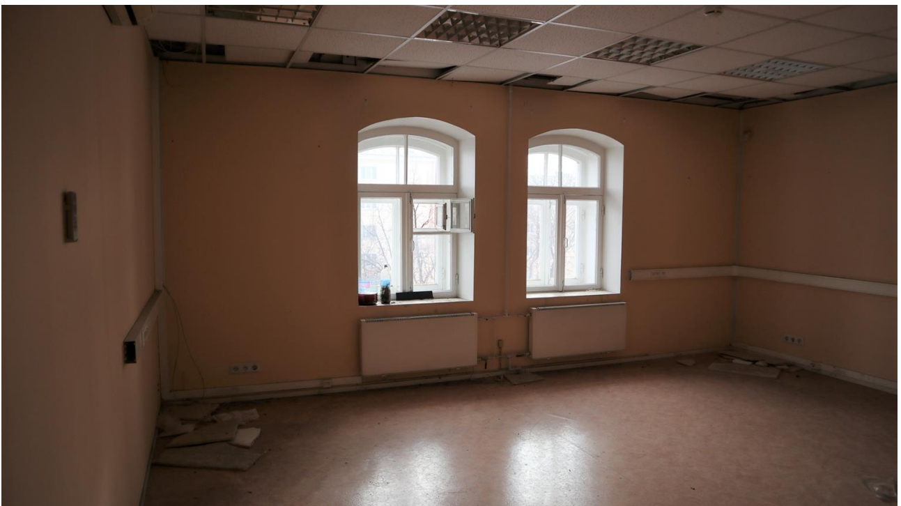
Фото 4.46. 4 этаж, помещение 10Н (6).
