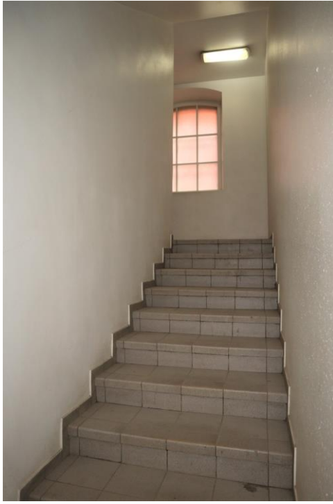
Фото 2.66. 2 этаж, лестница ЛК-1 (4).
