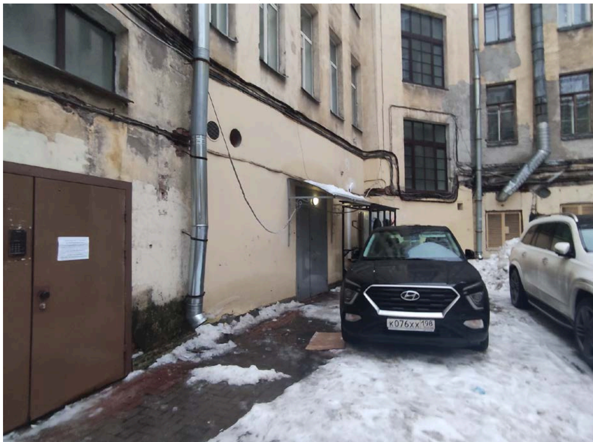
Фото 10. Фрагмент дворового фасада объекта культурного наследия «Дом Санкт-Петербургского Мещанского общества»
