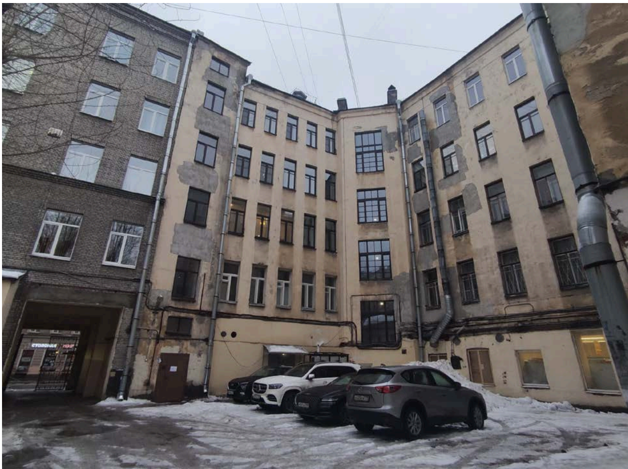
Фото 9. Фрагмент дворового фасада объекта культурного наследия «Дом Санкт-Петербургского Мещанского общества»
