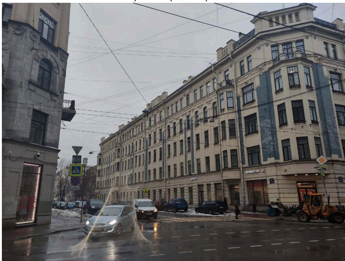
Фото 2. Фрагмент лицевого фасада объекта культурного наследия «Дом Санкт-Петербургского Мещанского общества», вид со стороны ул.Бородинской
