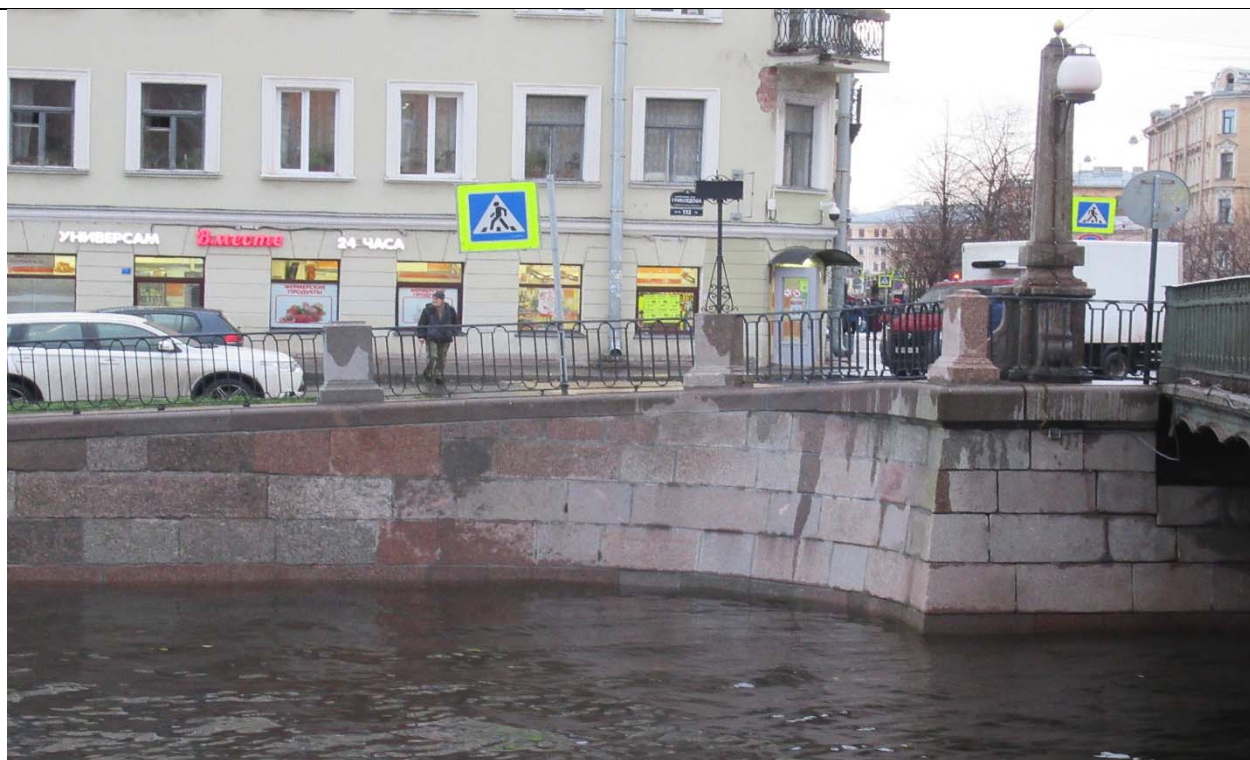
3. ОКН ФЗ «Мост Аларчин», входящий в состав комплекса «Набережные и мосты Екатерининского канала (ныне канала Грибоедова)» по адресу: г. Санкт-Петербург, через канал Грибоедова по Английскому пр. Вид на береговые устои моста, расположенные со стороны наб. кан. Грибоедова. Дата съемки: 15.11.2020 г.
