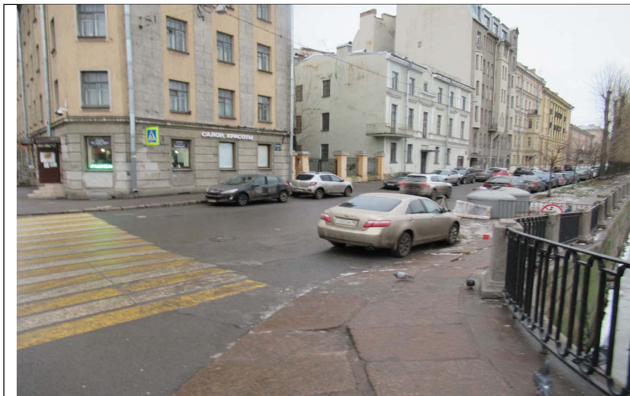
17. ОКН ФЗ «Мост Аларчин», входящий в состав комплекса «Набережные и мосты Екатерининского канала (ныне канала Грибоедова)» по адресу: г. Санкт-Петербург, через канал Грибоедова по Английскому пр. Вид от моста вдоль наб. кан. Грибоедова напротив д. 154. Дата съемки: 15.11.2020 г.
