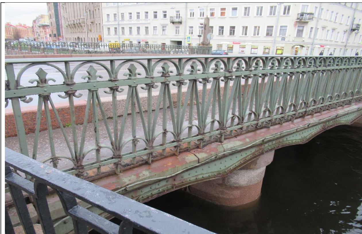
9. ОКН ФЗ «Мост Аларчин», входящий в состав комплекса «Набережные и мосты Екатерининского канала (ныне канала Грибоедова)» по адресу: г. Санкт-Петербург, через канал Грибоедова по Английскому пр. Общий вид на проезжую и пешеходную части моста от просп. Римского -Корсакова. Дата съемки: 15.11.2020 г.
