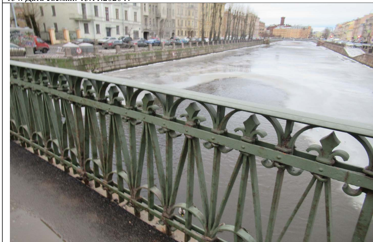
18. ОКН ФЗ «Мост Аларчин», входящий в состав комплекса «Набережные и мосты Екатерининского канала (ныне канала Грибоедова)» по адресу: г. Санкт-Петербург, через канал Грибоедова по Английскому пр. Перильное ограждение. Дата съемки: 15.11.2020 г.
