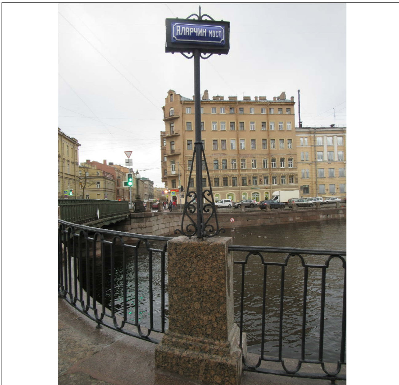
6. ОКН ФЗ «Мост Аларчин», входящий в состав комплекса «Набережные и мосты Екатерининского канала (ныне канала Грибоедова)» по адресу: г. Санкт-Петербург, через канал Грибоедова по Английскому пр. Декоративная стойка для таблички и табличка с названием моста (со стороны наб.кан. Грибоедова) и вид на набережную со стороны проспекта Римского-Корсакова. Дата съемки: 15.11.2020 г.
