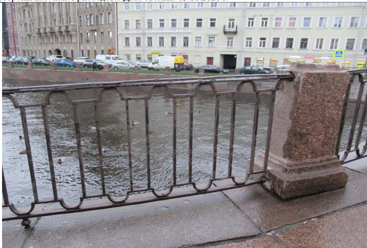
4. ОКН ФЗ «Мост Аларчин», входящий в состав комплекса «Набережные и мосты Екатерининского канала (ныне канала Грибоедова)» по адресу: г. Санкт-Петербург, через канал Грибоедова по Английскому пр. Элементы декора ограждения моста и вид на набережную, расположенную со стороны наб. кан. Грибоедова. Дата съемки: 15.11.2020 г.
