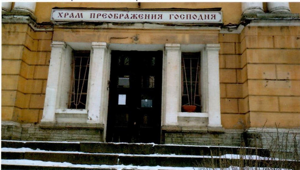
8. Вход в здание со стороны юго-западного фасада.
