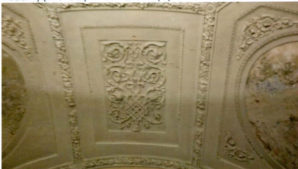
7. Лепное оформление исторического сводчатого перекрытия.
