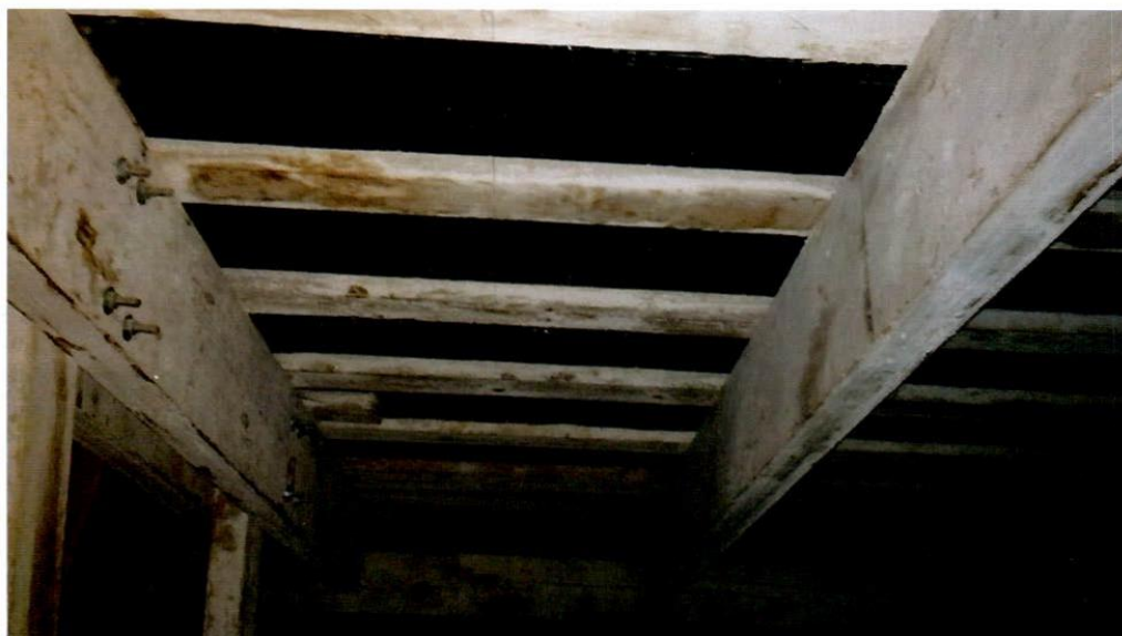
5. Стропильная система.
