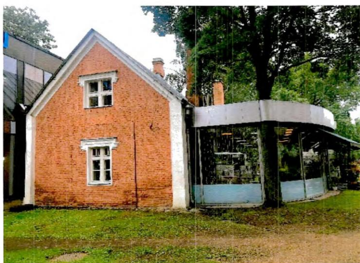
7. Лицевой фасад объекта культурного наследия «Четыре служебных корпуса». Вид с северной стороны (ул. Савушкина, д. 8, литера А)
