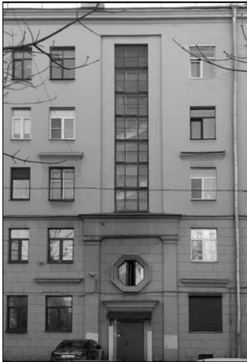
20. Восточный (дворовый) фасад. Южная часть. Фрагмент. Дата съемки: 10 мая 2021 г. Фотограф: Г. В. Михайловская.
