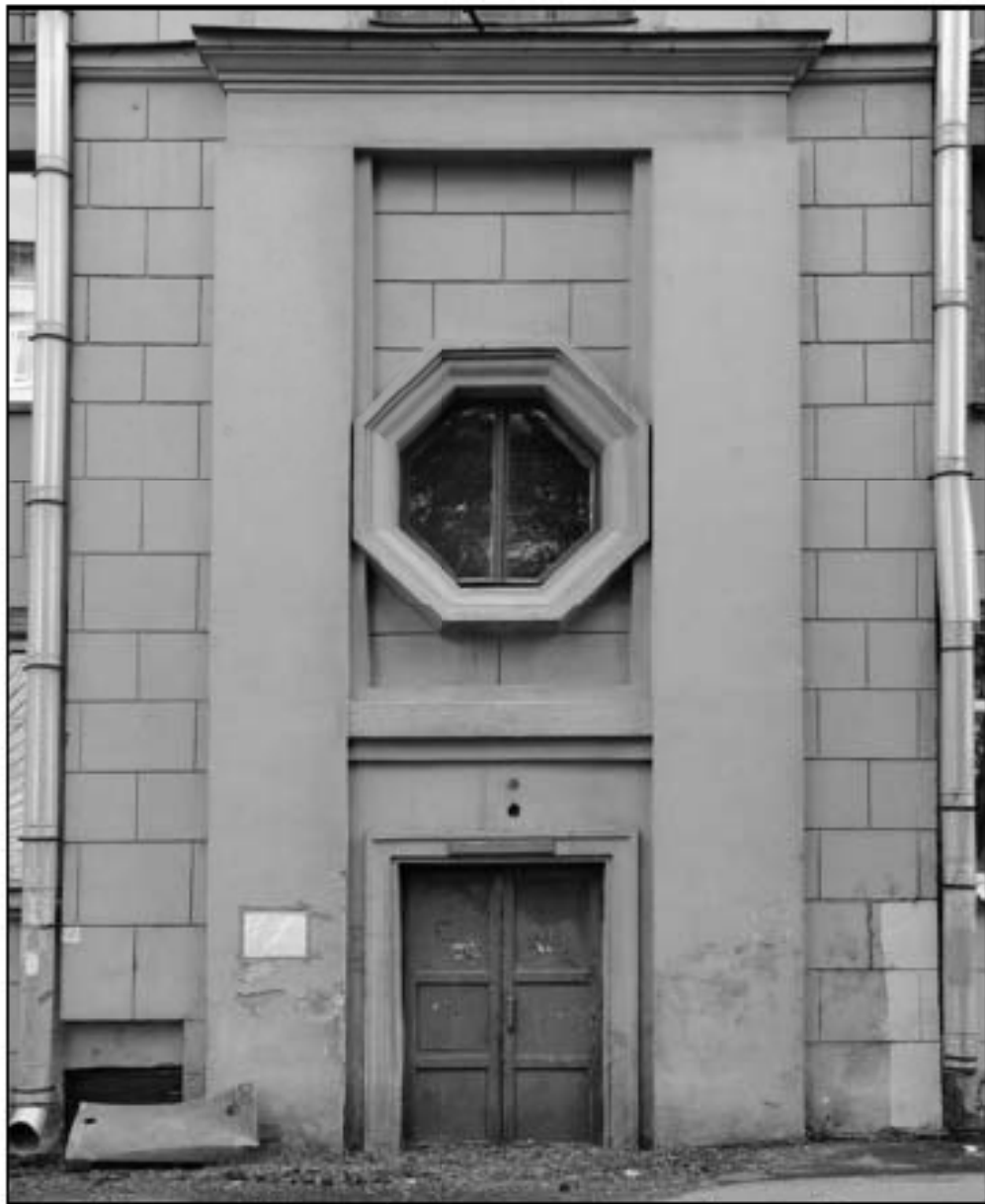
16. Северный фасад. Раскреповка центральной части. Фрагмент. Дата съемки: 10 мая 2021 г. Фотограф: Г. В. Михайловская.
