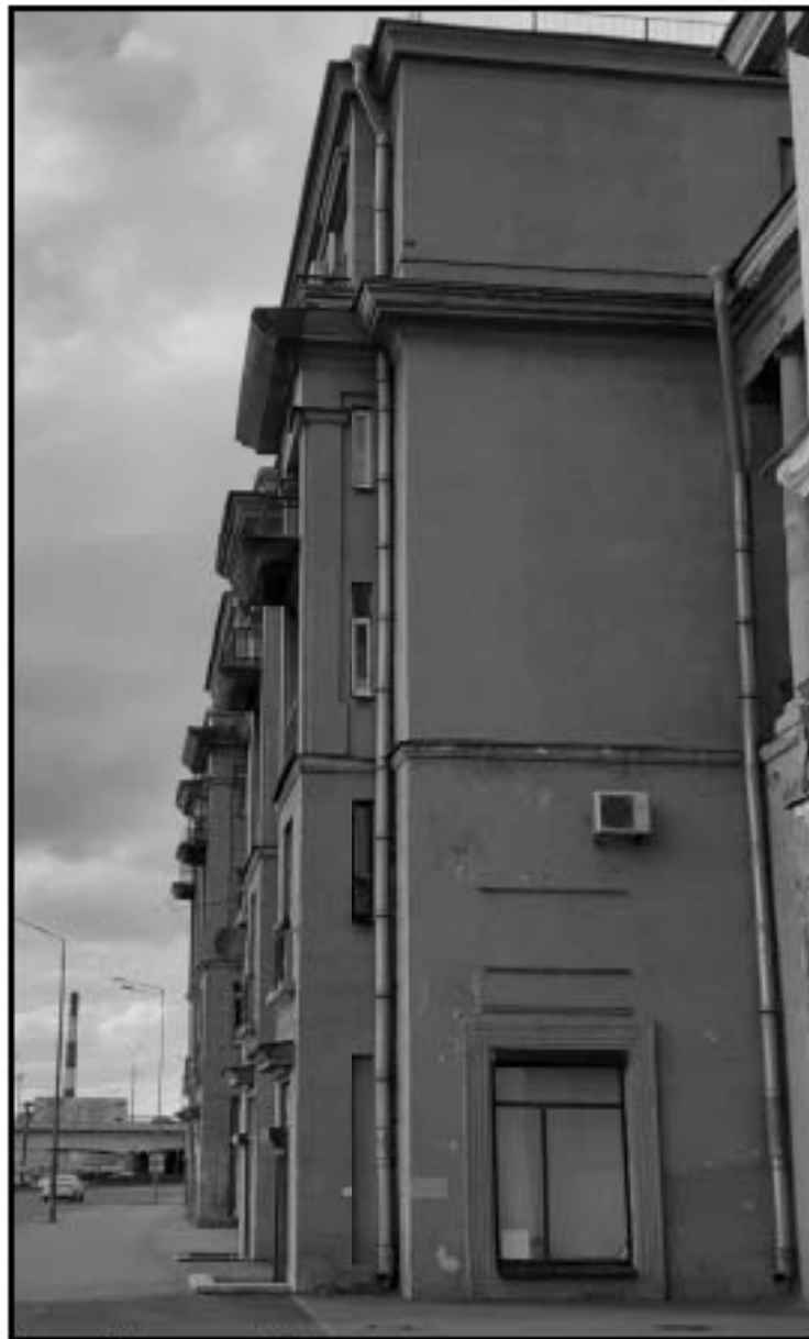
8. Южный (торцевой) фасад южного ризалита западного фасада. Дата съемки: 10 мая 2021 г. Фотограф: Г. В. Михайловская.
