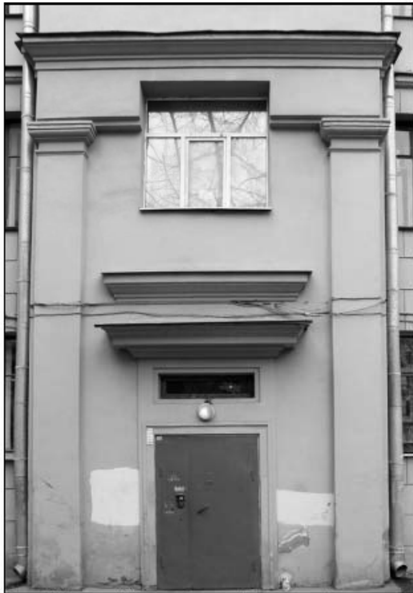
25. Южный (дворовый) фасад. Западный лестничный ризалит. Фрагмент. Дата съемки: 10 мая 2021 г. Фотограф: Г. В. Михайловская.
