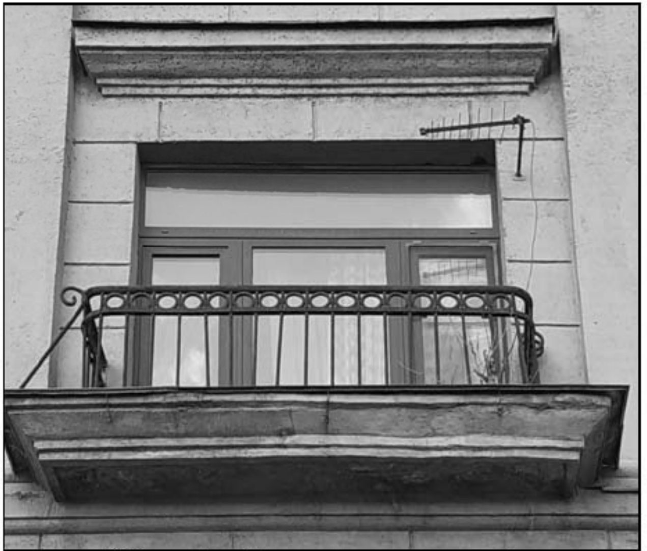
10. Западный фасад. Кованое металлическое ограждение балкона. Дата съемки: 10 мая 2021 г. Фотограф: Г. В. Михайловская.
