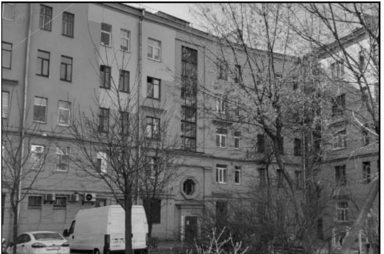
21. Восточный (дворовый) фасад. Северная часть. Дата съемки: 10 мая 2021 г. Фотограф: Г. В. Михайловская.
