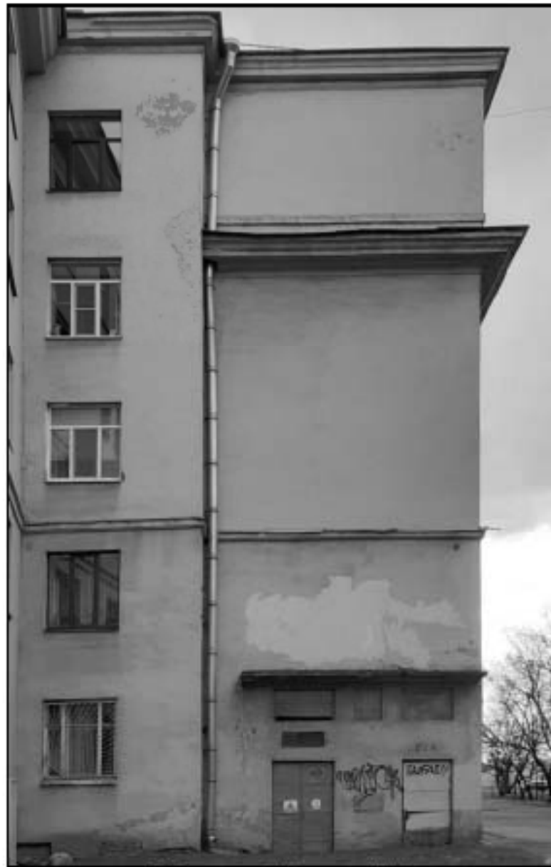
18. Восточный (торцевой) фасад. Дата съемки: 10 мая 2021 г. Фотограф: Г. В. Михайловская.
