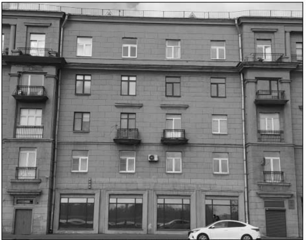
5. Западный фасад. Центральная часть. Дата съемки: 10 мая 2021 г. Фотограф: Г. В. Михайловская.
