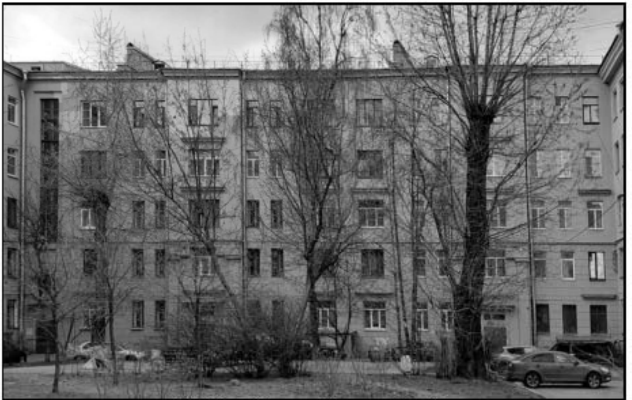
22. Южный (дворовый) фасад. Общий вид. Дата съемки: 10 мая 2021 г. Фотограф: Г. В. Михайловская.
