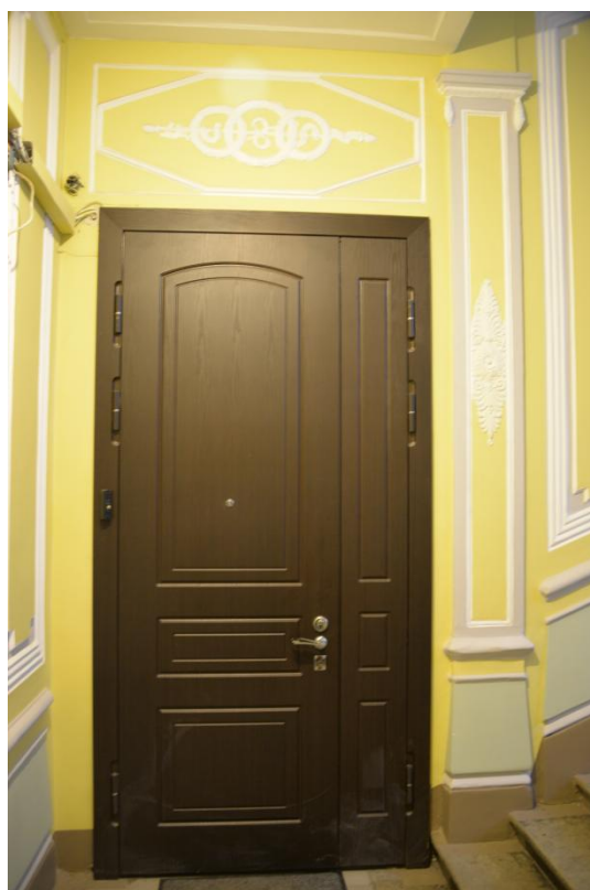
4. Входная дверь в квартиру №4
