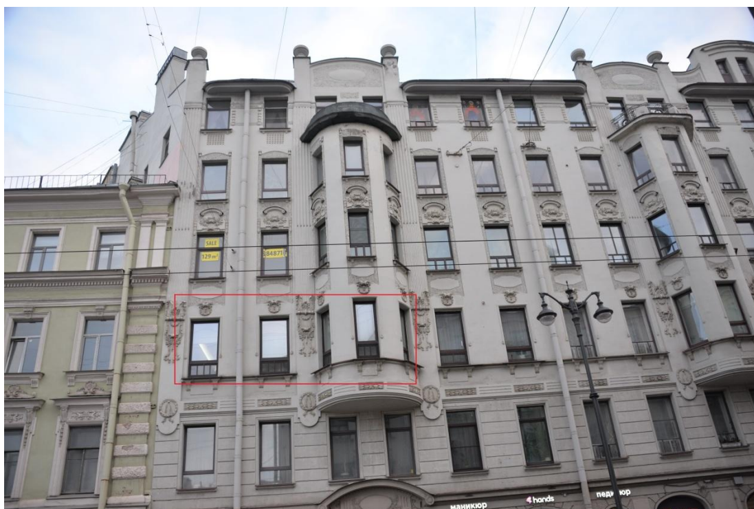
2. Фрагмент лицевого фасада выявленного объекта культурного наследия «Дом В.Г. и О.М. Чубаковых»
