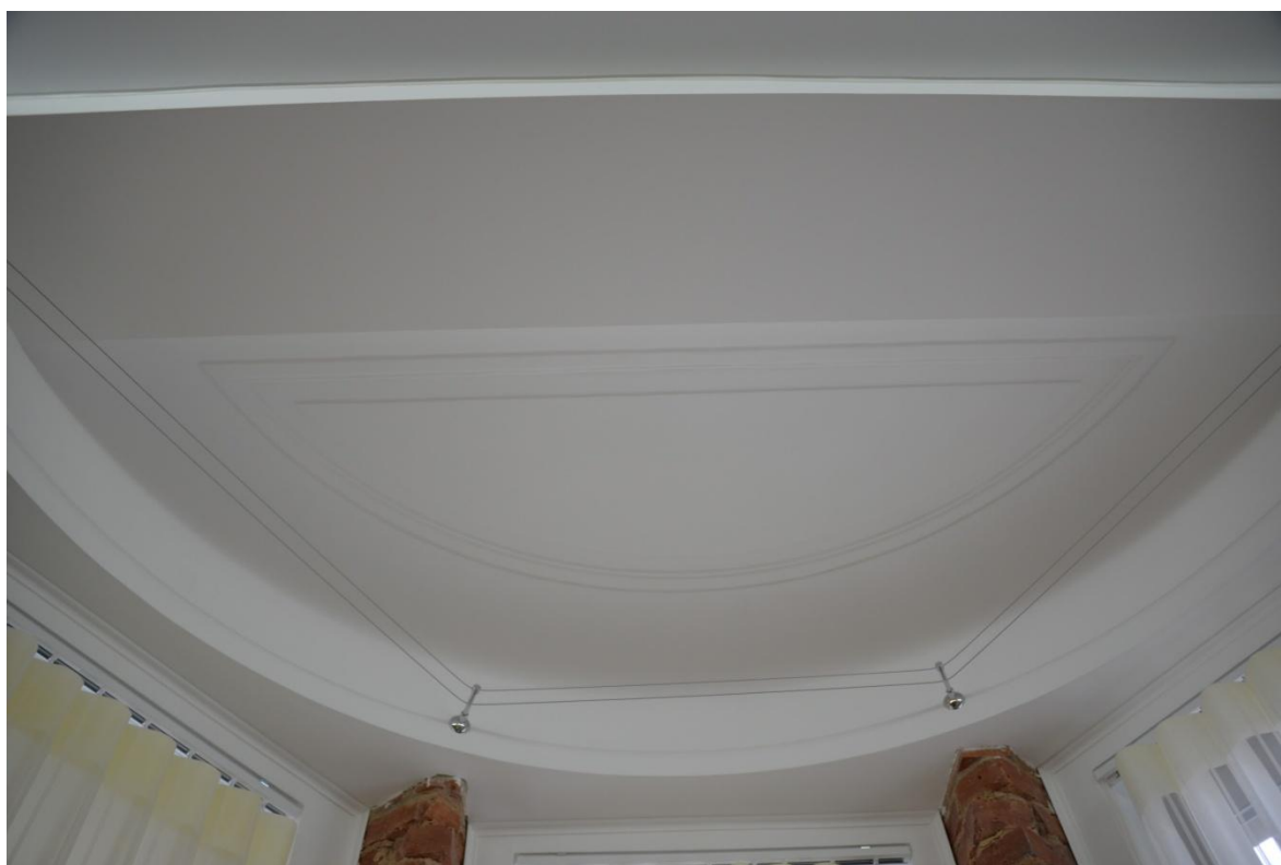
12. Интерьер квартиры №4 (фрагмент потолка в части помещения 3)
