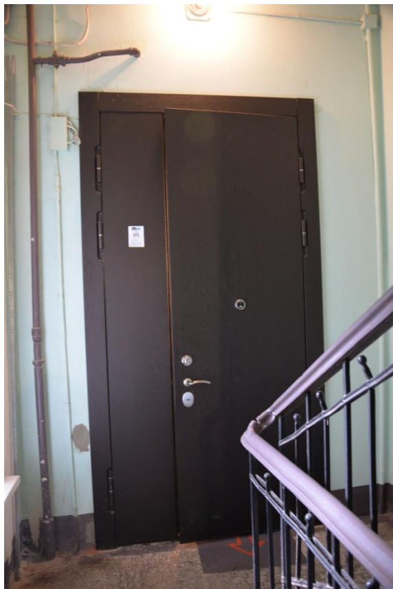
5. Входная дверь в квартиру №4
