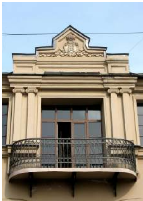
119. Балкон южного фасада параллельного восточного корпуса. 2014г. http://www.citywalls.ru/ .
