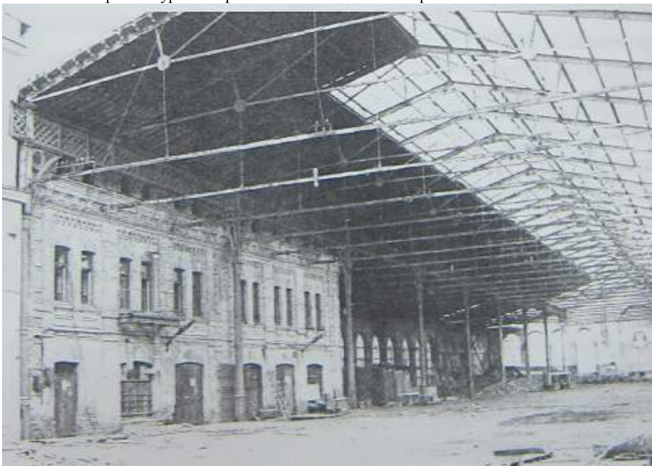
103. Фрагмент дебаркадера. Вид с юго-востока. 2003г. ООО «Архитектурное бюро «Литейная часть-91»». Архив КГИОП. Ф. 1155. № Н-5881.
