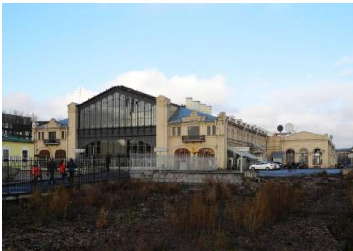
124. Вид на здание вокзала со стороны разобранных путей парка «В». 2013г. https://railwayz.info/ .
