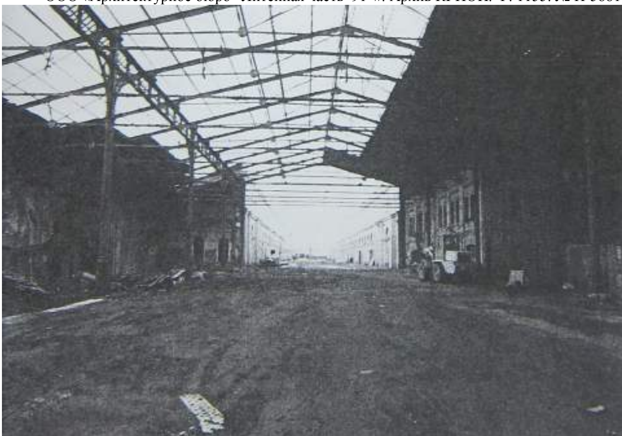
101. Дебаркадер. Вид с севера. 2003г. ООО «Архитектурное бюро «Литейная часть-91»». Архив КГИОП. Ф. 1155. № Н-5881.
