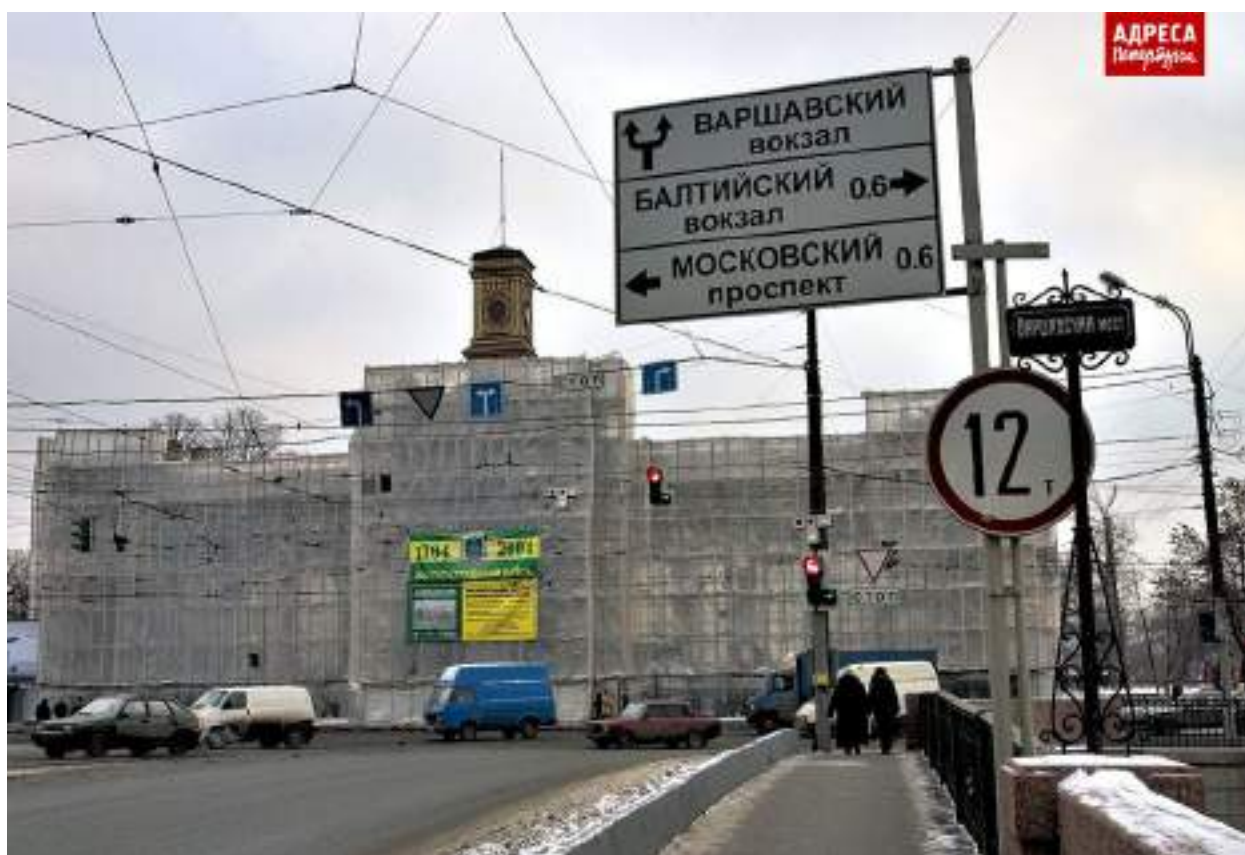
111. Фасад здания бывшего Варшавского вокзала во время реконструкции. 2005г. https://adresaspb.ru/ .
