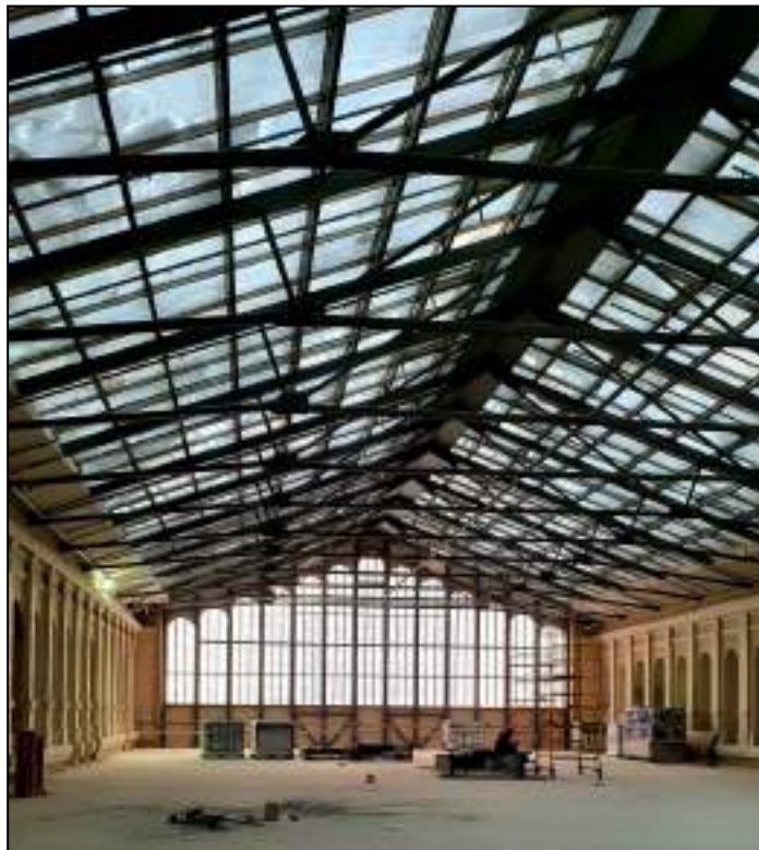
17. Интерьер второго этажа. Фрагмент. Вид на центральную часть южного фасада, которая выделена ризалитом, завершенным треугольным щипцом. Выявленный объект культурного наследия «Здание вокзала», расположенный по адресу: Санкт-Петербург, наб. Обводного канала, д. 118, лит. С, входящий в ансамбль выявленного объекта культурного наследия «Комплекс построек Варшавского вокзала». Дата съемки: 20.12.2021.
