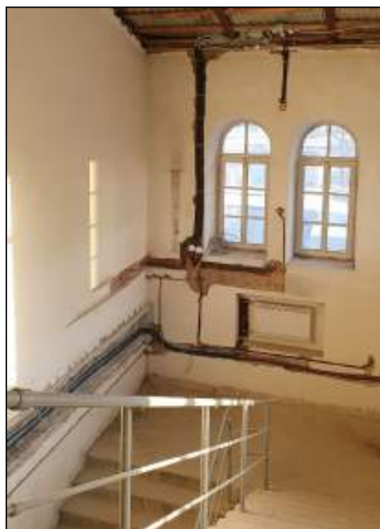
38. Интерьер второго этажа. Историческое местоположение лестницы. Выявленный объект культурного наследия «Здание вокзала», расположенный по адресу: Санкт-Петербург, наб. Обводного канала, д. 118, лит. С, входящий в ансамбль выявленного объекта культурного наследия «Комплекс построек Варшавского вокзала». Дата съемки: 20.12.2021.
