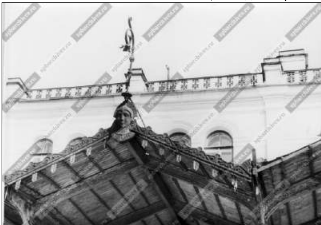
68. Вид части козырька над западным входом в зал ожидания Варшавского вокзала. Архитектор П. О. Сальманович, 1858–1859гг., инженер Ю. Фляша. 23.04.1981г. ЦГАКФФД СПб. Ар 212559.
