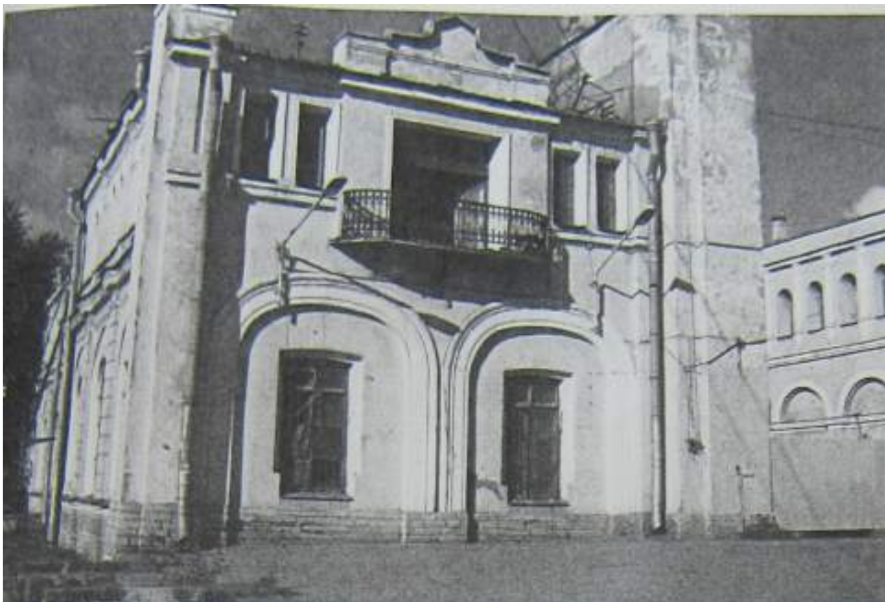
92. Южный фасад западного корпуса. Вид с юго-запада. 2003г. ООО «Архитектурное бюро «Литейная часть-91»». Архив КГИОП. Ф. 1155. № Н-5881.
