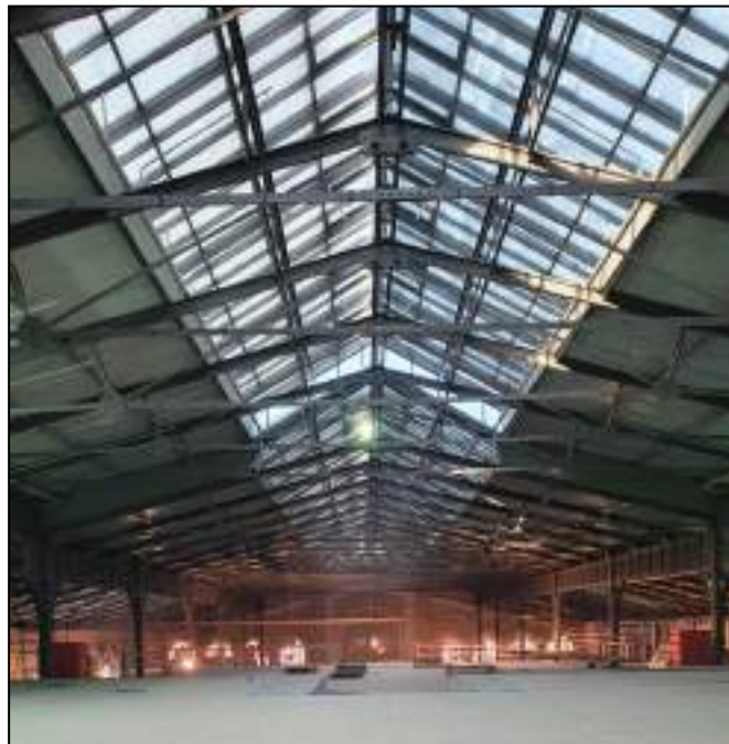
35. Фонарь в коньке крыши дебаркадера. Металлические фермы конструкции. Выявленный объект культурного наследия «Здание вокзала», расположенный по адресу: Санкт-Петербург, наб. Обводного канала, д. 118, лит. С, входящий в ансамбль выявленного объекта культурного наследия «Комплекс построек Варшавского вокзала». Дата съемки: 20.12.2021.
