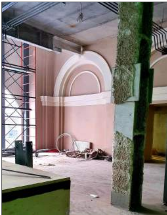
21. Фрагмент интерьера бывшего внутреннего двора, перекрытого в настоящее время. Выявленный объект культурного наследия «Здание вокзала», расположенный по адресу: Санкт-Петербург, наб. Обводного канала, д. 118, лит. С, входящий в ансамбль выявленного объекта культурного наследия «Комплекс построек Варшавского вокзала». Дата съемки: 20.12.2021.
