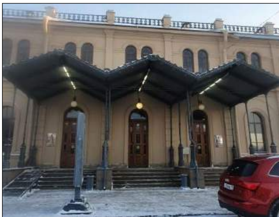
55. Фрагмент лицевого фасада западного корпуса. Крыльцо. Металлический козырек. Выявленный объект культурного наследия «Здание вокзала», расположенный по адресу: Санкт-Петербург, наб. Обводного канала, д. 118, лит. С, входящий в ансамбль выявленного объекта культурного наследия «Комплекс построек Варшавского вокзала». Дата съемки: 20.12.2021.
