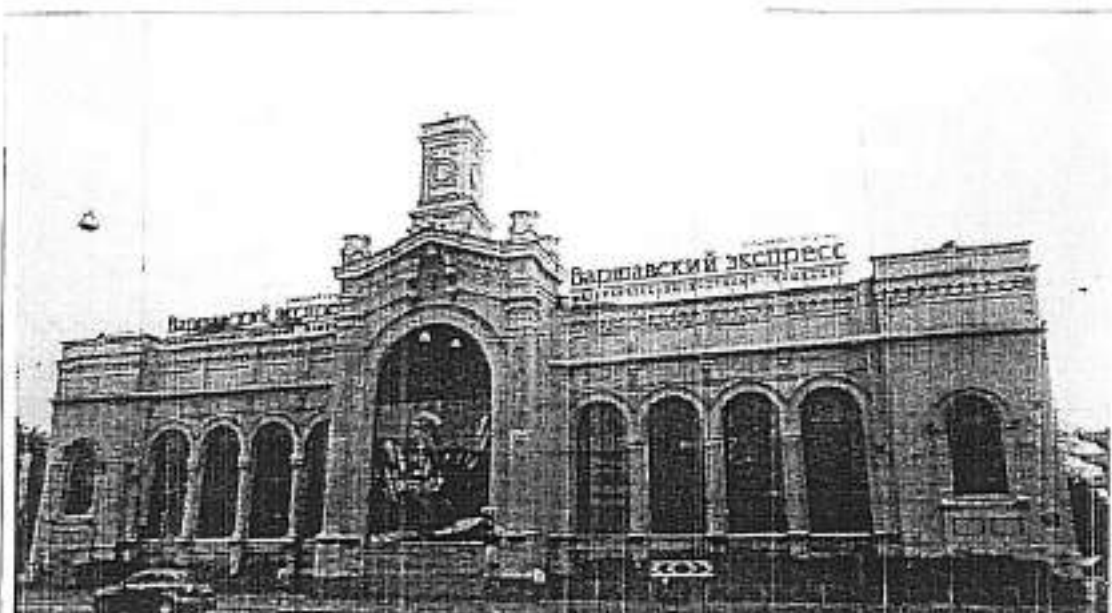
Северный фасад. Общий вид. Съемка июль 2012, Е.В. Черненко
