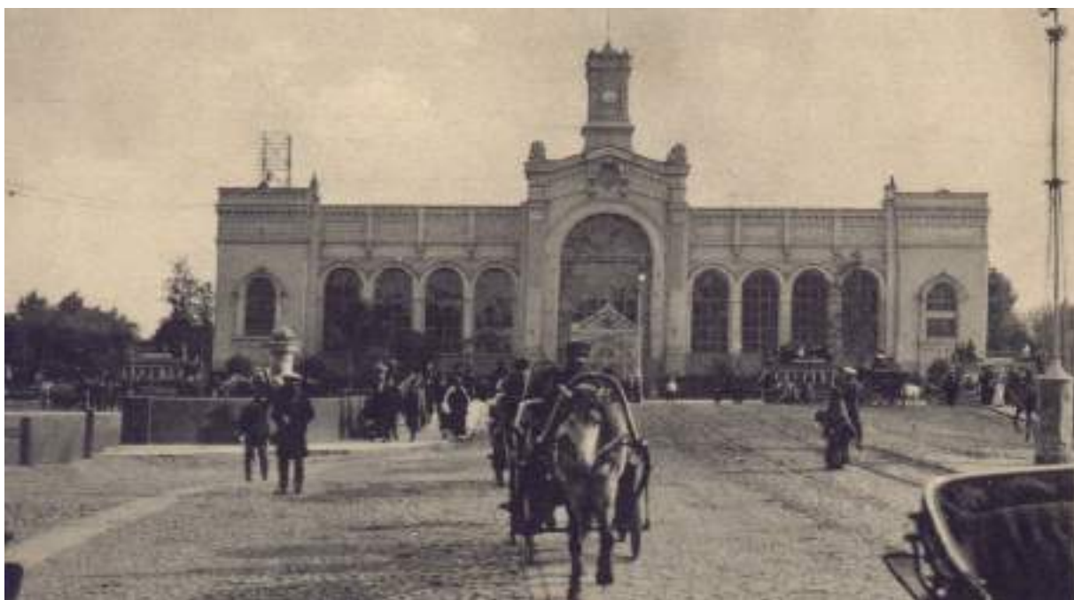
52. Здание вокзала в 1904г. Открытка. https://pastvu.com/ .
