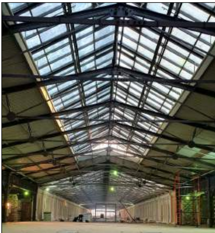
73. Фонарь в коньке крыши дебаркадера. Общий вид. Выявленный объект культурного наследия «Здание вокзала», расположенный по адресу: Санкт-Петербург, наб. Обводного канала, д. 118, лит. С, входящий в ансамбль выявленного объекта культурного наследия «Комплекс построек Варшавского вокзала». Дата съемки: 20.12.2021.
