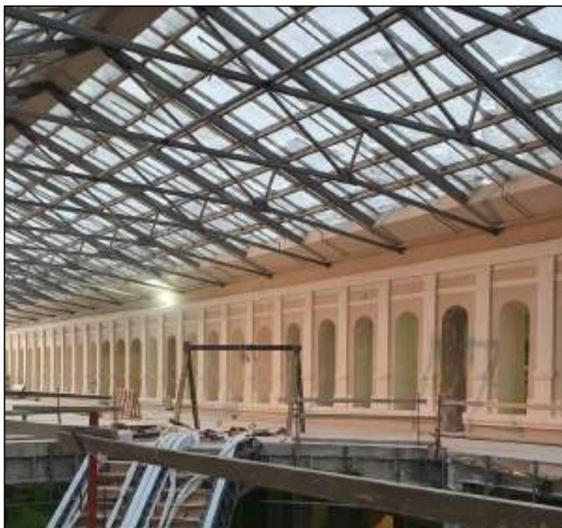
82. Интерьеры (второй этаж) бывшего внутреннего двора, перекрытого в настоящее время. Выявленный объект культурного наследия «Здание вокзала», расположенный по адресу: Санкт-Петербург, наб. Обводного канала, д. 118, лит. С, входящий в ансамбль выявленного объекта культурного наследия «Комплекс построек Варшавского вокзала». Дата съемки: 20.12.2021.
