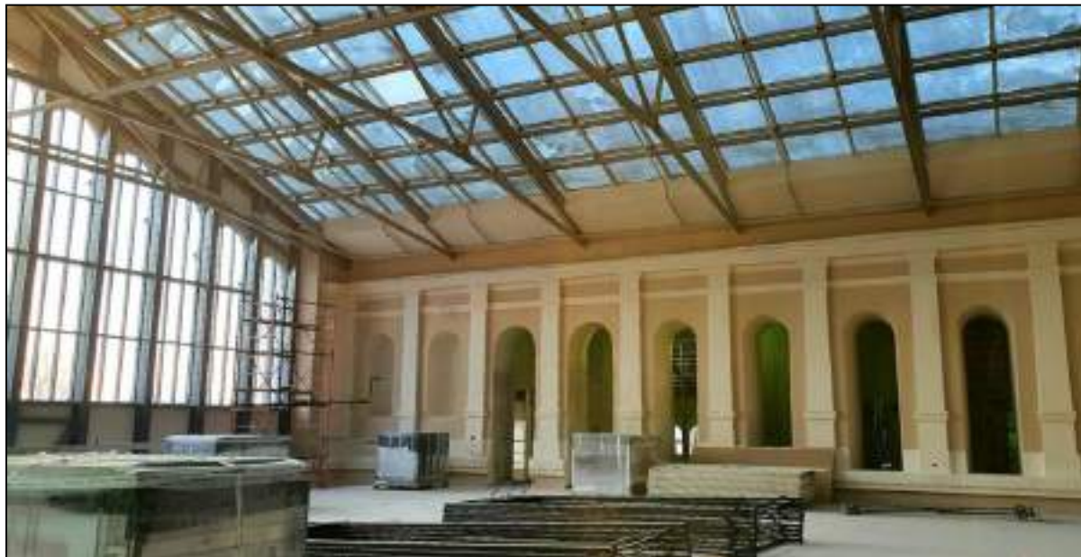
77. Интерьер второго этажа. Фрагмент. Вид на центральную часть южного фасада и современное перекрытие бывшего внутреннего двора. Выявленный объект культурного наследия «Здание вокзала», расположенный по адресу: Санкт-Петербург, наб. Обводного канала, д. 118, лит. С, входящий в ансамбль выявленного объекта культурного наследия «Комплекс построек Варшавского вокзала». Дата съемки: 20.12.2021.
