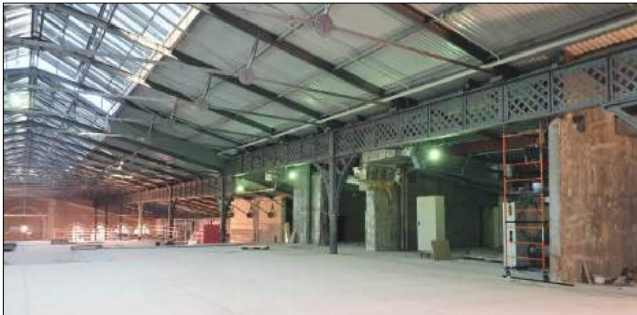
47. Фонарь в коньке крыши дебаркадера. Металлические колонны дебаркадера. Фермы. Фасонки. Выявленный объект культурного наследия «Здание вокзала», расположенный по адресу: Санкт-Петербург, наб. Обводного канала, д. 118, лит. С, входящий в ансамбль выявленного объекта культурного наследия «Комплекс построек Варшавского вокзала». Дата съемки: 20.12.2021.
