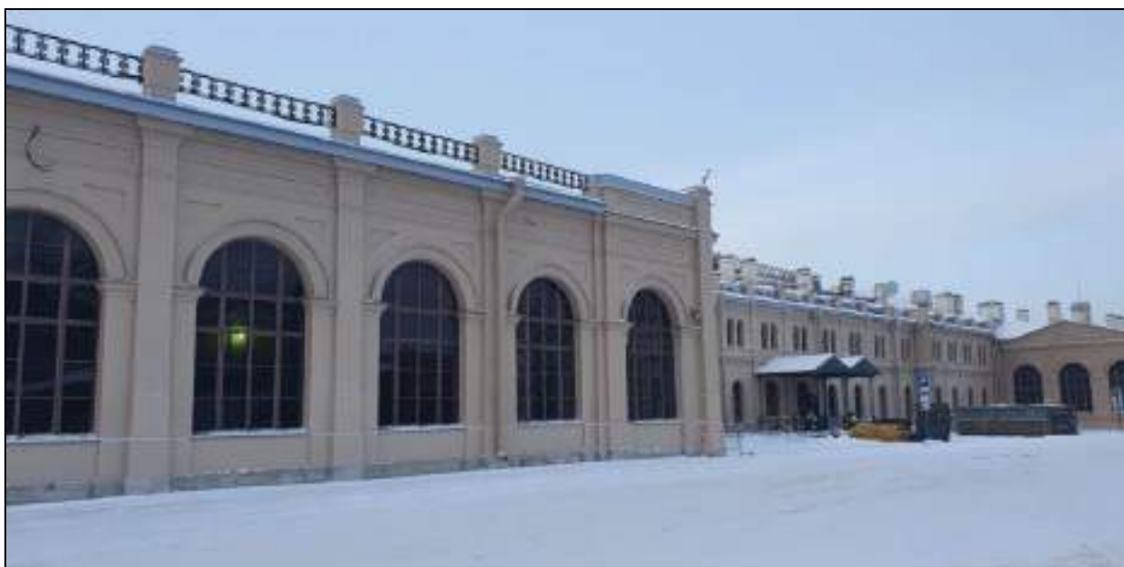
3. Боковой фасад восточного корпуса. Общий вид. Выявленный объект культурного наследия «Здание вокзала», расположенный по адресу: Санкт-Петербург, наб. Обводного канала, д. 118, лит. С, входящий в ансамбль выявленного объекта культурного наследия «Комплекс построек Варшавского вокзала». Дата съемки: 20.12.2021.
