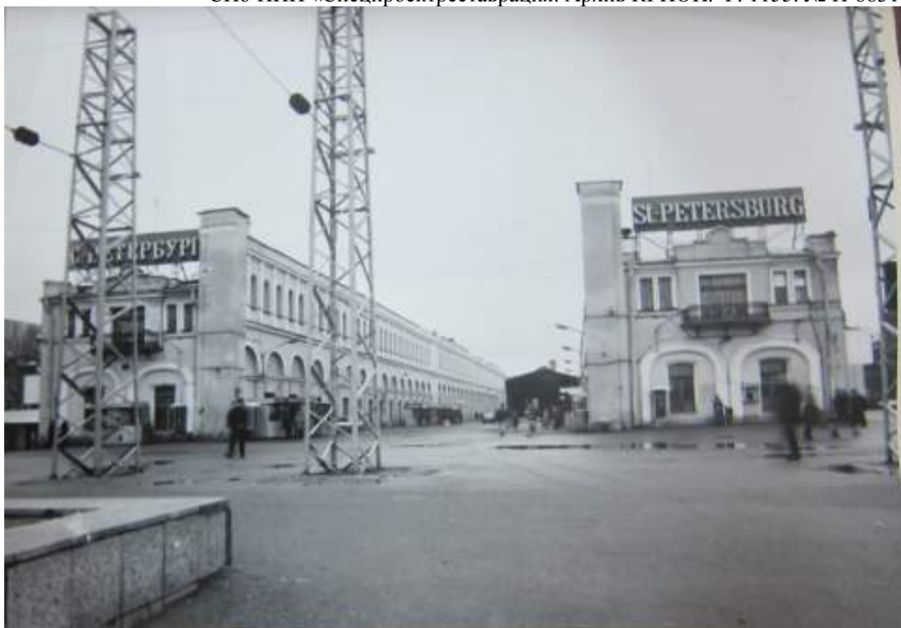
80. Варшавский вокзал. Южный фасад. 1997г. СПб НИИ «Спецпроектреставрация». Архив КГИОП. Ф. 1155. № Н-8831.
