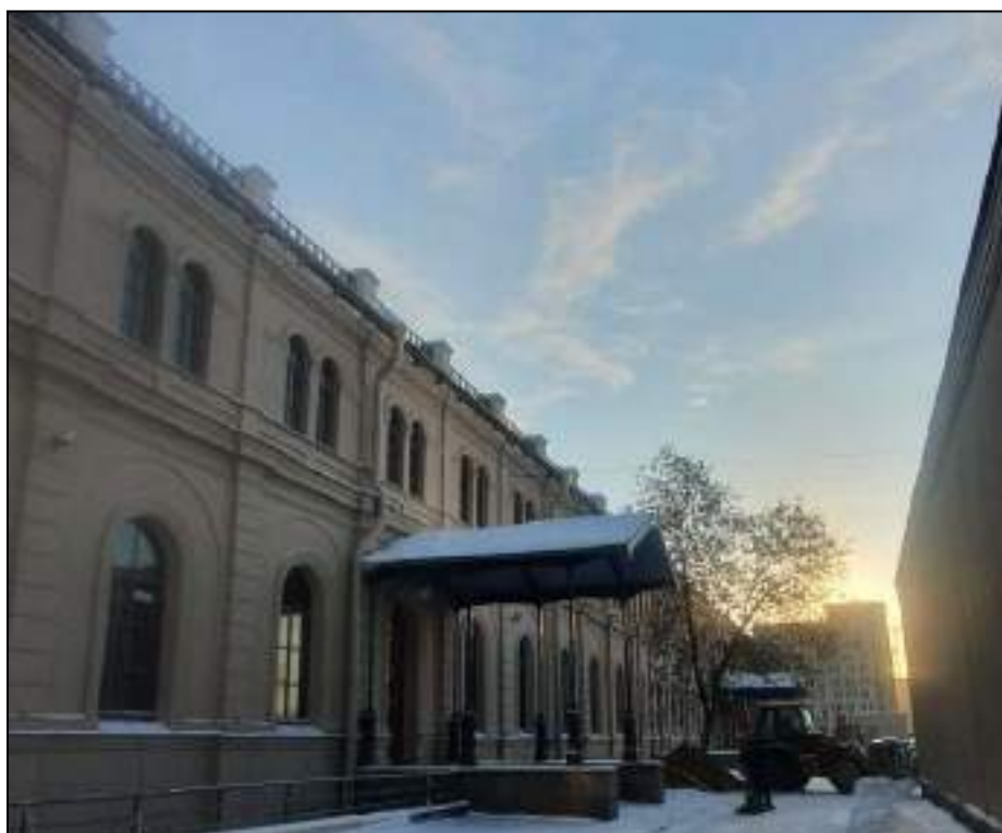
65. Лицевой фасад западного корпуса. Общий вид. Выявленный объект культурного наследия «Здание вокзала», расположенный по адресу: Санкт-Петербург, наб. Обводного канала, д. 118, лит. С, входящий в ансамбль выявленного объекта культурного наследия «Комплекс построек Варшавского вокзала». Дата съемки: 20.12.2021.
