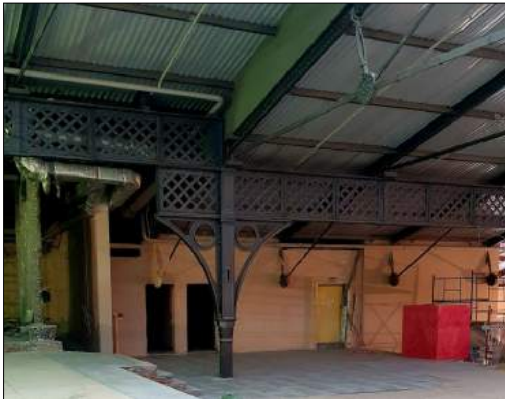
43. Фрагмент фонаря в коньке крыши дебаркадера. Ферма. Фрагмент металлической колонны. Фасонка. Выявленный объект культурного наследия «Здание вокзала», расположенный по адресу: Санкт-Петербург, наб. Обводного канала, д. 118, лит. С, входящий в ансамбль выявленного объекта культурного наследия «Комплекс построек Варшавского вокзала». Дата съемки: 20.12.2021.
