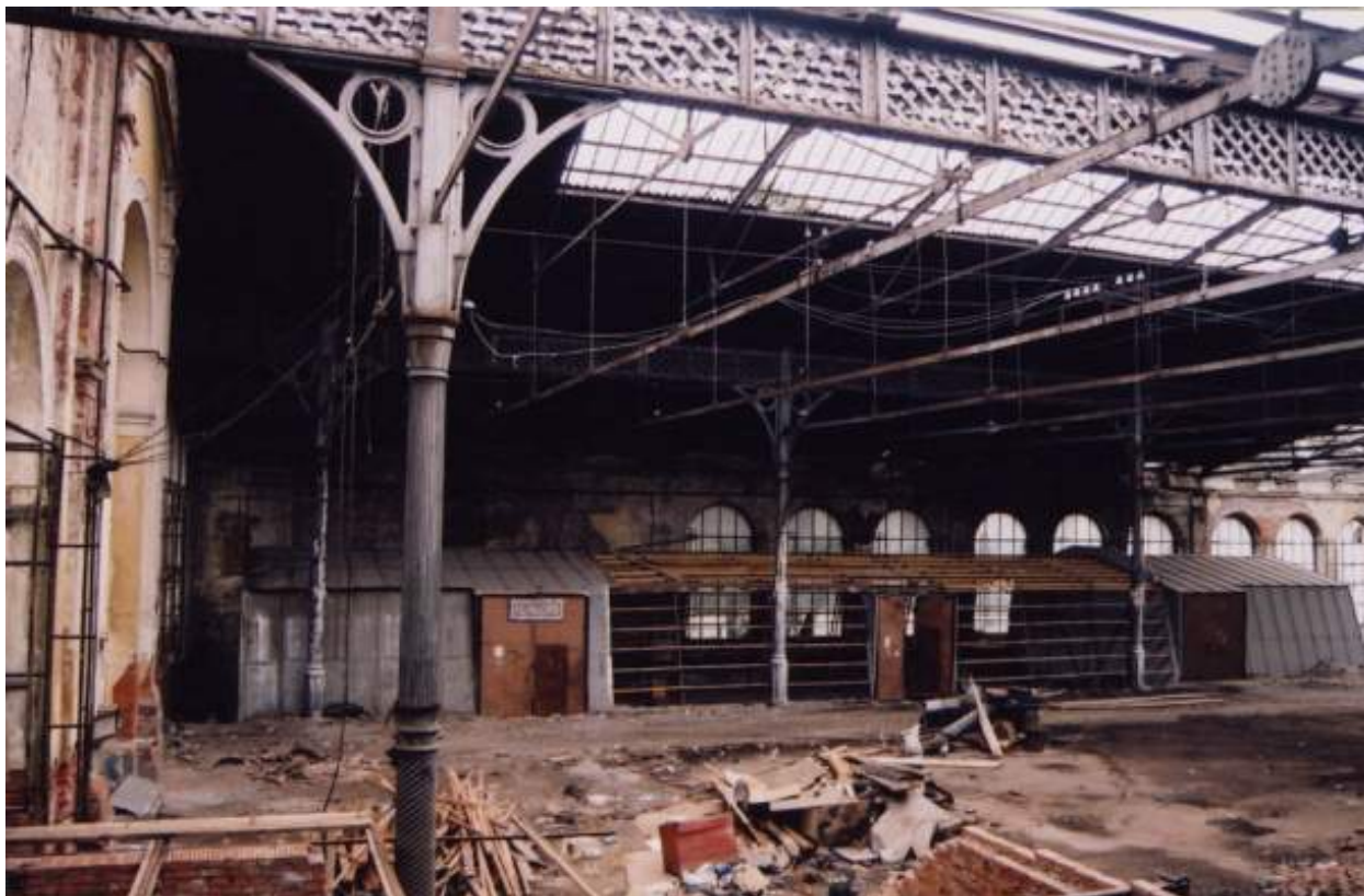
108. Здание бывшего Варшавского вокзала во время реконструкции. Видны 18 чугунных колонн французской фирмы, ранее поддерживающих стеклянную крышу. 2004г. http://www.citywalls.ru/ .
