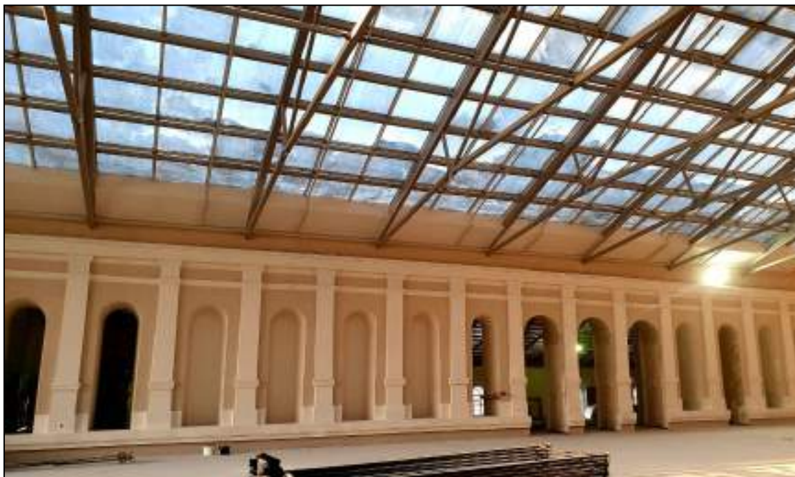
79. Интерьеры (второй этаж) бывшего внутреннего двора, перекрытого в настоящее время. Выявленный объект культурного наследия «Здание вокзала», расположенный по адресу: Санкт-Петербург, наб. Обводного канала, д. 118, лит. С, входящий в ансамбль выявленного объекта культурного наследия «Комплекс построек Варшавского вокзала». Дата съемки: 20.12.2021.
