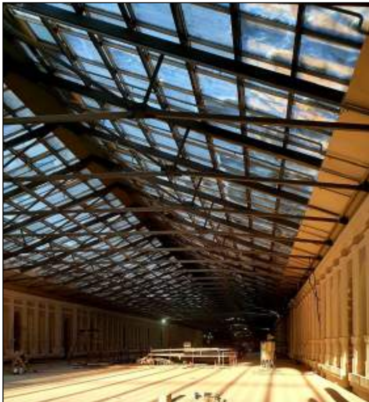
81. Интерьеры (второй этаж) бывшего внутреннего двора, перекрытого в настоящее время. Выявленный объект культурного наследия «Здание вокзала», расположенный по адресу: Санкт-Петербург, наб. Обводного канала, д. 118, лит. С, входящий в ансамбль выявленного объекта культурного наследия «Комплекс построек Варшавского вокзала». Дата съемки: 20.12.2021.
