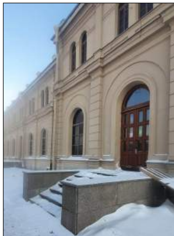
61. Фрагмент лицевого фасада западного корпуса. Исторический дверной проем. Гранитное крыльцо. Выявленный объект культурного наследия «Здание вокзала», расположенный по адресу: Санкт-Петербург, наб. Обводного канала, д. 118, лит. С, входящий в ансамбль выявленного объекта культурного наследия «Комплекс построек Варшавского вокзала». Дата съемки: 20.12.2021.
