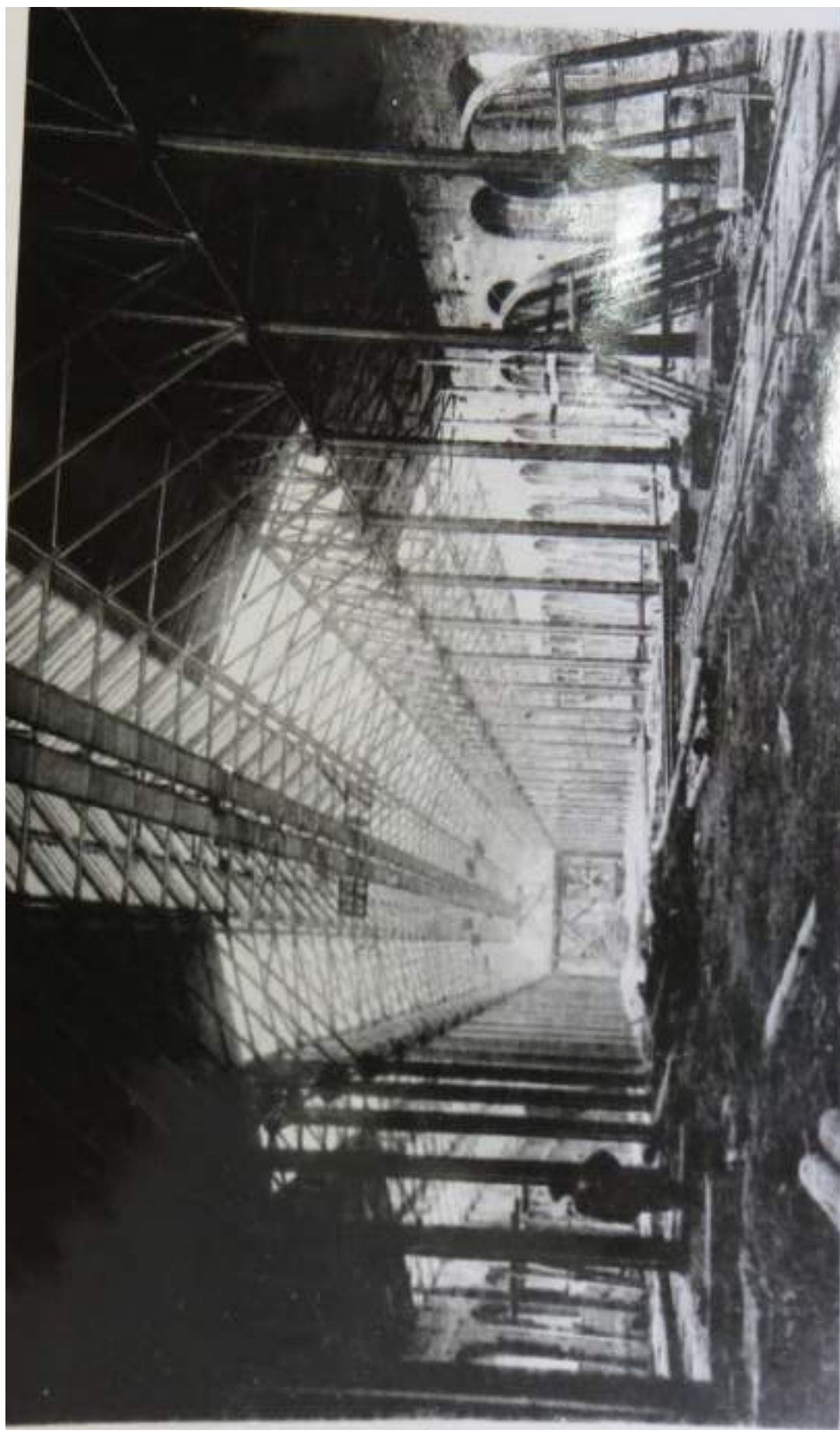
31. Внутренний вид сарая для императорских поездов. Передвижные подмости и рельсовый путь для них. 1897–1898гг.
