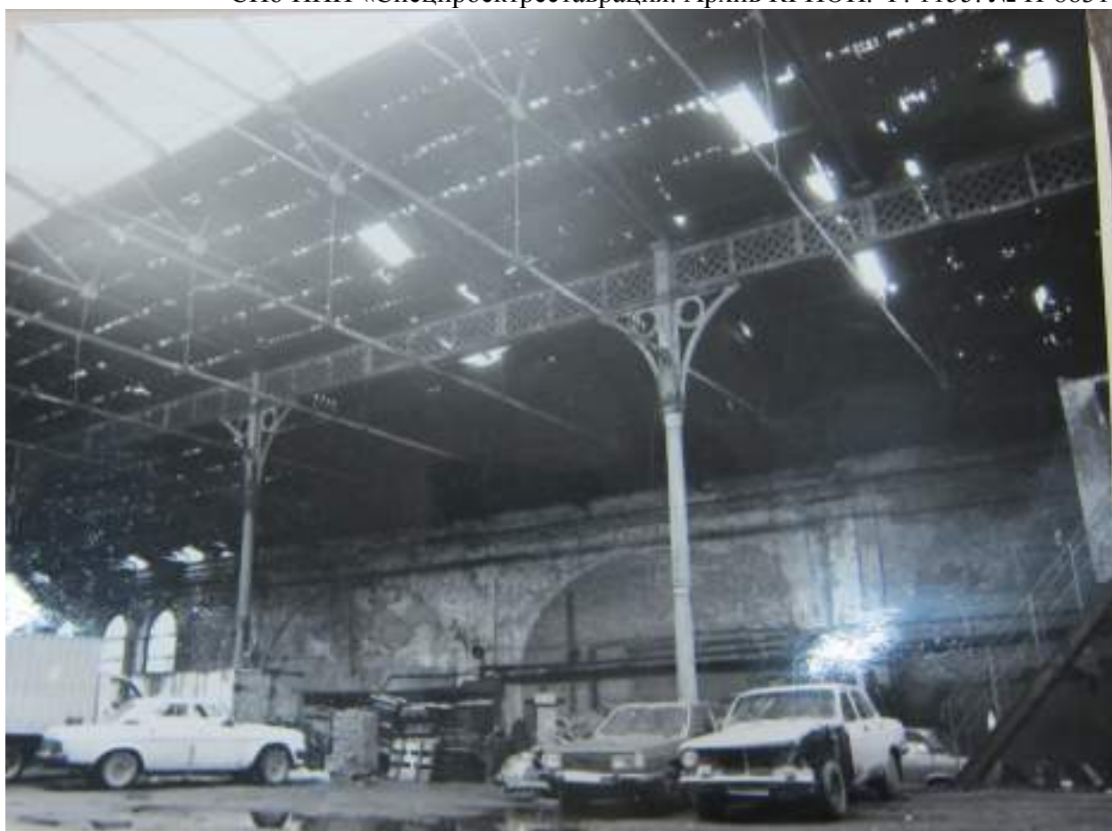
84. Варшавский вокзал. Дебаркадер. Фрагмент. Вид на восточную стену. 1997г. СПб НИИ «Спецпроектреставрация». Архив КГИОП. Ф. 1155. № Н-8831.
