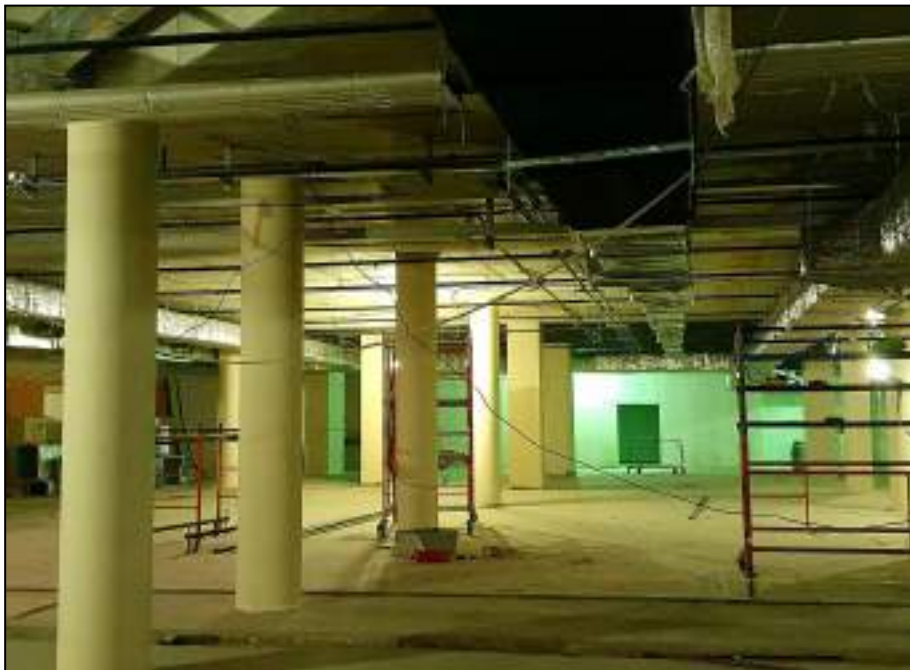
23. Фрагмент интерьера бывшего внутреннего двора, перекрытого в настоящее время. Выявленный объект культурного наследия «Здание вокзала», расположенный по адресу: Санкт-Петербург, наб. Обводного канала, д. 118, лит. С, входящий в ансамбль выявленного объекта культурного наследия «Комплекс построек Варшавского вокзала». Дата съемки: 20.12.2021.
