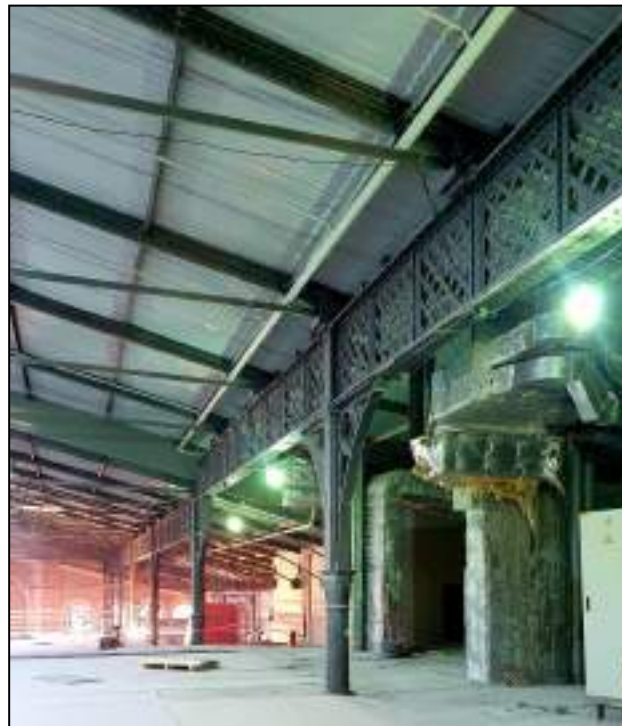
39. Фонарь в коньке крыши дебаркадера. Металлические колонны дебаркадера. Выявленный объект культурного наследия «Здание вокзала», расположенный по адресу: Санкт-Петербург, наб. Обводного канала, д. 118, лит. С, входящий в ансамбль выявленного объекта культурного наследия «Комплекс построек Варшавского вокзала». Дата съемки: 20.12.2021.
