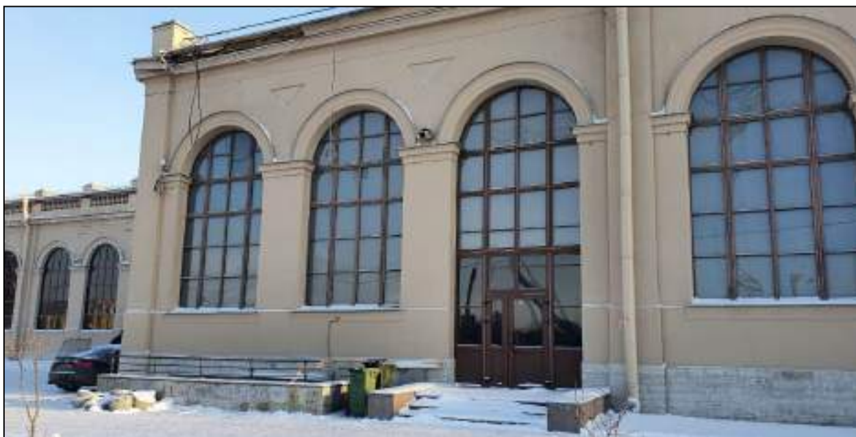
69. Лицевой фасад западного корпуса. Фрагмент. Лицевой фасад пристройки. Выявленный объект культурного наследия «Здание вокзала», расположенный по адресу: Санкт-Петербург, наб. Обводного канала, д. 118, лит. С, входящий в ансамбль выявленного объекта культурного наследия «Комплекс построек Варшавского вокзала». Дата съемки: 20.12.2021.
