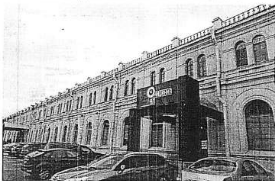
Западный фасад. Съемка июль 2012. Е.В. Черненко
