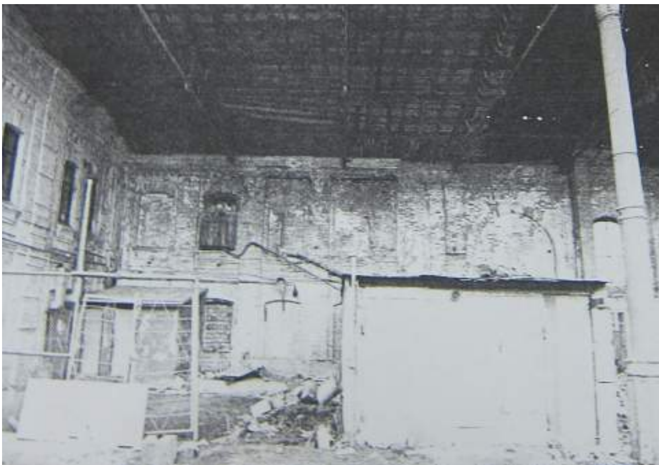
100. Фрагмент западной стены дебаркадера. Вид с востока. 2003г. ООО «Архитектурное бюро «Литейная часть-91»». Архив КГИОП. Ф. 1155. № Н-5881.
