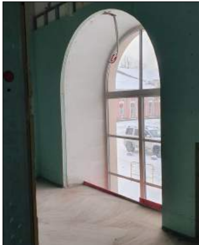
19. Исторический оконный проем. Фрагмент интерьера бывшего внутреннего двора, перекрытого в настоящее время. Выявленный объект культурного наследия «Здание вокзала», расположенный по адресу: Санкт-Петербург, наб. Обводного канала, д. 118, лит. С, входящий в ансамбль выявленного объекта культурного наследия «Комплекс построек Варшавского вокзала». Дата съемки: 20.12.2021.
