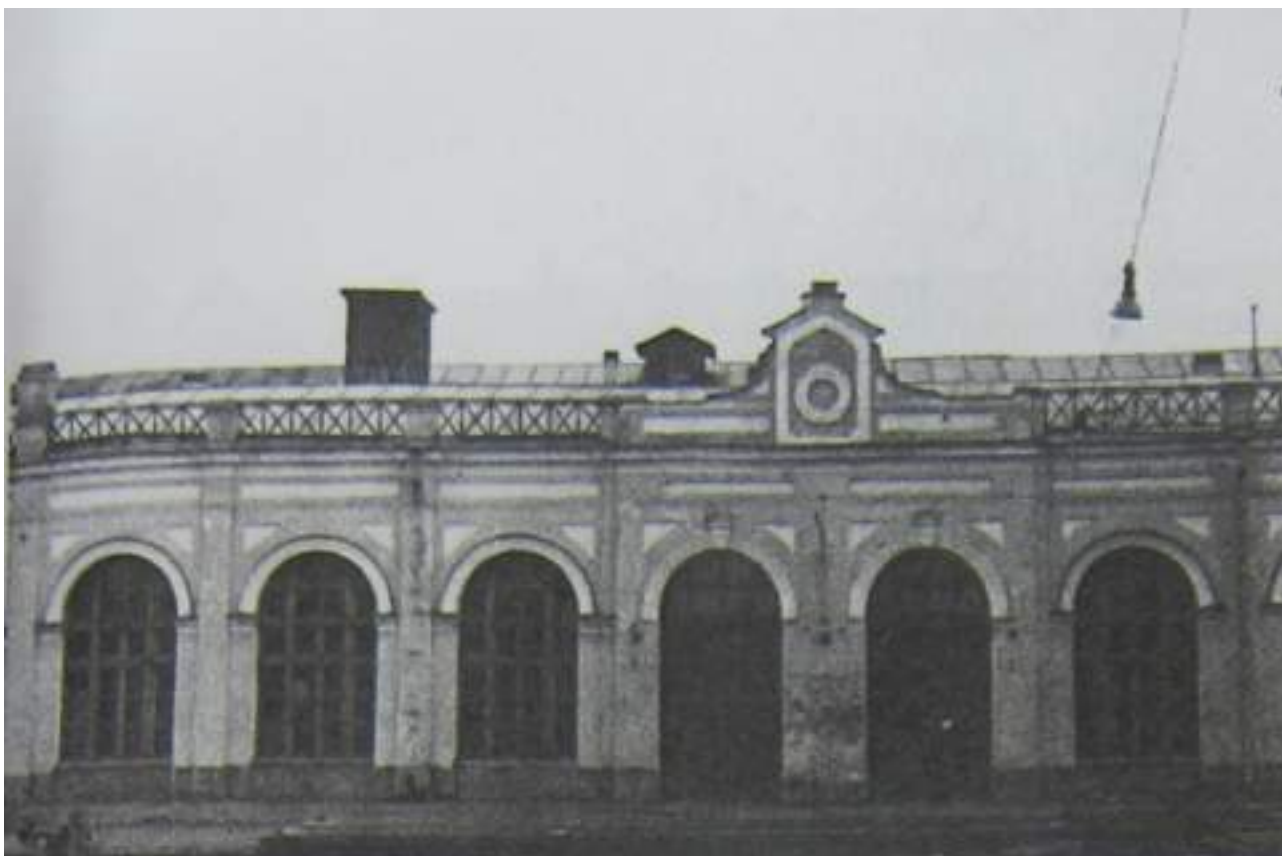
94. Фрагмент фасада пристройки. Вид с востока. 2003г. ООО «Архитектурное бюро «Литейная часть-91»». Архив КГИОП. Ф. 1155. № Н-5881.
