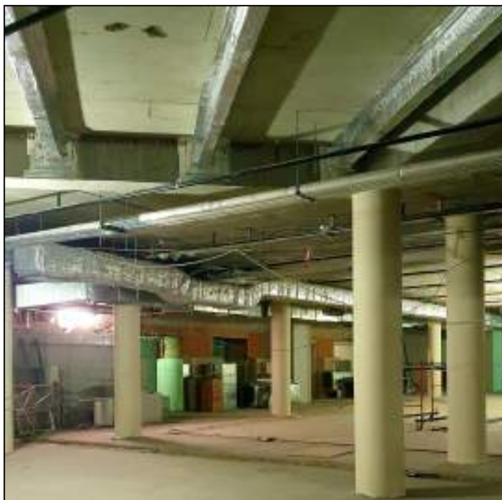
18. Интерьеры бывшего внутреннего двора, перекрытого в настоящее время. Фрагмент. Выявленный объект культурного наследия «Здание вокзала», расположенный по адресу: Санкт-Петербург, наб. Обводного канала, д. 118, лит. С, входящий в ансамбль выявленного объекта культурного наследия «Комплекс построек Варшавского вокзала». Дата съемки: 20.12.2021.
