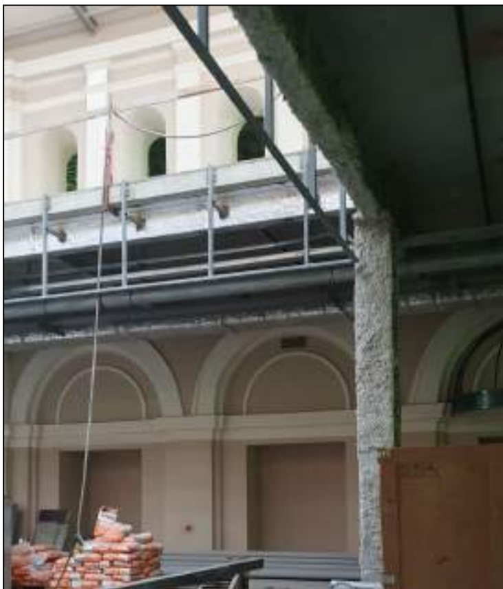
75. Интерьеры бывшего внутреннего двора, перекрытого в настоящее время. Фрагмент. Выявленный объект культурного наследия «Здание вокзала», расположенный по адресу: Санкт-Петербург, наб. Обводного канала, д. 118, лит. С, входящий в ансамбль выявленного объекта культурного наследия «Комплекс построек Варшавского вокзала». Дата съемки: 20.12.2021.
