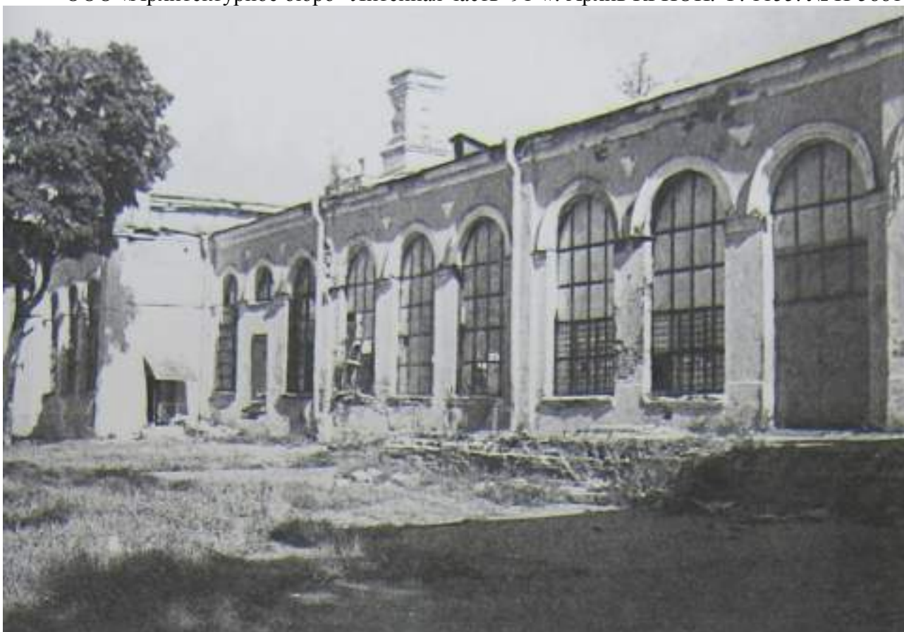
88. Западная стена дебаркадера. Фрагмент. Вид с юго-запада. 2003г. ООО «Архитектурное бюро «Литейная часть-91»». Архив КГИОП. Ф. 1155. № Н-5881.
