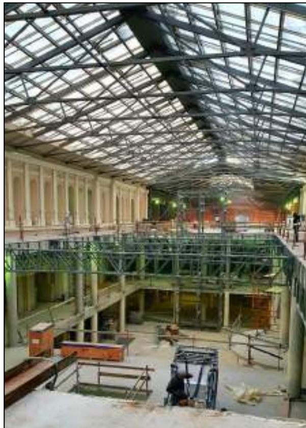
86. Интерьеры бывшего внутреннего двора, перекрытого в настоящее время. Общий вид. Выявленный объект культурного наследия «Здание вокзала», расположенный по адресу: Санкт-Петербург, наб. Обводного канала, д. 118, лит. С, входящий в ансамбль выявленного объекта культурного наследия «Комплекс построек Варшавского вокзала». Дата съемки: 20.12.2021.
