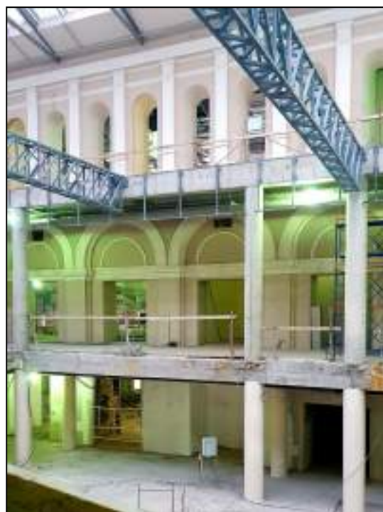
34. Фрагмент интерьера бывшего внутреннего двора, перекрытого в настоящее время. Выявленный объект культурного наследия «Здание вокзала», расположенный по адресу: Санкт-Петербург, наб. Обводного канала, д. 118, лит. С, входящий в ансамбль выявленного объекта культурного наследия «Комплекс построек Варшавского вокзала». Дата съемки: 20.12.2021.
