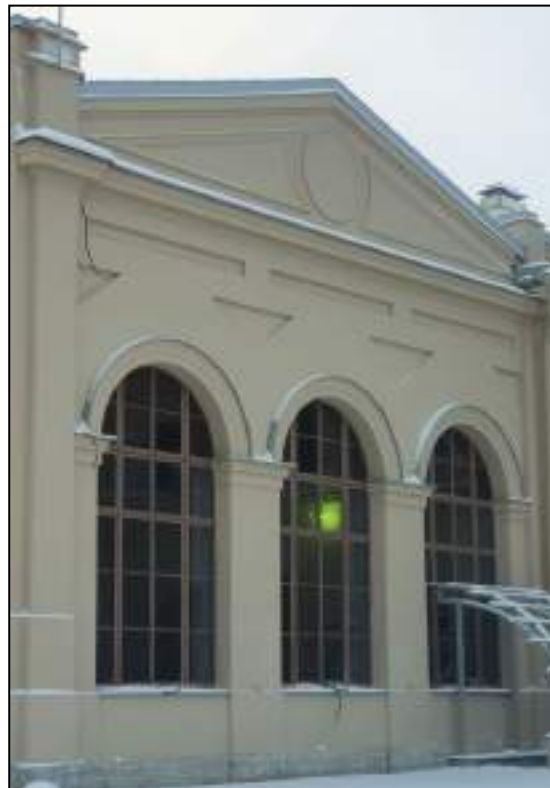
12. Боковой фасад пристройки лицевого фасада восточного корпуса. Выявленный объект культурного наследия «Здание вокзала», расположенный по адресу: Санкт-Петербург, наб. Обводного канала, д. 118, лит. С, входящий в ансамбль выявленного объекта культурного наследия «Комплекс построек Варшавского вокзала». Дата съемки: 20.12.2021.
