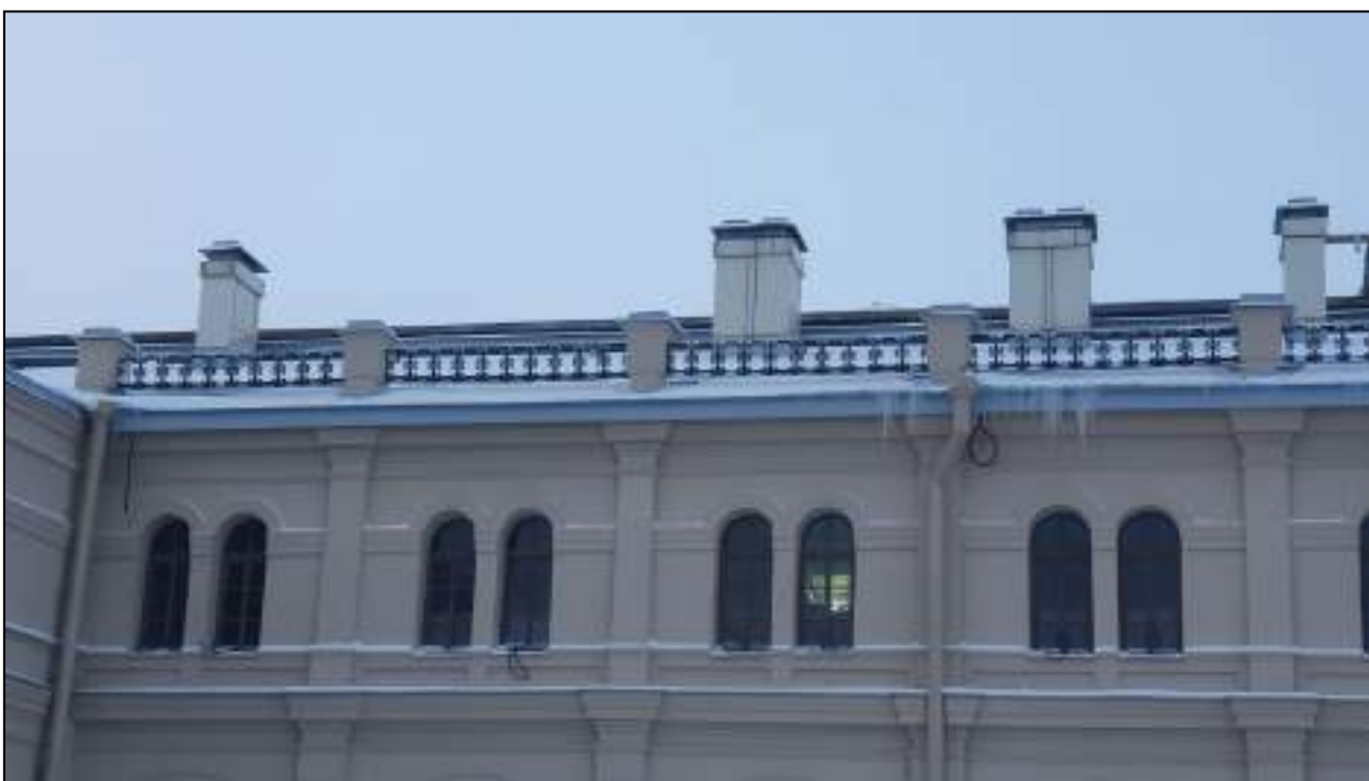
11. Фрагмент лицевого фасада восточного корпуса. Профилированный карниз; парапетное ограждение с решеткой; парапетное ограждение в виде тумб. Выявленный объект культурного наследия «Здание вокзала», расположенный по адресу: Санкт-Петербург, наб. Обводного канала, д. 118, лит. С, входящий в ансамбль выявленного объекта культурного наследия «Комплекс построек Варшавского вокзала». Дата съемки: 20.12.2021.
