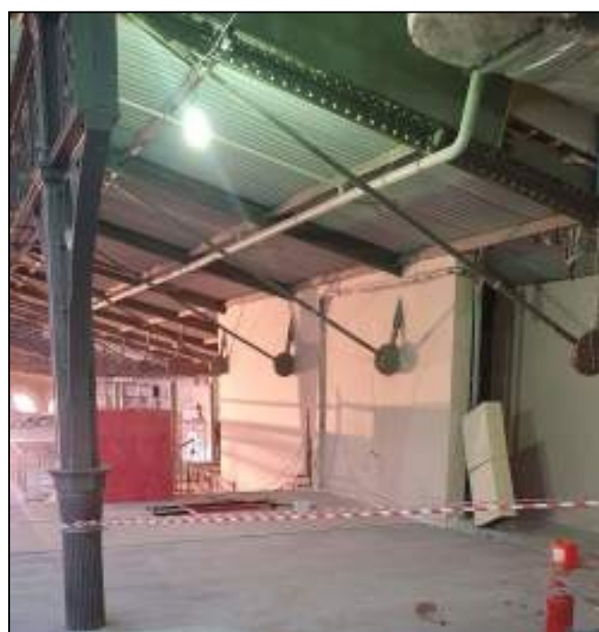
42. Фрагмент фонаря в коньке крыши дебаркадера. Фермы. Фасонки. Выявленный объект культурного наследия «Здание вокзала», расположенный по адресу: Санкт-Петербург, наб. Обводного канала, д. 118, лит. С, входящий в ансамбль выявленного объекта культурного наследия «Комплекс построек Варшавского вокзала». Дата съемки: 20.12.2021.
