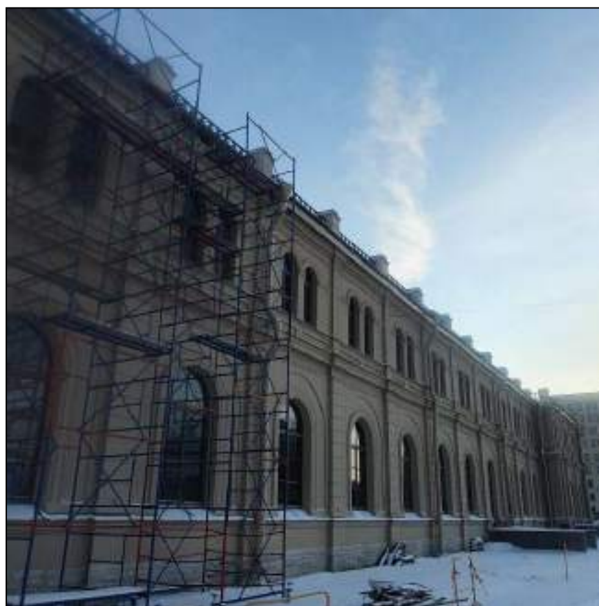
53. Фрагмент лицевого фасада западного корпуса. Выявленный объект культурного наследия «Здание вокзала», расположенный по адресу: Санкт-Петербург, наб. Обводного канала, д. 118, лит. С, входящий в ансамбль выявленного объекта культурного наследия «Комплекс построек Варшавского вокзала». Дата съемки: 20.12.2021.
