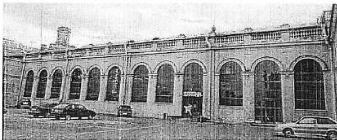
Западный фасад. Съемка июль 2012. Е.В. Черненко
