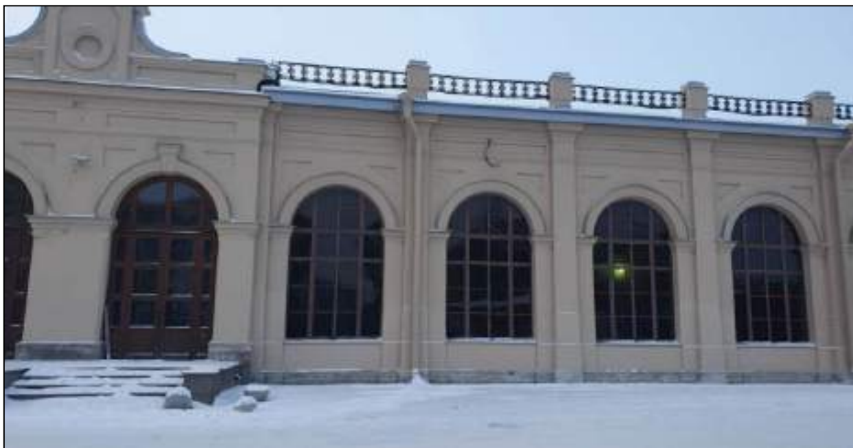
2. Боковой фасад восточного корпуса. Фрагмент. Исторические оконные проемы – полуциркульные в виде стилизованной аркады. Выявленный объект культурного наследия «Здание вокзала», расположенный по адресу: Санкт-Петербург, наб. Обводного канала, д. 118, лит. С, входящий в ансамбль выявленного объекта культурного наследия «Комплекс построек Варшавского вокзала». Дата съемки: 20.12.2021.
