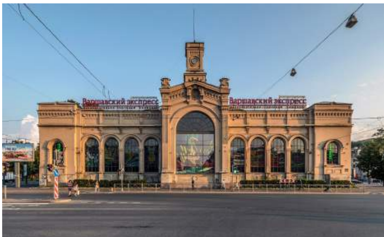
113. Варшавский вокзал после реконструкции. 2006г. https://ru.wikipedia.org/ .
