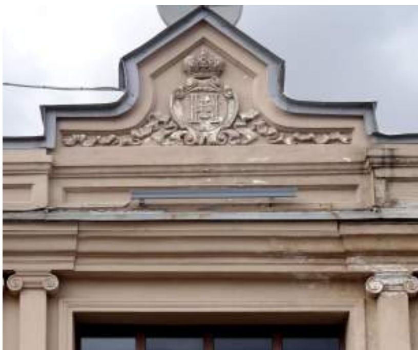
118. Фрагмент южного фасада параллельного восточного корпуса – рустованная лопатка с гирляндой растительного орнамента, профилированный междуэтажный карниз, профилированный венчающий карниз, многоступенчатый аттик со штукатурной лентой в картуше, увенчанной короной, буква и цифра «Н I». 2014г. http://www.citywalls.ru/ .
