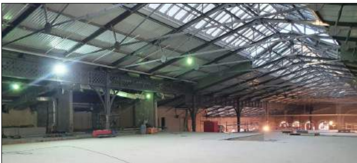
48. Фонарь в коньке крыши дебаркадера. Металлические колонны дебаркадера. Фермы. Фасонки. Выявленный объект культурного наследия «Здание вокзала», расположенный по адресу: Санкт-Петербург, наб. Обводного канала, д. 118, лит. С, входящий в ансамбль выявленного объекта культурного наследия «Комплекс построек Варшавского вокзала». Дата съемки: 20.12.2021.
