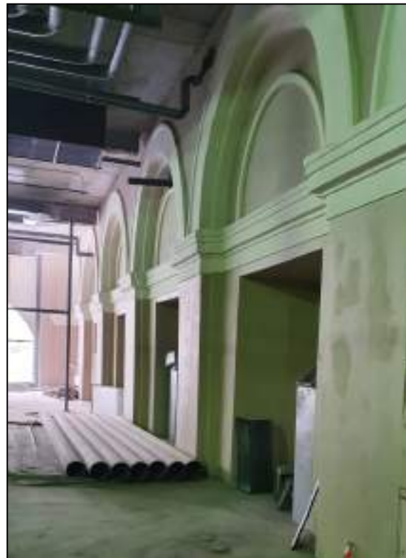
33. Интерьеры бывшего внутреннего двора, перекрытого в настоящее время. Оформление оконных проемов нижнего уровня – профилированные архивольты на импостах; профилированные карнизы. Выявленный объект культурного наследия «Здание вокзала», расположенный по адресу: Санкт-Петербург, наб. Обводного канала, д. 118, лит. С, входящий в ансамбль выявленного объекта культурного наследия «Комплекс построек Варшавского вокзала». Дата съемки: 20.12.2021.
