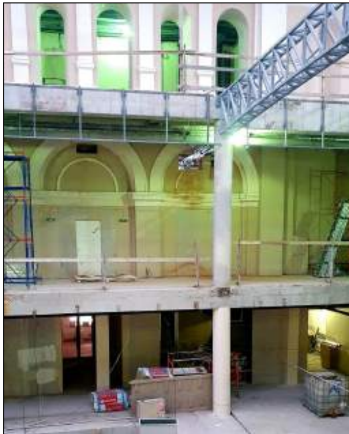
45. Фрагмент интерьера бывшего внутреннего двора, перекрытого в настоящее время. Выявленный объект культурного наследия «Здание вокзала», расположенный по адресу: Санкт-Петербург, наб. Обводного канала, д. 118, лит. С, входящий в ансамбль выявленного объекта культурного наследия «Комплекс построек Варшавского вокзала». Дата съемки: 20.12.2021.
