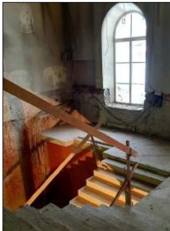
31. Интерьер второго этажа. Историческое местоположение лестницы. Выявленный объект культурного наследия «Здание вокзала», расположенный по адресу: Санкт-Петербург, наб. Обводного канала, д. 118, лит. С, входящий в ансамбль выявленного объекта культурного наследия «Комплекс построек Варшавского вокзала». Дата съемки: 20.12.2021.
