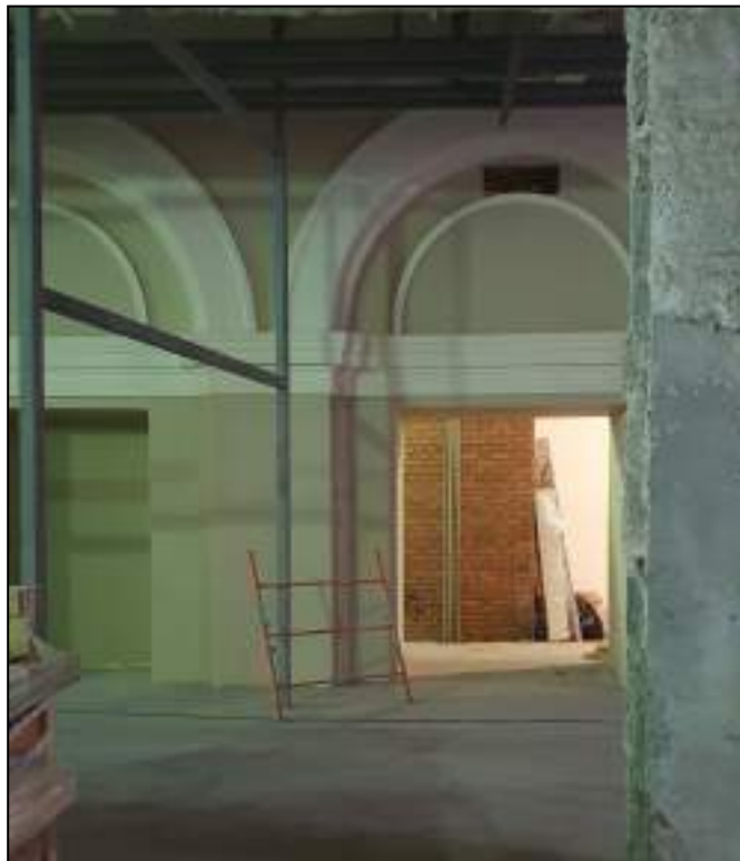
25. Фрагмент интерьера бывшего внутреннего двора, перекрытого в настоящее время. Выявленный объект культурного наследия «Здание вокзала», расположенный по адресу: Санкт-Петербург, наб. Обводного канала, д. 118, лит. С, входящий в ансамбль выявленного объекта культурного наследия «Комплекс построек Варшавского вокзала». Дата съемки: 20.12.2021.
