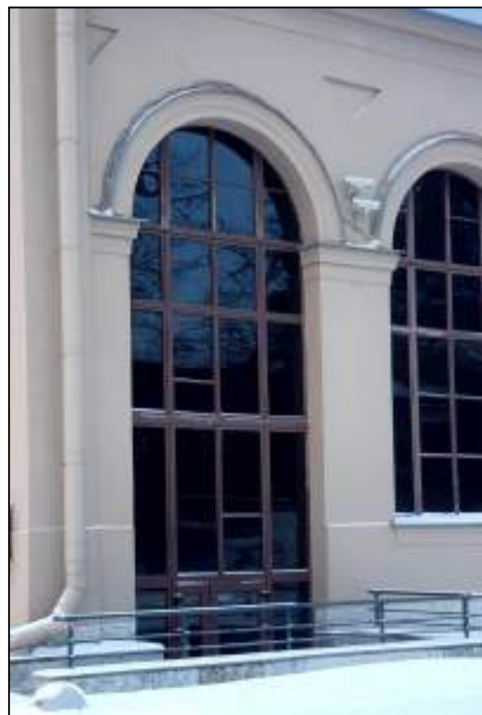
9. Фрагмент лицевого фасада восточного корпуса. Исторический дверной проем. Выявленный объект культурного наследия «Здание вокзала», расположенный по адресу: Санкт-Петербург, наб. Обводного канала, д. 118, лит. С, входящий в ансамбль выявленного объекта культурного наследия «Комплекс построек Варшавского вокзала». Дата съемки: 20.12.2021.
