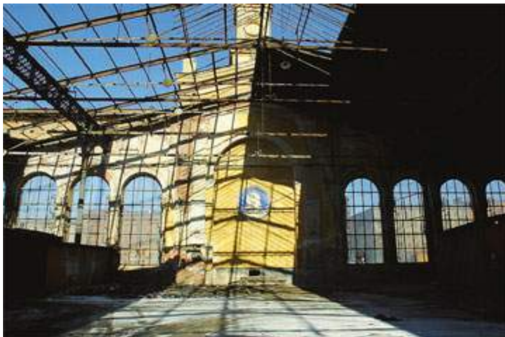
112. Здание бывшего Варшавского вокзала во время реконструкции. 2005г. http://kn.sobaka.ru/ .
