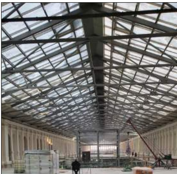
46. Интерьер второго этажа. Фрагмент. Вид на южный фасад. Выявленный объект культурного наследия «Здание вокзала», расположенный по адресу: Санкт-Петербург, наб. Обводного канала, д. 118, лит. С, входящий в ансамбль выявленного объекта культурного наследия «Комплекс построек Варшавского вокзала». Дата съемки: 20.12.2021.
