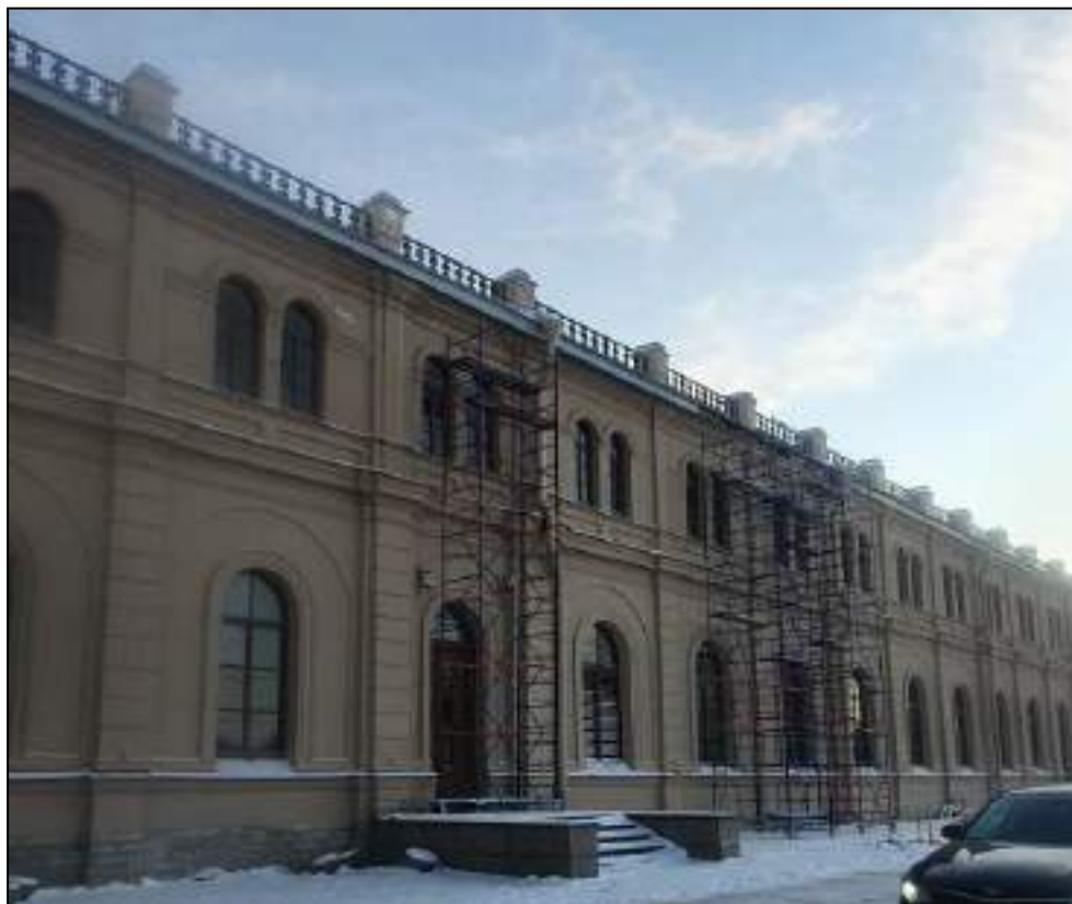
54. Фрагмент лицевого фасада западного корпуса. Выявленный объект культурного наследия «Здание вокзала», расположенный по адресу: Санкт-Петербург, наб. Обводного канала, д. 118, лит. С, входящий в ансамбль выявленного объекта культурного наследия «Комплекс построек Варшавского вокзала». Дата съемки: 20.12.2021.
