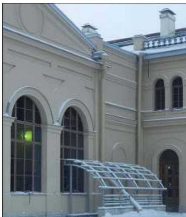
13. Место примыкания бокового фасада пристройки лицевого фасада восточного корпуса и непосредственно лицевого фасада восточного корпуса. Выявленный объект культурного наследия «Здание вокзала», расположенный по адресу: Санкт-Петербург, наб. Обводного канала, д. 118, лит. С, входящий в ансамбль выявленного объекта культурного наследия «Комплекс построек Варшавского вокзала». Дата съемки: 20.12.2021.
