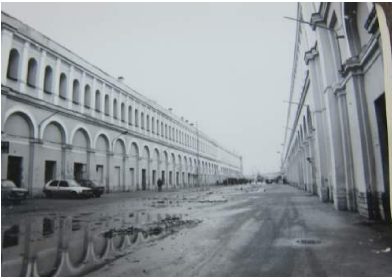
85. Варшавский вокзал. Вид от дебаркадера на юг, вдоль внутреннего двора в сторону платформы. 1997г. СПб НИИ «Спецпроектреставрация». Архив КГИОП. Ф. 1155. № Н-8831.
