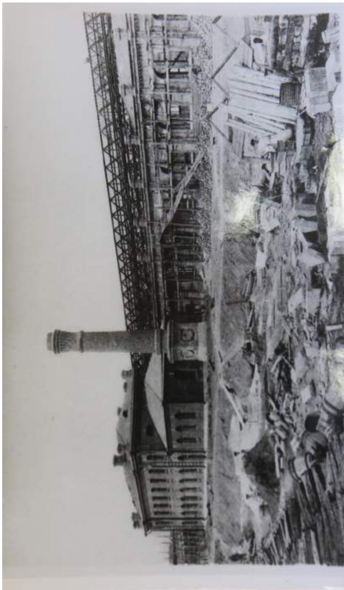
32. Общий вид сарая для императорских поездов и пристройки к нему. Приготовление цементно-бетонных облицовочных камней. 1897–1898гг.
