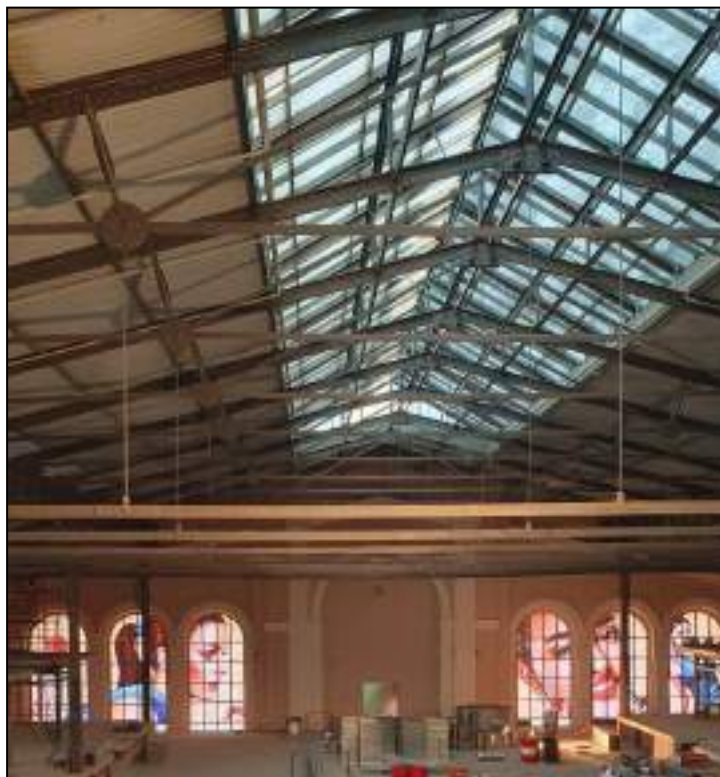
37. Фонарь в коньке крыши дебаркадера. Металлические фермы конструкции. Выявленный объект культурного наследия «Здание вокзала», расположенный по адресу: Санкт-Петербург, наб. Обводного канала, д. 118, лит. С, входящий в ансамбль выявленного объекта культурного наследия «Комплекс построек Варшавского вокзала». Дата съемки: 20.12.2021.
