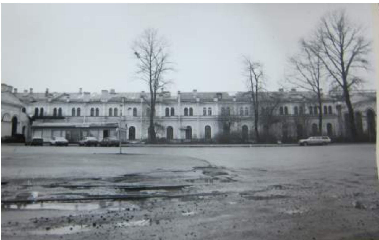
82. Варшавский вокзал. Восточный фасад. Фрагмент. Восточный корпус. 1997г. СПб НИИ «Спецпроектреставрация». Архив КГИОП. Ф. 1155. № Н-8831.
