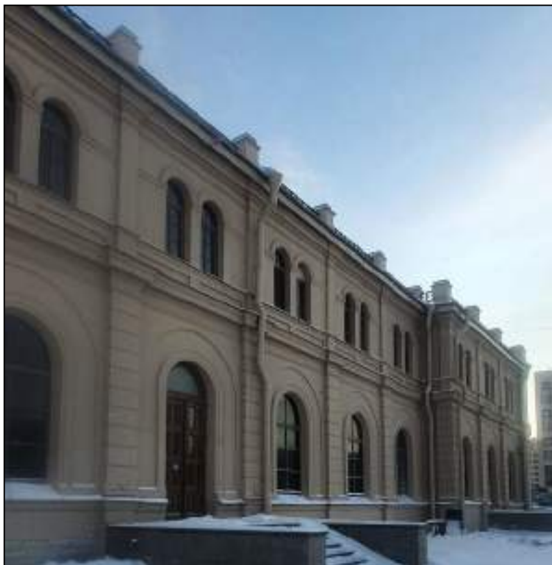
64. Лицевой фасад западного корпуса. Фрагмент. Исторический дверной проем и гранитное крыльцо. Выявленный объект культурного наследия «Здание вокзала», расположенный по адресу: Санкт-Петербург, наб. Обводного канала, д. 118, лит. С, входящий в ансамбль выявленного объекта культурного наследия «Комплекс построек Варшавского вокзала». Дата съемки: 20.12.2021.
