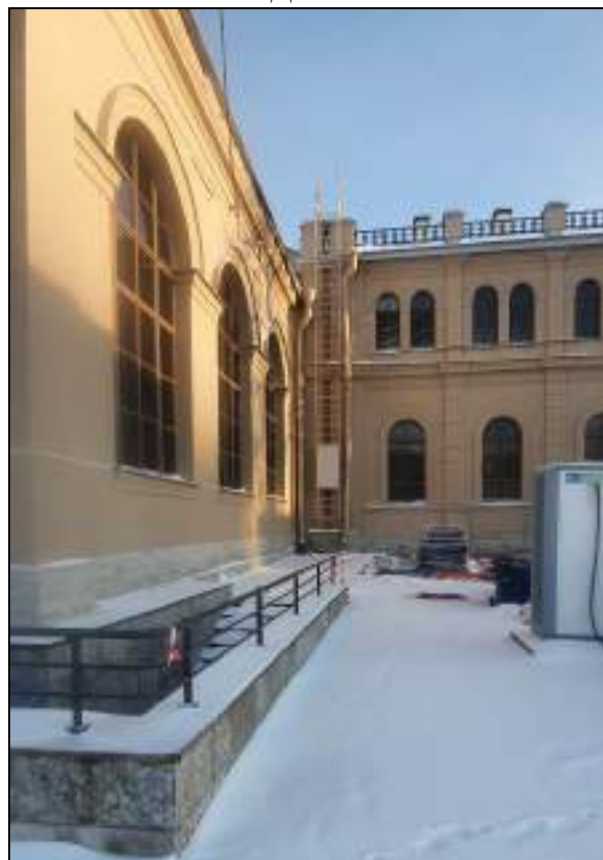
67. Лицевой фасад западного корпуса. Фрагмент. Место примыкания бокового фасада пристройки лицевого фасада и непосредственно фасада западного корпуса. Выявленный объект культурного наследия «Здание вокзала», расположенный по адресу: Санкт-Петербург, наб. Обводного канала, д. 118, лит. С, входящий в ансамбль выявленного объекта культурного наследия «Комплекс построек Варшавского вокзала». Дата съемки: 20.12.2021.
