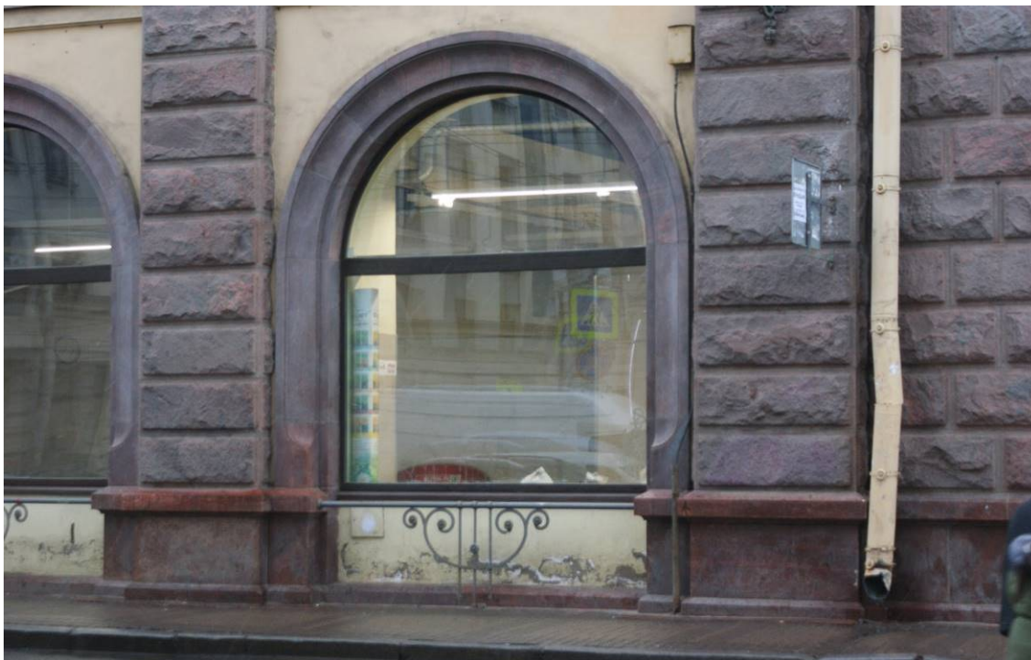
Фото 11. Здание по адресу: г. Санкт-Петербург, Звенигородская улица, дом 2/44, литера А. Лицевой фасад по Загородному пр. Фрагмент. Съемка 24.11.2021 г. Трушковский В. Э.
