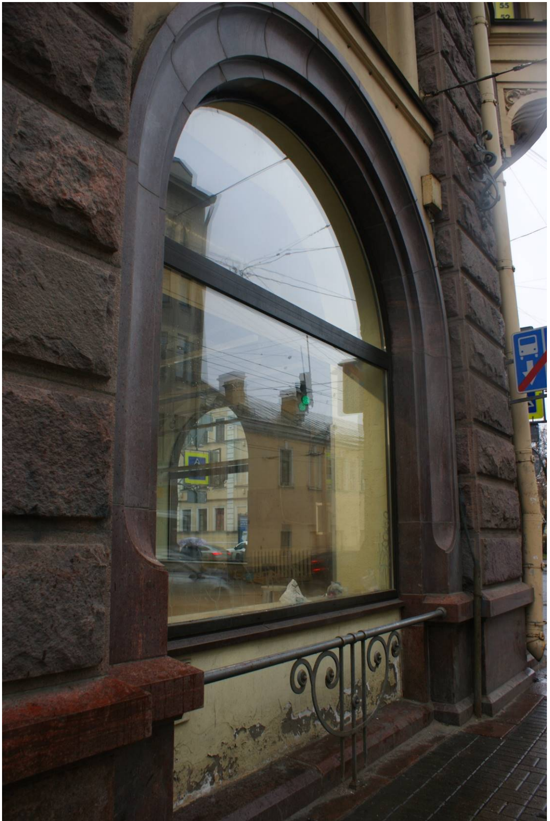
Фото 10. Здание по адресу: г. Санкт-Петербург, Звенигородская улица, дом 2/44, литера А. Лицевой фасад по Загородному пр. Фрагмент. Съемка 24.11.2021 г. Трушковский В. Э.
