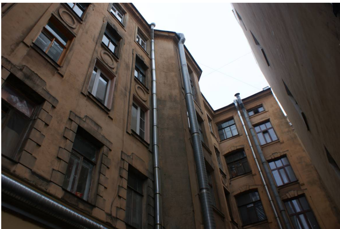
Фото 39. Здание по адресу: г. Санкт-Петербург, Звенигородская улица, дом 2/44, литера А. Северо-восточный дворовой фасад. Фрагмент. Съемка 24.11.2021 г. Трушковский В. Э.
