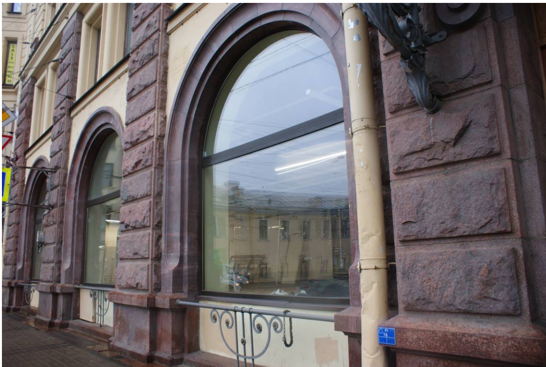
Фото 19. Здание по адресу: г. Санкт-Петербург, Звенигородская улица, дом 2/44, литера А. Лицевой фасад по Звенигородской ул. Фрагмент. Оформление окон 1-го этажа. Съемка 24.11.2021 г. Трушковский В. Э.
