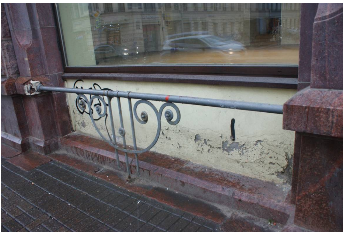
Фото 12. Здание по адресу: г. Санкт-Петербург, Звенигородская улица, дом 2/44, литера А. Лицевой фасад по Загородному пр. Фрагмент. Съемка 24.11.2021 г. Трушковский В. Э.
