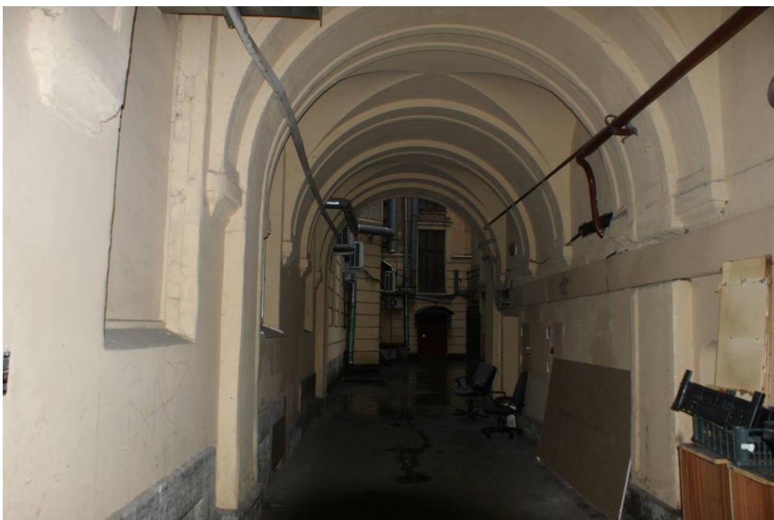
Фото 37. Здание по адресу: г. Санкт-Петербург, Звенигородская улица, дом 2/44, литера А. Воротный проезд между дворовыми корпусами. Съемка 24.11.2021 г. Трушковский В. Э.
