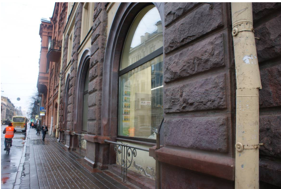
Фото 9. Здание по адресу: г. Санкт-Петербург, Звенигородская улица, дом 2/44, литера А. Лицевой фасад по Загородному пр. Фрагмент. Съемка 24.11.2021 г. Трушковский В. Э.
