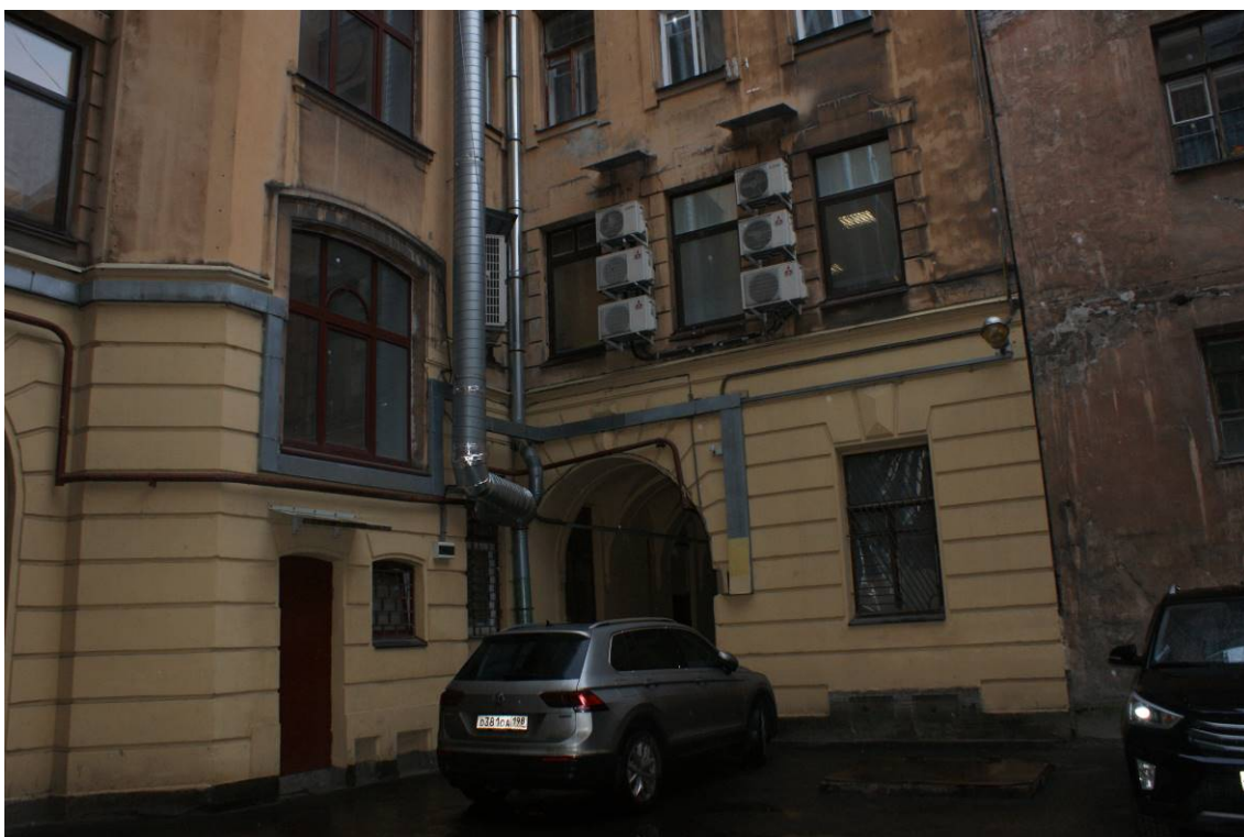
Фото 35. Здание по адресу: г. Санкт-Петербург, Звенигородская улица, дом 2/44, литера А. Юго-восточный дворовой фасад. Фрагмент. Съемка 24.11.2021 г. Трушковский В. Э.
