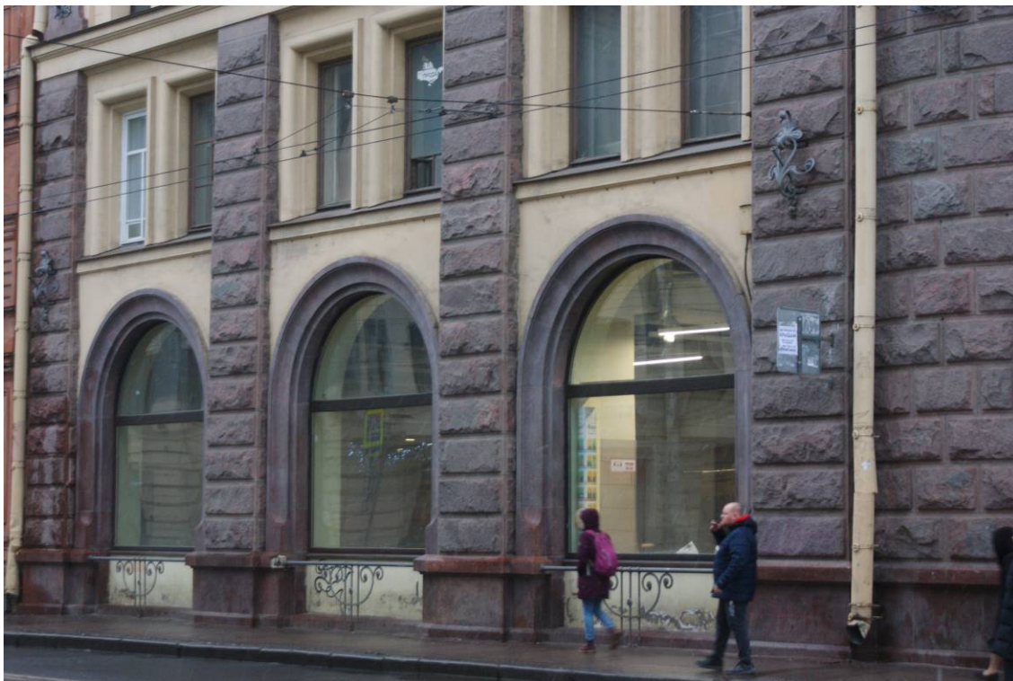
Фото 8. Здание по адресу: г. Санкт-Петербург, Звенигородская улица, дом 2/44, литера А. Лицевой фасад по Загородному пр. Фрагмент. Съемка 24.11.2021 г. Трушковский В. Э.
