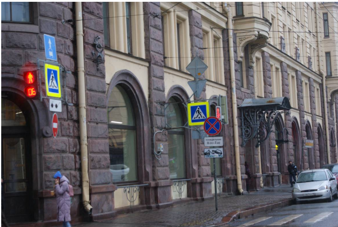
Фото 17. Здание по адресу: г. Санкт-Петербург, Звенигородская улица, дом 2/44, литера А. Лицевой фасад по Звенигородской ул. Фрагмент. Съемка 24.11.2021 г. Трушковский В. Э.
