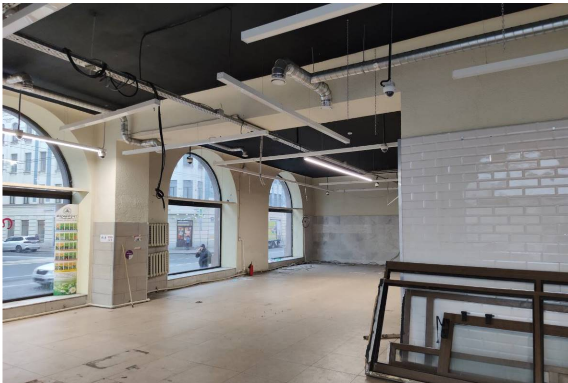
Фото 42. Здание по адресу: г. Санкт-Петербург, Звенигородская улица, дом 2/44, литера А. Пом. 1-Н 2/280,8. Съемка 24.11.2021 г. Трушковский В. Э.
