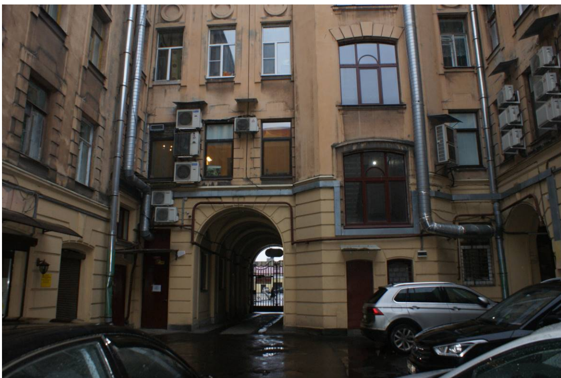
Фото 33. Здание по адресу: г. Санкт-Петербург, Звенигородская улица, дом 2/44, литера А. Юго-восточный дворовой фасад. Фрагмент. Съемка 24.11.2021 г. Трушковский В. Э.
