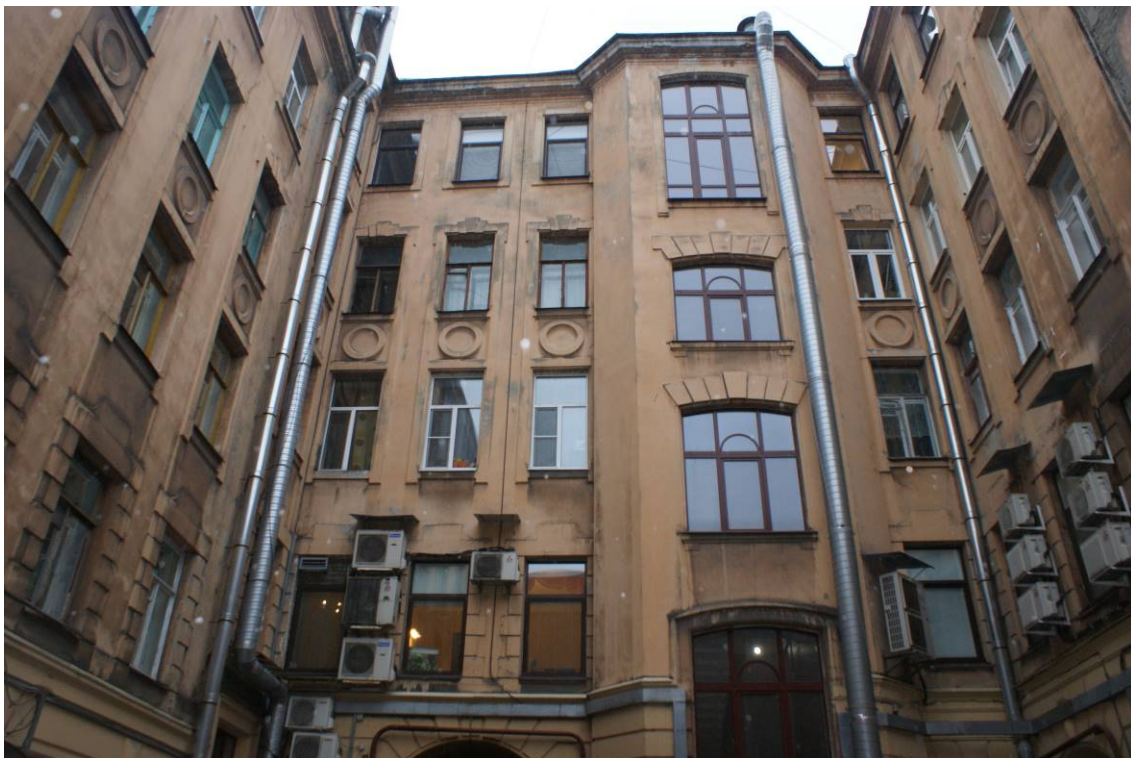
Фото 34. Здание по адресу: г. Санкт-Петербург, Звенигородская улица, дом 2/44, литера А. Юго-восточный дворовой фасад. Фрагмент. Съемка 24.11.2021 г. Трушковский В. Э.
