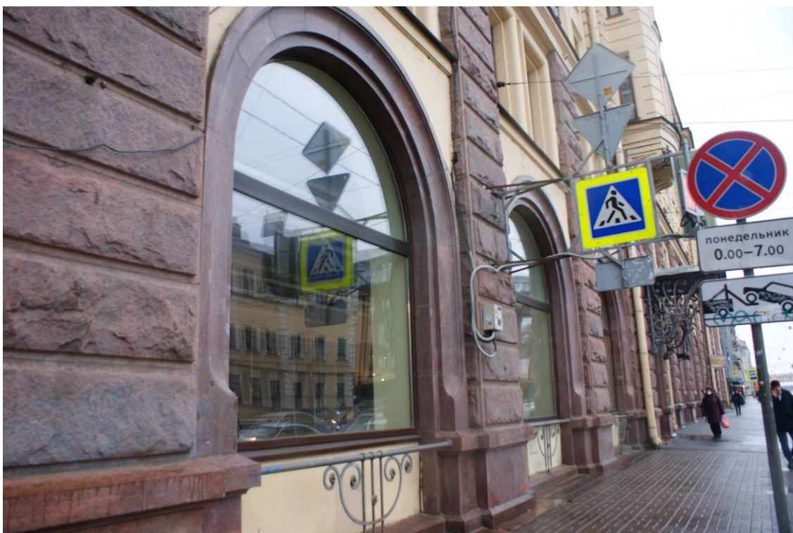
Фото 18. Здание по адресу: г. Санкт-Петербург, Звенигородская улица, дом 2/44, литера А. Лицевой фасад по Звенигородской ул. Фрагмент. Оформление окон 1-го этажа. Съемка 24.11.2021 г. Трушковский В. Э.
